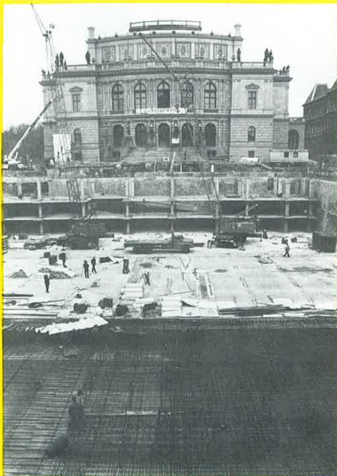
Armování dílů 5, 6 desky; na dílu 1, 2 se již montuje skelet parkingu
