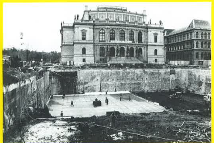
Armování dílů 5, 6 desky; na dílu 1, 2 se již montuje skelet parkingu Provádění podkladních vrstev vč. izolace
