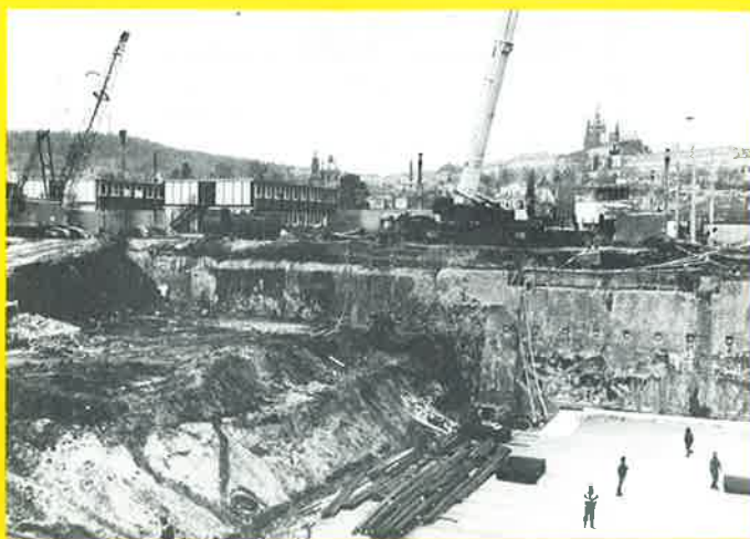
Souběh zemních prací, kotvení stěn, hydroizolace a armování desky
