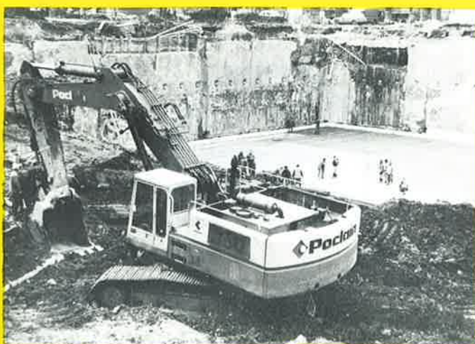
Souběh zemních prací, kotvení stěn, hydroizolace a armování desky
