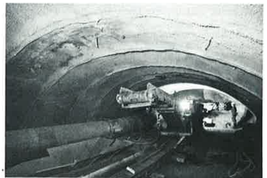
Ražba kaloty staničního tunelu na stanici Hloubětín na trase IV. B.
