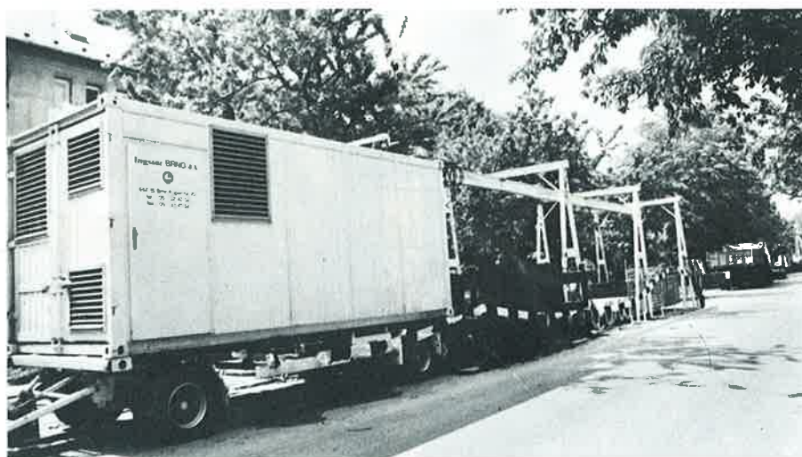
Kontejnerová souprava SOLTAU na staveništi v Ostravě.
