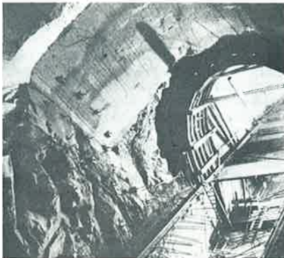
Poslední pas šikmého tunelu při vyústění do hlavní kaverny.
