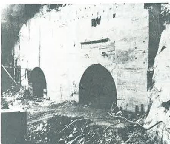
Pohled na část povodní stěny komory uzavěrů.
