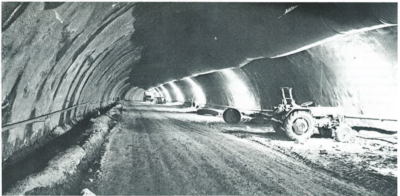
Pohled na vyraženou část kaloty
