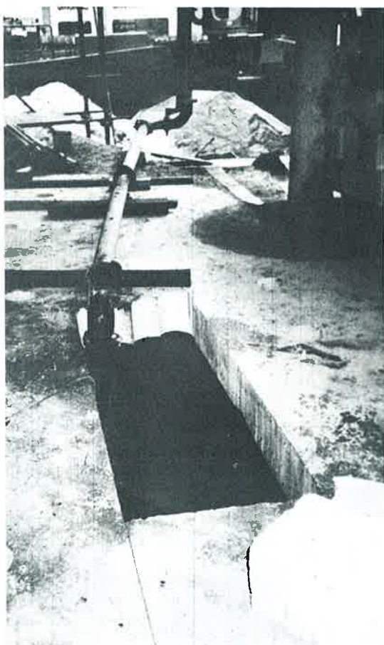
Obr. č. 2 Trezor Brno Koblížná – přívod betonové směsi výřezem ve stropě.
