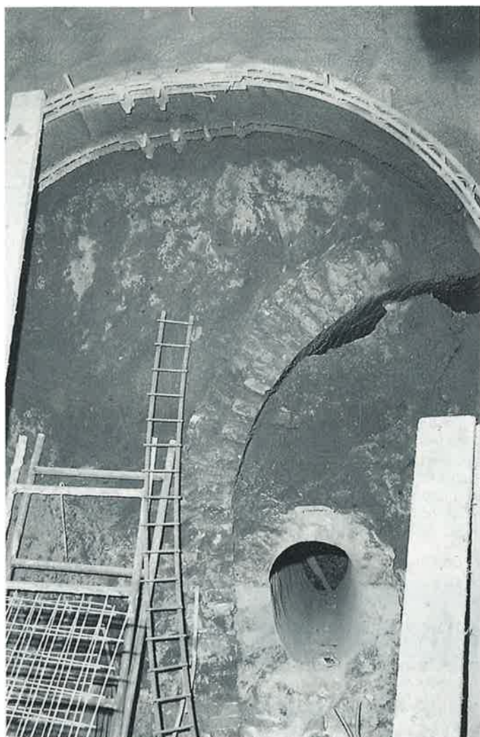
Obr. 4 Staré zdivo a „suchá“ kanalizace
