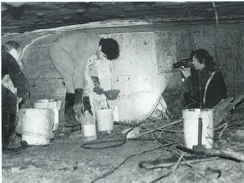
SANACE NETĚSNOSTÍ V ZASLEPENÉM PŘÍVODNÍM KANÁLU PŘČERPÁVACÍ VODNÍ ELEKTRÁRNY VE ŠTĚCHOVICÍCH
