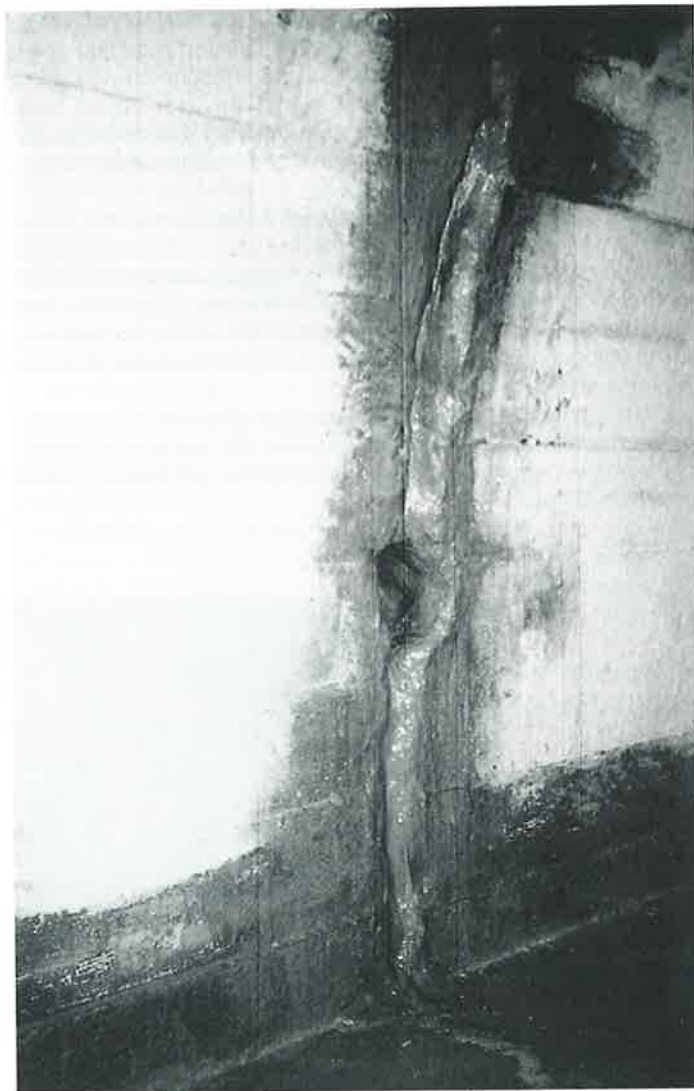
UTĚSNĚNÁ PRACOVNÍ SPÁRA A JEJÍ OKOLÍ SE NATŘE XYPEXEM, KTERÝ VYVOLÁ TĚSNÍCÍ KRYSALIZACI.
