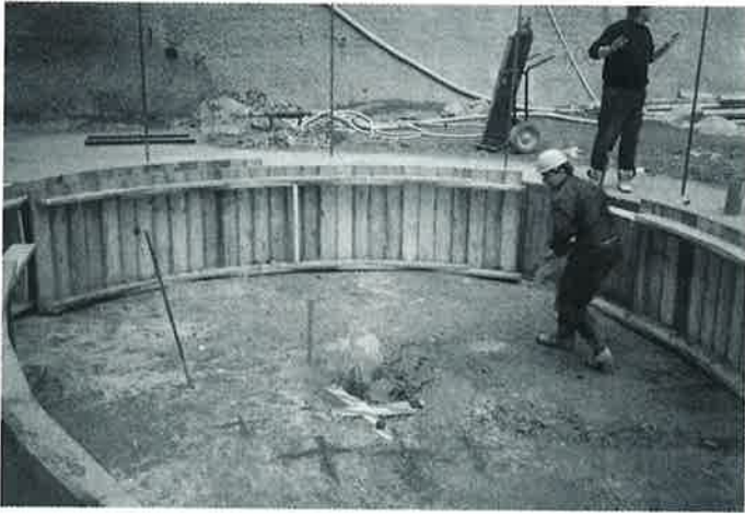
Obr. 4. Příprava betonáže ohlubňového límce
