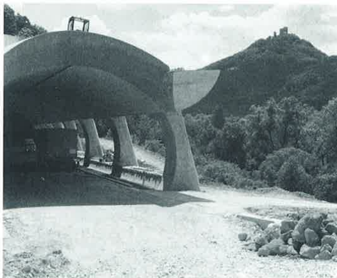
Pohled od galerie na hrad Trifels
