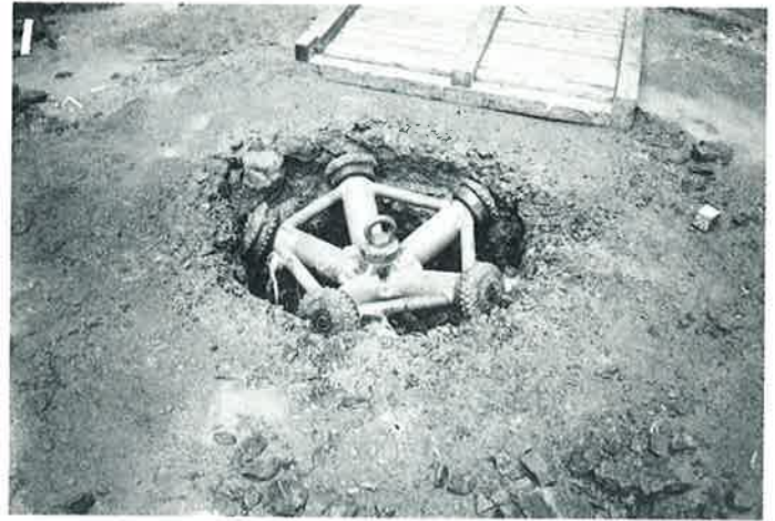
Obr. 5. Pronik pilotního vrtu do dna jámy
