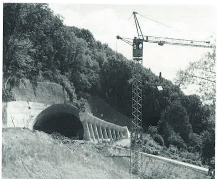
Tunel Barbarossa - část galerie
