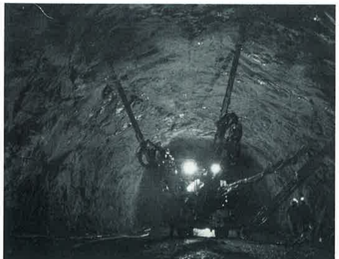
Vrtací lafety v norském tunelu
