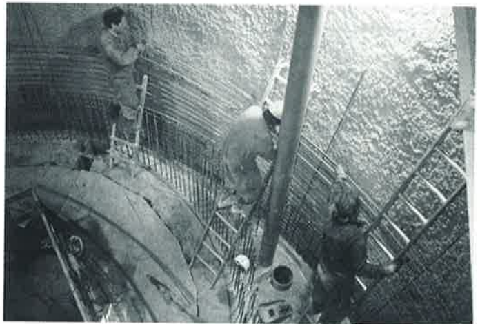
Obr. 9. Kontrola jámy před definitivní betonáží
