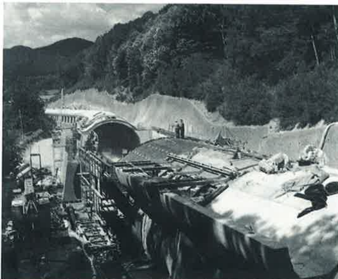
Tunel Löwenherz - výstavba galerie
