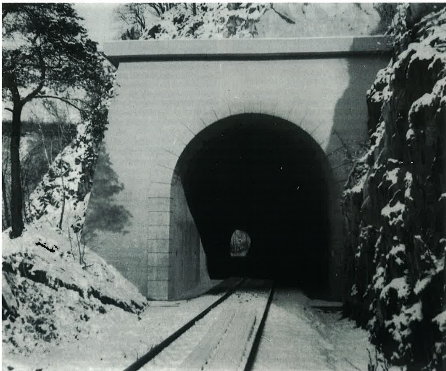
Portál rekonstruovaného davelského tunelu
