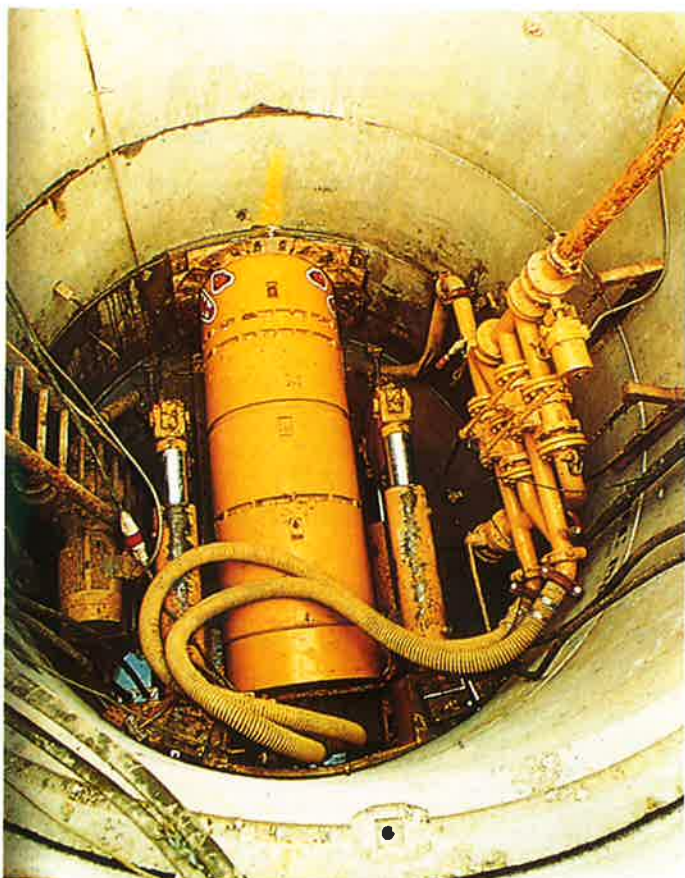
Pohled do startovací šachty se strojem Iseki Unclemole TCC 780 v Heathrow
