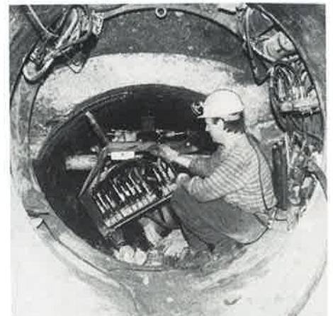
Obr. 8. Impaktor v stiesnenom priestore pôvodnej kanálovej rúry
