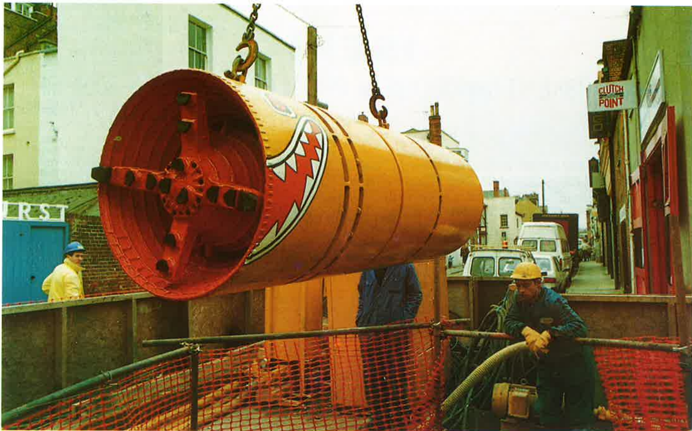
Spouštění razicího stroje Iseki při výstavbě běžného kanalizačního řadu v Londýně
