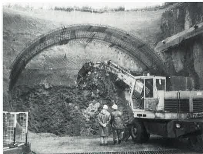
Obr. 5. Dobírání spodní klenby tunelbagrem Liebherr R 912
