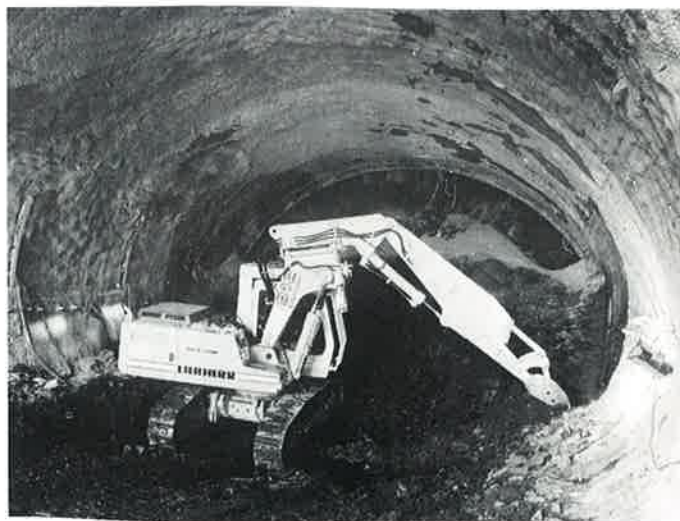
Obr. 4. Pohled z jámy na DT
