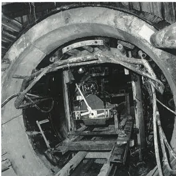
Obr. 3. Pohled na osazené protlačovací zařízení PDP 20 ve štítu DN 3050 mm těsně před zahájením prací na odvodňovacím vrtu
