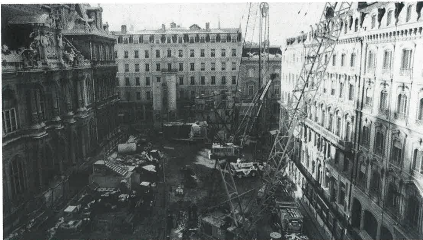
Parkoviště „U Burzy“ - provádění podzemních stěn - srpen 1991
