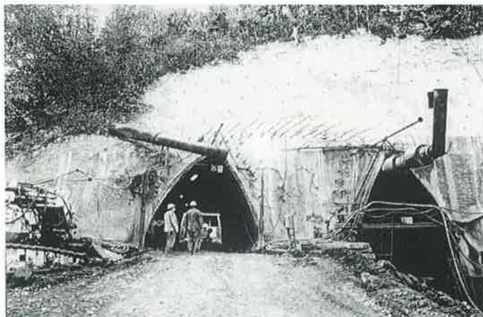
Obr. 1. Opěrové štoly tunelu
