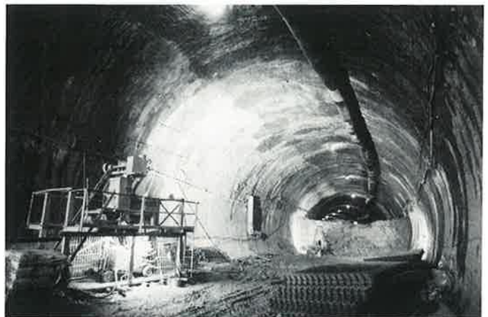
Vyražená kalota tunelu zajištěná stříkaným betonem se sítěmi a systémovým kotvením
