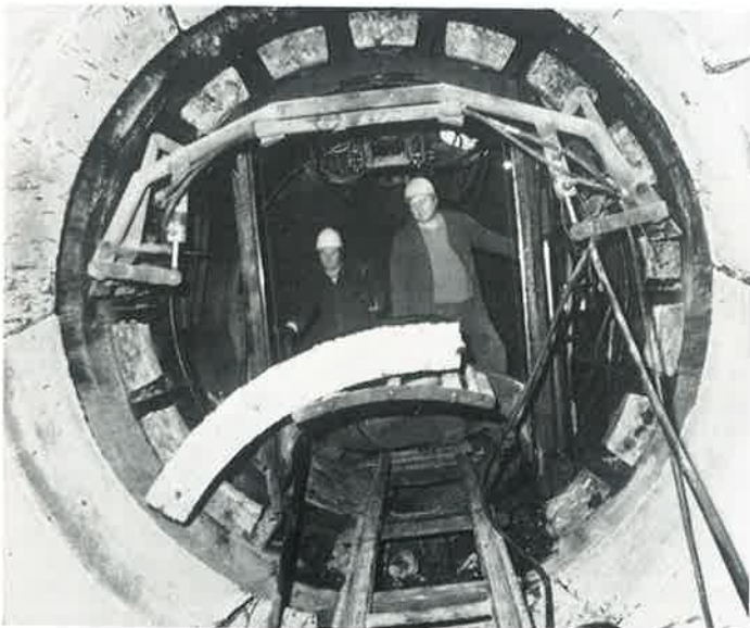
Montáž nosného ostění štítované štoly
