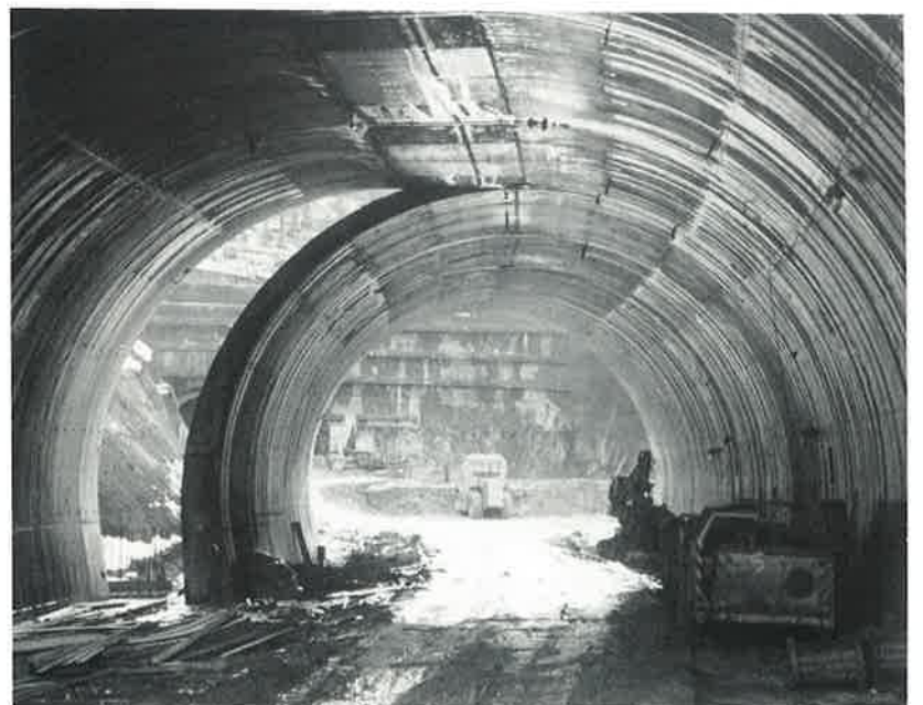
Obr. 6. Pohled z tunelu prováděného v otevřeném výkopu
