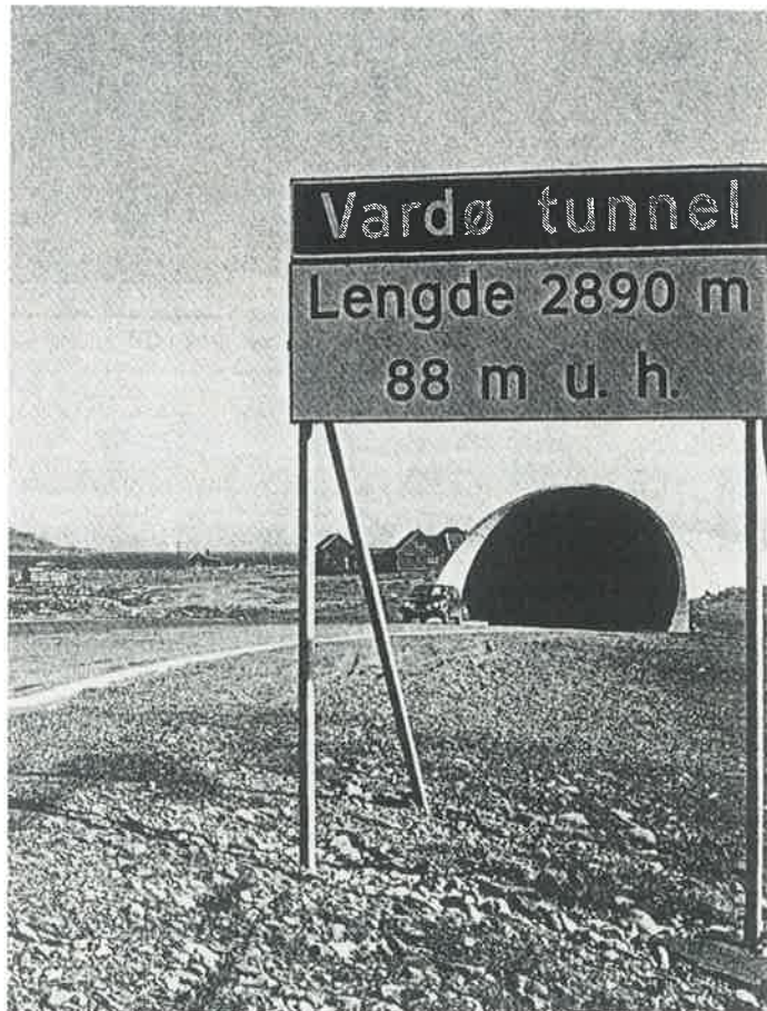
Portál cestného tunela vedeného pod jedným z tisícich fjordov sa vyníma najmä tým, že je vybudovaný v rovinnom teréne
