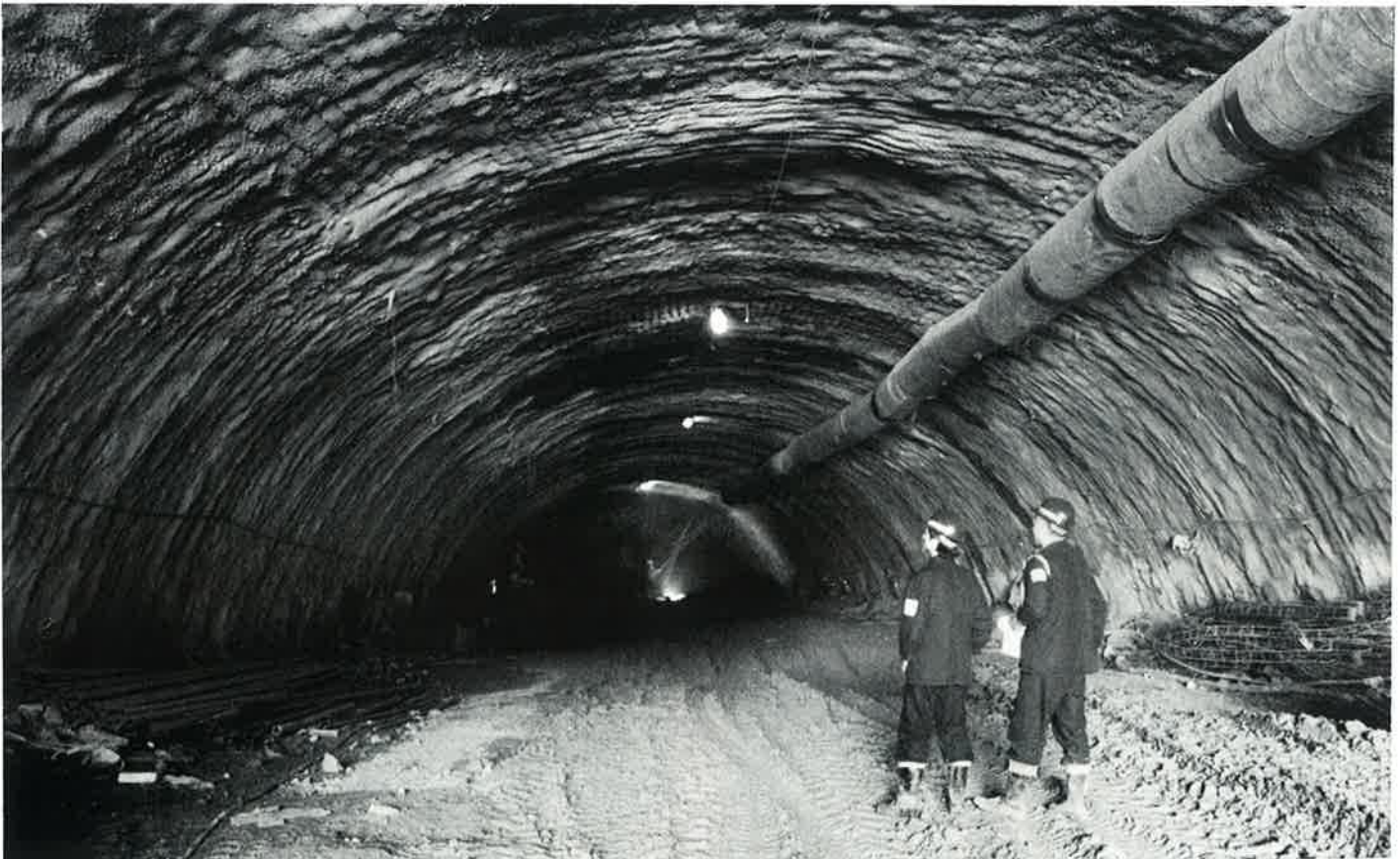
Tunel ve fázi odtěžování jádra a zřizování ostění boků tunelu a spodní klenby
