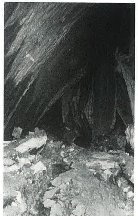
Obr. 11. Porušení dna a vytlačení jílovců do počvy štol
