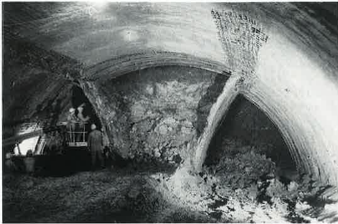
Ražení kaloty tunelu s členěním na dvě předstihové boční stoly
