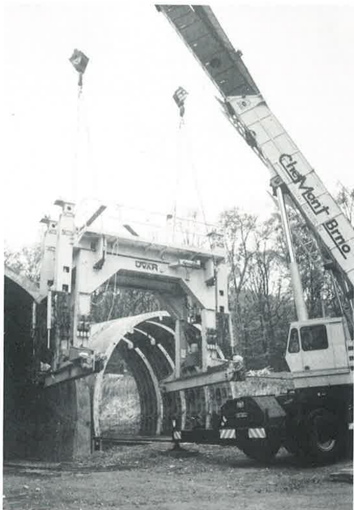
Přenos manipulacího vozu k betonáži druhého tunelu
