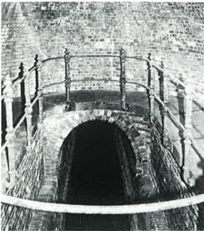
Obr. 3. Spojná komora se stokou „A“ před sanací
