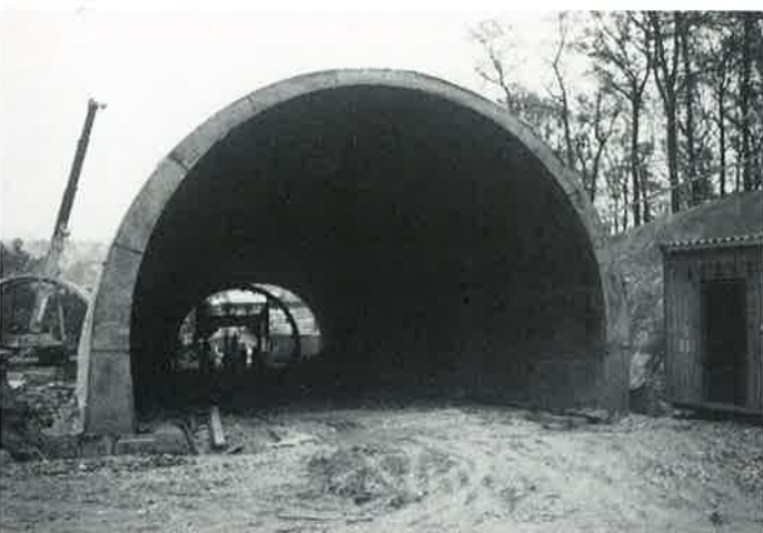
Tunelová trouba v hloubené části a přesun bednění k betonáži sousedního tunelu
