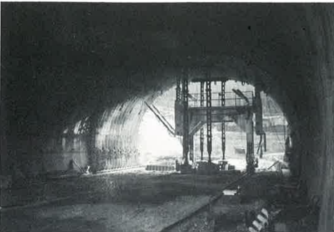
Pohled na vnitřní bednění z vnitřku tunelu
