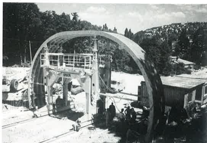
Usazení 1. segmentu s rozšířenou horní částí
