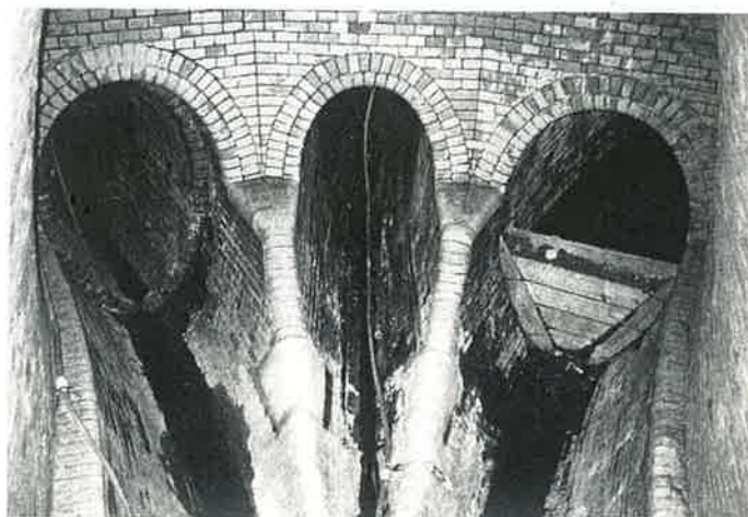
Obr. 2. Soutok tří stok v době sanace
