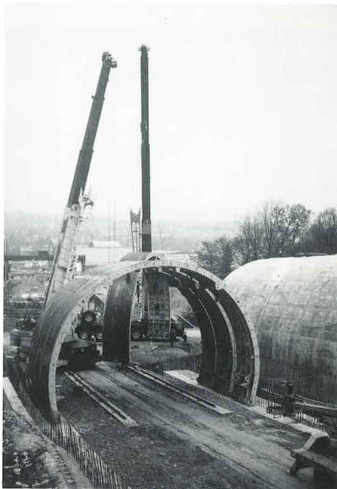
Přesun bednění k začátku betonáže druhého tunelu
