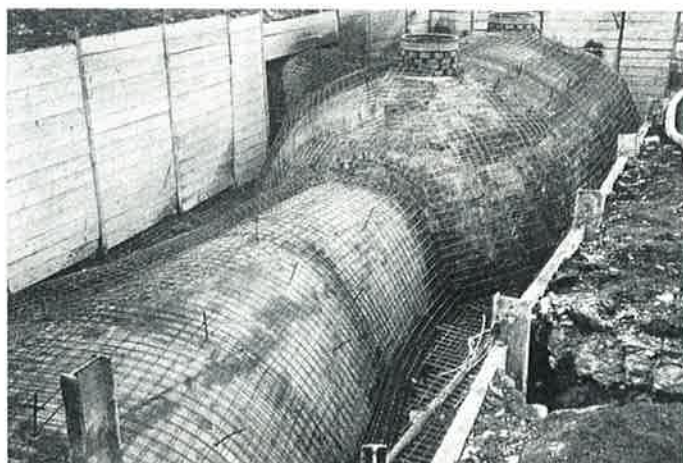
OB. 15. Spojná komora před betonáží sanační rubové klenby
