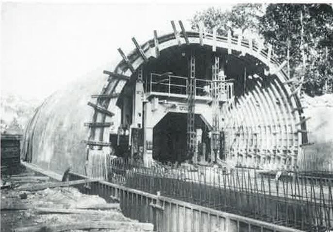
Ústí tunelové trouby po demontáži vnějšího bednění
