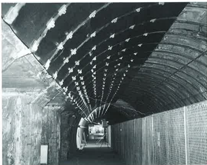
Obr. 1. Boční staniční tunel – začátek montáže zontů
