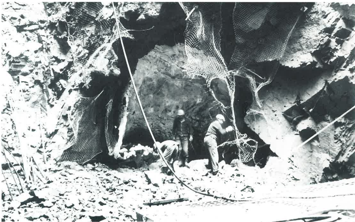
Obr. 1: Záběr z ražby štoly pro přivaděč
