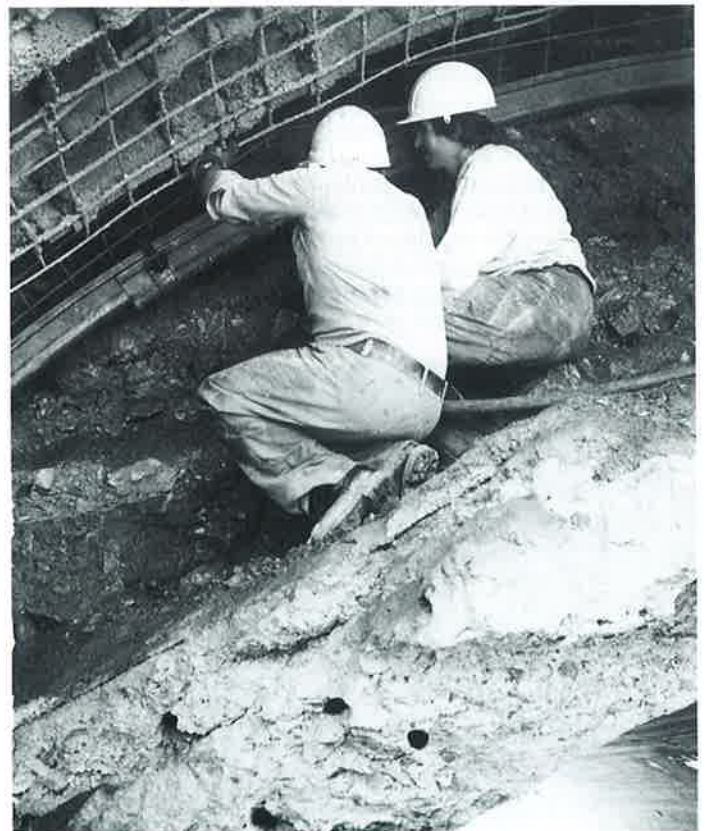
Obr. 5. Primárne ostenie tunela tvorí spravidla ocelová oblúková výstuž, ocelová zvarovaná mrežovina a striekaný betón. Na obrázku je vidieť časť pôvodnej betónovej klenby rekonštruovaného klenbového mosta (Vlkov pri Brne).
