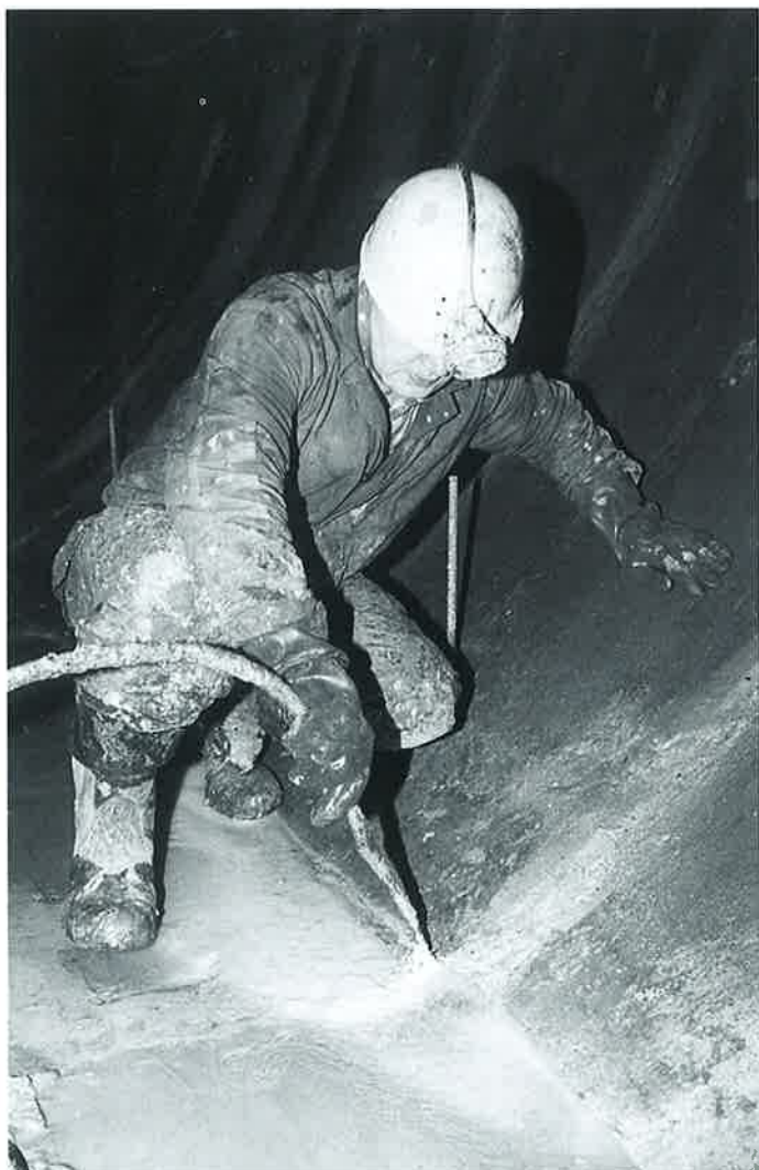
Obr. 1: Injektáž křížového styku spar u rovného počvové dílce Mediatanem 701
