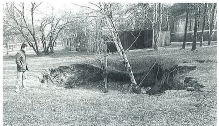
Projev havárie na povrchu území z obr. 4
