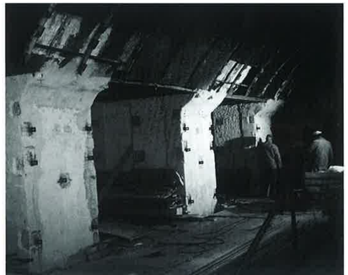
Obr. 2. Střední staniční tunel – oprava prostupů
