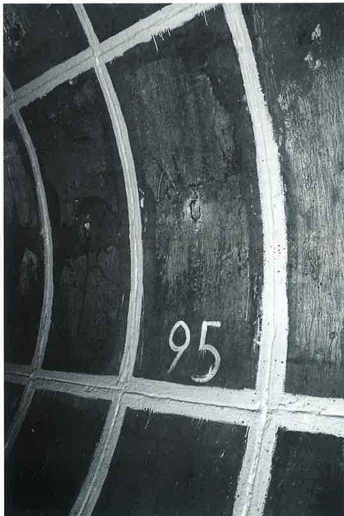
Obr 2: Spáry skládaného prefabrikovaného ostění finálně ošetřené nátěrem Mediatan 36-1
