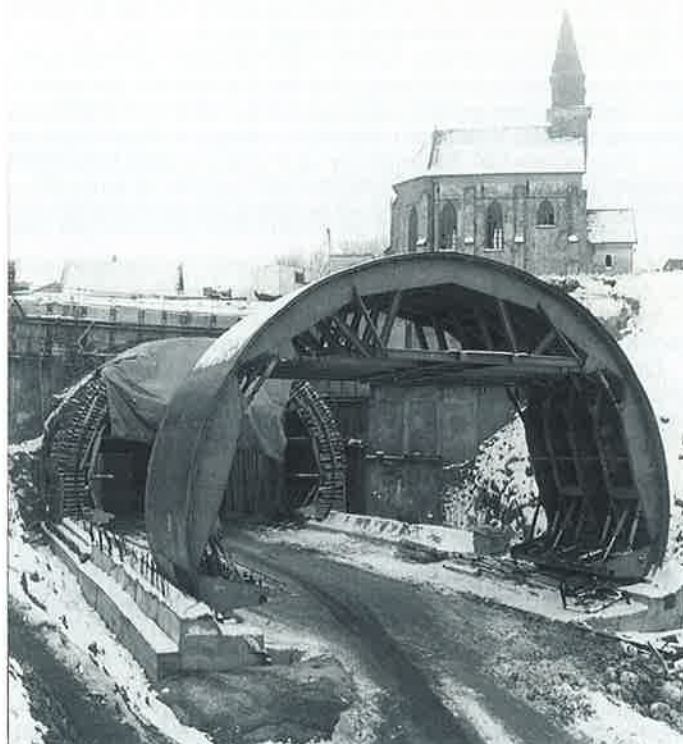
Ocelové bednění na délku sekce 5 m připravené k betonáži jednoplášťového ostění předportálové zasypávané části v blízkosti kostela sv. Josefa obce Hřebeč
