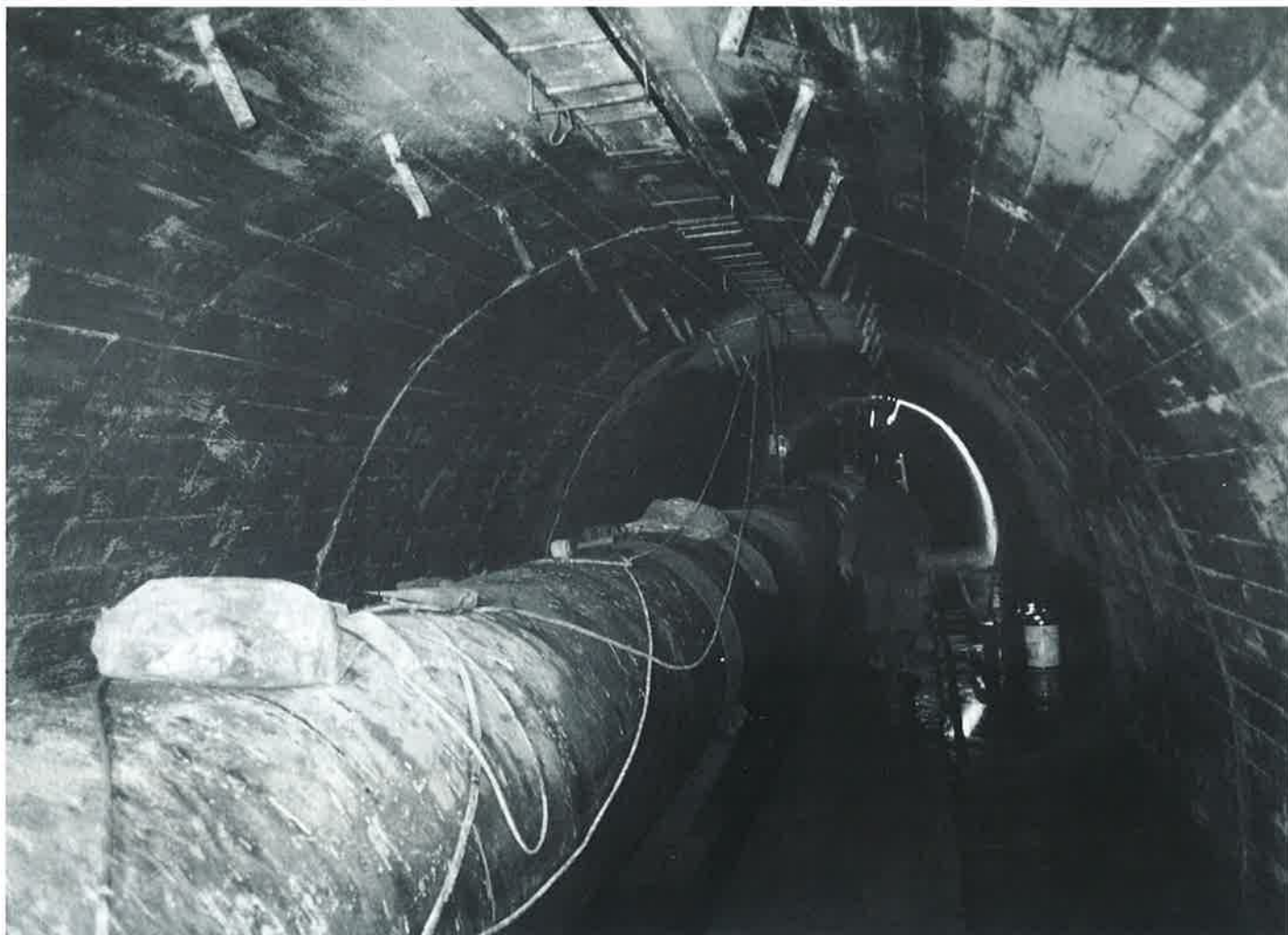
Obr. 1 Shybka pro vodovodní přivaděč po dokončené sanaci.
