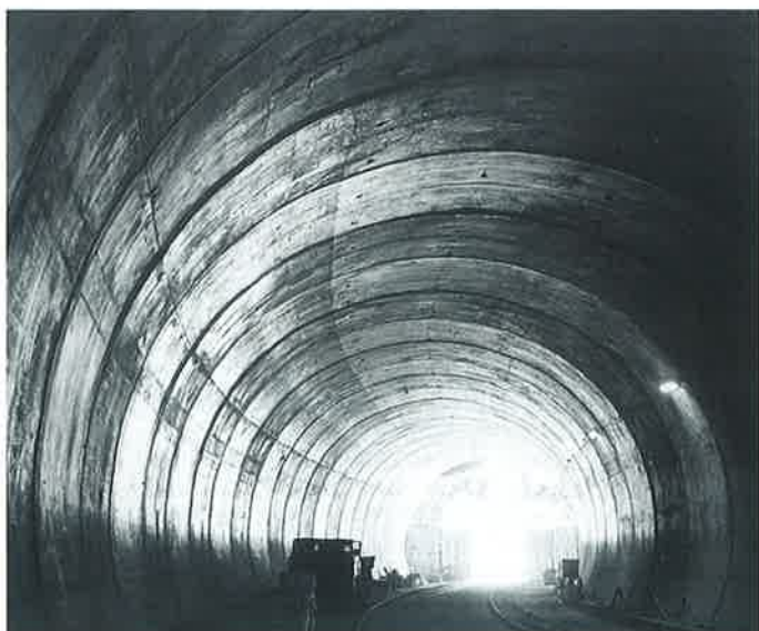
Vybetonovaný tunel ražené části
