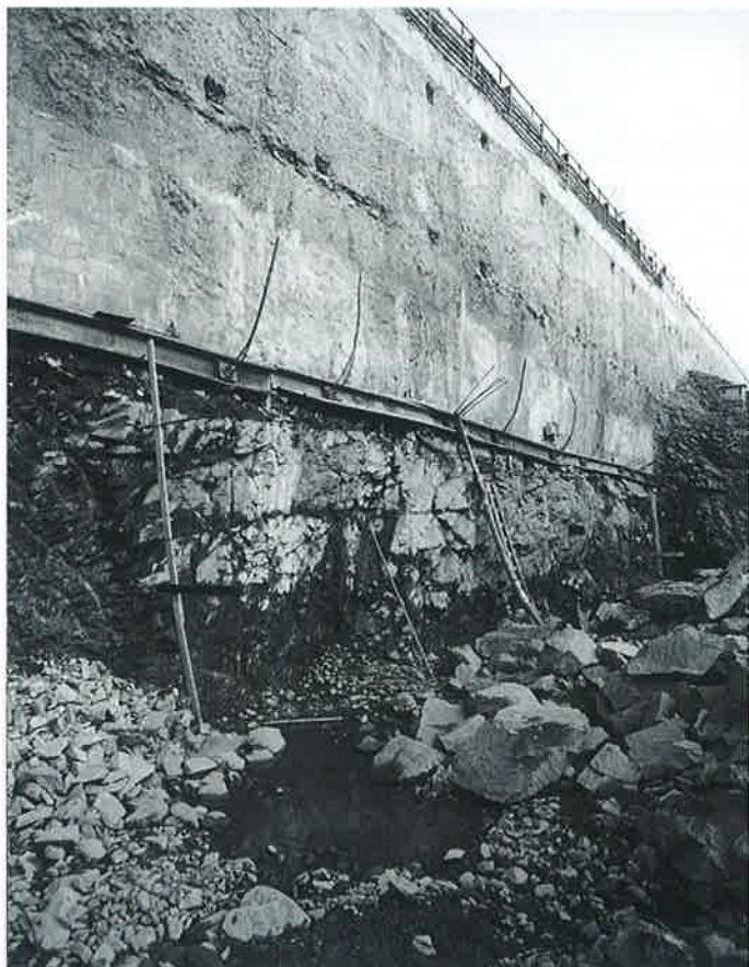
Obr. 2 Pohled na zabezpečení stavební jámy kotvenými podzemními stěnami, které jsou ukončeny na úrovni skalního podloží
