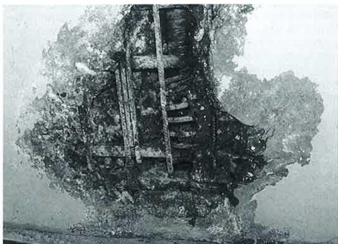
Obr. 2 a 3 Podzemní stěna s lokální korozi výztuže (vlevo), způsobenou zcela nedostatečným krytím. Vpravo po komplexním ošetření a před konečnou reprofilací.
