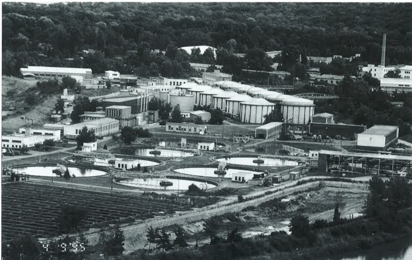
Obr. 1 Celkový pohled na ÚČOV Praha – v popředí prostor stavební jámy v těsné blízkosti plavebního kanálu
