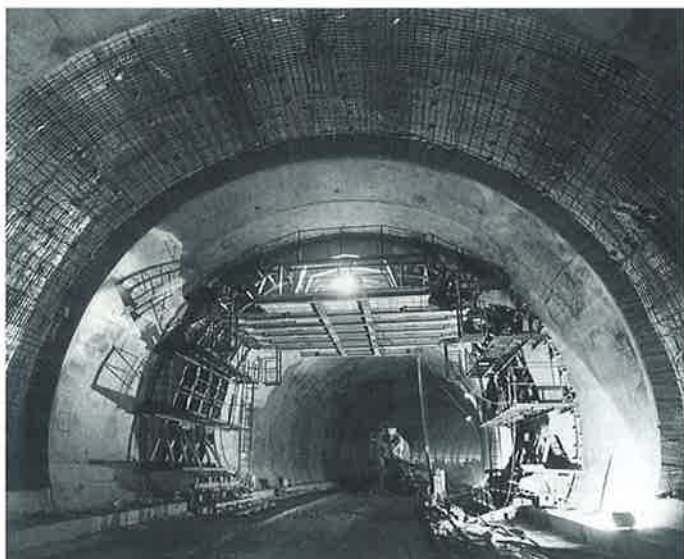
Postup betonáže vnitřního pláště po sekcích o délce 5 m, vždy ob jednu sekci
