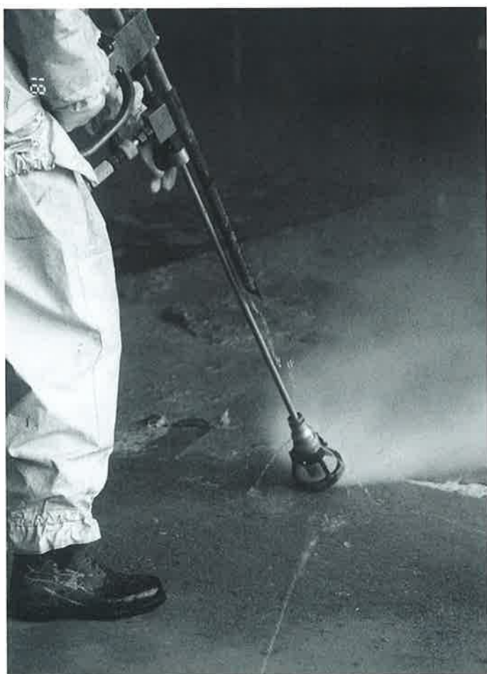
Obr. 12 Základem sanačního zásahu je otryskávání povrchu vysokotlakým paprskem s výstupním tlakem až 150 MPa.
