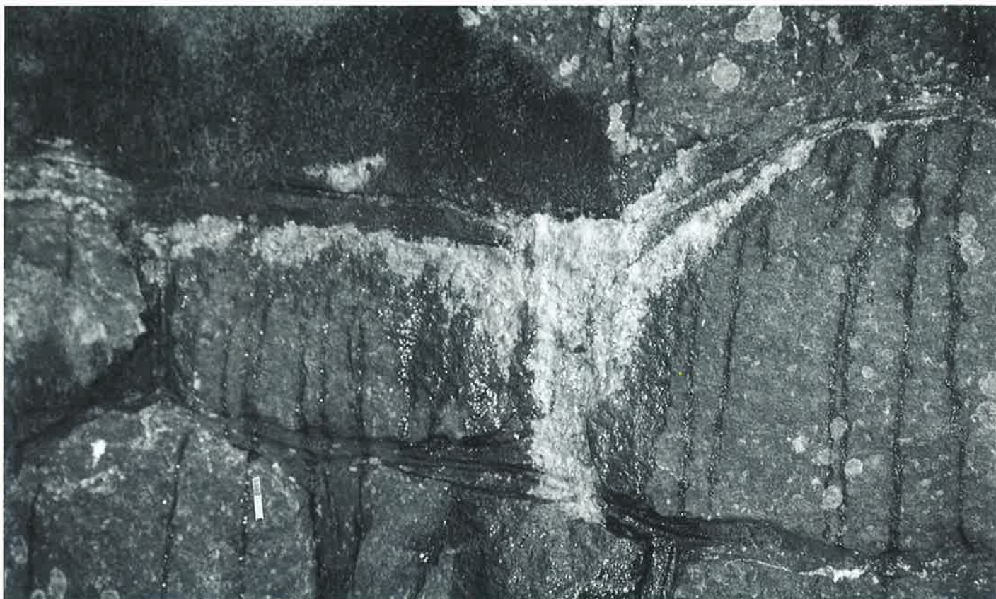
Obr. 8 Stěna štoly z kamenného zdiva před sanací.
