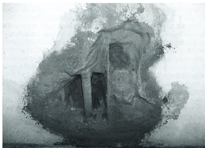
Obr. 2 a 3 Podzemní stěna s lokální korozi výztuže (vlevo), způsobenou zcela nedostatečným krytím. Vpravo po komplexním ošetření a před konečnou reprofilací.
