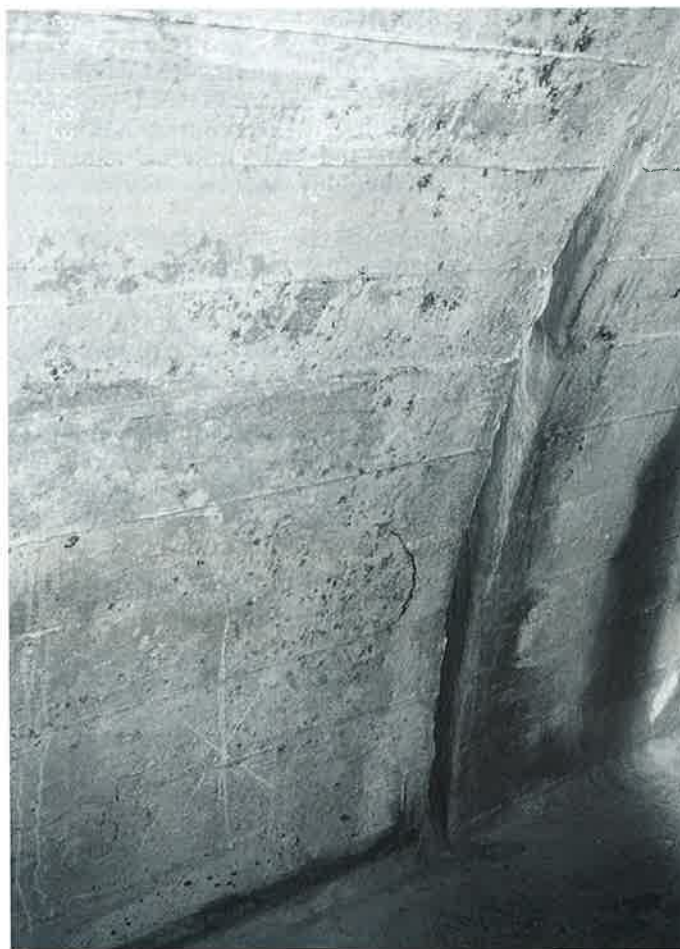
Obr. 13 Ošetřená a utěsněná pracovní spára před reprofilací.
