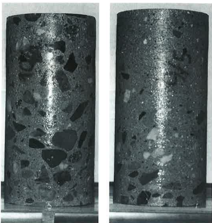
Obr. 4 a 5 Vývrty z podzemní stěny. Čerpaná betonová směs se rozmísila nepřipustným vodorovným přemísťováním vibrátorem. Vlevo beton z místa pod hadicí, vpravo z odlehle části bednění.
