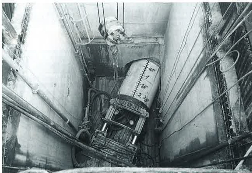
Obr. 5 Celkové uspořádání ve startovací šachtě – protlačování z Š-9 směrem na Š-8
