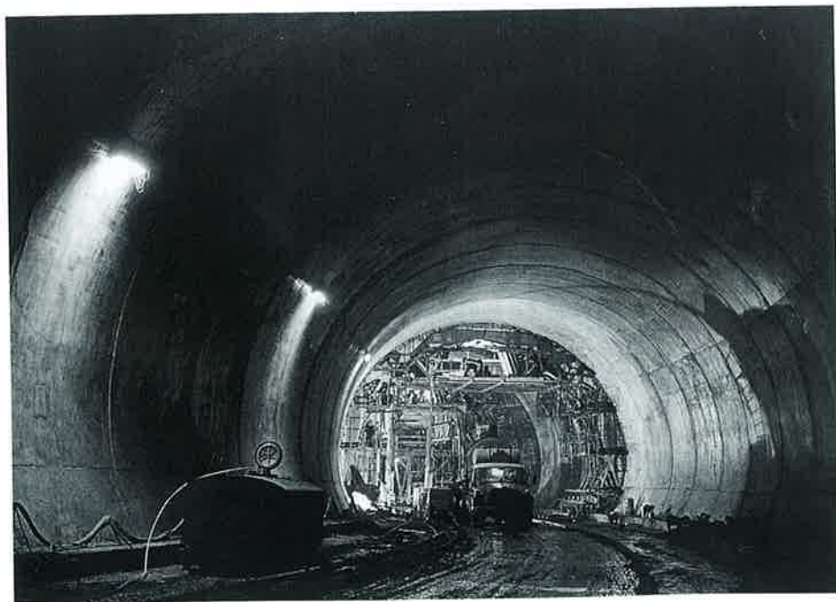
Obr. 2 Betonáž sudé sekce zhotovování monolitického ostění
