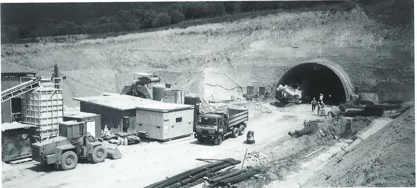
Obr. 1: Západný portál tunela Branisko s časťou zariadenia staveniska.
