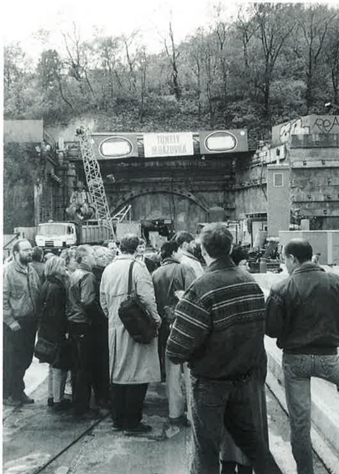
Z exkurze – před portálem tunelu Mrázovka
