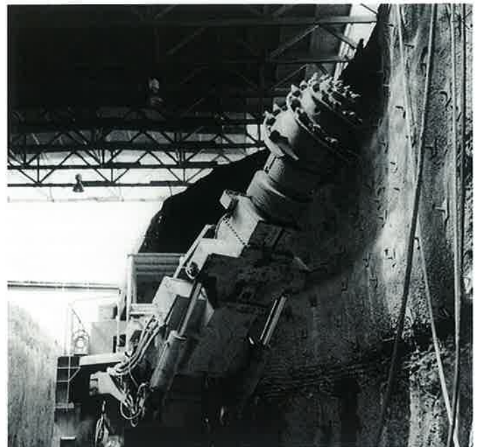
Obr. 6: Razicí stroj s výložníkovou frézou
