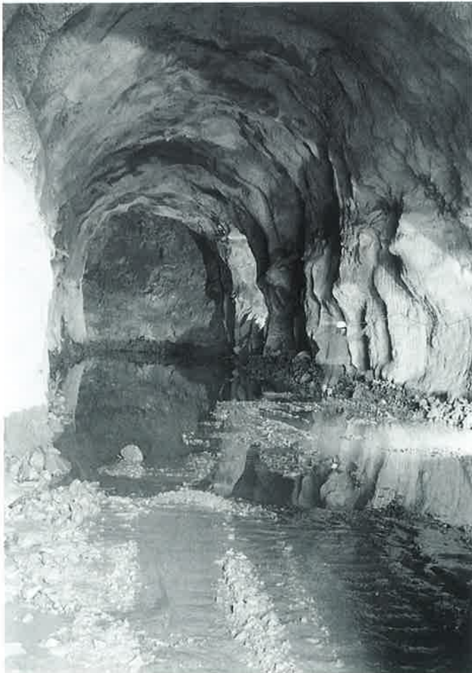
Obr. 4: NRTM při provádění podzemních kaveren
