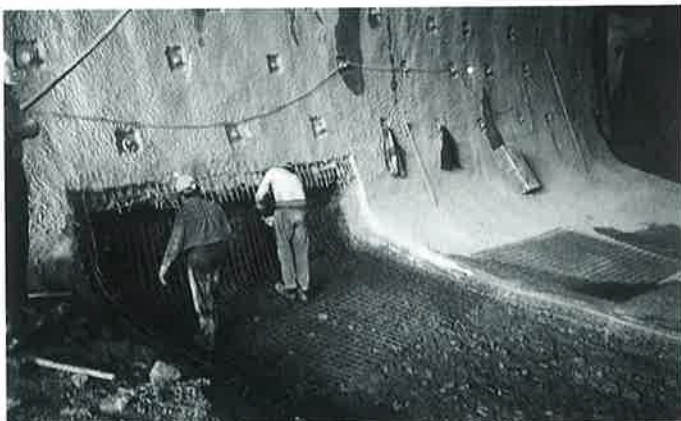
Obr. 2: V príortálovej časti tunela a vo vstrojovacej triede VI. primárne ostenie sa buduje aj v spodnej klenbe tunela.
