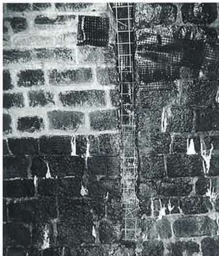
Obr. 4: Detail odvodňovací svíslé svodnice, v jejímž okolí je vidět provedené spárování kamenné obezdívky v kombinaci s injektáží PU pryskyřicí Mediatan 701-I
