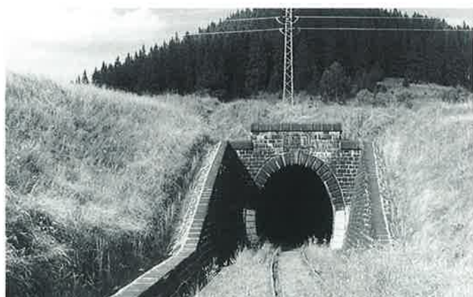
Obr. 6: Horní portál tunelu Telgárt
