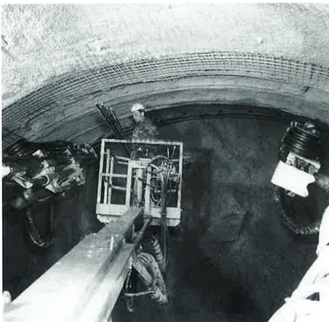
Z ražby tunelu Branisko, kde se na čelbě po odpalu tunelářům zjeví silueta sv. Barbory (foto Banské stavby a. s. Prievidza)
