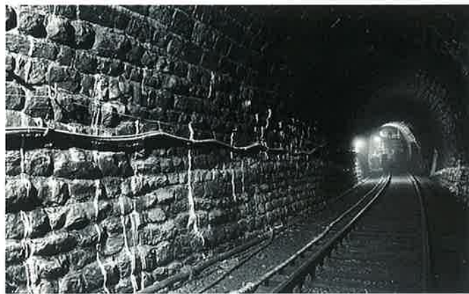
Obr. 2: Kamenná obezdívka sanovaná Mediatanem 701-I.
