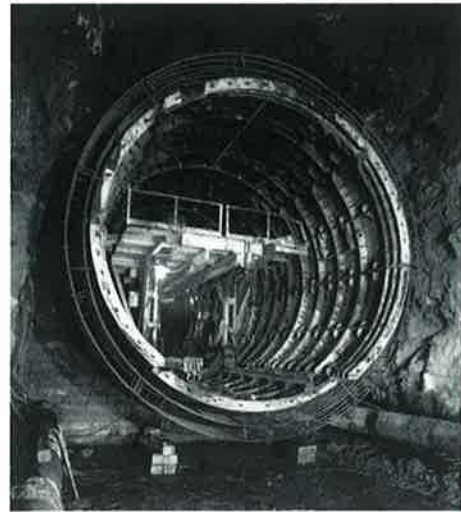
foto č. 10: Přivaděč
