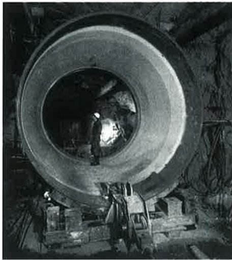
foto č. 9: Přivaděč
