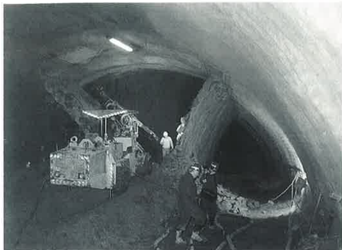
Obr. 1: Ražba metodou NRTM na silničním tunelu Hřebeč
