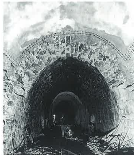
Obr. 5: Náhrada původní obezdívky novou konstrukcí
