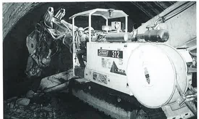
Obr. 3: Na rozpojovanie horniny a nakladanie v úvodnej časti tunela sa používa tunelový báger vybavený impaktorom Montabert s hmotnosťou 1 250 kg, nahrnovacou lopatou a hrabľovým dopravníkom.
