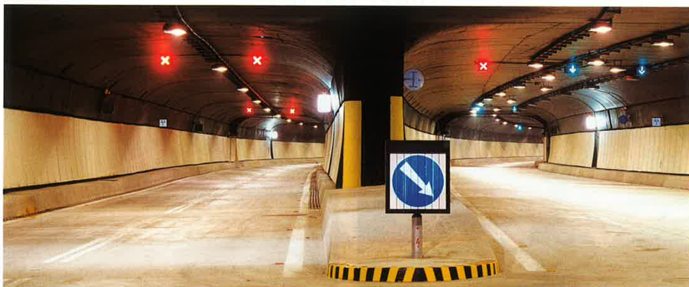
Pohled na tunelové trouby od břevnovského portálu
