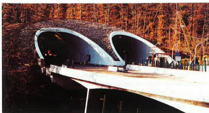
Portál Pisárky Na severní portál navazuje most přes řeku Svatku. Nad zasypanou částí tunelu bude obnoven lesoparkový porost
