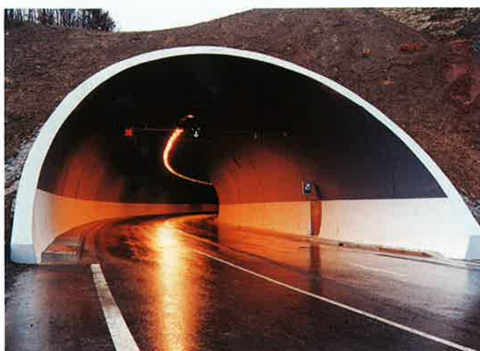
Východní portál (Moravská Třebová) Místo někdejšího skalního zřícení po dokončení
