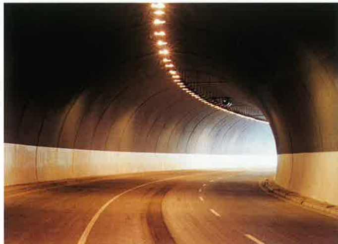
Vnitřní úprava ostění, osvětlení, podélné větrání
