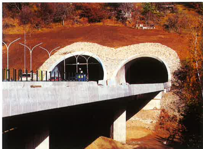
Portál Nový Lískovec Na jižní portál navazuje mostní estakáda přes údolí potoka Čertík
