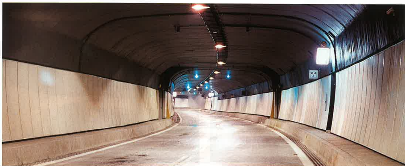
Pravá tunelová trouba – interiér
