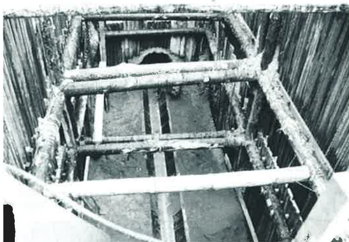
Oprava stoky v horní (menší) šachtě
