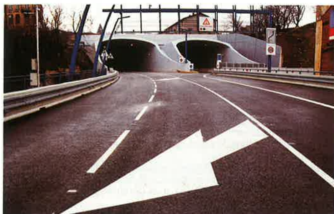
Smíchovský portál s nájezdovým mostem
