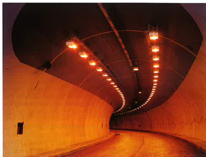
Interiér tunelu Povrchová úprava ostění a osvětlení u oblasti portálu
