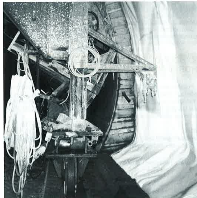
OBR. 5 Detail debnenia, oddebneného čela a plášťovej hydroizolácie
