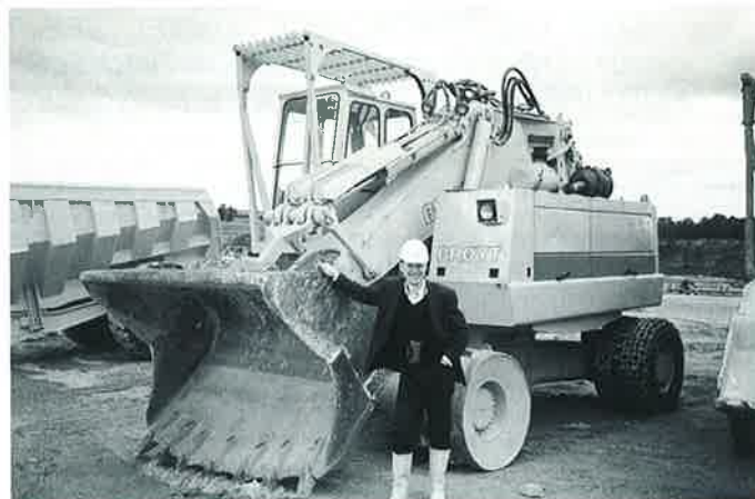
OBR. 4 Hydraulický lopatový nakladač Broyt
