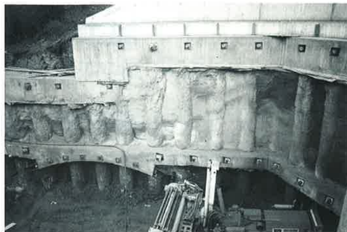
FOTO 4 Východní tunelová trouba – pohled na pilotovou stěnu S6 a S9
