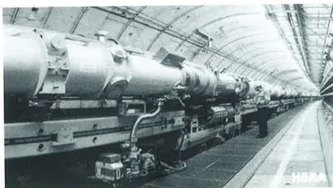
OBR. 3 Podzemní tunel HERA
