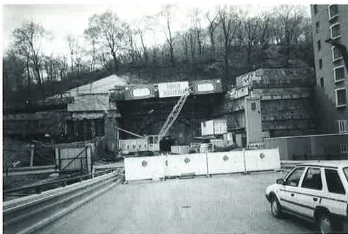
FOTO 2 Západní tunelová trouba – pohled na portál se vstupem do průzkumné štoly
