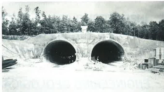
OBR. 3 Pohľad na východný portál
