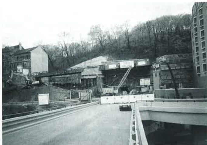
FOTO 1 Celkový pohled na oblast severního portálu tunelu Mrázovka
