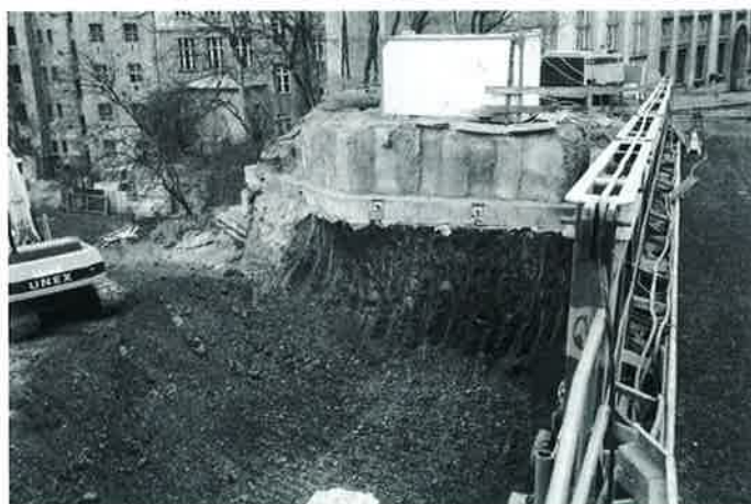
FOTO 3 Hloubení jámy před pilotovou stěnou S7
