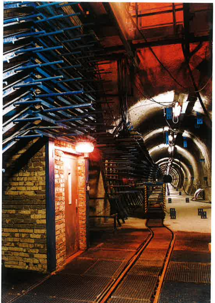
5. Primární kolektor – Brno Primary utility tunnel – Brno
