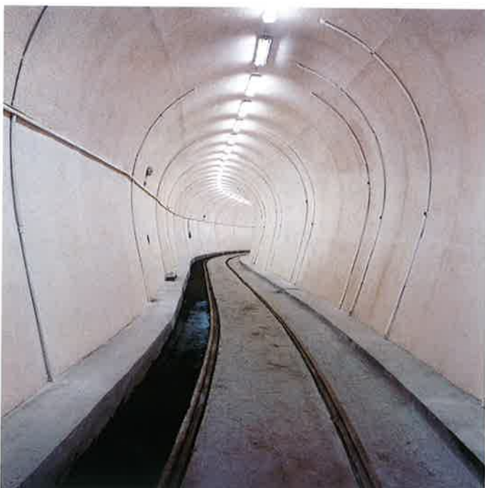
3. Přechpávací elektrárna Dlouhé Stráně– přístupový tunel Dlouhé Stráně pumped storage plant – acces tunnel
