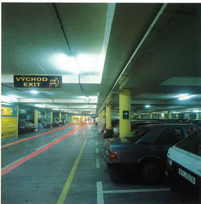
7. Podzemní garáže – Karlovy Vary Underground garrage – Karlovy Vary
