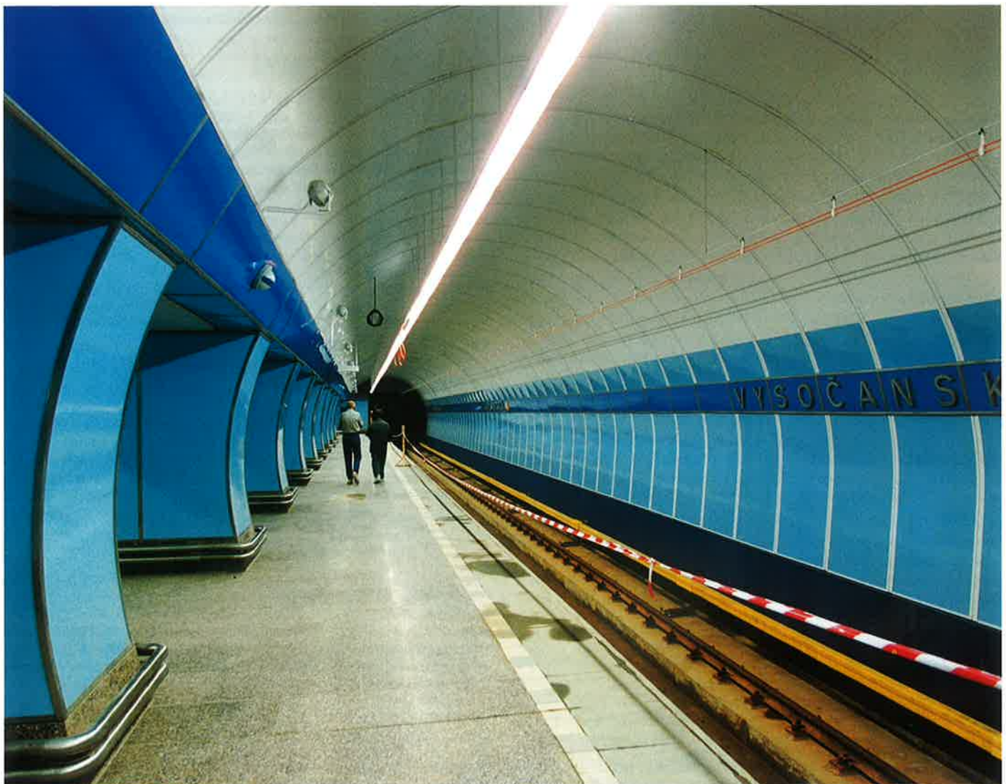
Ražená stanice – Vysočanská The driven station – Vysočanská
