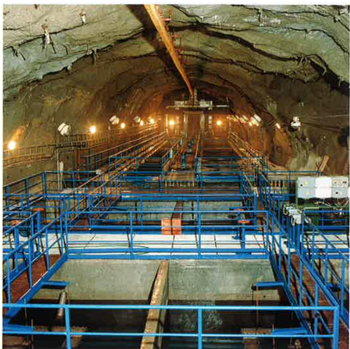
4. Čistírna odpadních vod – Pec p. S. Sewerage plant – Pec p. S.
