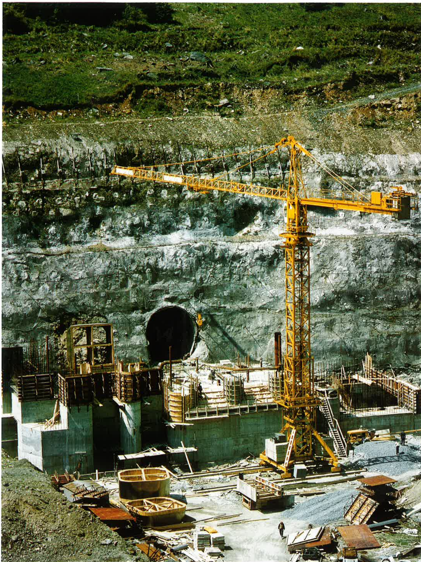
2. Přečerpávací elektrárna Dlouhé Stráně – odlom portálu Dlouhé Stráně pumped storage plant - portal excavation
