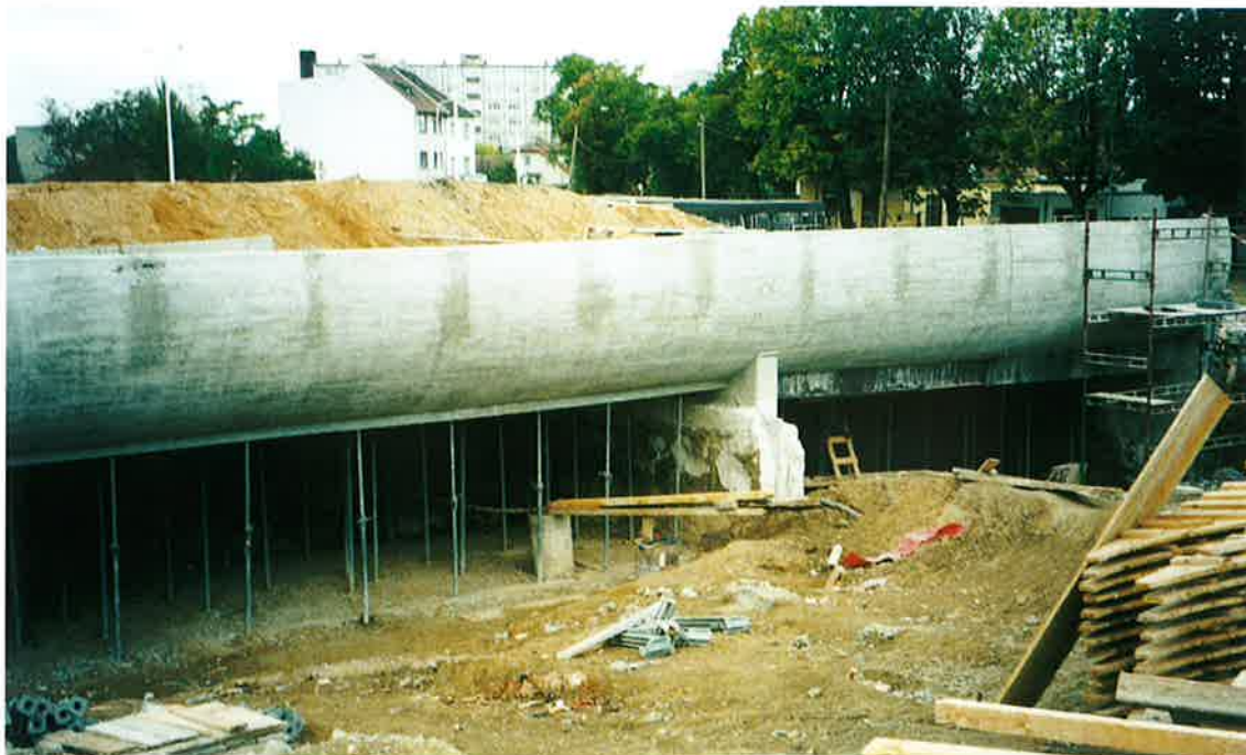
Obr. 1: Počátek odtěžovací zeminy u portálu Fig. 1: Beginning excavation at the portal
