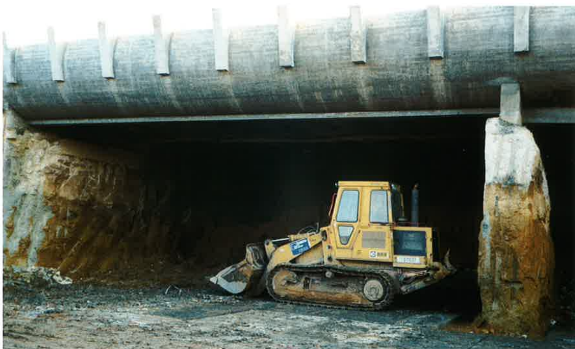
Obr. 2: Odtěžování pod stropem Fig. 2: Excavation under the ceiling
