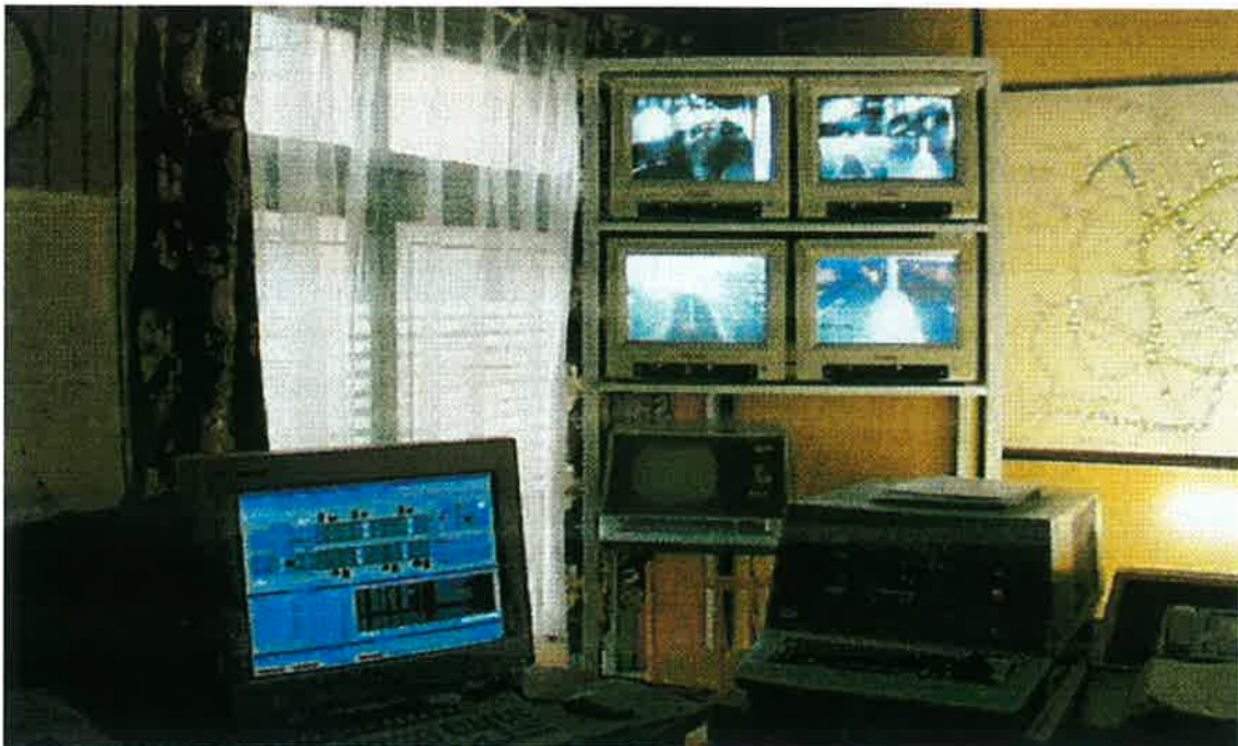
Obr. 5: Pracoviště policie určené pro řízení tunelu Husovice je vybavené počítačovým terminálem a TV monitory. Veškeré řídicí funkce, včetně ovládání kamer se realizují prostřednictvím obrazovek počítače.
