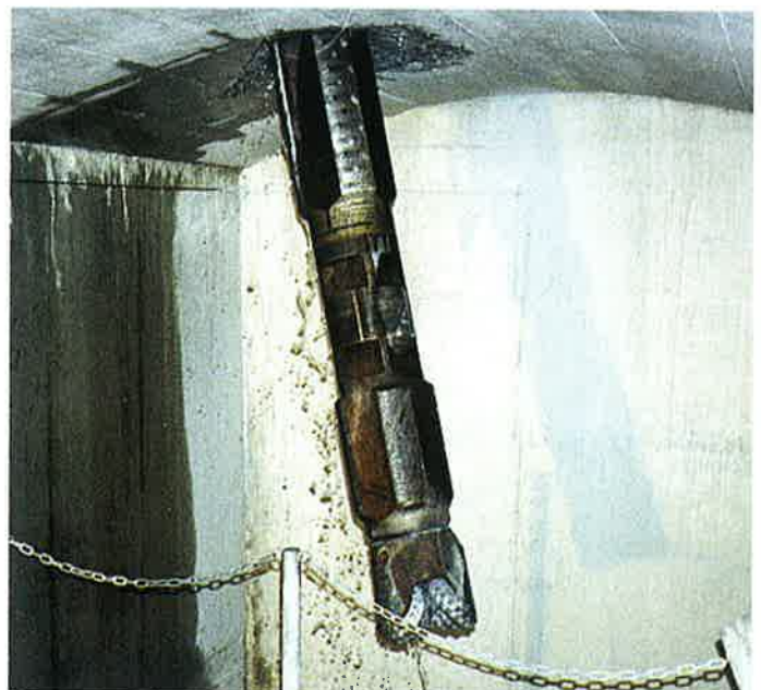
Obr. 5 Pronik pilotního vrtu Fig. 5 Penetration of the Pilot Borehole
