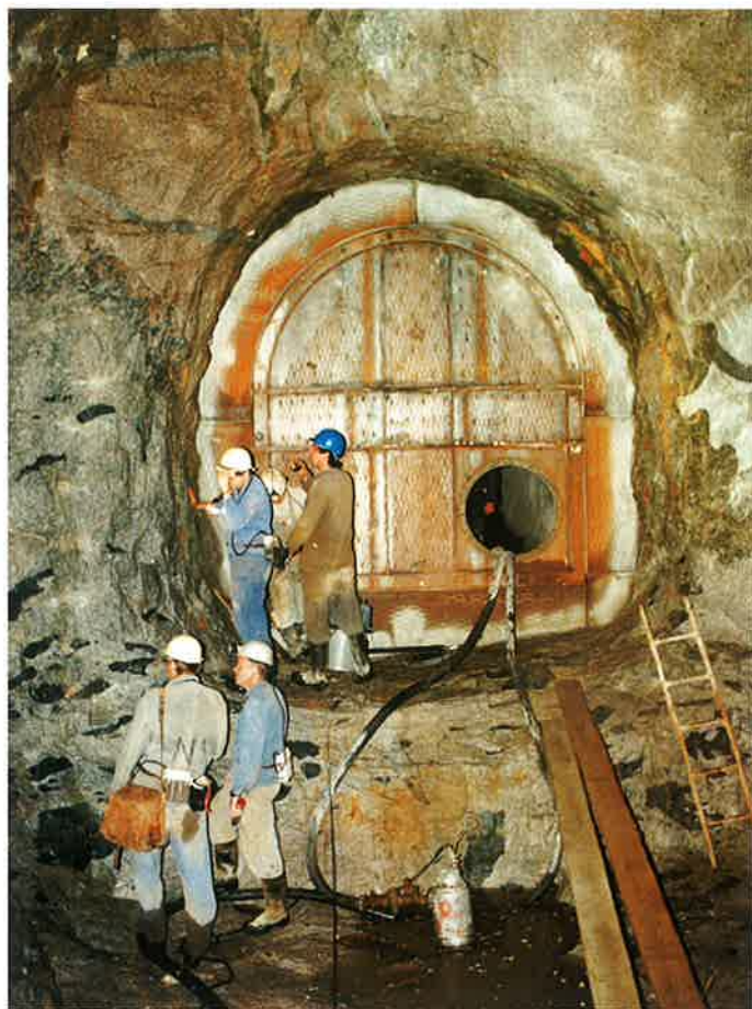
Obr. 1 Vylomený prostor pro zátku se závěrovým pancířem Fig. 1 Excavated space for the plug with the closure armour
