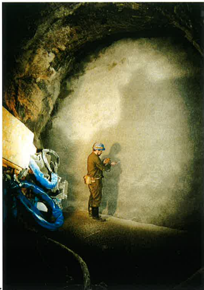
Foto 4 – Stříkaný drátkobeton zátky Photo 4 – Steel-fiber reinforced shotcrete of the plug
