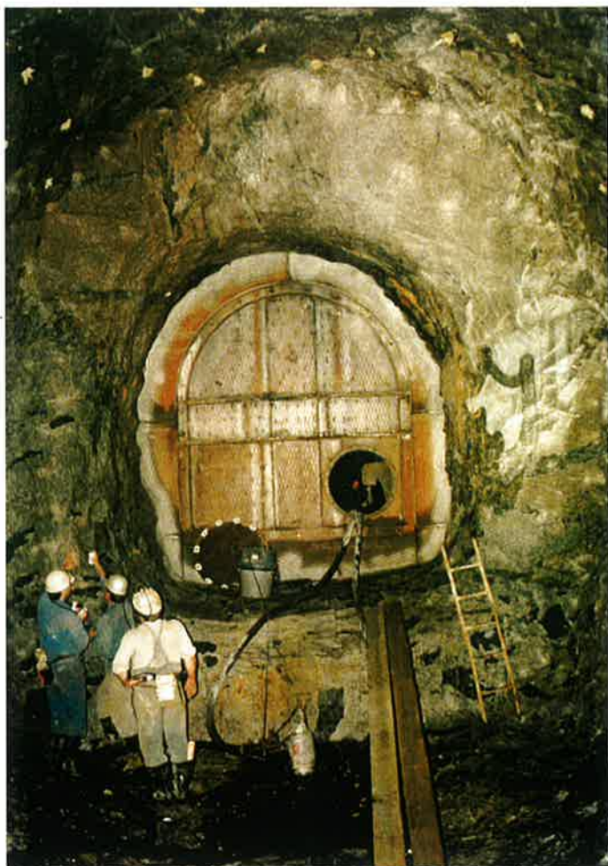
Foto 3 – Výlom definitivní zátky a uzavírací prostor Photo 3 – Excavation for the plug and the closing armour
