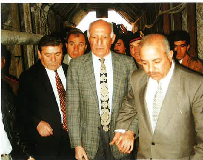
Obr. 4: Návšteva ministra zavlažovania pri príležitosti osláv prerážky tunela. V hornej časti obrázku je vidieť lichobežníkový profil výstuže I 16 , ktorá je polohovo kotvená ocelovými lepenými svorníkmi. Časť výtokového portála Al Baláa s ocelovou polygónovou výstužou.
