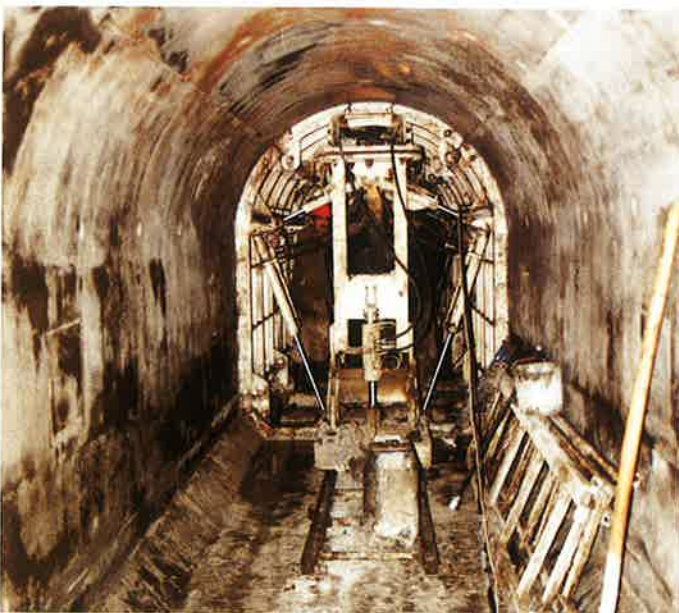
Obr. 2: Pohľad na zadnú časť debnenia DB 2500 počas betonáže tunelového vŕadzača vody
