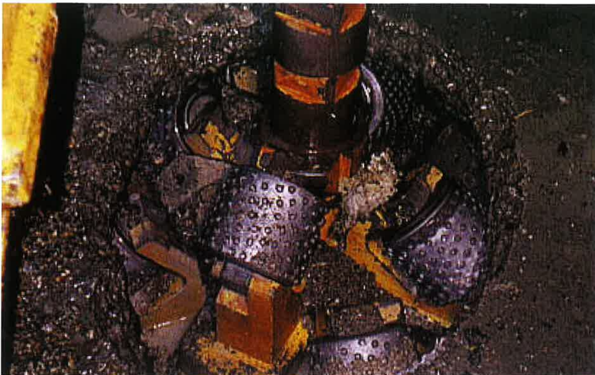
Obr. 7 Dovrtávání RD 1400 mm Fig. 7 Reaming up to 1,400 mm
