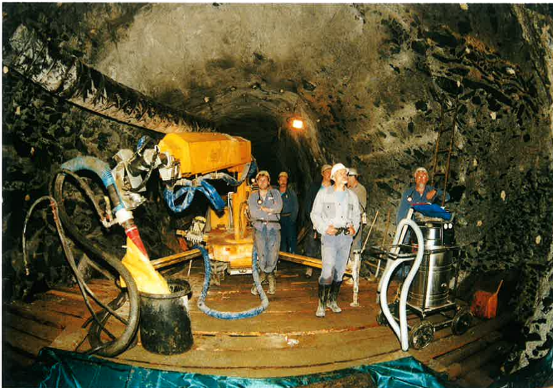
Obr. 1 Manipulátor ALIVA použitý ke stříkání drátkobetonu
