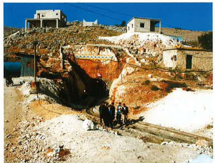
Obr. 5: Pohľad na výtokový portál tunela na strane Al Baláa Fig. 5: A view on outlet portal of tunnel on the side of Al Baláa
