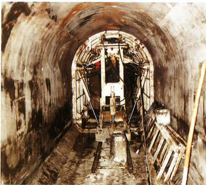
Obr. 2: Pohľad na zadnú časť debnenia DB 2500 počas betonáže tunelového prievádzča vody
