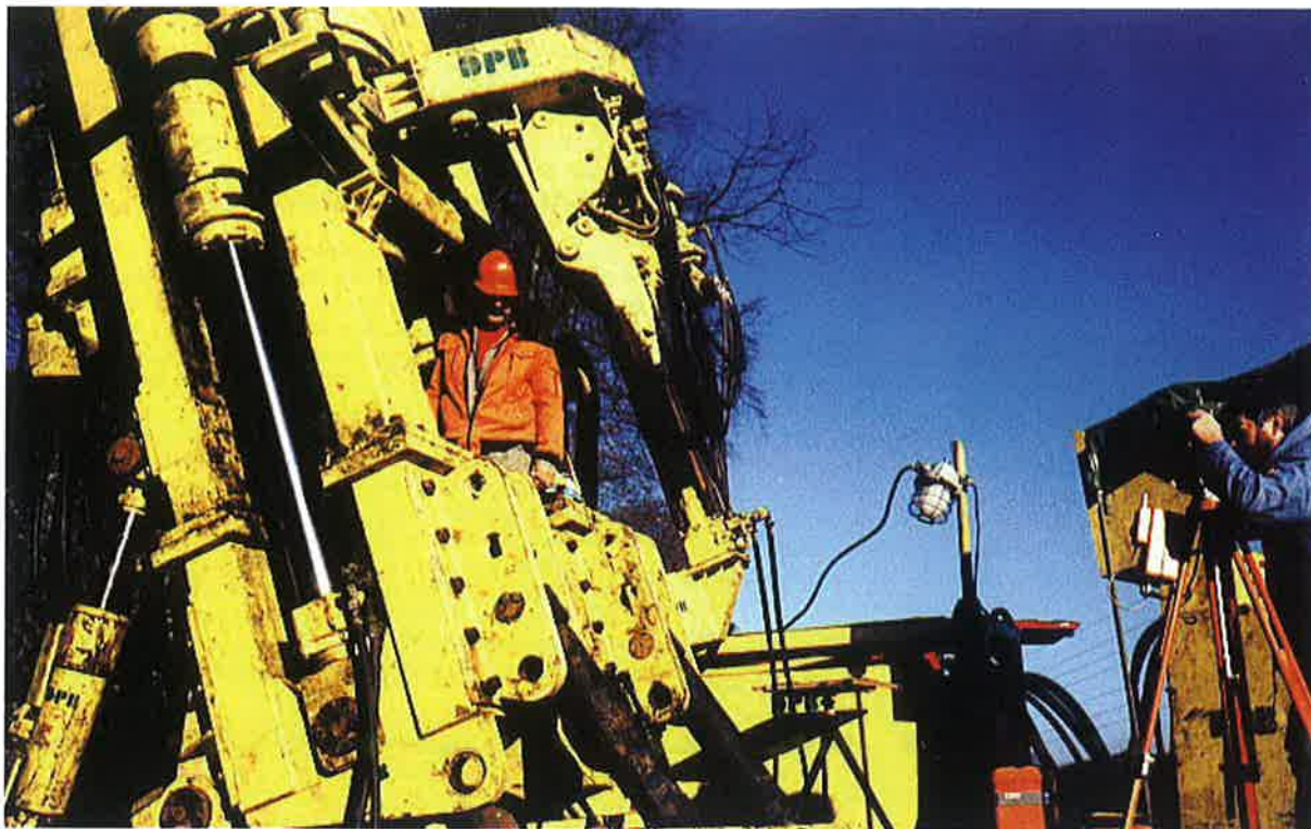
Obr. 4 Vrtná souprava WIRTH HG 210 Fig. 4 WIRTH HG-210 Drilling Rig
