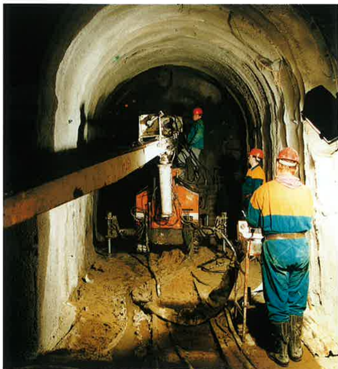
Obr. 4 Provádění tryskové injektáže Execution of jet grouting
