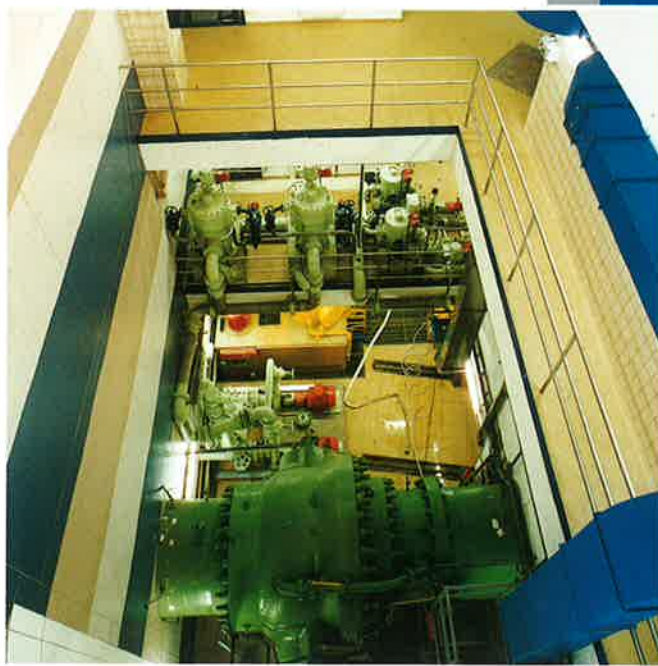
Podzemní přečerpávací vodní elektrárna Štěchovice Underground pump storage power station Štěchovice
