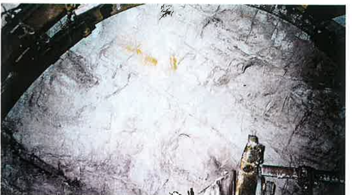
Obr. 5 Anomální prostředí v pískovcích (křemencích). Lavcovité, tvrdé horniny se zřetelným křížovým zvrstvením (vpravo ve středu). Frézou obtížně rozpojitelná hornina. An anomalous environment in sandstones (quartzites). Banks of hard rock with distinct cross bedding (on the right side from the center). The rock is hard to excavate with roadheader.
