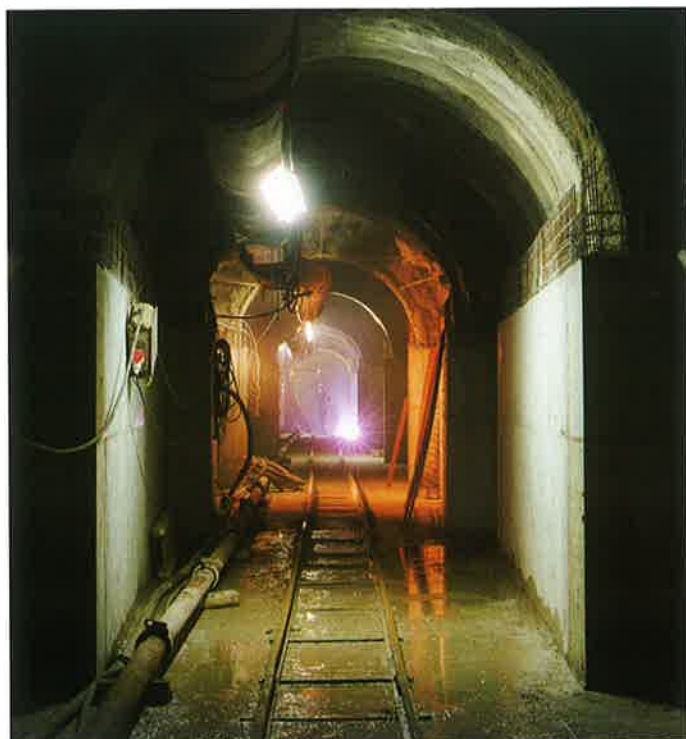
Obr. 8 Monolitické definitivní ostění boků kolektoru In-situ final lining of walls.
