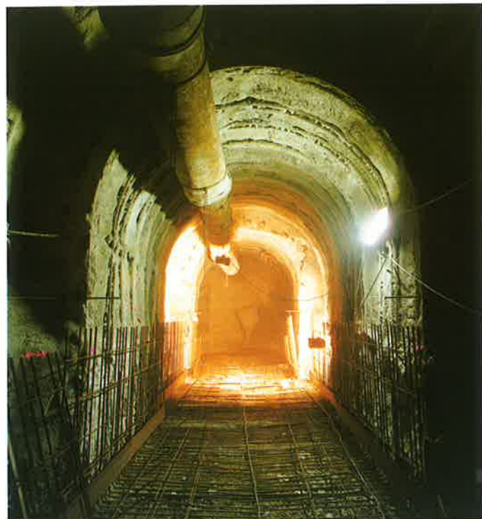
Obr. 7 Ukládání armatury dna kolektoru. Plechové pásy v pracovní spáře. Fixing rebars in the tunnel bottom. Steel bands in the day-joint.
