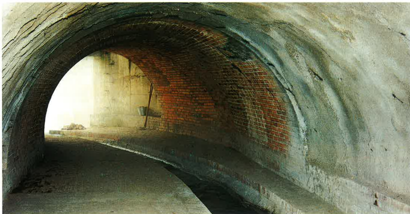
Obr. 5 Zděný úsek ústí sběrače v Mladé Boleslavi Bricked section of the sewer mouth in Mladá Boleslav
