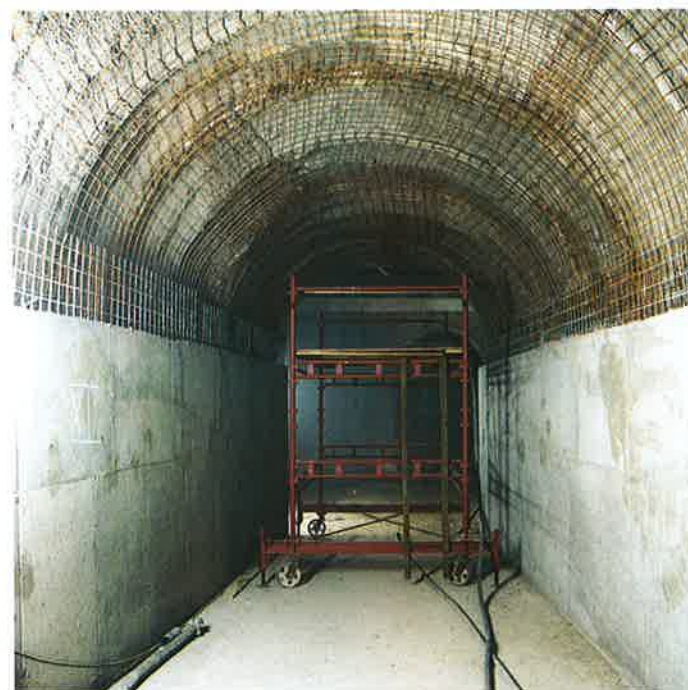
Obr. 9 Provedeno definitivní ostění dna i boků kolektoru. Připravena armatura pro stříkaný beton stropu. Final lining of the bottom and walls completed. Rebars for spraying the roof prepared.
