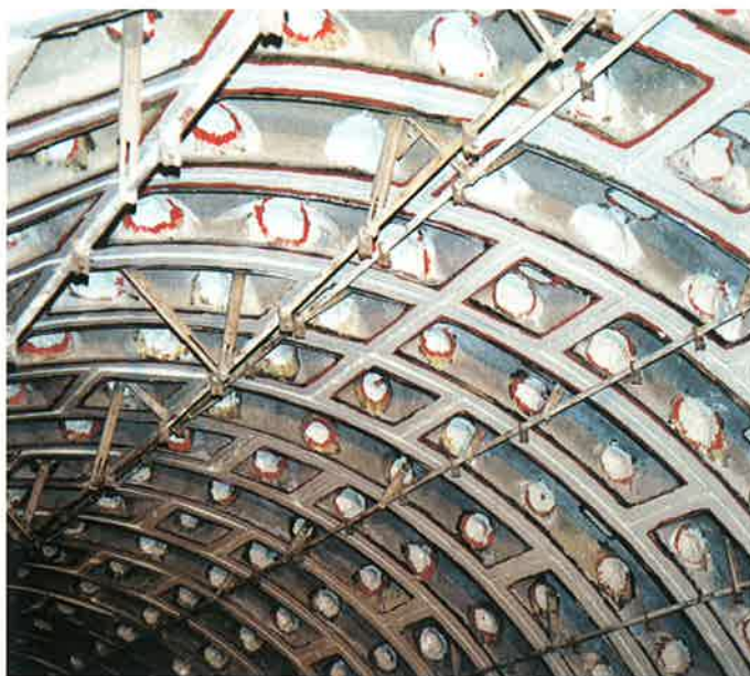
Obr. 3 Ostění stanice po přetěsnění Lining of the station after re-sealing
