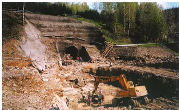
Obr. 2 Štola spodních výpustí – povodní portál (duben 1999) Bottom outlet tunnel - downstream portal (March 1999)
