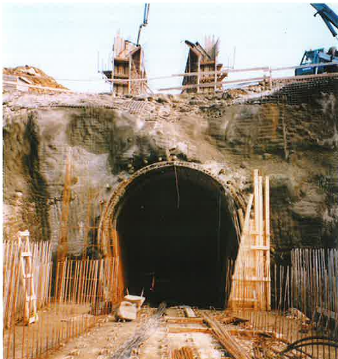
Obr. 4 Štola spodních výpustí – návodní portál – detail (duben 1999) Bottom outlet tunnel - upstream portal - detail (March 1999)
