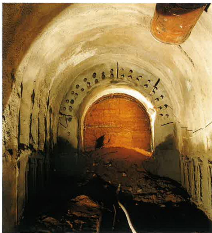
Obr. 5 Ražba 1. lávky záběru kolektoru Excavation of 1st bench
