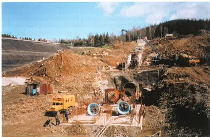
Obr. 3 Štola spodních výpustí – návodní portál (duben 1999) Bottom outlet tunnel - upstream portal (March 1999)
