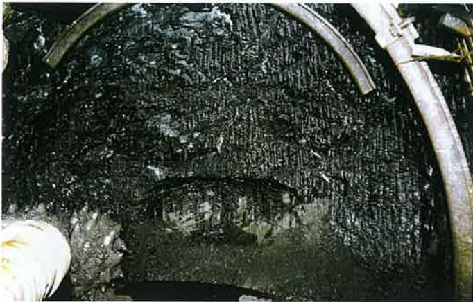
Obr. 2 Celba v homogenním horninovém prostředí jílovitoprachovitých břidlic. Převládající geologická stavba v trase sběrače P. The face in homogenous rock conditions of clayey-powdery gneissic rocks. Prevailing geological composition along the route of the collection sewer "P".
