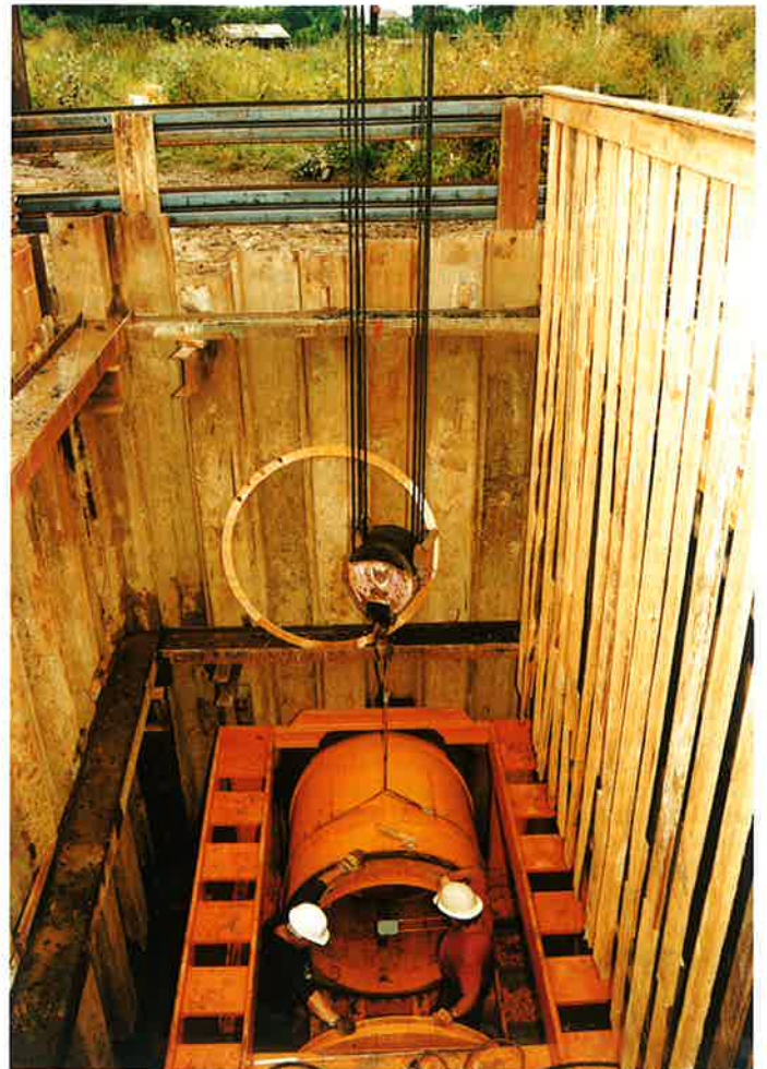
Obr. 3 Kanalizace Modřany II.A - protlačovací souprava PS 1650 v těžní šachtě Sewerage Modřany II.A) pipe jacking equipment PS II.A) in the hauling shaft
