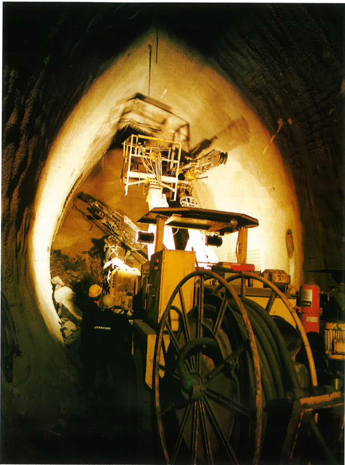
Obr. 2 Kotvení boku pravé předstihové štoly Wall anchoring in the right-hand fore-gallery
