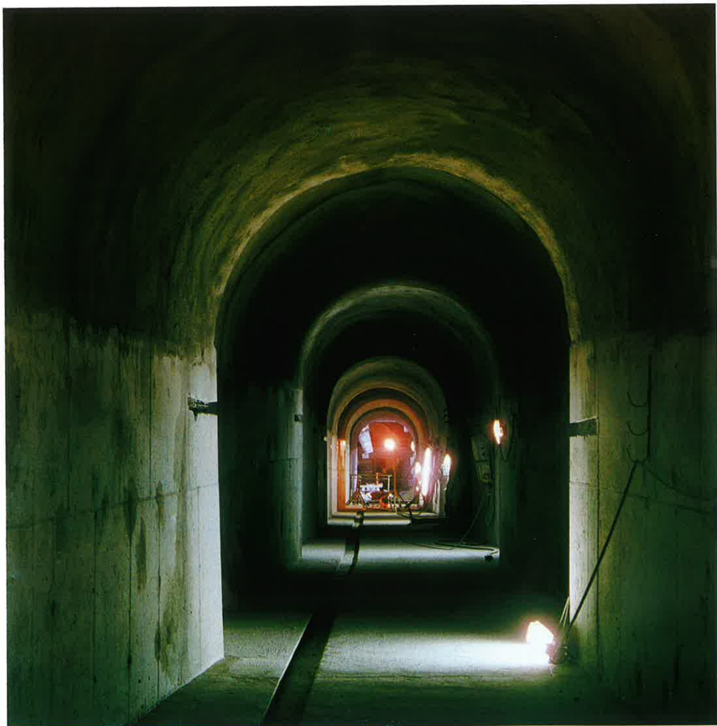
Obr. 4 Definitivní ostění kolektoru Příkopy před montáží vnitřního vybavení Final lining of the Příkopy utility tunnel before installation of internal equipment
