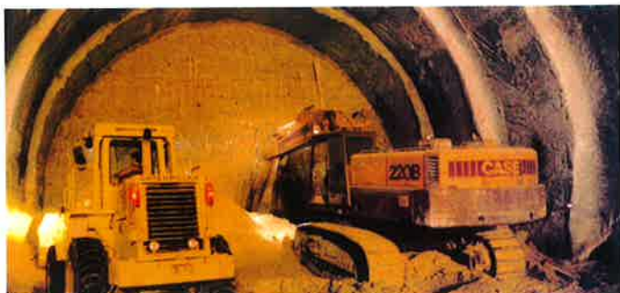
Obr. 9 Fig. 9 Pohled na čelbu a předklenbu View of a heading and a pre-vault
