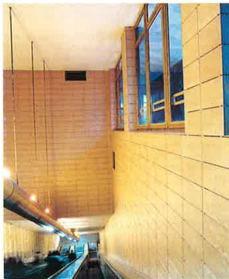
Obr. 1 Fig. 1 Pohled do rekonstruovaného eskalátorového tunelu View of the refurbished escalator tunnel interior
