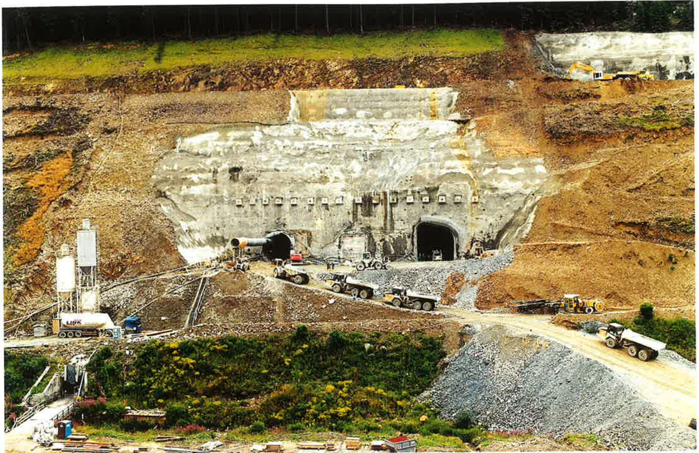
Obr. 3 Fig. 3 Výpustný objekt do dolnej nádrže Outlet structure to the lower basin
