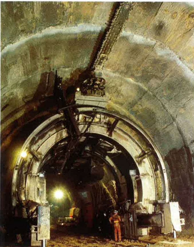
Obr. 11 Fig. 11 Pohled na vrubovací zařízení View of a slot cutting machine
