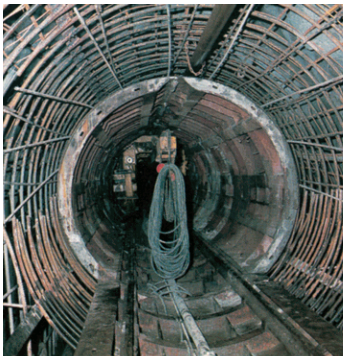
Obr. 7 Fig. 7 Štola surové vody - betonáž Raw water tunnel - concreting
