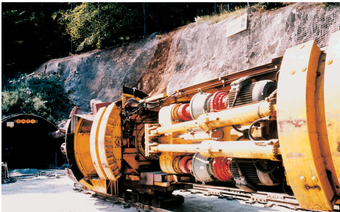
Obr. č. 6 Portál Bystrc - razicí stroj Bystrc portal - boring machine
