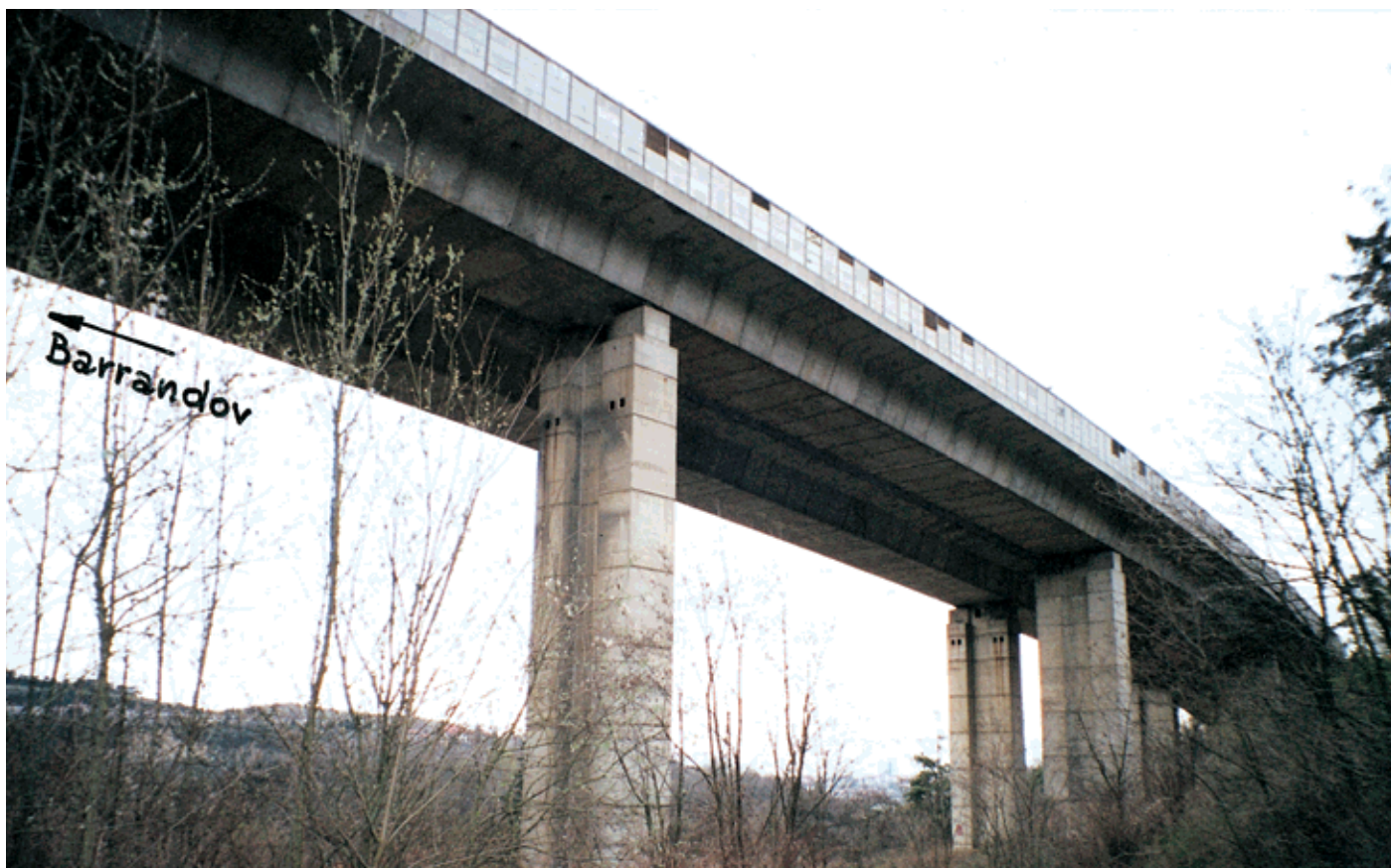
Obr. 3a,b Fig. 3a,b Silniční most přes Růžičkovu rokli Road bridge over Růžicka valley
