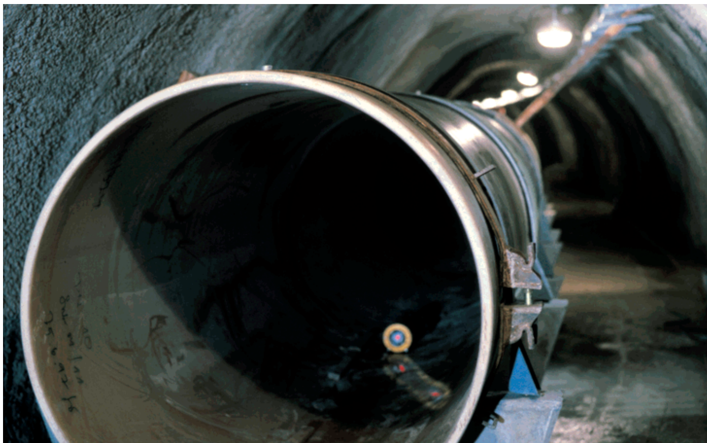
Obr. 5 Fig. 5 Štola Bystrc - Bosonohy - potrubí Hobas Tunnel Bystrc - Bosonohy - Hobas piping
