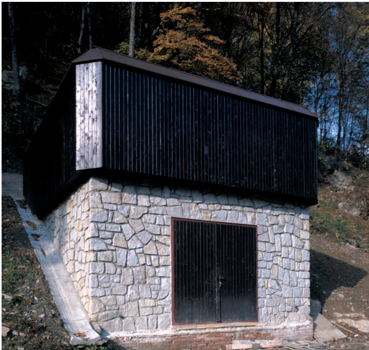
Obr. 8 Fig.8 Portálový domek Bystrc Portal small house - Bystrc
