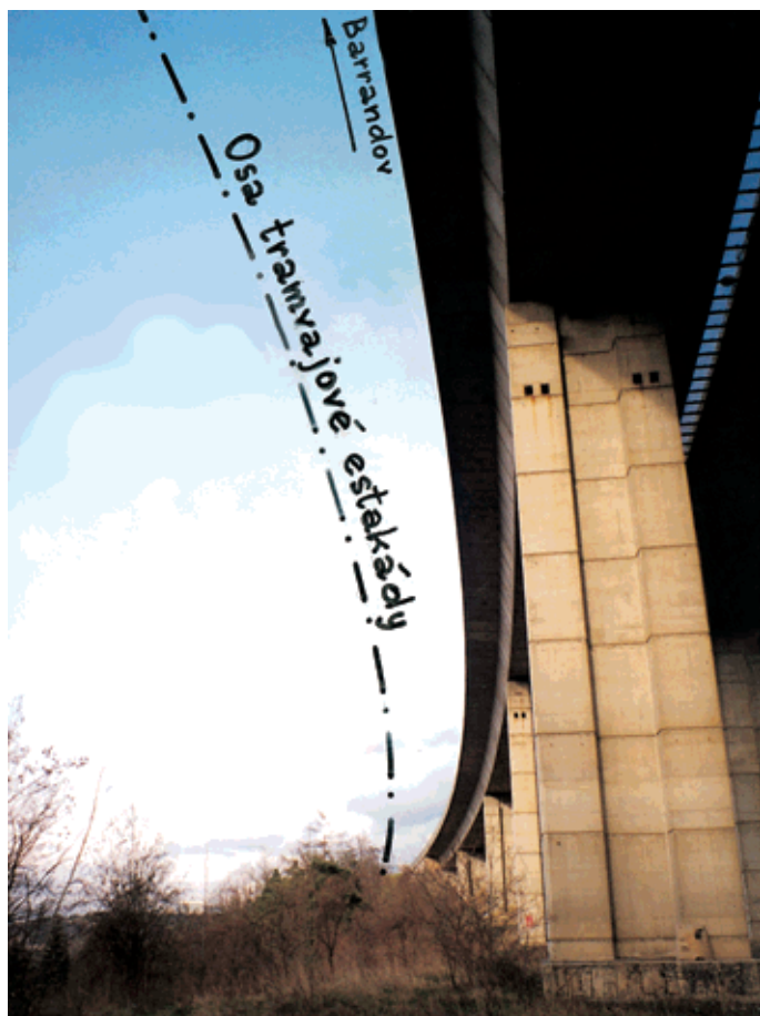
Obr. 2 Fig. 2 Poloha tramvajového mostu Hlubočepy-Barrandov Position of the Hlubočepy-Barrandov tram bridge
