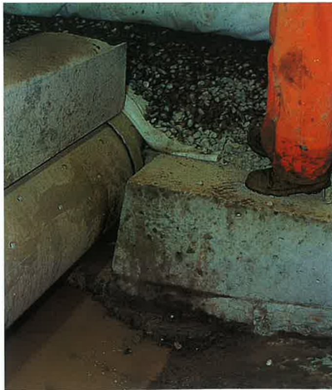
Obr. 4 Detail drenážní vrstvy Fig. 4: Detail of a drainage layer
