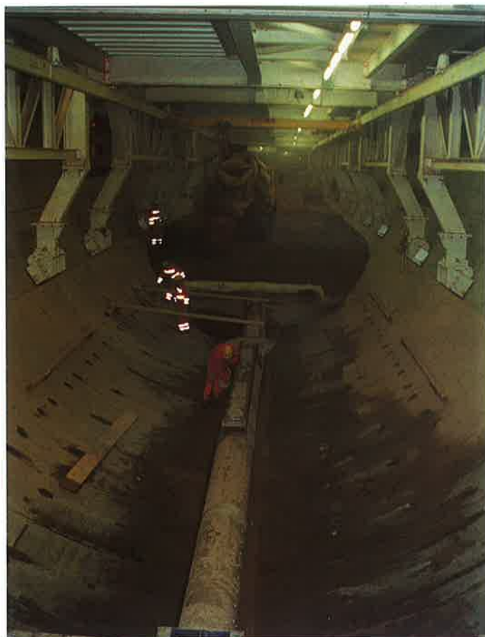
Obr. 3 Pohled na položené průsakové vedení Fig. 3: View onto an installed drainage
