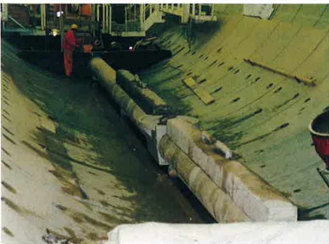
Obr. 2 Položené vedení s vybetonovanou průsakovou vrstvou Fig. 2 Laid down line with a drainage layer
