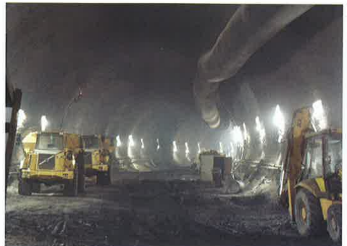
Vyražený třípruhový tunel u severního portálu Excavated three lane tunnel by the northern portal
