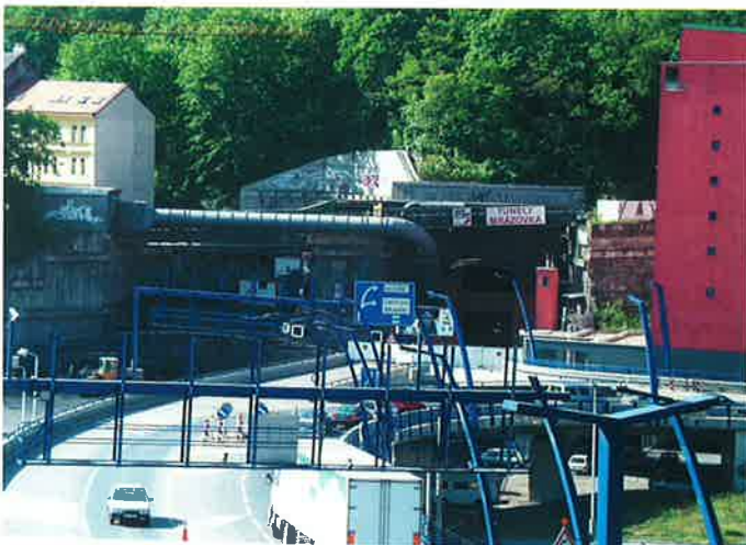
Pohled na severní portál View of the northern portal
