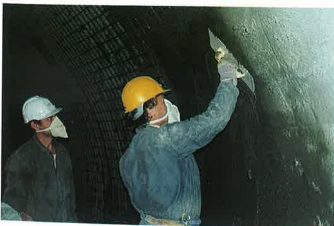
Zahlnění nastříkané betonové směsi před aplikací hydroizolace Smoothing of shotcrete surface before application of hydroinsulation
