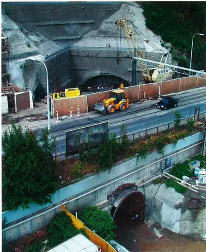
Pohled na jihozápadní portál - kotvené skalní stěny, přístupová štola pod ulicí Radlická View of the south-western portal - anchor bolted rock walls, access gallery under Radlická street
