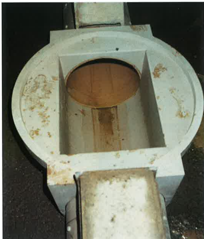
Obr. 5 Detail zabudované revizní šachty Fig. 5: Detail of a built-in inspection shaft
