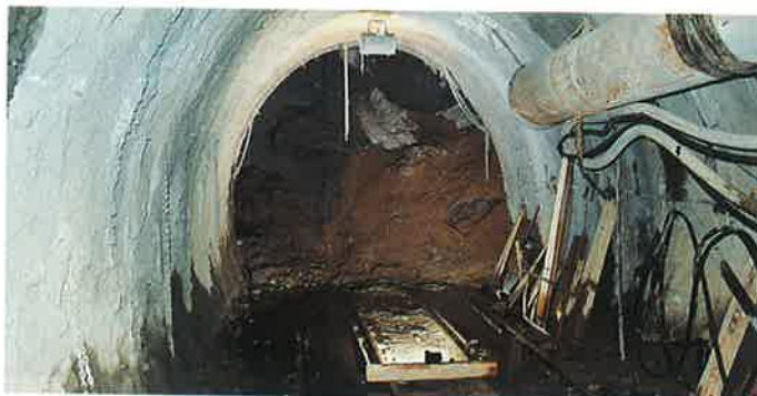
Ražba kolektoru provedená primárním nástřikem Driving of collecting duct with subsequent primary spray-on
