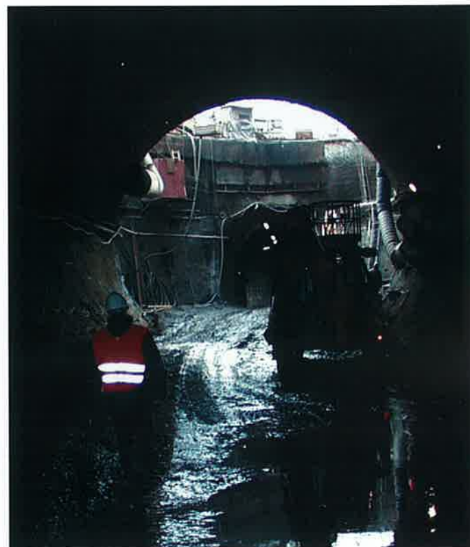
Dvoupruhový tunel u jihozápadního portálu Two-lane tunnel by the south-western portal
