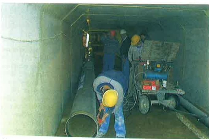
Obr. 1: Uložení trub do manipulační chodby a postup při montáži Fig. 1: Laying down of tubes into a service corridor and advance during the assembly
