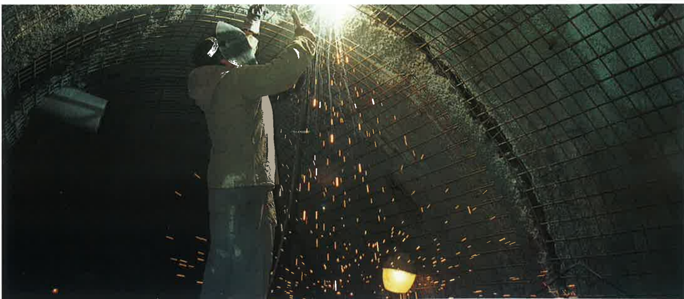
Svařování sítě pro zesilující sekundární výztuž Welded mesh for secondary lining
