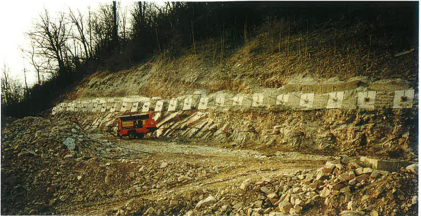
Obr. 4. Zakotvená I. etáž a odkop II. etáže
