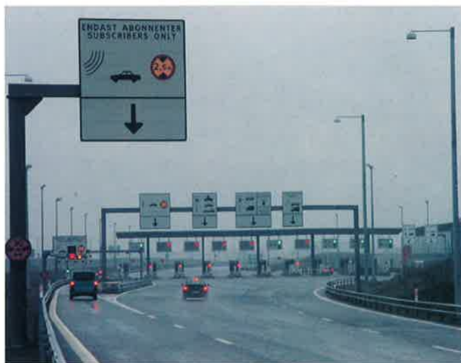
Obr. 7. Mýtné místo je situováno na švédské straně Fig. 7. The toll collection facility is situated on the Sweden side
