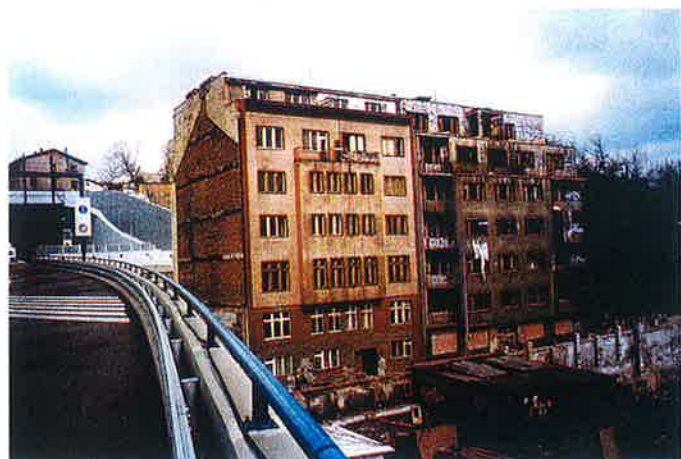
Obr. 1. Pohled na jižní portál Strahovského tunelu s chybějícím východním mostem
