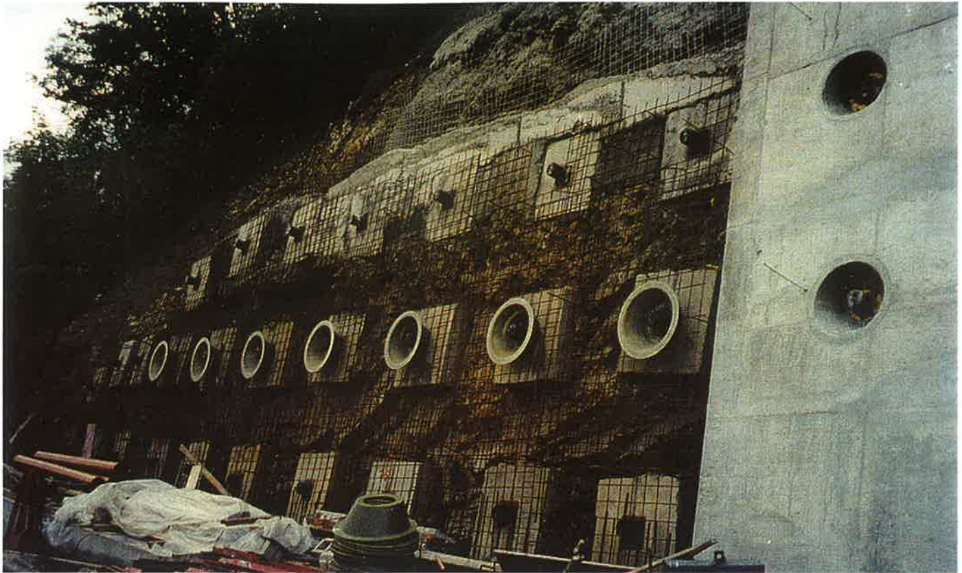
Obr. 7. Plastové kalichy trvalých reinjektabilních kotev Fig. 7. Plastic moulds on permanent regrowable anchors
