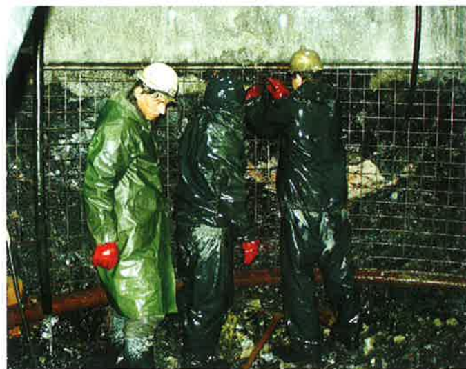
Foto číslo 1 Pohled na severní stěnu šachty v úrovni 39 m pod povrchem terénu. Světlá čárka v tmavé hornině reprezentuje hydrotermální povlaky puklin v okolí spililitové žíly. Mokrý prostředí kladlo zvýšené nároky na práci razičů.
