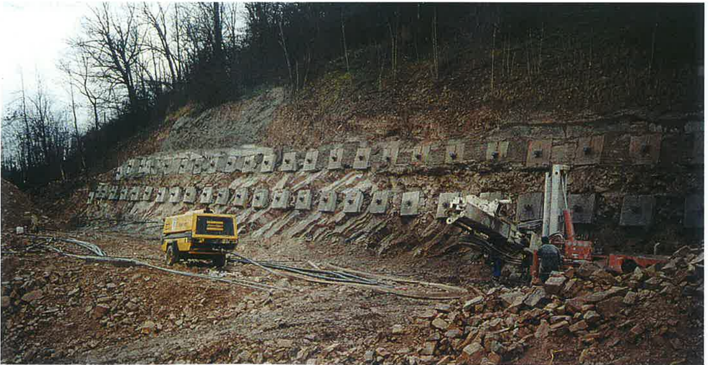
Obr. 5. Zakotvená I. a II. etáž, odkop pro III. etáž
