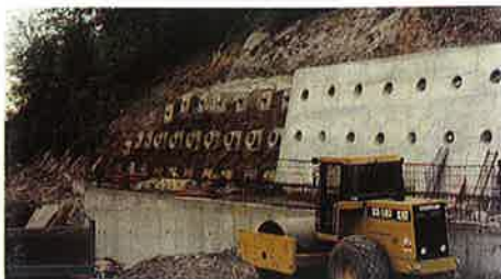
Obr. 8. Betonáž obkladní zdi ze samozhutitelného betonu Fig. 8. Pouring of the self-compacting concrete of the cladding wall
