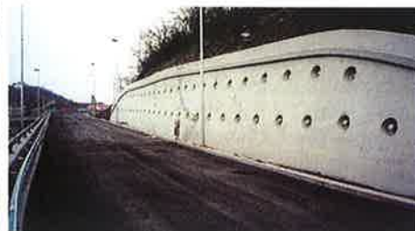
Obr. 9. Rampa „D“ se zajištěním svahu Sacre Coeur Fig. 9. Ramp „D“ with the Sacre Coeur slope support
