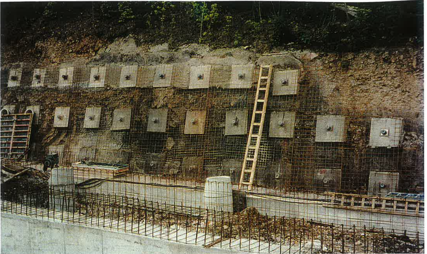
Obr. 6. Zakotvená I. až III. etáž a výztuž obkladní zdi Fig. 6. Levels I to III anchoring completed, the cladding wall reinforcing in progress
