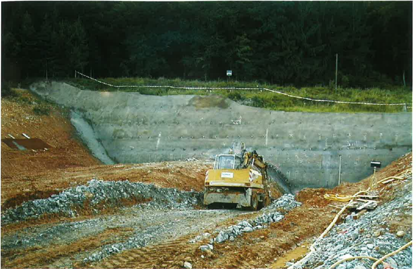
Obr. 10 Tunel Schellenberg – zahájení profilování zemního tělesa Fig. 10 The Schellenberg tunnel – beginning of the ground body profiling
