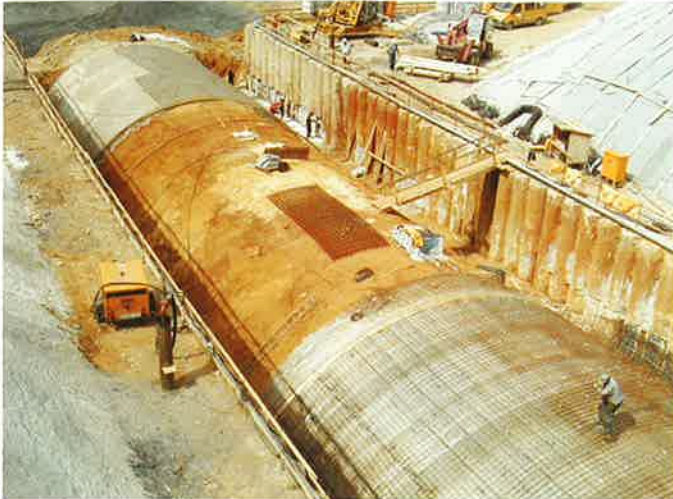
Obr. 6 Tunel Euerwang – fáze postupu výstavby Fig. 6 The Euerwang tunnel – the construction progress phases
