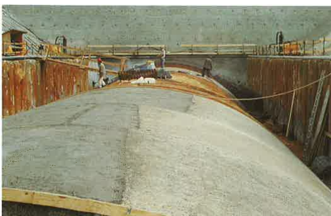
Obr. 5 Tunel Euerwang – profilovací šablona Fig. 5 The Euerwang tunnel – the profiling template
