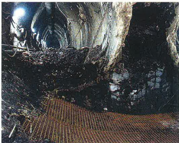
Obr. 3 Výrub s vertikálním členěním při uzavírání spodní klenbou Fig. 3 Vertical sequencing at closing of the excavation by invert (photo J. Altman)
