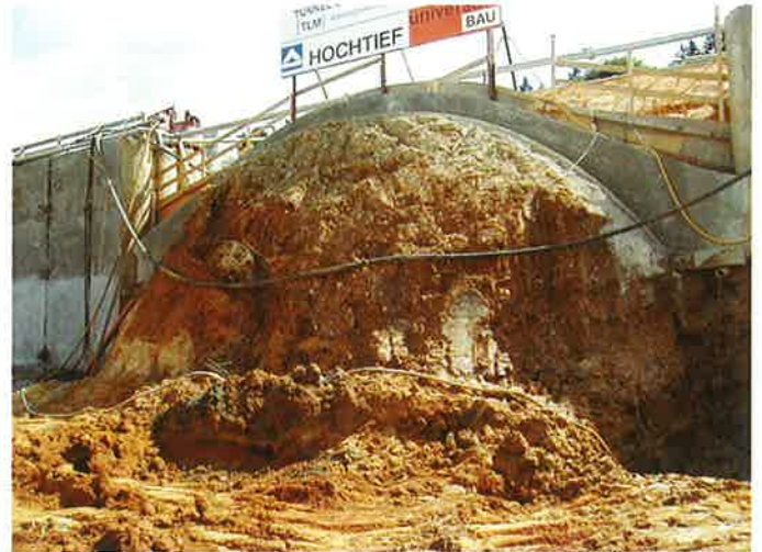
Obr. 8 Tunel Euerwang – zemní těleso před zahájením ražby Fig. 8 The Euerwang tunnel – the ground body before beginning of the mining
