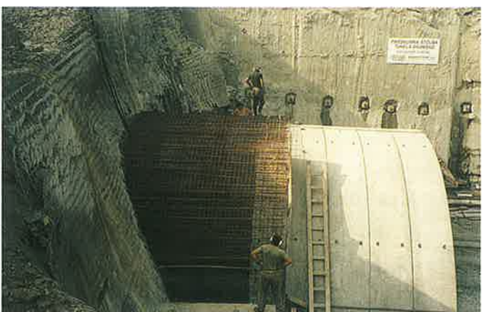
Obr. 4 Tunel Branisko – prefabrikovaná konstrukce želvy Fig. 4 The Branisko tunnel – prefabricated structure of the "Turtle mail"
