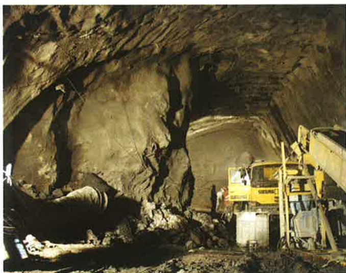
Obr. 3 Realizace opěrného klínu Fig. 3 Realization of the supporting wedge
