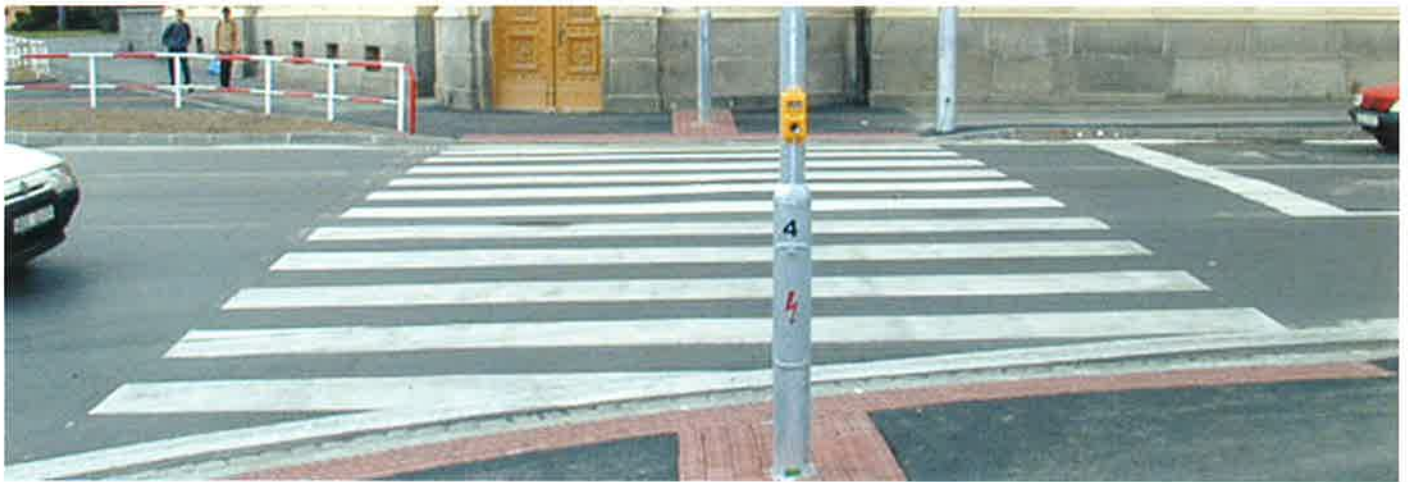
Obr. 10 Hmatné úpravy a řešení akustické signalizace na přechodu pro chodce Fig. 10 Tactile modifications and solutions of the acoustic signaling at the road cross-walks
