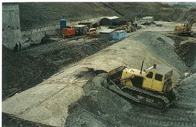
Obr. 2 Tunel Branisko – hutněný zásyp konstrukce Fig. 2 The Branisko tunnel – compacted backfill of the structure
