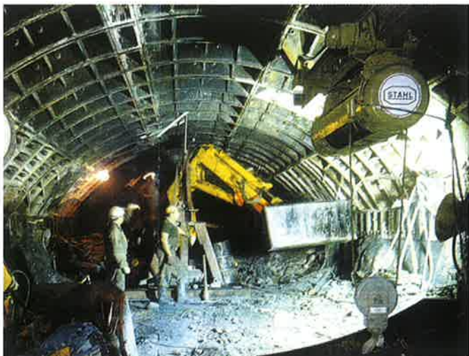
Obr. 6 Ražba kaloty středního tunelu stanice Můstek A Fig. 6 Central tunnel top heading excavation of the Můstek station
