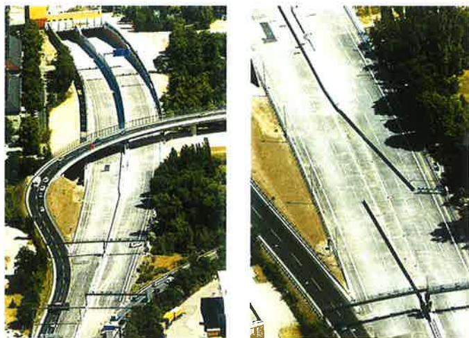
Obr. 3 Klidová poloha bariér (obr. vlevo) a bariéry při změnách směru dopravy (obr. vpravo)
