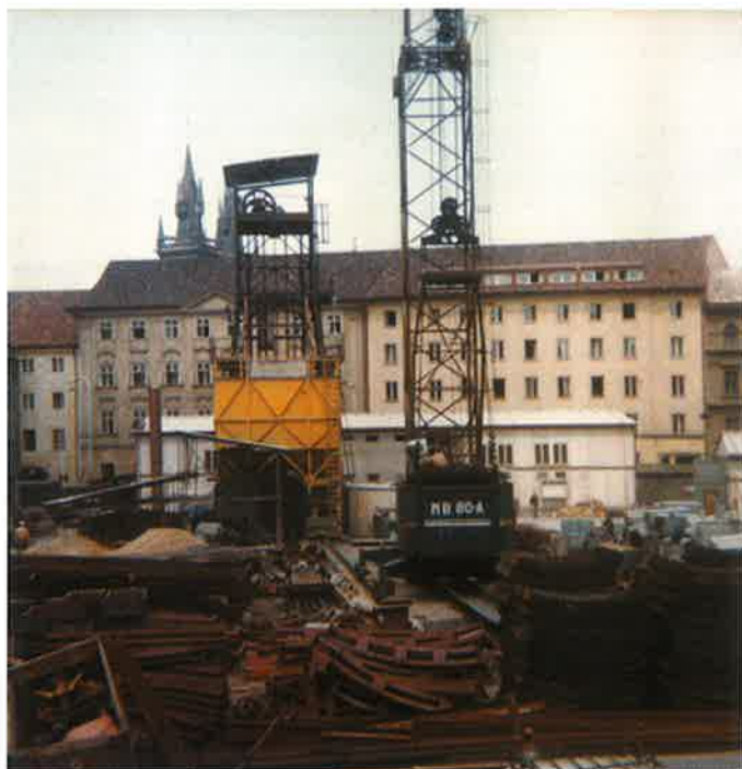
Obr. 3 Stavěniště v proluce Myslbek – 70. léta minulého století (odsud probíhala výstavba obou stanic Můstek A i B) Fig. 3 Construction site at the Myslbek clearance – the seventies of the last century (serving for construction of both Mustek stations, i.e. on the lines A and B)
