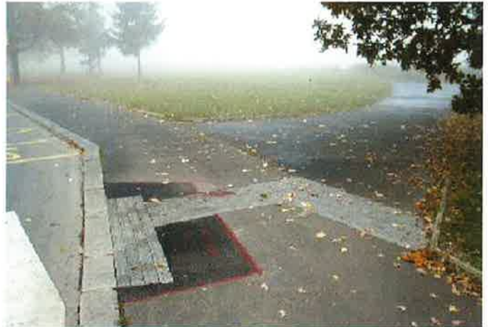
Obr. 9 Dodatečně prováděné bezbariérové úpravy na přechodu pro chodce Fig. 9 Additionally performed barrier-free modifications of pedestrian overpasses
