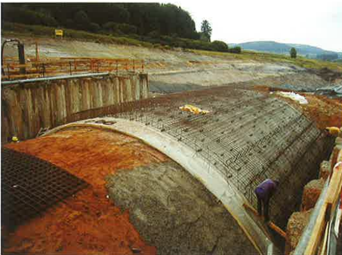
Obr. 7 Tunel Euerwang – osazování výztuže Fig. 7 The Euerwang tunnel – reinforcement fixing
