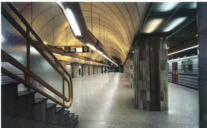
Obr. 2 Střední tunel stanice Florenc IB (sloupová s rozšířenou střední lodí) se zaústěným přestupním schodištěm ze stanice Florenc IC
