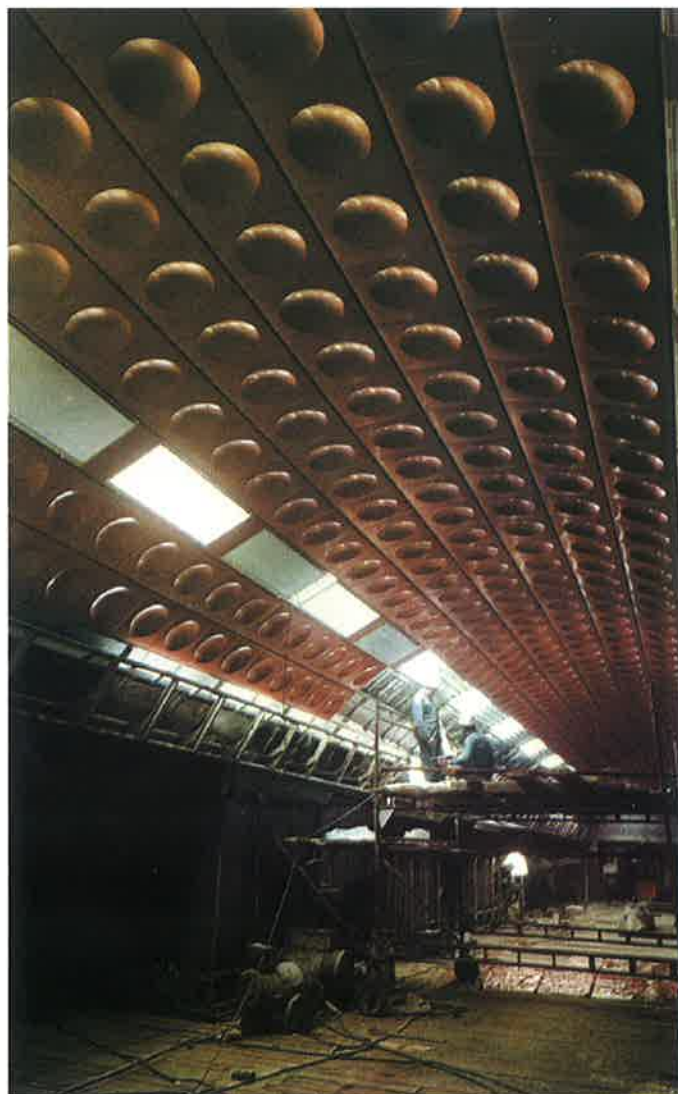
Obr. 6 Montáž obkladu středního staničního tunelu ražené stanice trasy A Fig. 6 Installation of cladding in a central tunnel of a driven station on the line A
