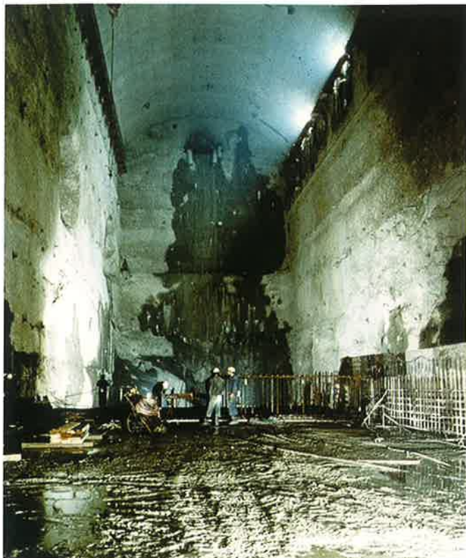
Obr. 1 Kaverna podzemní hydrocentrály PVE Dlouhé Stráně Fig. 1 The cavern of the underground hydro-electric power station PVE Dlouhé Stráně
