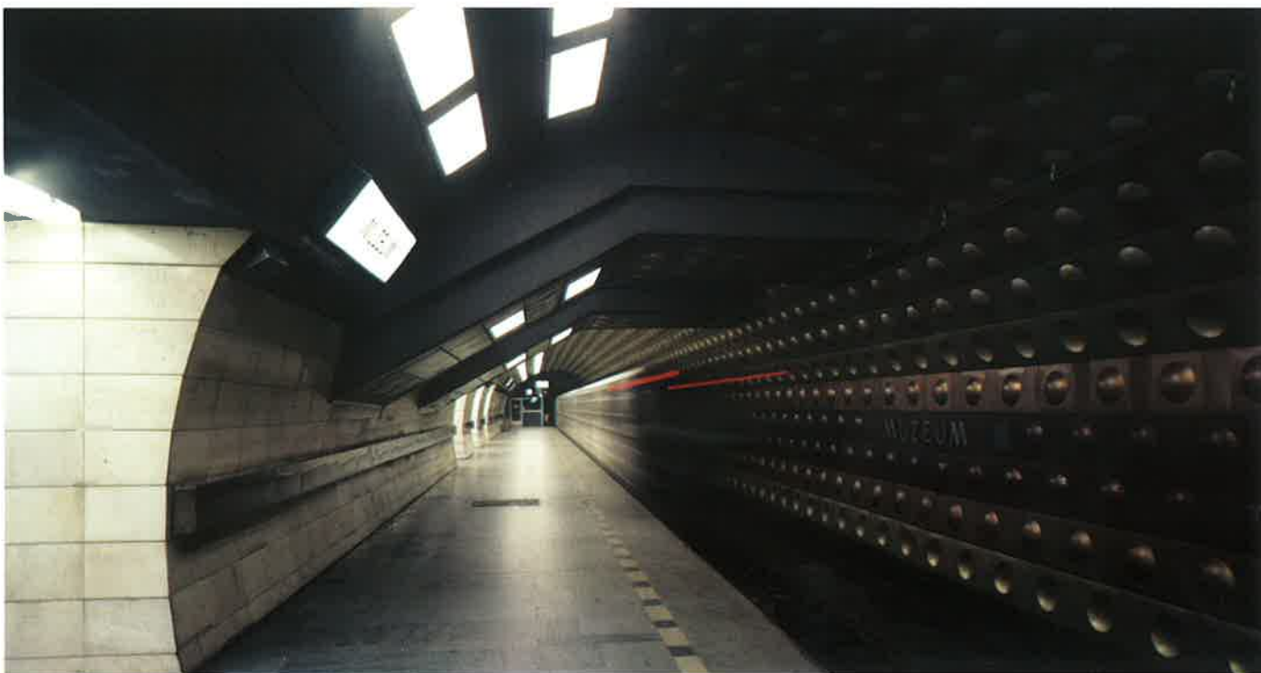
Obr. 3 Boční tunel stanice Muzeum IA (klasická pilířová)
