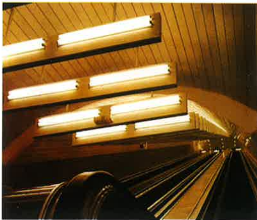
Obr. 1. Ilustrační foto – eskalátory v pražském metru Fig. 1. Escalators of Prague metro
