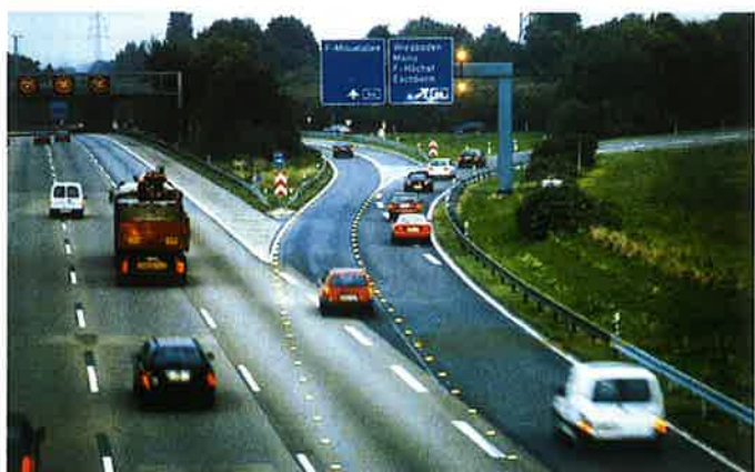
Obr. 4 Světlo emitující elementy vyznačující změnu směru jízdy na dálnici Fig. 4 Light-emitting elements marking a change in the traffic flow on a motorway
