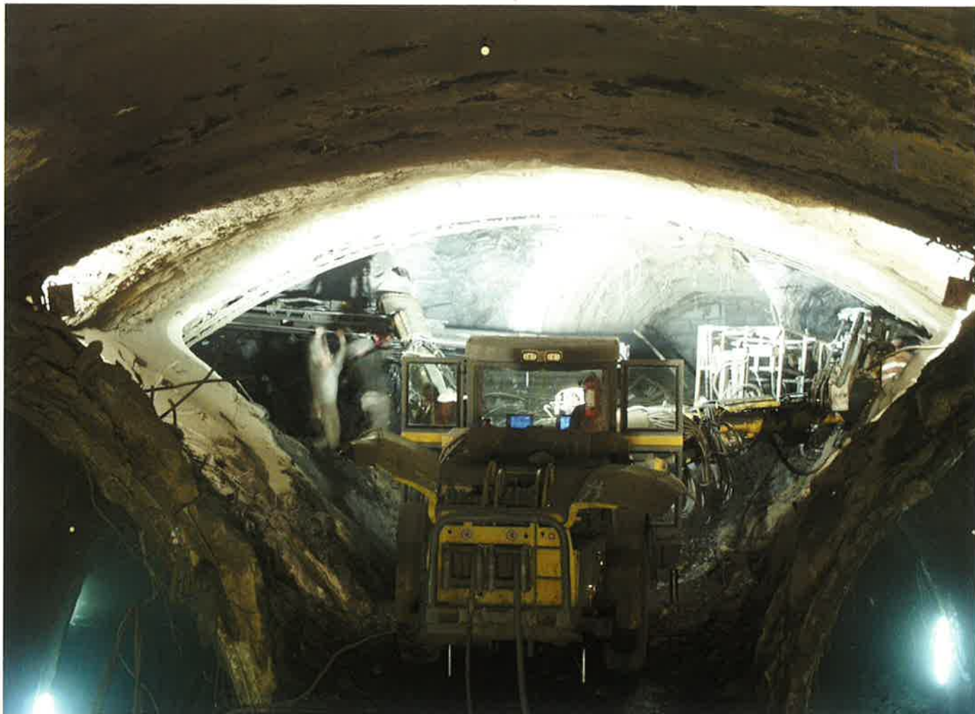
Obr. 7 Kotvení horniny nad kalotou rozpletu Fig. 7 Rock anchoring over the bifurcation chamber top heading
