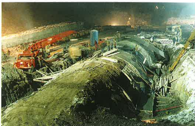
Obr. 1 Tunel Branisko – postup výstavby Fig. 1 The Branisko tunnel – process of construction
