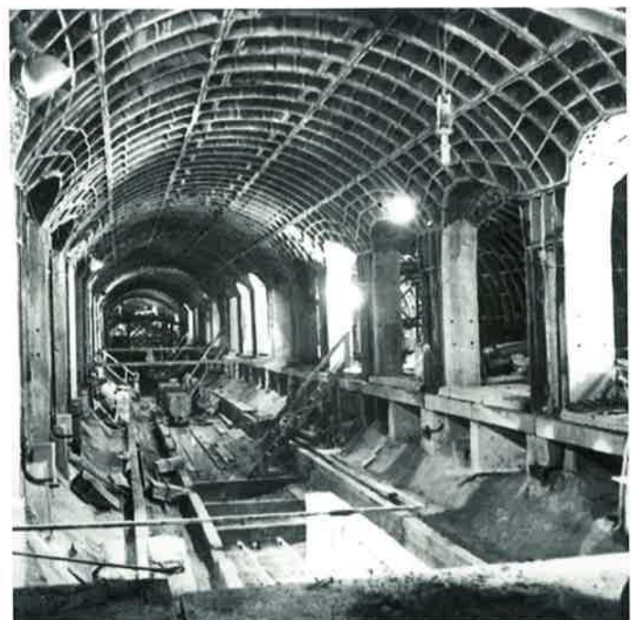
Obr. 2 Výstavba sloupové stanice metra v Moskvě (konec 60. let minulého století) Fig. 2 Construction of a pillar type of metro station in Moscow (the end of the sixties of the last century)
