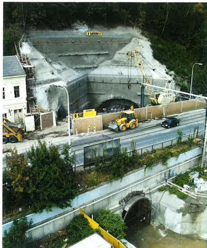
Obr. 2 Jihozápadní portál dvoupruhového tunelu Fig. 2 Southwestern portal of the double-lane tunnel
