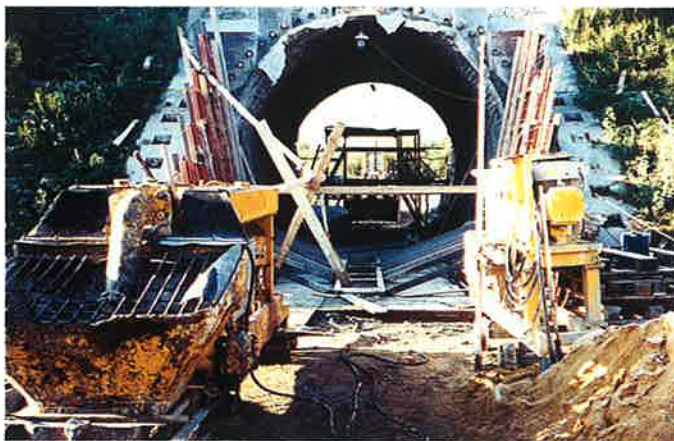
Obr. 7 Klenbový most v násype železničnej trate Fig. 7 Arched bridge in a railway embankment
