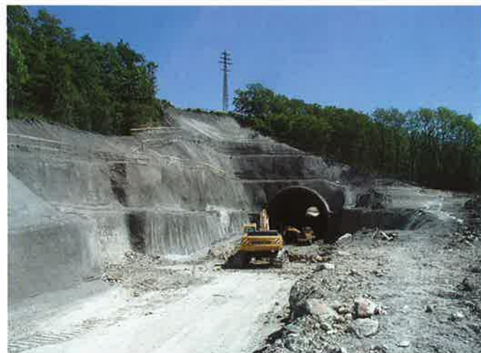
Obr. 10 Odtěžování na úroveň spodní klenby před betonáží definitivního ostění (hloubka jámy 29 m) Fig. 10 Excavation up to the level of the invert before casting of the final lining (the pit depth of 29 m)
