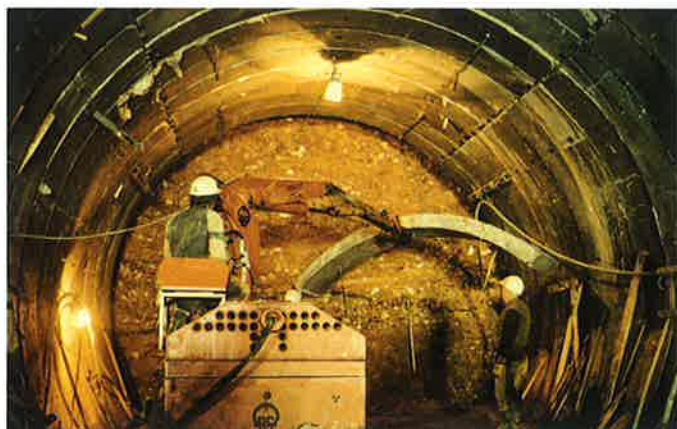
Obr. 2 Štvorsegmentová montovaná výstuž Fig. 2 Four-segmental prefabricated lining
