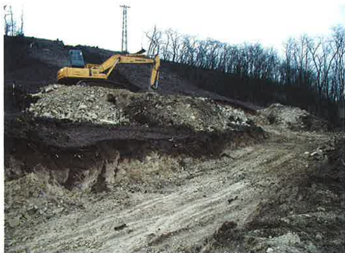
Obr. 7 Přístupová komunikace k horním etážím pražského portálu Fig. 7 The access road to the upper banquettes of the Prague portal
