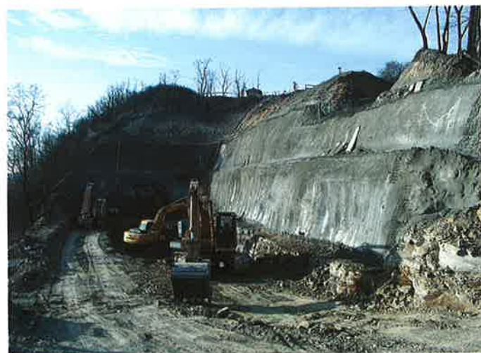
Obr. 3 Zahájení odtěžování čtvrté etáže a příprava ochranného "deštníku" nad kalotou tunelu Fig. 3 Starting of the fourth banquette excavation, and preparation of the "umbrella" above the tunnel crown
