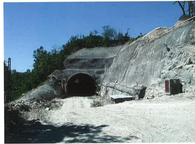
Obr. 4 "Světlo na konci tunelu" po prorážce v květnu 2001 - čtvrtá etáž odtěžena na rozhraní jádro - počva Fig. 4 "The light at the end of the tunnel" after the breakthrough in May 2001. The fourth banquette excavated at the core-invert interface
