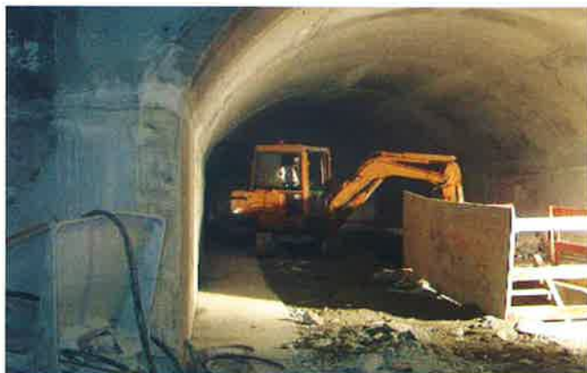
Obr. 9 V tomto výklenku na francouzské straně se začíná bagrovat propojení se vzduchovým kanálem
