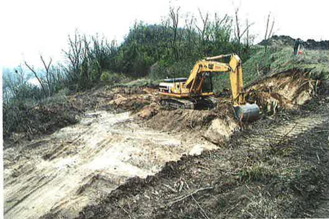
Obr. 1 Zahájení prací na odtěžování první etáže děčínského portálu v kvartérních sedimentech (písky) Fig. 1 Starting the work on excavation of the first banquette of the Děčín portal in the Quaternary sediments (sands)
