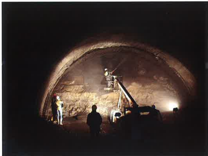
Obr. 5 Nástřik primárního ostění kaloty Fig. 5 Spraying of the top heading primary lining
