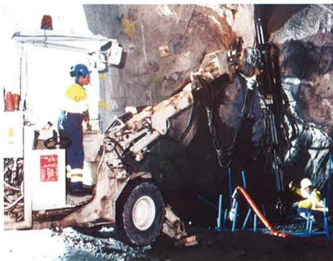
Obr. 2 Oheň kompletně zničila betonovou obezdívku Fig. 2 The fire completely destroyed the concrete lining
