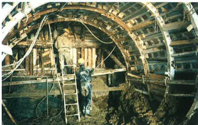
Obr. 1 Tunelárska metóda vystužovania čelby. V obtiažnych geologických podmienkach a vo výnimočných situáciách sa používa dodnes.
