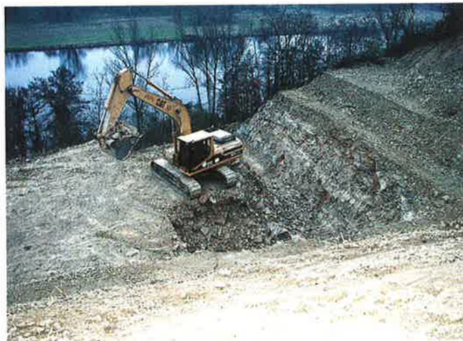
Obr. 2 Druhá etáž již zasahovala do vrstev zvětralých a silně rozpukaných slínovců Fig. 2 The second banquette reached into the layers of weathered and heavily fractured marbles
