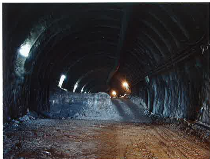
Obr. 6 Ražba jádra a rampa do kaloty v technologické třídě výrubu IV. Fig. 6 The core excavation, and the ramp to the top heading driven in technological excavation class IV.
