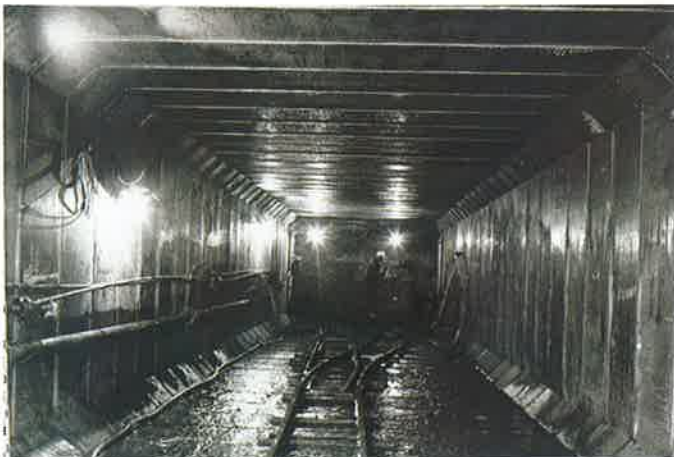
Obr. 6 Podchod z rámových železobetónových prefabrikátov, vybudovaný pretláčaním Fig. 6 A subway from prefabricated reinforced concrete frames, built by means of jacking
