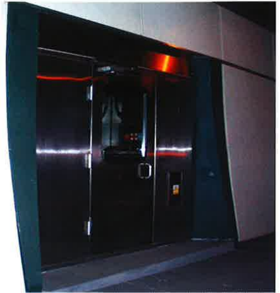
Obr. 4 Skříně SOS (SAT) Fig. 4 SOS cabins (SAT)
