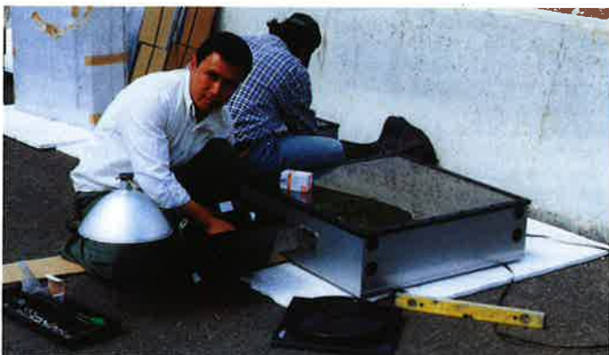
Obr. 3 Příprava mechanické montáže proměnných dopravních značek na staveništi Fig. 3 Preparation of the mechanical assemblage of the variable traffic signs at the construction site
