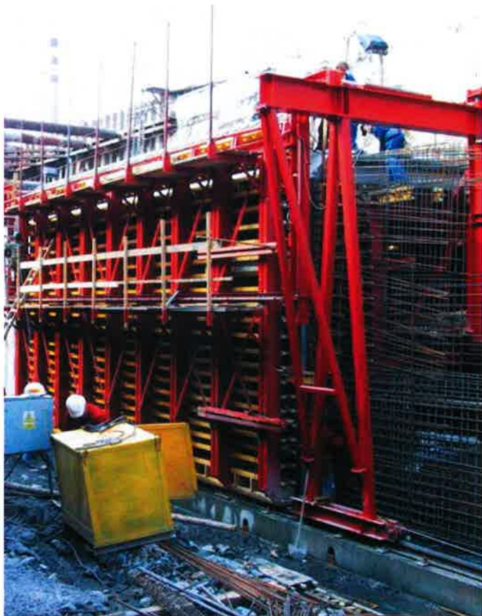
Obr. 1 Posuvné bednění a částečná výztuž dalšího segmentu Fig. 1 Sliding formwork and partial reinforcement of the next segment
