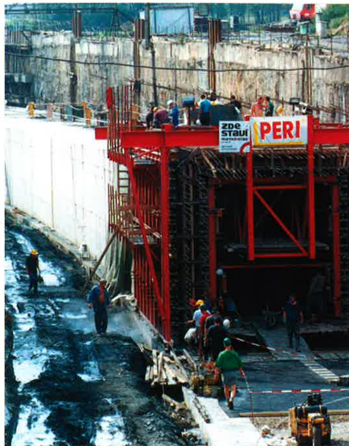
Obr. 2 Pohled na posuvné bednění zřepředu Fig. 2 Front view of the formwork
