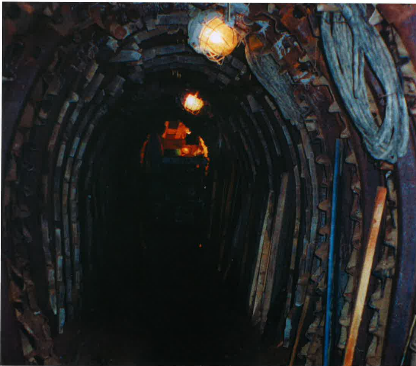
Obr. 4 Děčín - kanalizační štola Fig. 4 Děčín - sewerage gallery
