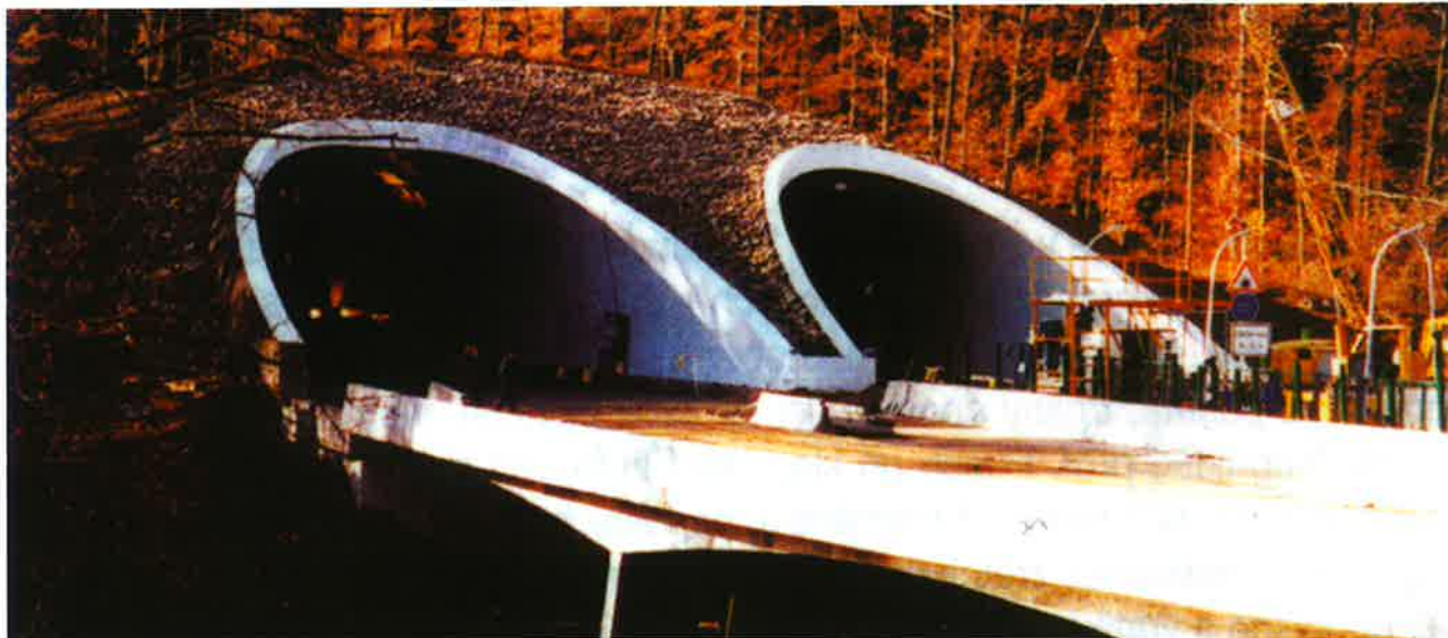
Obr.1 Pohled na portál Pisáreckého tunelu Fig. 1 View of the Pisárecký tunnel portal
