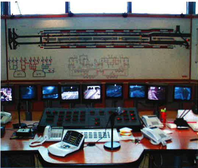
Obr. 3 Dispečerské pracoviště - velín SAT Fig. 3 SAT control stand
