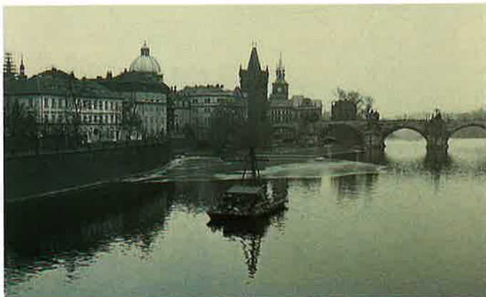
Obr. 4 Průzkum pro pražské metro v roce 1972 - přechod trasy A pod Vltavou
