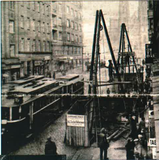
Obr. 1 Sondovací práce pro II. železniční tunel na Vinohradech (1933)
