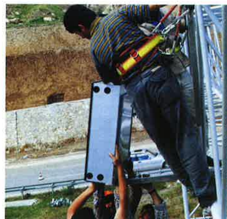
Obr. 2 Mechanická montáž proměnných dopravních značek na portál Fig. 2 Mechanical installation of variable traffic signs on the gantry
