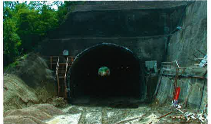
Obr. 6 Monitoring při výstavbě železničního tunelu Kralupy v rámci modernizace I. železničního tranzitního koridoru (2001)
