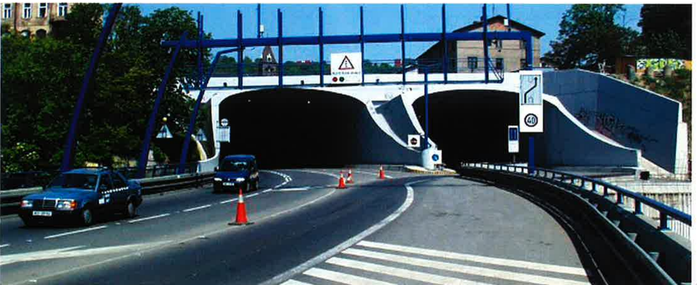
Obr. 6 Jižní portál SAT Fig. 6 SAT southern portal
