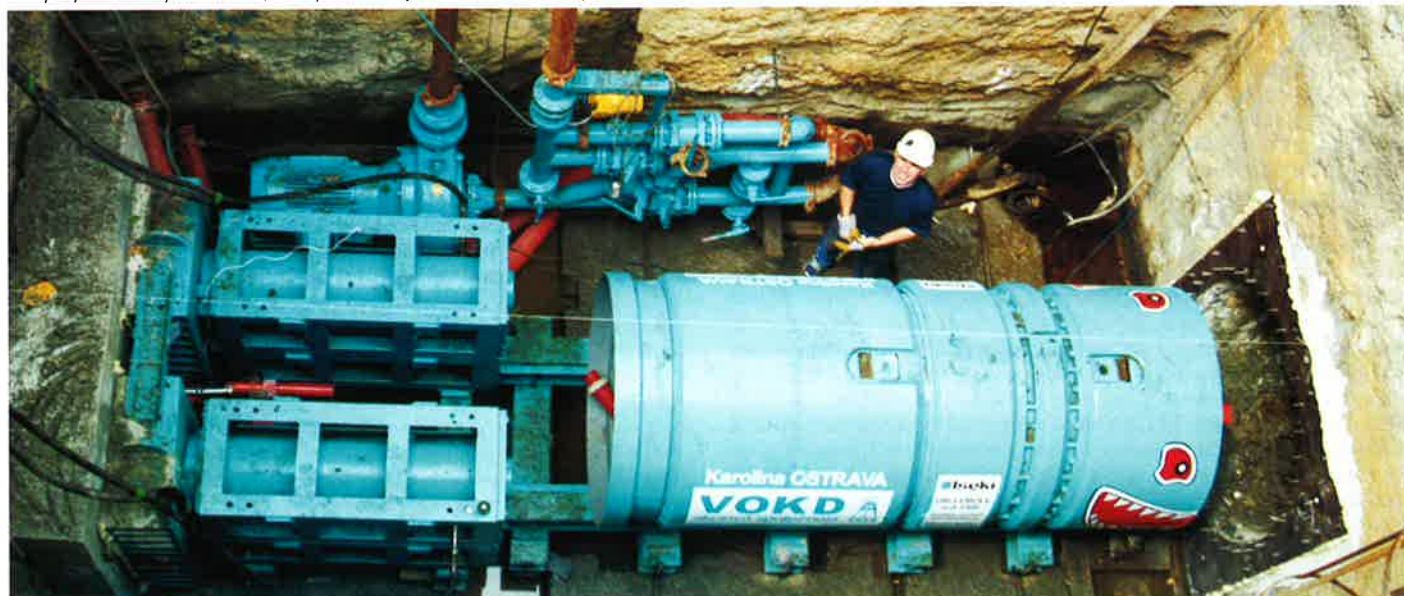
Obr. 1 Zařízení připravené k protlaku Fig. 1 Equipment ready to start the jacking
