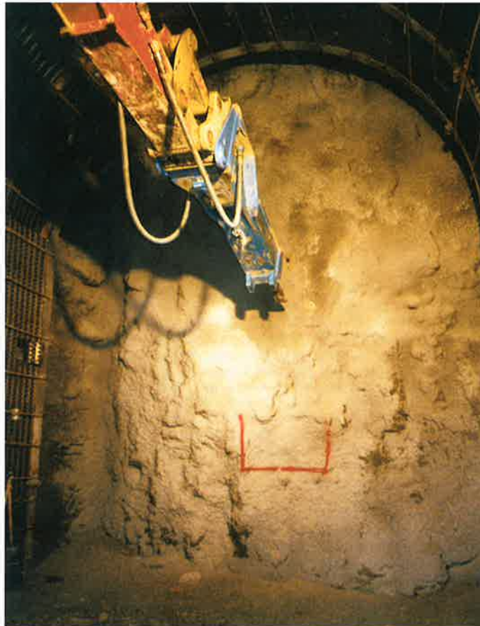
Obr. 6 Moment před prorážkou tunelu pneumatickým impaktorem - zbývá 80 cm Fig. 6 The moment before the tunnel holing with the pneumatic impactor - 80 cm remaining
