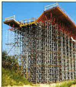
Silniční most, Beluša, Slovensko
