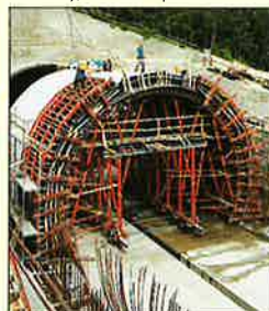
Železniční tunel, Vraňany, Česká republika
