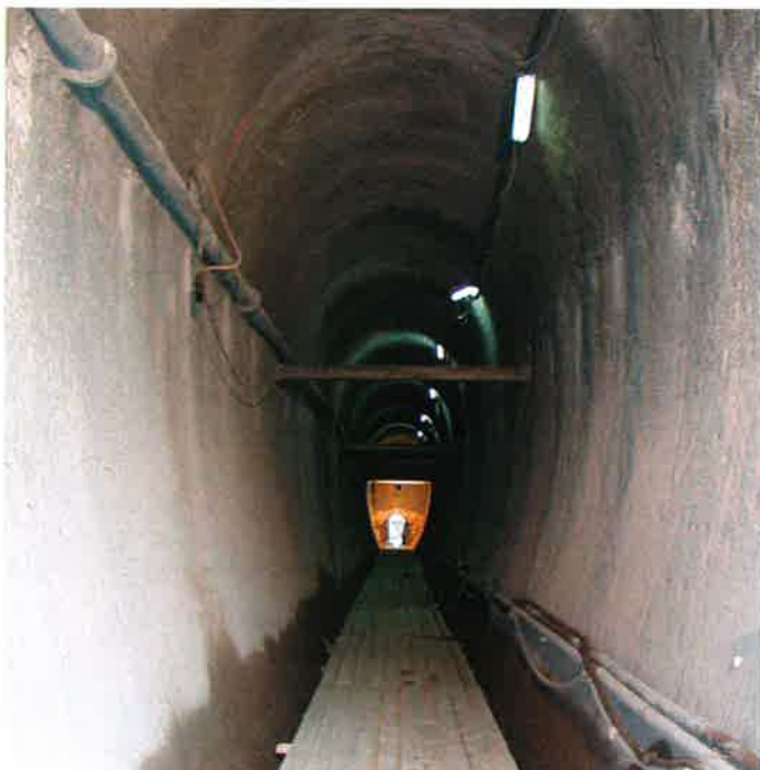
Obr. 2 Primární ostění tunelu ve valu Prašného mostu Fig. 2 Primary lining of the tunnel in the Powder Bridge embankment
