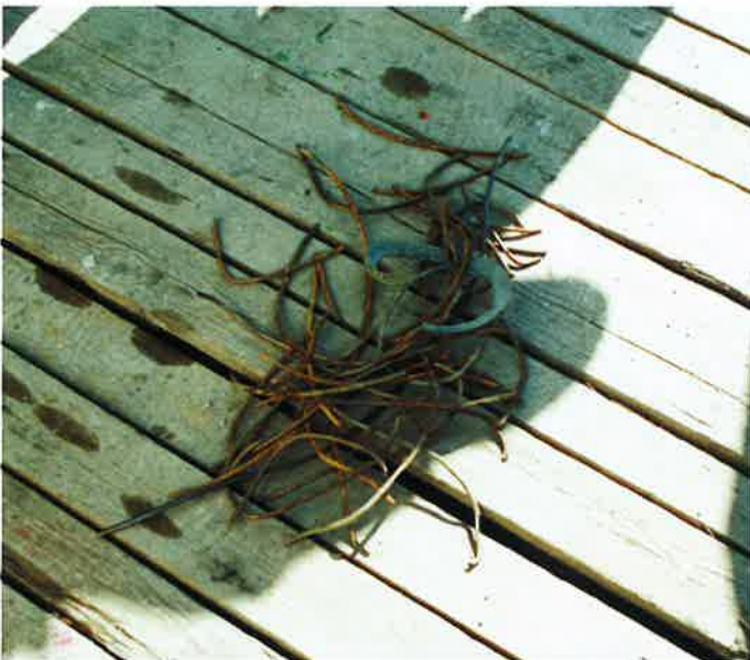
Obr. 2 Úlomky amatur po pročištění slurry potrubí Fig. 2 Fragments of reinforcement found in slurry
