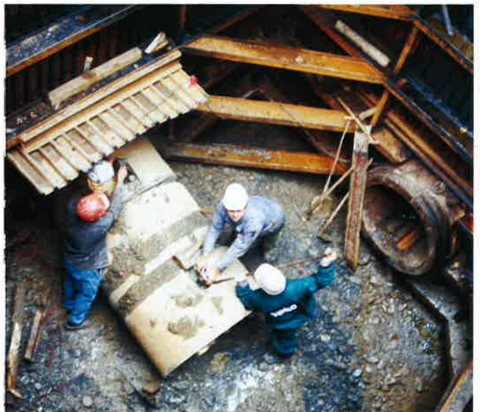
Obr. 3 Vytažení štítu z Š2 po dokončení protlaku Š1 - Š2 (174,6 m) Fig. 3 Lifting the shield from the Š2 manhole after completion of pipe jacking between Š1 and Š2 (174,6 m)
