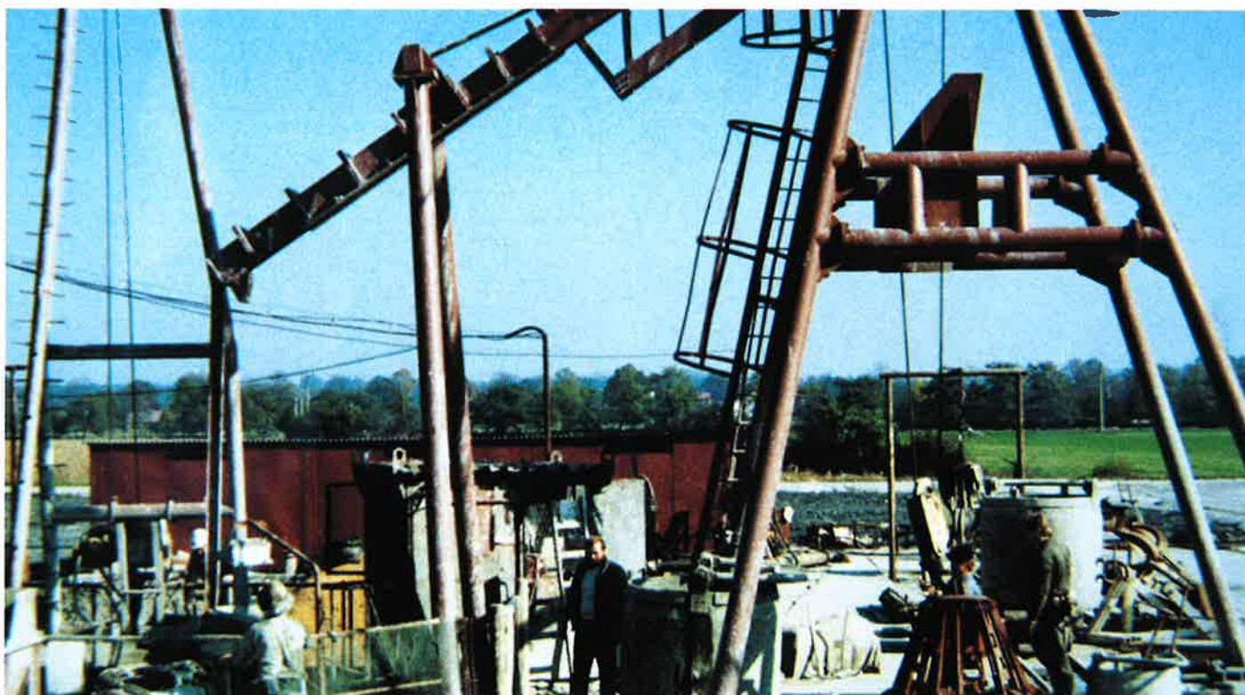
Obr. 4 „Kudlanka“ zahlubovací zařízení jam vyvinuté VOKD Fig. 4 „Kudlanka“ shaft collaring equipment developed by VOKD
