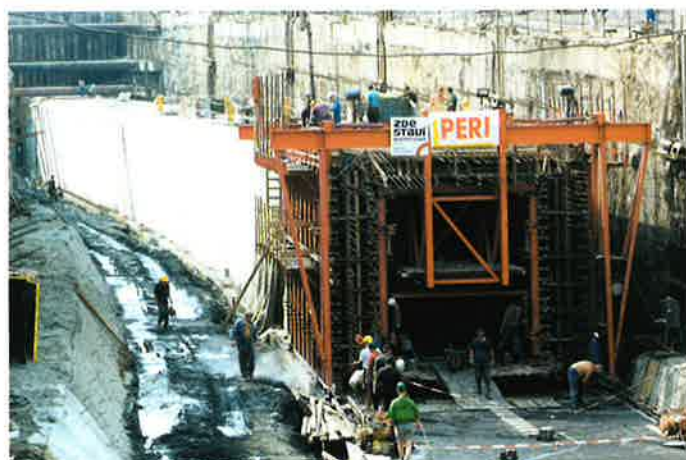
Obr. 1 Rozepření čelní stěny suchého doku Fig. 1 Bracing of the front end wall of the dry dock
