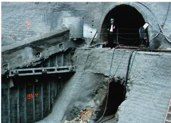
Obr. 1 Pohled na kalotu, Tereziánskou štolu a polohově zajištěnou kanalizaci v DJP
