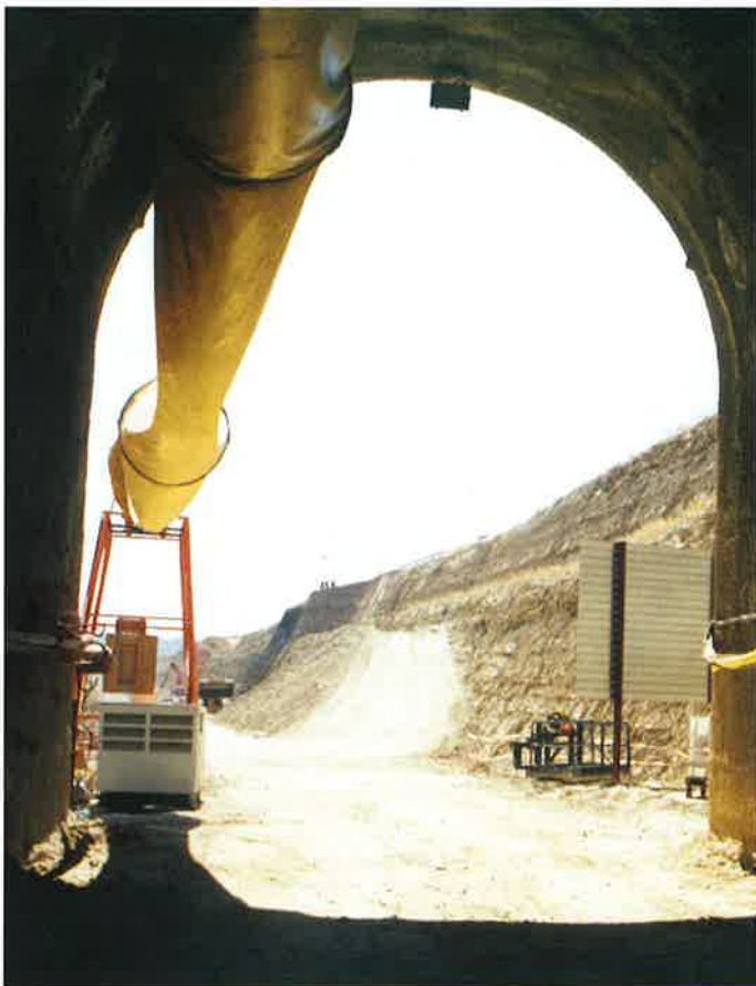
Obr. 5 Portál tunelu El Cotijo Fig. 5 The El Cotijo tunnel portal
