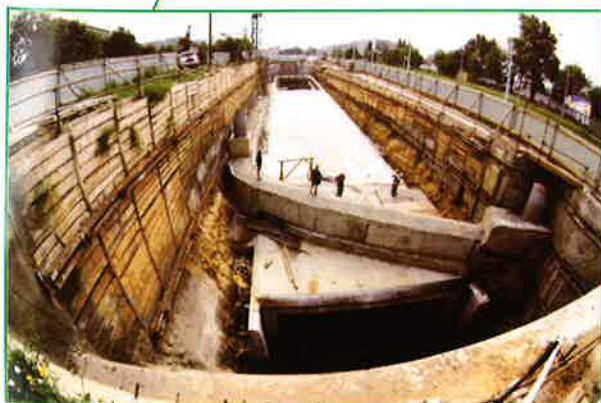
Výstavba hloubených tunelů metra IV.C.1 u stanice Ládví
