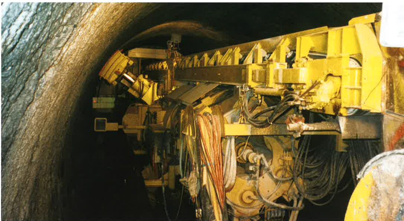
Obr. 1 Provizorní ostění štoly ze stříkaného drátkobetonu Fig. 1 Steel-fibre reinforced shotcrete temporary lining of the gallery
