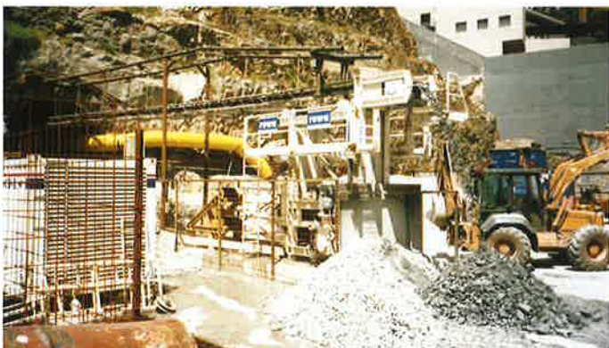
Obr. 2 Doprava rubaniny pásovým dopravníkem Fig. 2 Muck transport by the belt conveyor
