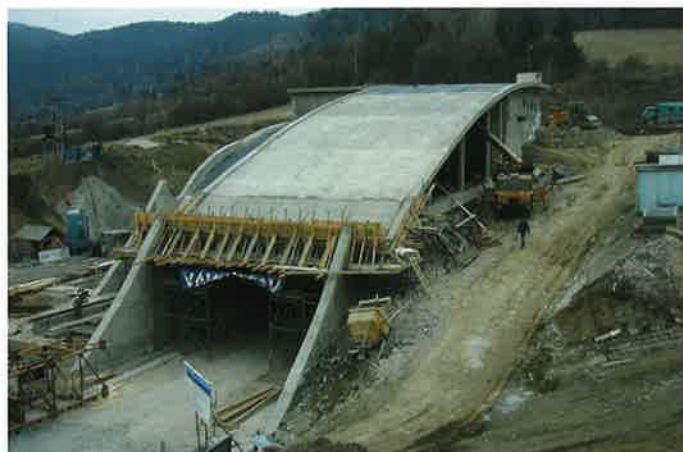
Obr. 3 Výstavba portálového objektu na západnom portáli, 03/2002 Fig. 3 Construction of the portal building at the western portal, 03/2002
