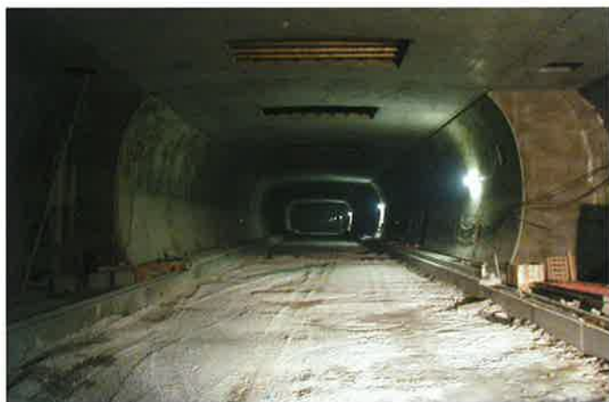
Obr. 2 Pohľad do dopravného priestoru tunela pred realizáciou vozovky, 10/2001 Fig. 2 Transport part of the tunnel before construction of the carriageway, 10/2001
