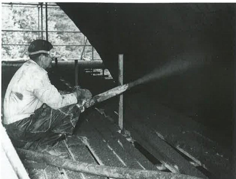
Obr. 3 Použití stříkaného betonu na Sychrovském tunelu Fig. 3 Shotcrete application at the Sychrov tunnel
