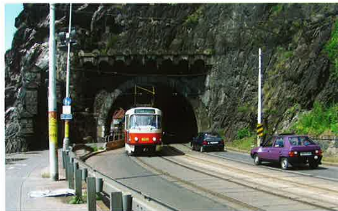
Obr. 3 Vyšehradský městský tunel (1910) Fig. 3 Vyšehrad urban tunnel
