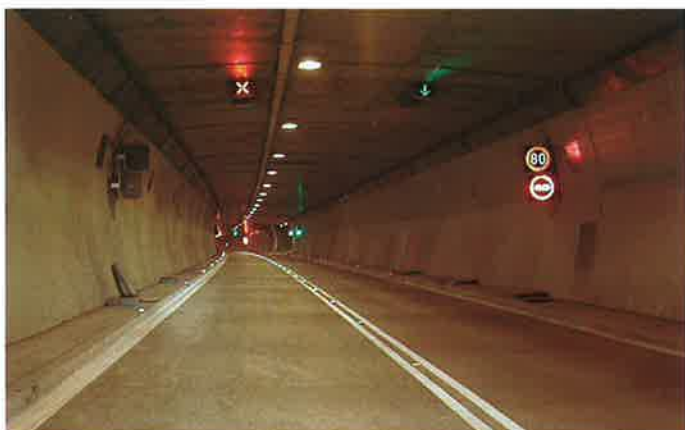
Obr. 4 Pohľad do tunelovej rúry pred uvedením do prevádzky Fig. 4 View of the tunnel tube before putting in operation
