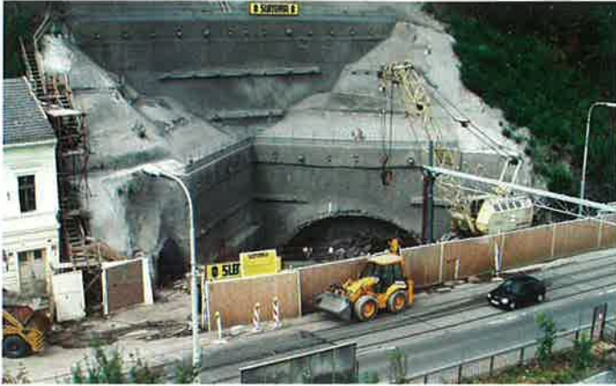
Obr. 8 Tunel Mrázovka, jihozápadní portál Fig. 8 Mrazovka Car Tunnel, southwestern portal
