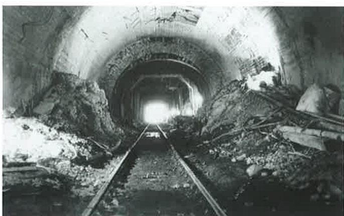
Obr. 5 Tunel Blanský IV po odstranění závalu Fig. 5 The Blansko IV tunnel after the collapse removal
