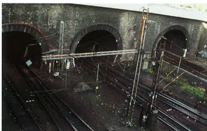
Obr. 4 Vinohradské železniční tunely (1871, 1930, 1985) severní portál Fig. 4 Vinohrady railway tunnels - northern portal
