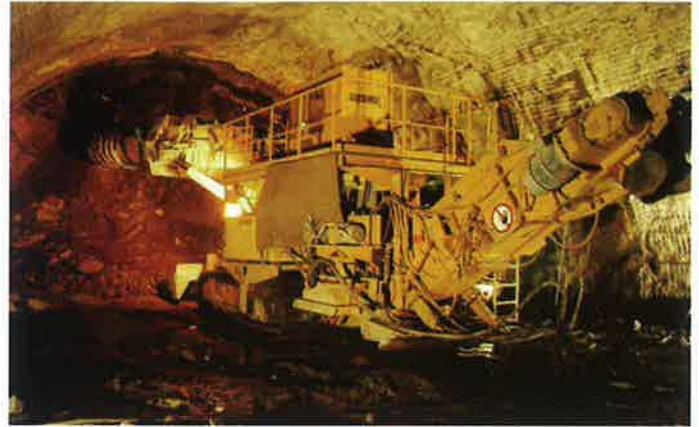
Obr. 9 Ražba velkého profilu (2000) Fig. 9 Driving of a big profile
