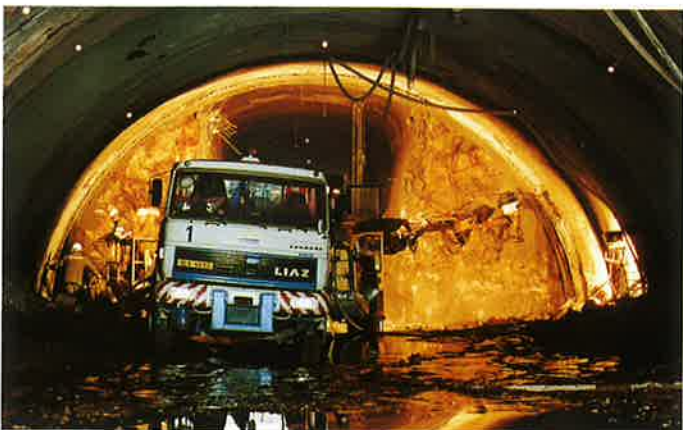
Obr. 6 Vrtné práce na čelbě zajišťuje nový vrtný vůz Rocket Boomer od firmy Atlas Copco s počítačově řízeným vrtáním
