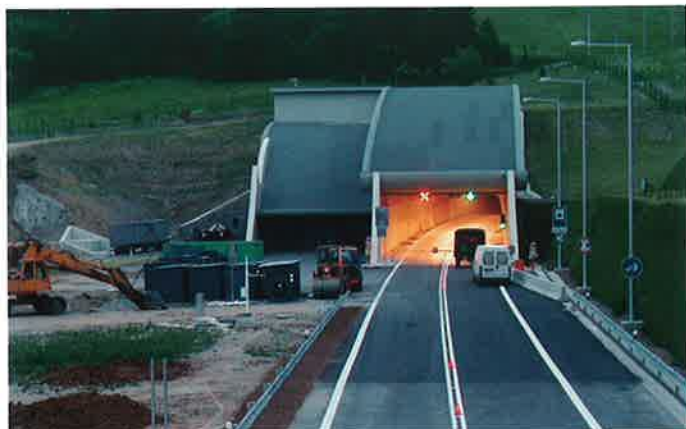
Obr. 1 Pohľad na západný portál tunela Branisko Fig. 1 View of the tunnel Branisko western portal
