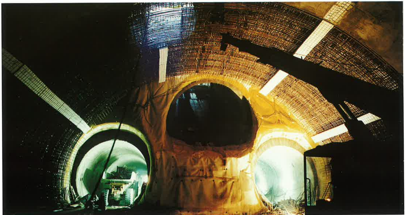
Obr. 3 Trasa metra IVC1 - jednolodní stanice Kobylisy, pohled ze stanice na jednokolejné tunely a eskalátorový tunel Fig. 3 Metro line IVC1 - Kobylisy one-vault station - single-rail tunnels and the escalator tunnel viewed from the station
