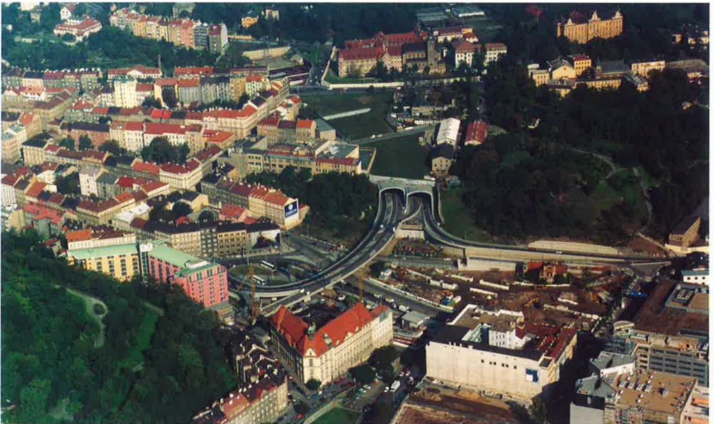
Obr. 10 Letecký pohled na jižní portál Strahovského tunelu - vlevo dole vrch Mrázovka, pod kterým se razí další tunel Fig. 10 Southern portal of the Strahov Tunnel - on the left below: Mrazovka Hill with another tunnel being driven under the hill
