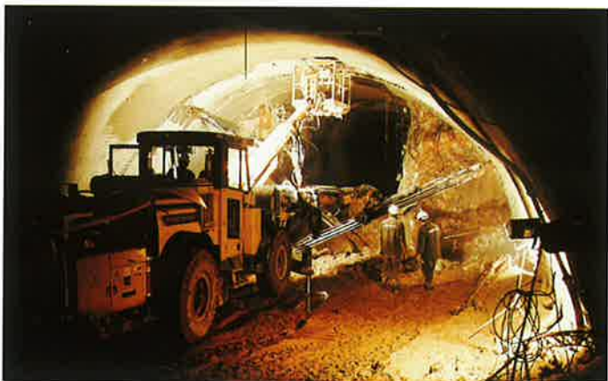
Obr. 5 Pohled směrem k čelbě kaloty, v pozadí je vidět profil průzkumné štoly Fig. 5 A view in the direction towards the top heading face; the exploration gallery profile can be seen in the background
