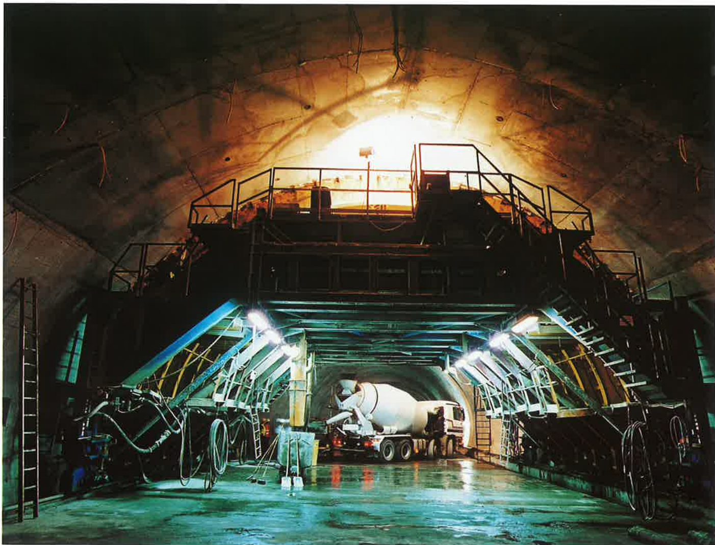
Obr. 1 Tunel Mrázovka - pohled na bednicí vůz v úseku třípruhového tunelu Fig. 1 Mrázovka tunnel - travelling form in the three-lane tunnel section
