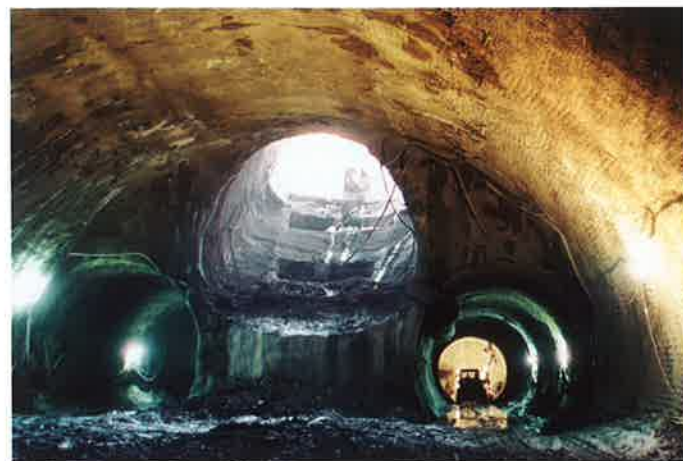
Obr. 15 Kobyličky - první jednolodní ražena stanice na pražském metru (trasa IVC1 - 2002) Fig. 15 Station Kobyličky - the first driven single nave station of Prague metro (line IVC1 - 2002)
