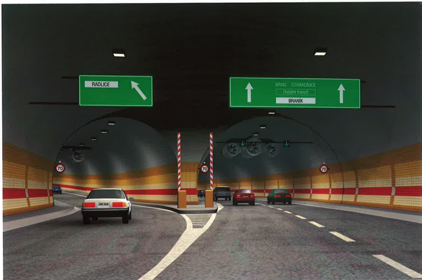
Obr. 3 Tunel Mrázovka - návrh definitivního uspořádání rozpletu v západní troubě (P. Šourek, A. Zapletal, V. Petržílka, F. Polák)
