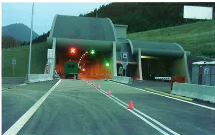
Obr. 3 Východný portál tunela Branisko Fig. 3 Tunnel Branisko eastern portal
