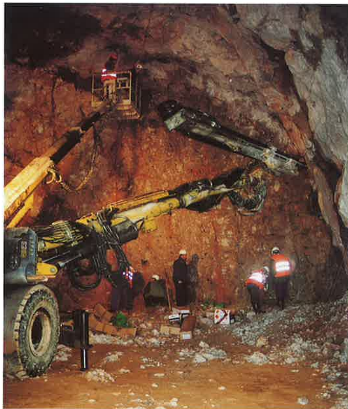
Obr. 7 Plnoprofilová ražba silničního tunelu Plasina
