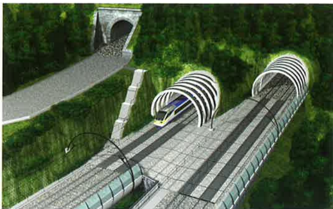
Obr. 2 Uspořádání portálů na stavbě Nové spojení - východní portál (M. Gramblička) Fig. 2 Arrangement of portals at the Nové spojení construction - eastern portal (M. Gramblička)
