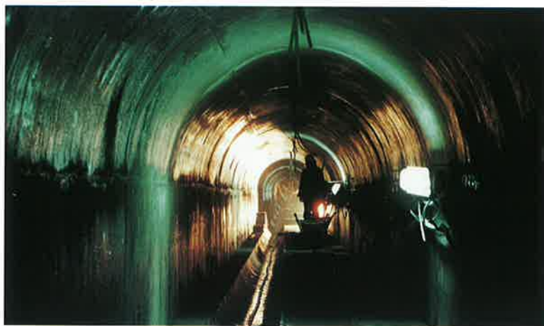
Obr. 2 Výstavba kanalizační stoky na dálničním obchvatu Plzně Fig. 2 Sewer construction on the Pilsen highway by-pass
