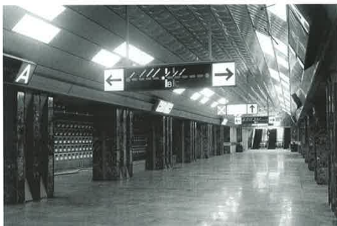
Obr. 12 Stanice metra Můstek A (1978) Fig. 12 Metro station Můstek A
