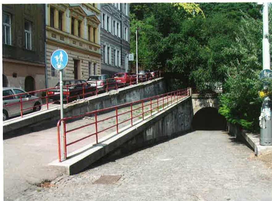
Obr. 24 Pěší tunel pod Vítkovem - jižní portál (1960)
