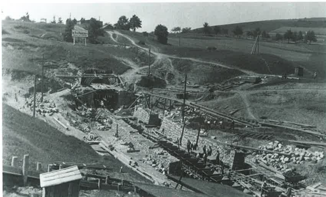
Obr. 1 Portál Třebovického tunelu Fig. 1 The Třebovice tunnel portal
