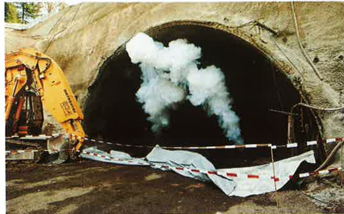
Obr. 2 „Odstřelení“ závěsu, který zakrýval portál kaloty západního tunelu Fig. 2 "Blasting" of the curtain covering the top heading portal at the western portal
