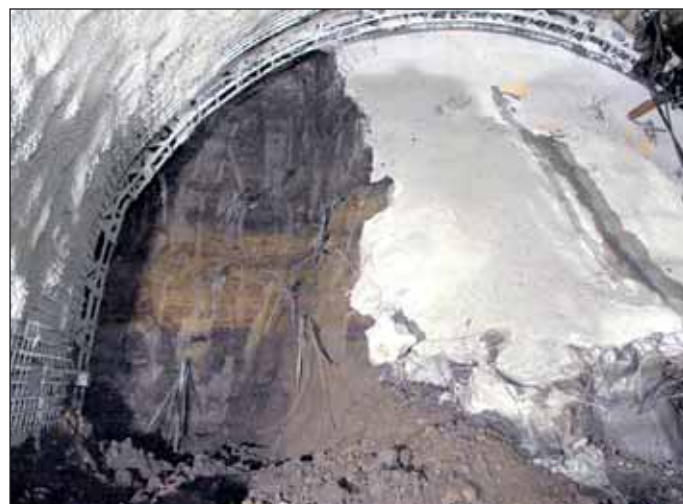
Obr. 8 Ražba kaloty s dílčími výrubu a opěrným klínem Fig. 8 Top heading excavation, with partial headings and a supporting rock wedge
