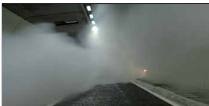
Obr. 10 Zkouška kouřem Fig. 10 Smoke test
