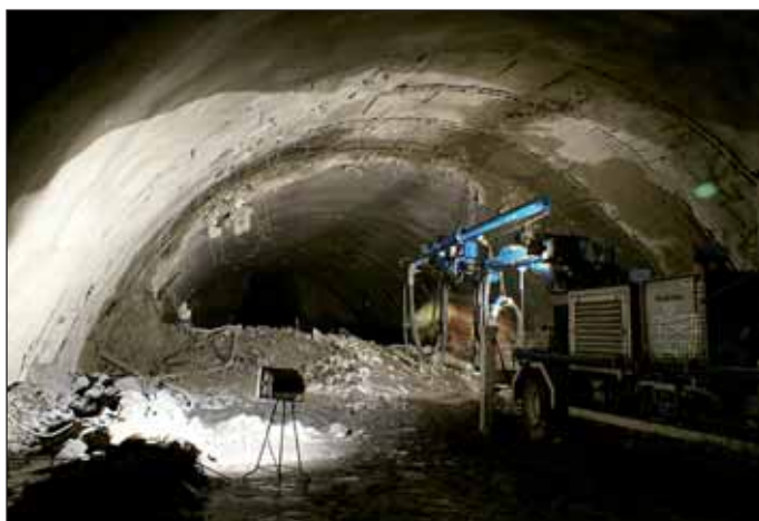
Obr. 8 Bourání ostění průzkumné štoly v přístropí kaloty
