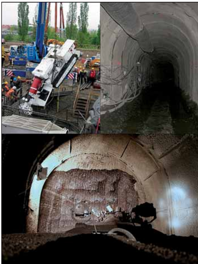
Obr. 4 Fotografie z provádění stavby
