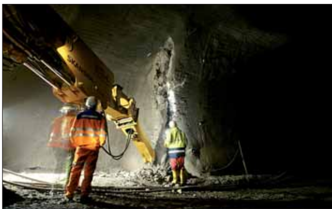
Obr. 7 První úderý bouracího kladiva při zahájení ražby ze štolý
