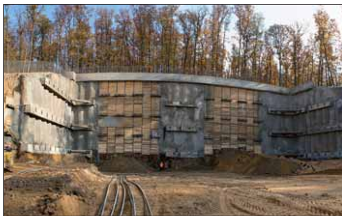
Obr. 5 Pažení stavební jámy Komořany
