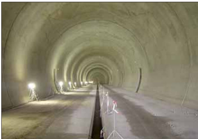
Obr. 10 Definitivní ostění severního vítkovského tunelu Fig. 10 Final lining of the northern Vítkov tunnel
