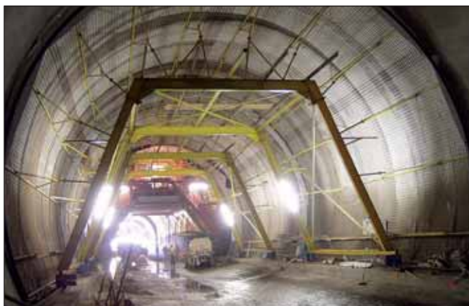
Obr. 7 Ošetřovací vozy Fig. 7 Concrete curing gantries
