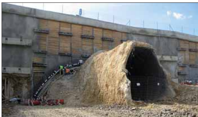
Obr. 6 Bourání ostění průzkumné štoly v oblasti jámy Cholutice
