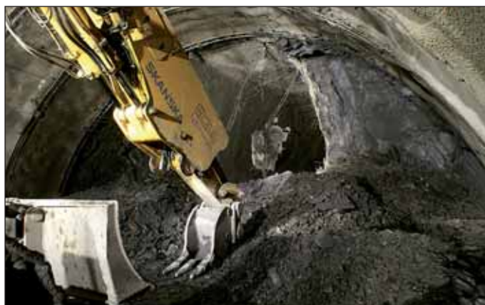
Obr. 3 Geologické poměry na čelbě jižního tunelu
