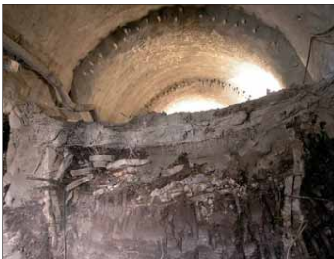
Obr. 11 Zmáhání závalu s dočasně uzavřeným dnem kaloty (v neodtěženém opěří jsou patrné zbytky rozlámáné předklenby)
