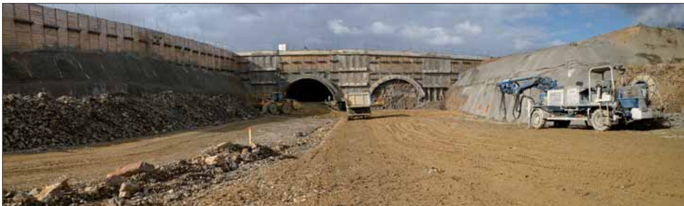
Obr. 2 Pohled na Cholutický portál a stavební jámu
