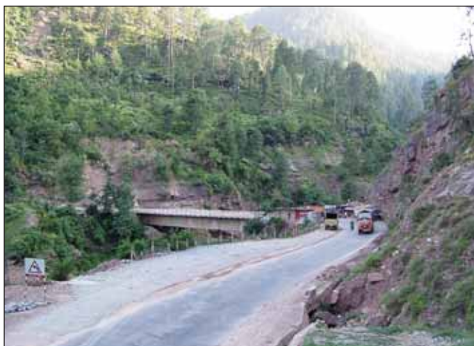
Obr. 2 Severní portál tunelu Fig. 2 Northern tunnel portal
