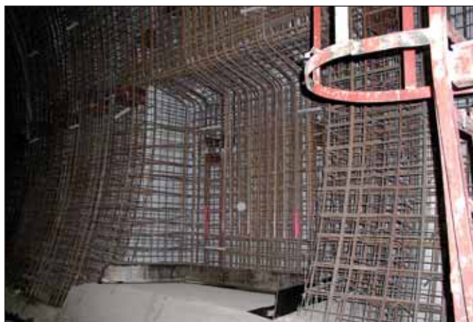
Obr. 4 Armatura definitivního ostění s výklenkem (foto Ing. M. Heřt)
