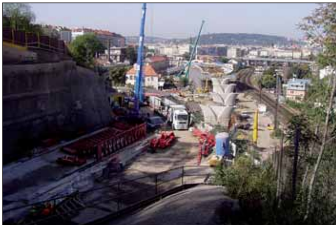
Obr. 2 Montáž bednicího vozu – západní portál Fig. 2 Assembly of the traveller form – the western portal
