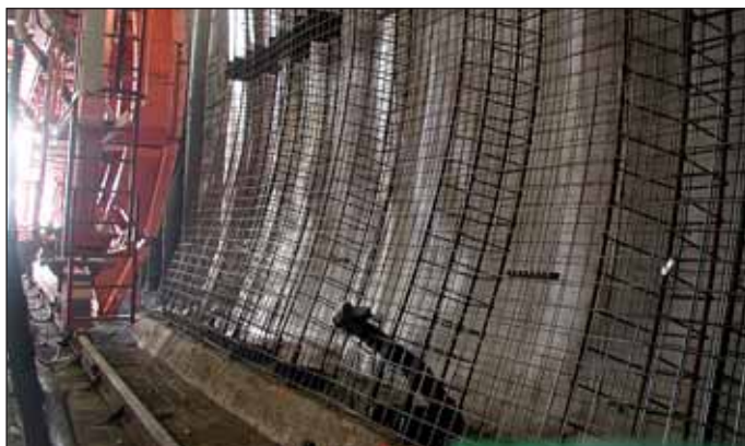
Obr. 3 Armatura definitivního ostění (foto Ing. M. Heřt)
