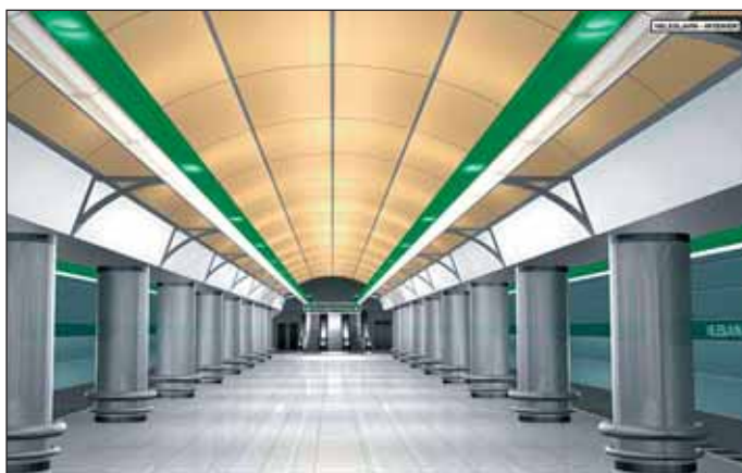
Obr. 10 Trojlodní ražená stanice Veleslavín Fig. 10 Veleslavín three-vault mined station
