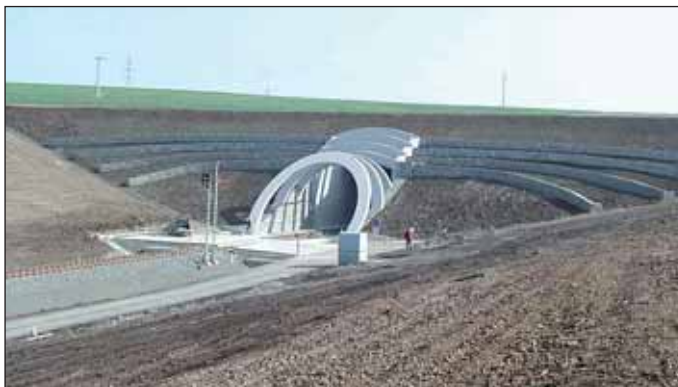
Obr. 2 Definitivní zajištění vjezdového portálu (foto Ing. M. Heřt) Fig. 2 Final support of the entrance portal (photo Ing. M. Heřt)
