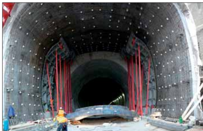
Obr. 4 Montáž bednění trakčního výklenku – západní portál Fig. 4 Fabrication of the formwork for a catenary recess – the western portal
