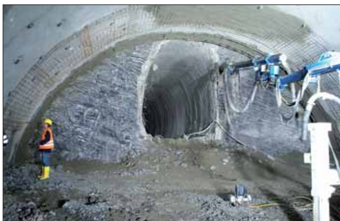
Obr. 1 Průzkumná štola situovaná ve středu kaloty jižního tunelu Fig. 1 The exploration gallery found in the centre of the southern tunnel calotte
