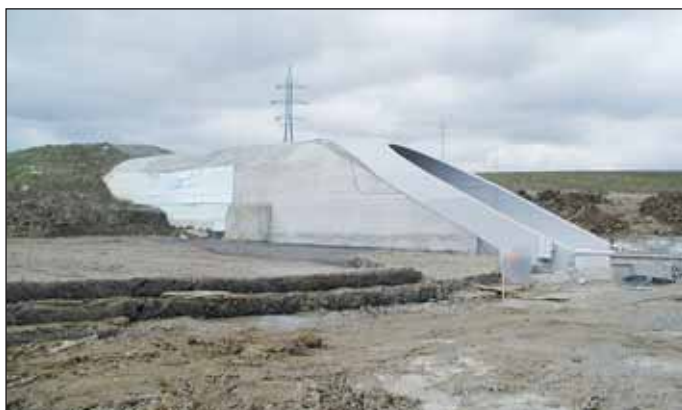
Obr. 6 Zасыпávání definitivního výjezdového portálu (foto Ing. M. Heřt) Fig. 6 Covering of the definite exit portal with soil (photo Ing. M. Heřt)
