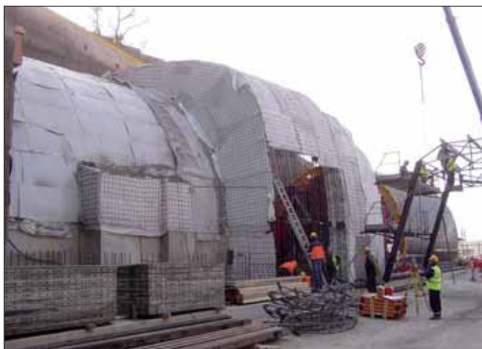
Obr. 3 Falešné primární ostění Fig. 3 The false primary lining
