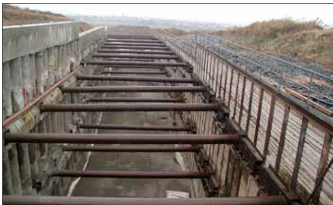
Obr. 5 Rozepřené pažící stěny u výjezdového portálu (foto Ing. M. Heřt) Fig. 5 Braced supporting walls at the exit portal (photo Ing. M. Heřt)
