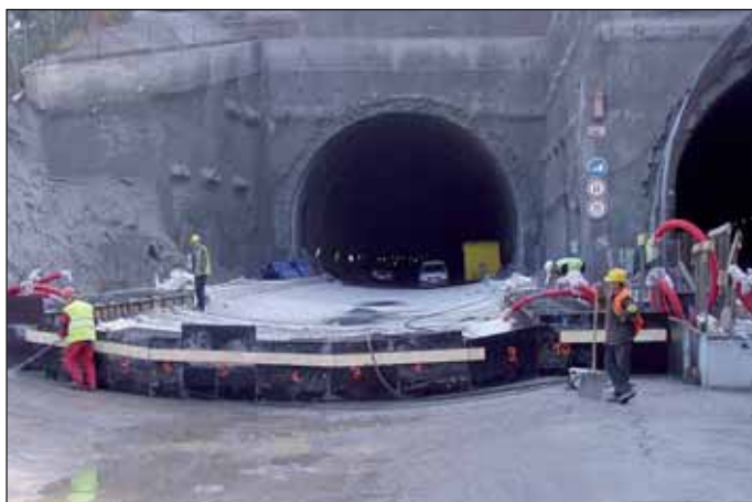
Obr. 1 Po betonáži patek s protiklenbou na západním portálu Fig. 1 After the casting of the footings and invert at the western portal
