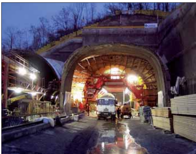
Obr. 6 Betonáž bloku navazujícího na trakční výklenek – západní portál Fig. 6 Casting of a block adjacent to a catenary recess – the western portal
