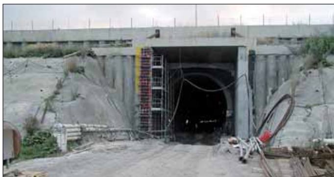
Obr. 1 Dočasné zajištění vjezdového portálu (foto Ing. M. Heřt) Fig. 1 Temporary support of the entrance portal (photo Ing. M. Heřt)
