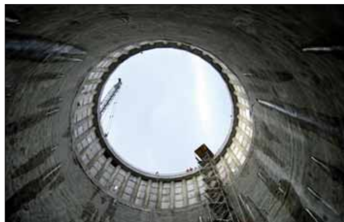
Obr. 17 Šachta Brunnenhof (Zdroj: IG Zalo)
