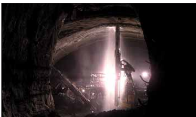
Obr. 5 Vrtání a osazování svorníků v třípruhovém tunelu Fig. 5 Drilling and installation of rock bolts in the triple-lane tunnel
