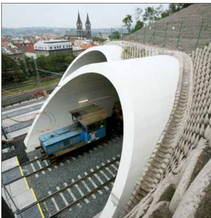
Obr. 5 Pohled na hotový portál včetně technologické jízdy vlaku Fig. 5 View of the finished portal inclusive of a testing train ride
