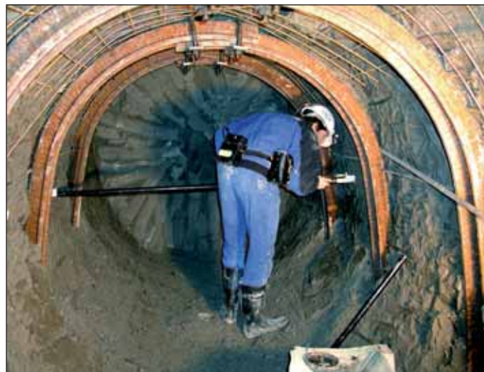
Obr. 10 Měření napjatosti masivu v kruhovém profilu rozrážky průzkumné štol tunelu Dobrovského konvergenční metodou
