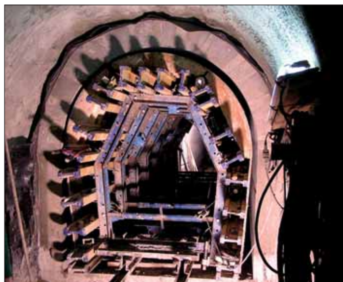
Obr. 2 Budování definitivního ostění odvodňovací štoly Fig. 2 Erection of the final lining of the drainage gallery
