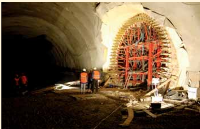
Obr. 1 Bednění propojky v tunelu Komořany
