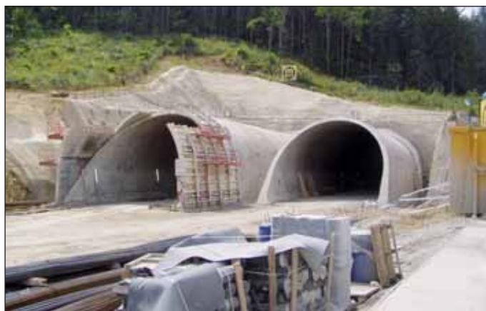
Obr. 7 Zrealizované hĺbené časti tunela na východnom portáli
