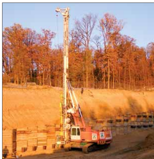
Obr. 3 Beranění zápor zajištění stavební jámy v prostoru komořanského portálu Fig. 3 Driving soldier beams supporting the construction trench at the Komořany portal
