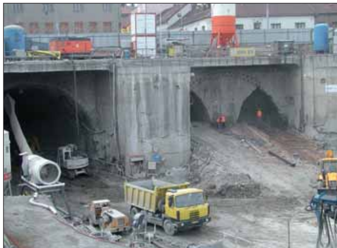
Obr. 11 Portál průzkumných štol tunelu Dobrovského po zahájení ražby tunelové trouby II (stav v roce 2008)
