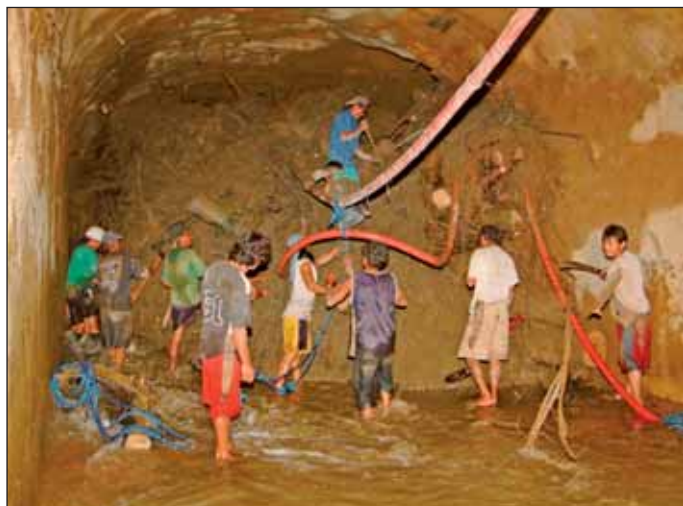
Obr. 9 Pohled na ruční čištění výtoku zaneseného tunelu (foto firmy EDCOP 2005)
