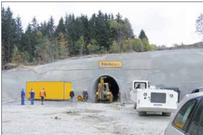
Obr. 3 Prieskumná štôľňa tunela Polná, západný portál (portál Rieka) Fig. 3 Exploration gallery for the Polná tunnel, western portal (Rieka portal)
