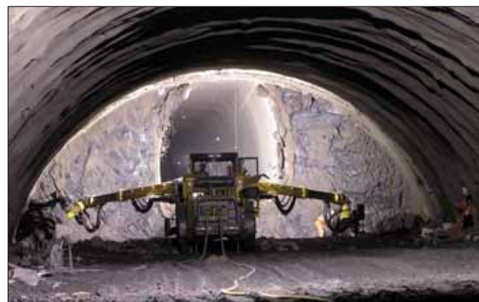
Obr. 4 Vrtání čelby třípruhového tunelu Fig. 4 Drilling into the triple-lane tunnel excavation face
