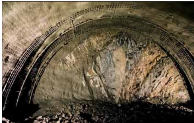
Obr. 2 Obrázek typické čelby Fig. 2 View of a typical heading
