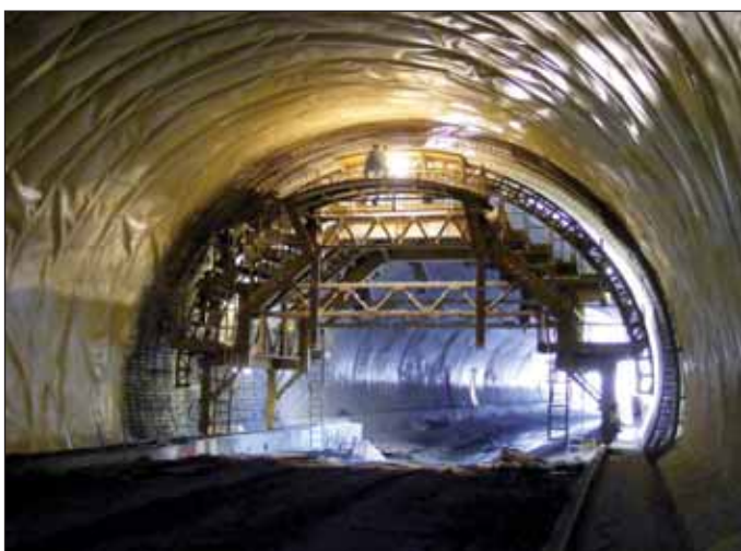
Obr. 12 Vázání výztuže prvního bloku definitivního ostění v třípruhovém tunelu Fig. 12 Tying-up the reinforcement of the first block of the final lining in the triple-lane tunnel
