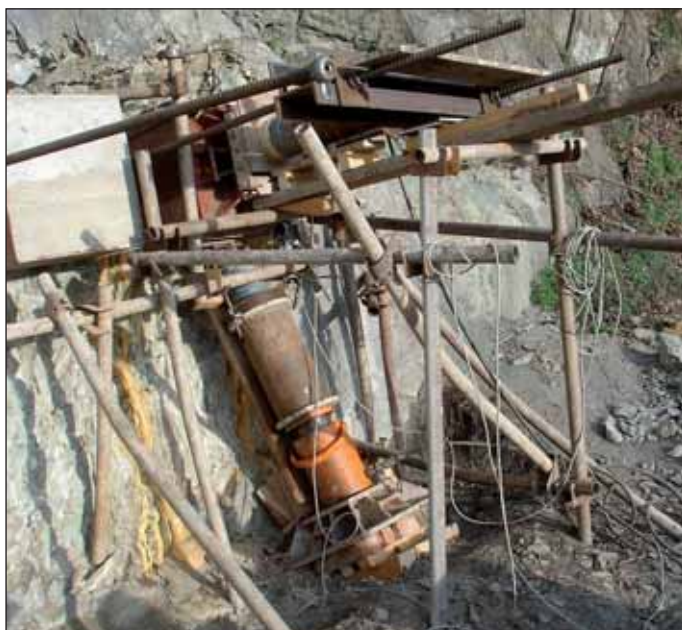
Obr. 12 Sestava polní smykové zkoušky při průzkumu pro tramvajový tunel Žabovřeská v Brně
