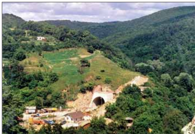
Obr. 5 Tunel č. 1 v rekonstrukci (stav červenec 1996)
