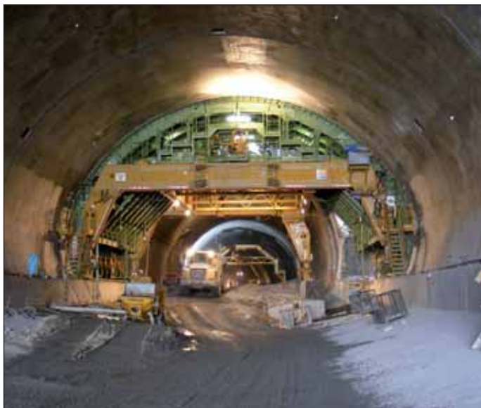
Obr. 7 Bednicí vůz na přechodu hloubeného čtyřpruhového a raženého třípruhového tunelu
