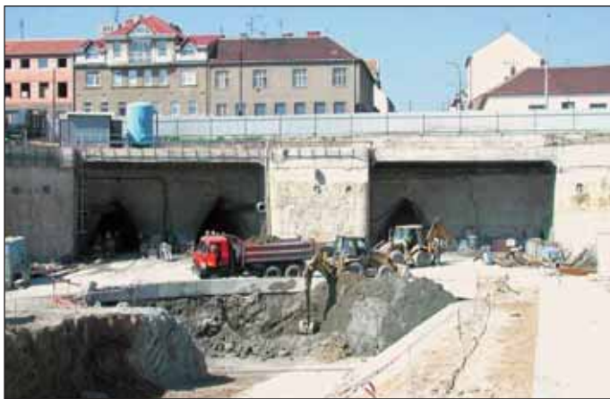
Obr. 9 Portál průzkumných štol tunelu Dobrovského v Brně (stav v roce 2002)
