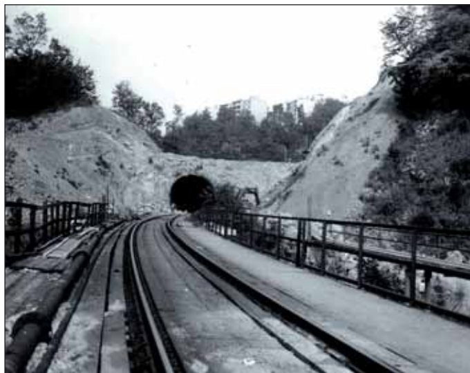
Obr. 2 Realizace zářezové varianty rekonstrukce tunelu č. 6 na trati Brno–Česká Třebová
