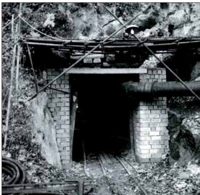
Obr. 7 Portál průzkumné štoly u tunelu č. 8 na trati Brno–Česká Třebová Fig. 7 Exploration gallery portal – tunnel No. 8 on Brno–Česká Třebová rail line
