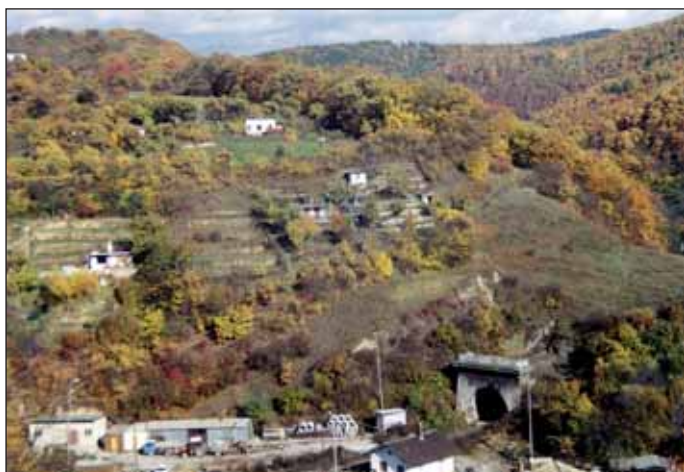
Obr. 4 Tunel č. 1 na trati Brno–Česká Třebová před rekonstrukcí (listopad 1994)
