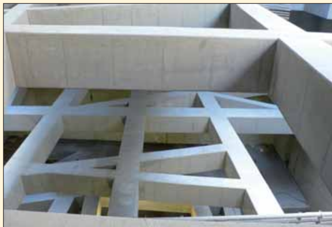
Obr. 2 Rozpěrné rámy jámy pro stanici Gellert
