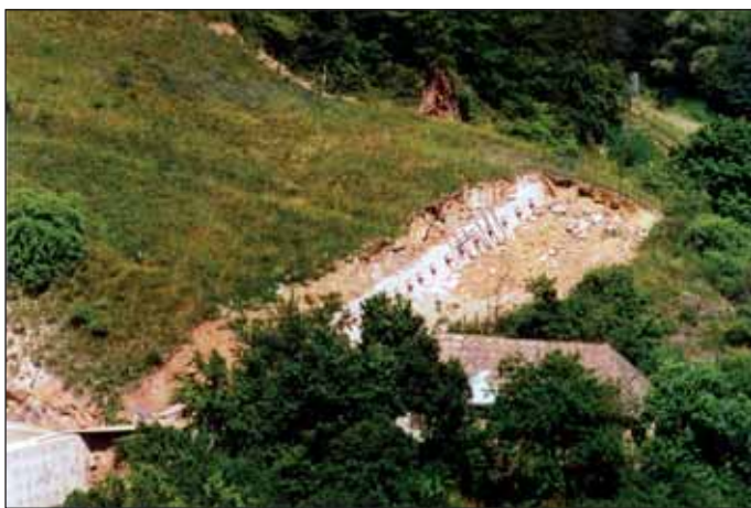
Obr. 6 Uspořádání kotev příčného sepnutí masivu
