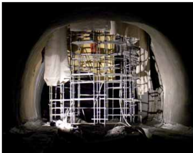
Obr. 10 Izolační práce ve vzduchotechnické šachtě Fig. 10 Installation of waterproofing in the ventilation shaft
