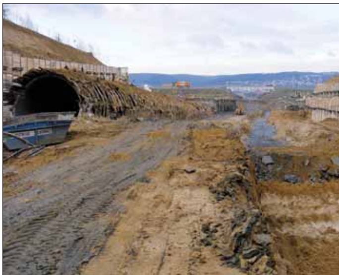
Obr. 11 Odhalená přístupová štola v komořanské stavební jámě Fig. 11 Exposed access adit in the Komořany construction trench
