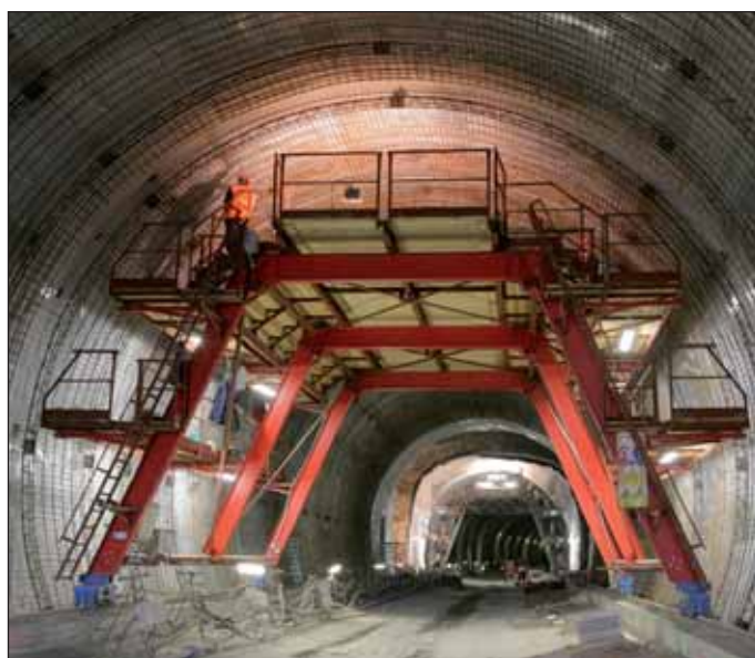
Obr. 6 Ukázka pracovního proudu při provádění definitivního ostění Fig. 6 Example of the production line system of casting the final lining
