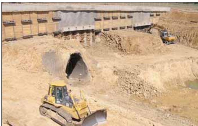
Obr. 1 Hloubení stavební jámy v prostoru cholupického portálu Fig. 1 Excavation of the construction trench at the Cholupice portal
