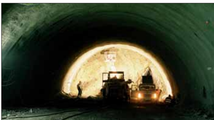
Obr. 3 Vlastní ražby tunelu Fig. 3 Tunnel excavation
