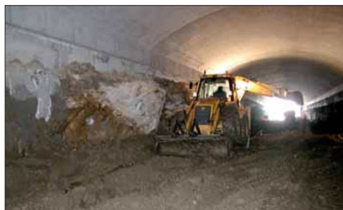
Obr. 13 Těžba horniny pod hotovou klenbou hloubeného tunelu na obchvatu Jihlavy
