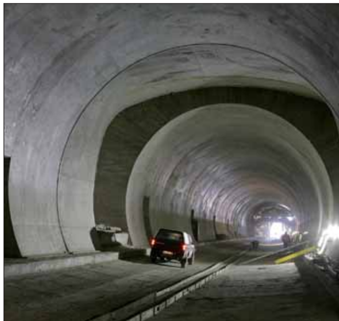
Obr. 8 Dokončené definitivní ostění Fig. 8 Complete final lining
