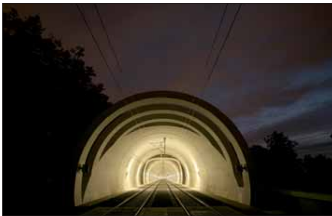
Obr. 7 Vystrojený tunel s kolejovým svrškem Fig. 7 Equipped tunnel with trackwork
