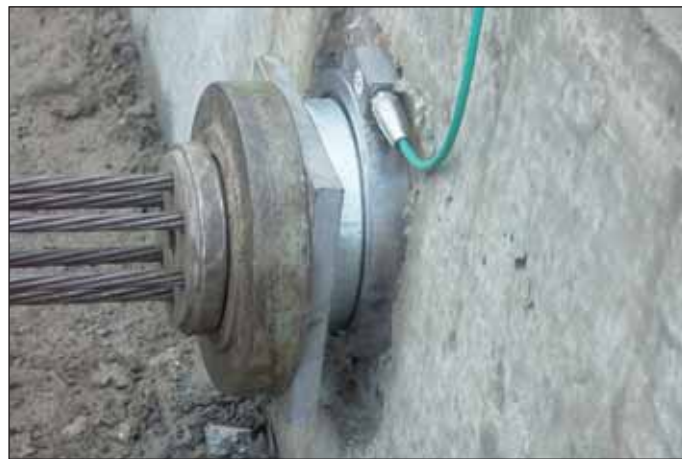
Obr. 9 Elektrický kruhový snímač napětí pro lanové kotvy
