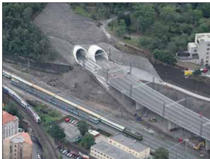
Obr. 10 Dokončené dílo z ptáčí perspektivy Fig. 10 Aerial view of complete works
