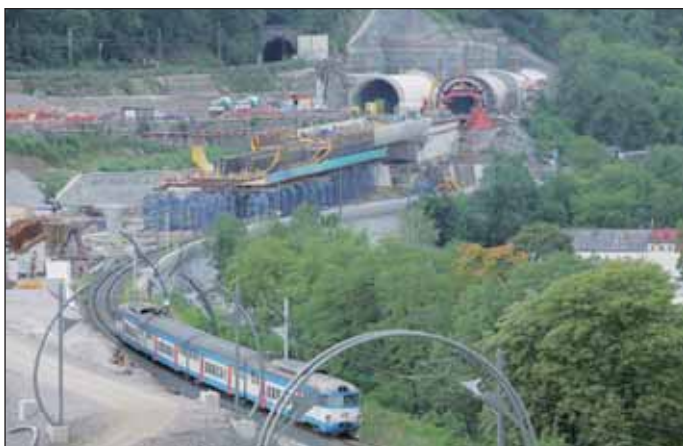
Obr. 9 Výstavba hloubených tunelů a souvisejících objektů Fig. 9 Construction of cut-and-cover tunnels and related structures
