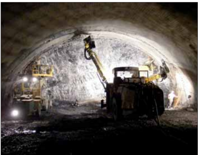
Obr. 9 Stavění tunelového rámu v odstavném zálivu dvoupruhového tunelu Fig. 9 Installation of a lattice girder in the double-lane tunnel lay-by
