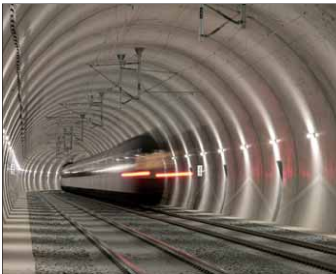
Obr. 12 Průjezd prvního vlaku dokončeným dílem Fig. 12 Passage of the first train through the completed tunnel
