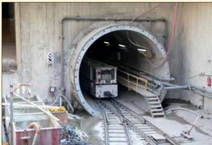
Obr. 1 Ústí traťového tunelu ve startovací šachtě na náměstí Etele
