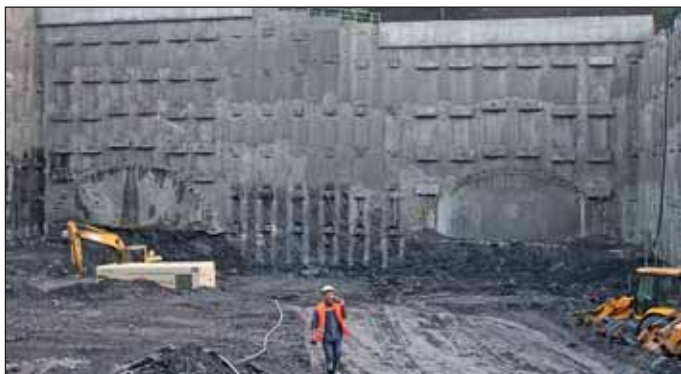
Obr. 1 Staveniště Myslbekova, východní stěna s portály ražených tunelů Fig. 1 Myslbekova site, the eastern wall with mined tunnel portals
