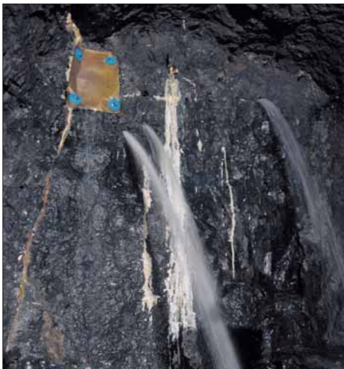
Obr. 4 Utěsnění puklin pro cementovou injektáž Fig. 4 Sealing of fissures before injecting cement grout
