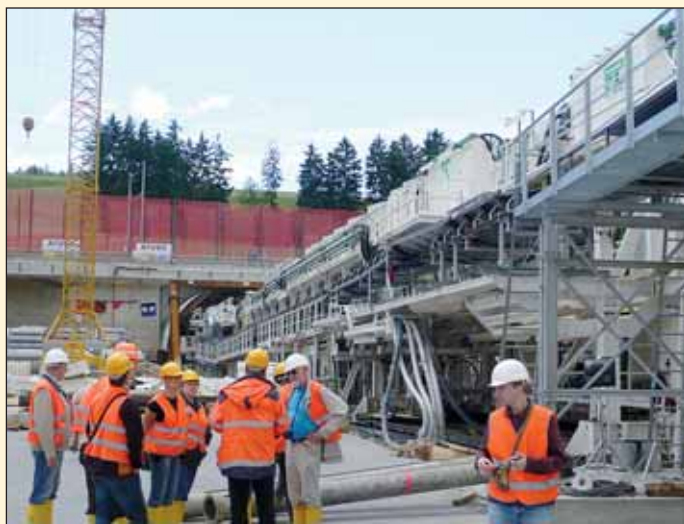
Obr. 1 Částečně zaražený zeminový štít na staveništi v Bielu Fig. 1 An EPB shield partially driven into the ground on the Biel construction site
