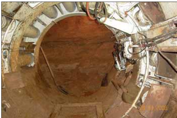
Obr. 4 Pohled do čelby štítu DN 2000 mm – hydrogeologické podmínky téměř idylické Fig. 4 View of the DN 2000mm shield heading – nearly idyllic hydrogeological conditions
