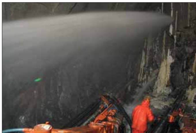
Obr. 7 Tlaková podzemní voda Fig. 7 Pressure ground water
