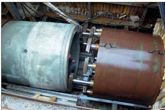
Obr. 1 Razicí štít upravený jako protlačecí stanice Fig. 1 Driving shield modified to a jacking station
