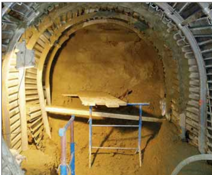
Obr. 6 Klasická ražba propoje tras B a C
