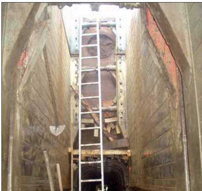
Obr. 5 Detail přechodu otevřeného výkopu v raženou část – ulice Komořanská Stoka A2-4
