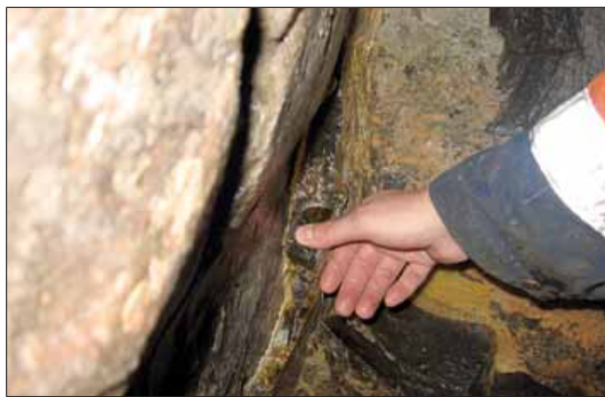
Obr. 9 Puklina vyplněná CarboPur WF Fig. 9 Fissure filled with CarboPur WF
