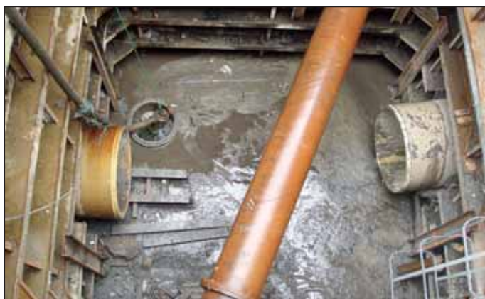
Obr. 1 Pohled do stavební jámy po ukončení mikrotunelování Fig. 1 View down a launching shaft
