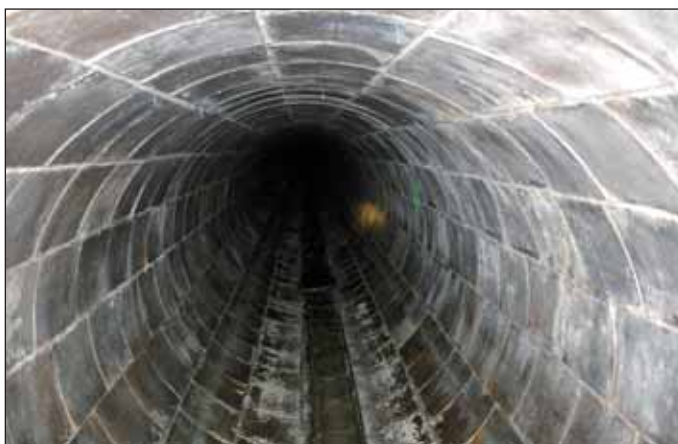
Obr. 2 Stávající stav Fig. 2 Existing condition
