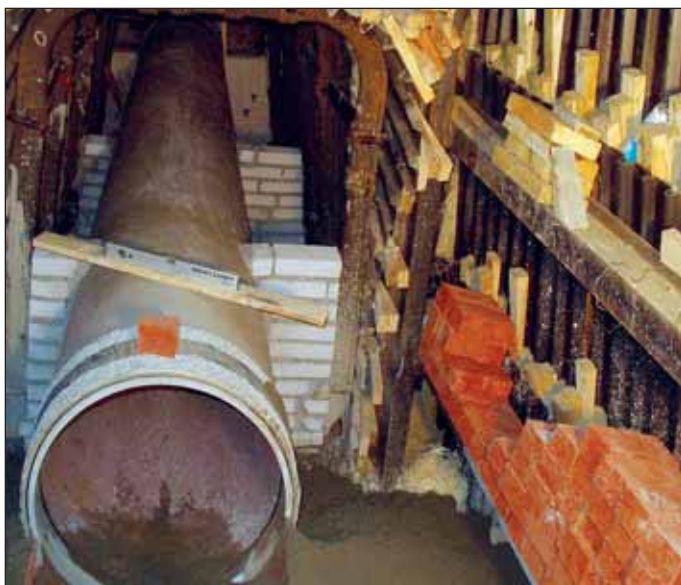
Obr. 3 Detail zajištění potrubí HOBAS čílkou z cihel; čílkou se dále používají jako přepážky proti přetečení popílkocementové směsi při postupném zaplňování (Stoka A2-1, ul. Komořanská)
