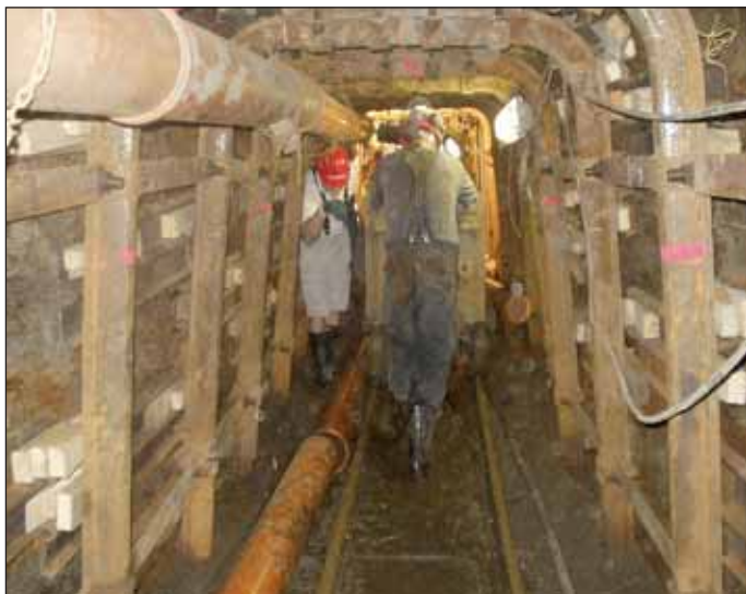
Obr. 2 Detail štolý – pro odtěžení používány speciálně upravené bedny na rubaninu; pro pojezd vozíků použita kolejová doprava (Stoka A2-1, ul. Komořanská)
