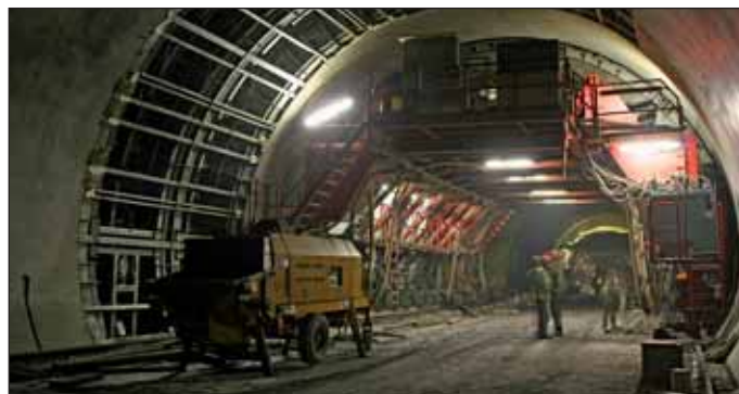
Obr. 6 Ražený tunel, bednění vzduchotechnických kanálů v klenbě definitivního ostění Fig. 6 Mined tunnel, formwork for ventilation ducts in the crown of the final lining vault
