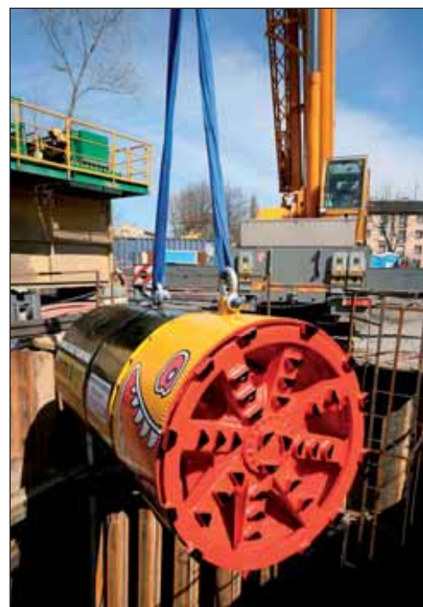
Obr. 2 Spouštění štítu do šachty – foto: Ing. Jiří Skupien Fig. 2 Lowering of the shield into a shaft – photo: Ing. Jiří Skupien
