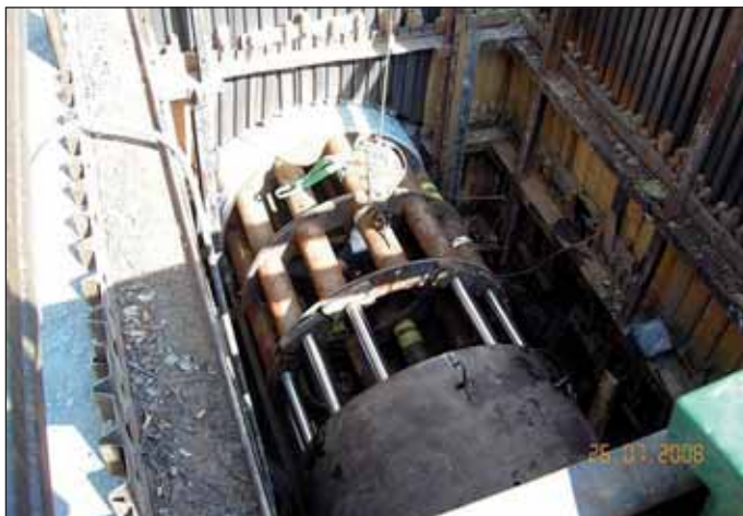
Obr. 2 Pohled do startovací šachty – protlačovací zařízení s vyjímatelnými nástavci Fig. 2 View down a launching shaft – a jacking set with removable attachments
