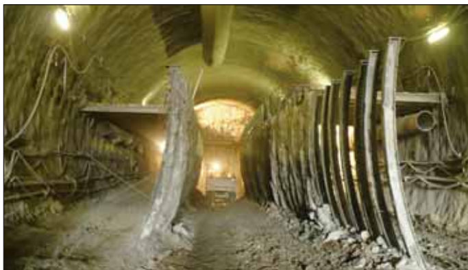
Obr. 8 Celkový pohled (vnitřní žebra HEB) Fig. 8 General view (HEB inner ribs)
