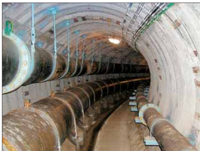
Obr. 3 Stávající vodovodní kanál, výchozí stav Fig. 3 The existing water feeder tunnel – original condition
