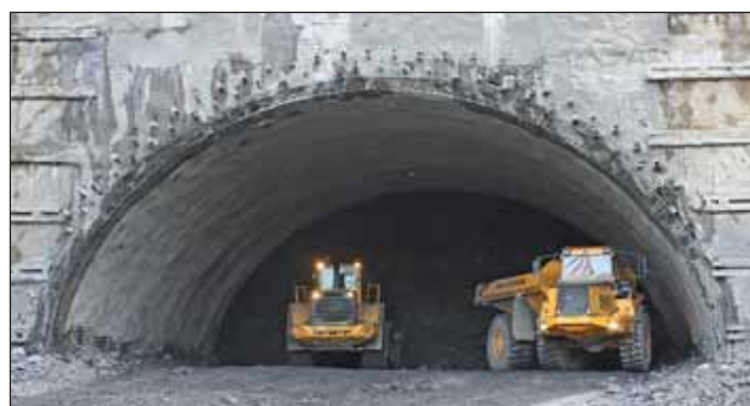
Obr. 5 Staveniště Letná, ražba severního třípruhového tunelu Fig. 5 Letná site, excavation of the northern three-lane tunnel
