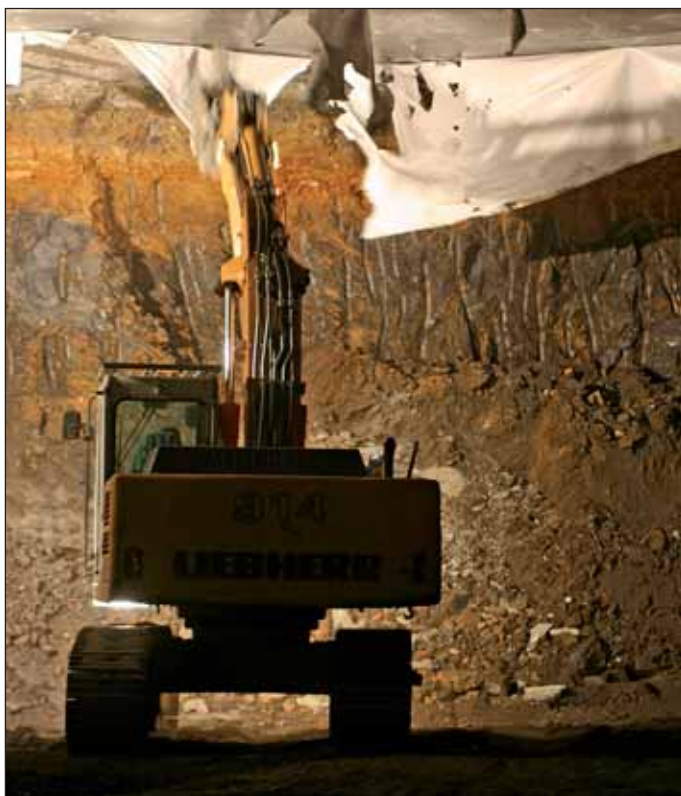
Obr. 3 Staveniště Letná, odtěžování pod ochranou stropní desky dilatace D11 Fig. 3 Letná site, excavation under the roof deck of expansion block D11
