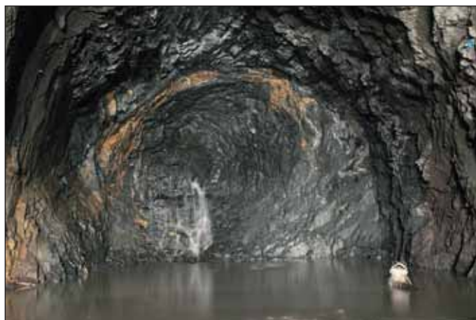
Obr. 2 Zatopená čelba při úpadní ražbě Fig. 2 Inundated face during the downhill excavation
