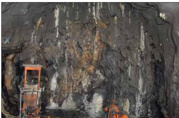
Obr. 12 Čelba po provedení injektáží Fig. 12 Excavation face after the grouting
