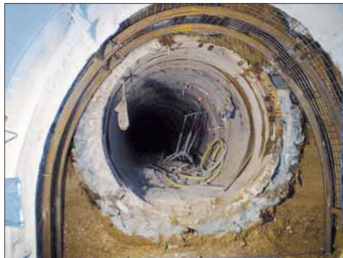
Obr. 5 Kolektor C, postup ražby v první látce Fig. 5 Utility tunnel C – first bench excavation procedure
