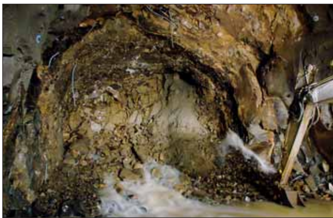
Obr. 8 Klenba stropu je stabilizována pomocí PU Fig. 8 Roof vault is stabilised by PU injections
