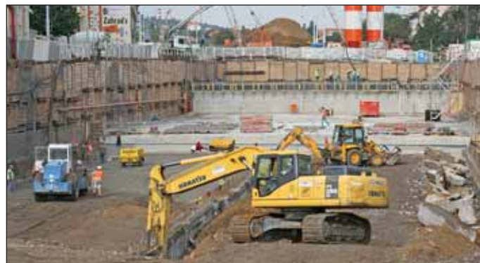
Obr. 2 Staveniště Letná, výstavba dilatací D4-D7 tzv. milánskou metodou Fig. 2 Letná site, construction of expansion blocks D4 through D7 by the Milan method
