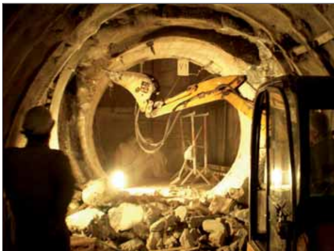
Obr. 4 Kolektor C, zmáhání vodovodního kanálu strojním způsobem Fig. 4 Utility tunnel C – mechanical demolition of the water feeder tunnel
