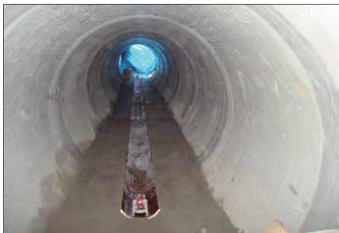
Obr. 6 Provádění kynety v protlaku do požadovaného promílového spádu Fig. 6 Construction of the bottom duct at the required gradient
