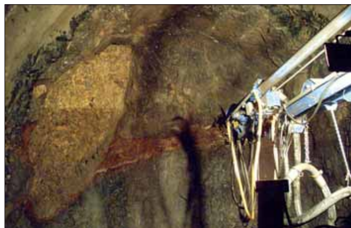
Obr. 10 Tektonická brekcie v levé části výrubu
