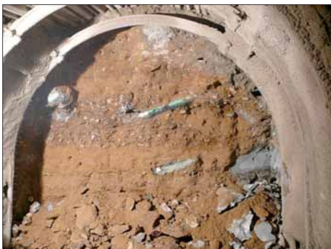
Obr. 2 Kolektor B, čelba zpevněná injektáží Dukol Fig. 2 Utility tunnel B – excavation face stabilised by Dukol grouting
