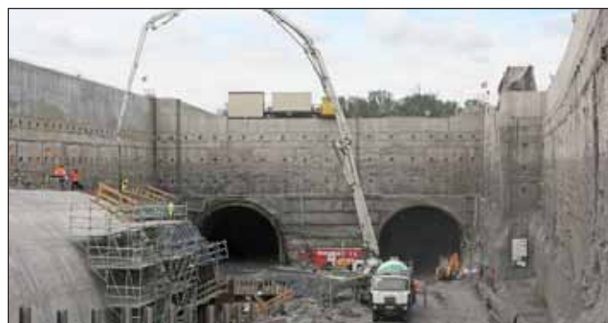
Obr. 7 Staveniště Troja, betonáž klenby hloubeného tunelu před raženým portálem Fig. 7 Troja site, casting of the vault of the cut-and-cover tunnel in front of the mined portal
