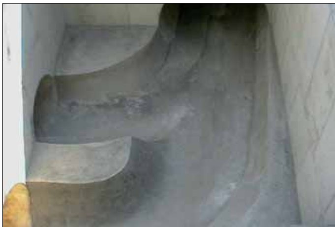
Obr. 7 Definitivní úpravy stavební části šachty Fig. 7 Finishing civil works on the shafts
