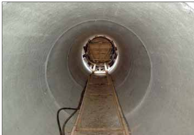
Obr. 3 Železobetonové trouby IZX DN 1600 mm – pohled z čela štítu směrem k tlačné stanici
