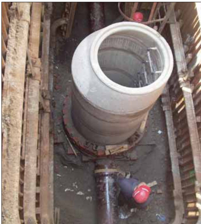
Obr. 4 Dokončení vyskružení šachty mezi dvěma štolami prováděnými pomocí důlní korýtkové výztuže; po obetonování potrubí se štola zaplaví popílkocementovou směsí (Stoka A2-1, ulice Kyslíková)
