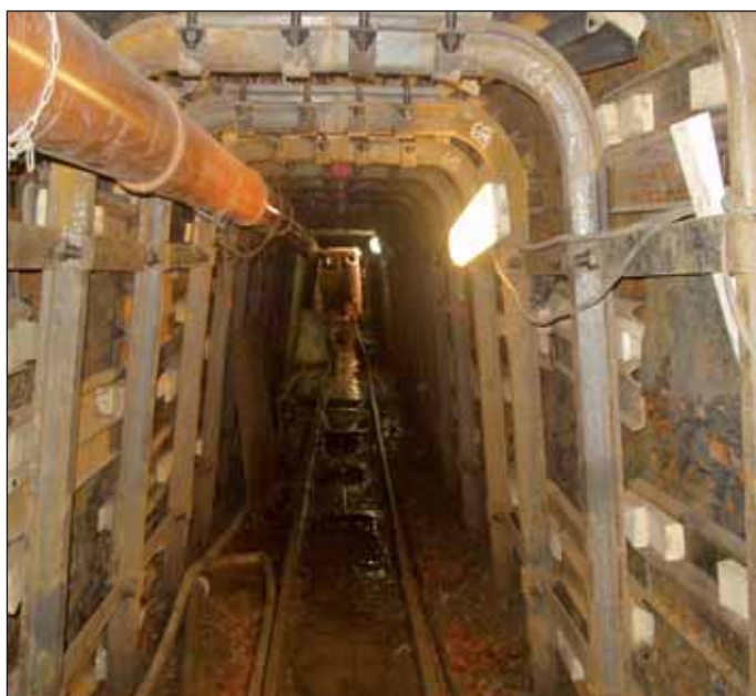
Obr. 1 Detail ražby v profilu LB2, pažení stoly z ocelových pažnic UNION kladených šachovnicovým způsobem; aktivace pažnic pomocí klínů (Stoka A2-1, ul. Komořanská)
