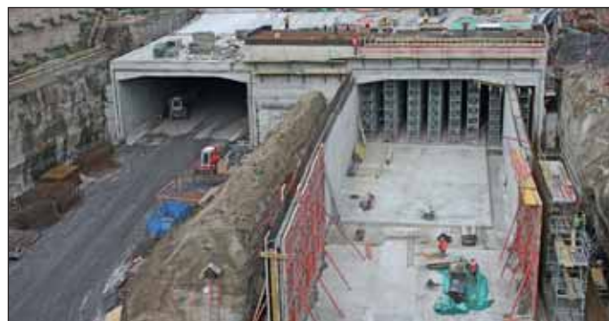
Obr. 4 Staveniště Letná, výstavba dilatace D20a severního tunelu Fig. 4 Letná, construction of expansion block D20a of the northern tunnel tube
