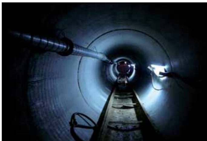
Obr. 5 Nejdelší z protlačených úseků – 70 bm Fig. 5 The longest of the pipejacking sections – 70m
