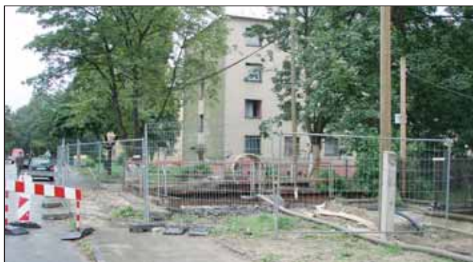
Obr. 3 Mikrotunelování umožňuje minimální zásah do životního prostředí Fig. 3 The microtunnelling technique makes a minimum environmental impact possible
