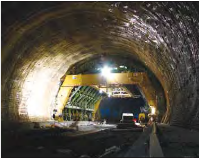
Obr. 7 Betonáž razeného tunela Fig. 7 Casting of the mined tunnel lining
