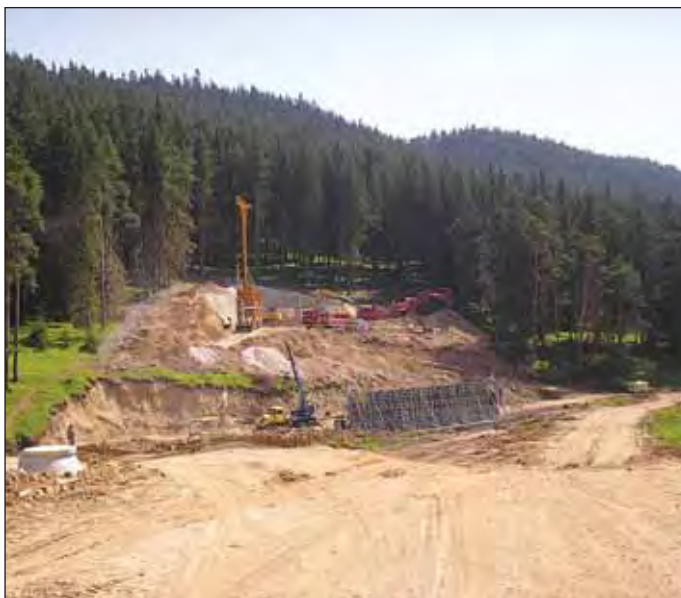
Obr. 1 Zakladanie portálu pomocou veľkoprofilových pilôt Fig. 1 Portal foundation by means of large-profile piles
