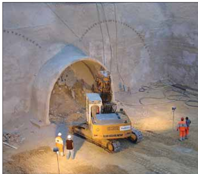
Obr. 2 Začiatok razenia pilierovej štôlne Fig. 2 Beginning of driving the pillar gallery
