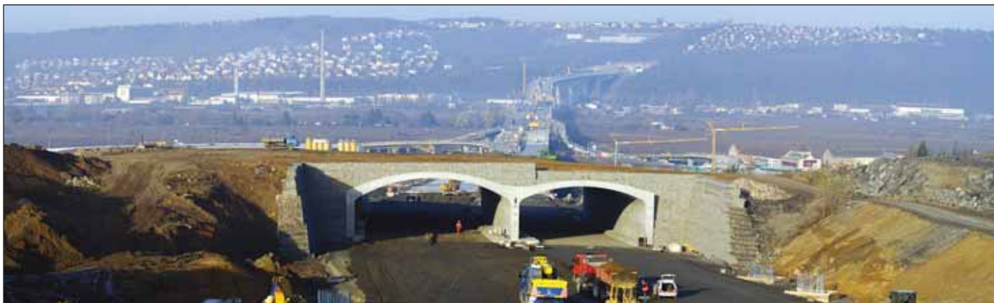
Obr. 12 Kompletní zásyp hloubeného tunelu
