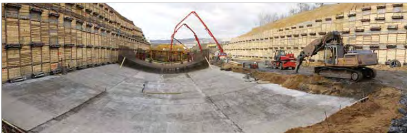
Obr. 4 Postup výstavby ve stavební jámě Komořany Fig. 4 Construction procedure in the Komořany construction trench
