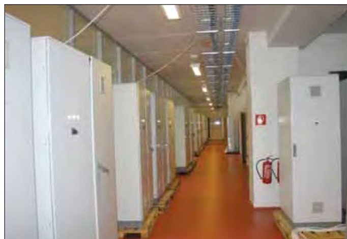
Obr. 12 Testování řídicího systému pro stavbu SOKP 514 v laboratořích společnosti ELTODO
