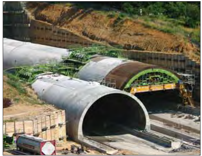
Obr. 8 Hĺbené tunely Komořany Fig. 8 Komořany cut-and-cover tunnels
