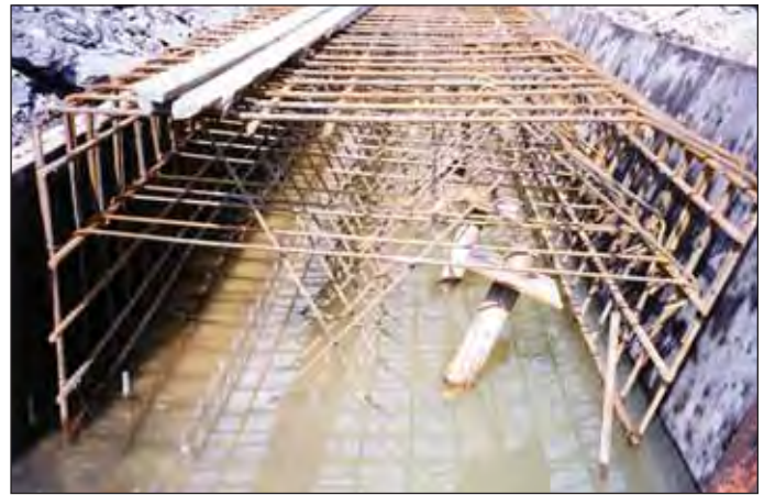
Obr. 17 Podchyzení základových patek prefabrikované klenby Fig. 17 Underpinning of footings of the precast vault
