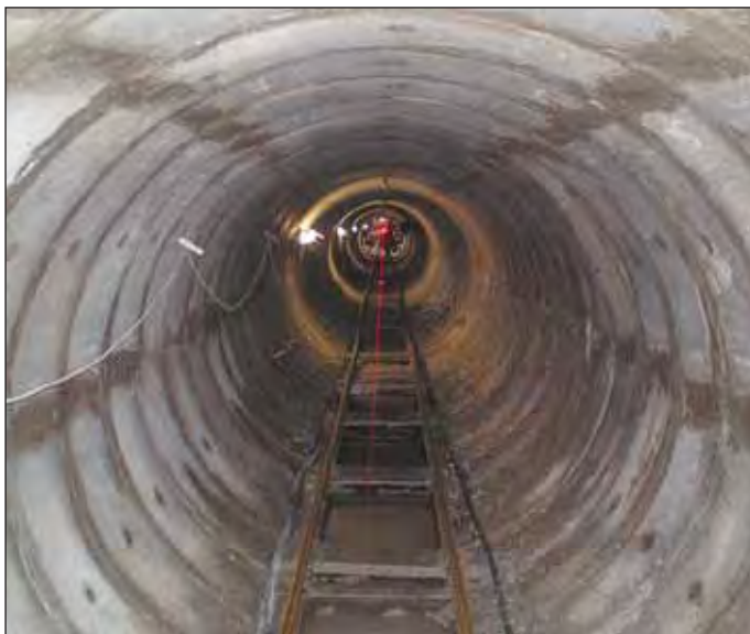
Obr. 10 Výsledná podoba vyražené štítované štolý v úseku TŠ6-TŠ7 Fig. 10 Final shape of the completed tunnel in the section between TŠ6 – TŠ7
