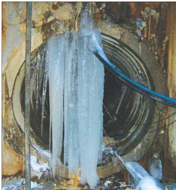
Obr. 11 Obrázek dokumentuje složité podmínky výstavby i s ohledem na drsné klimatické podmínky – pohled do ústí štítované štolý
