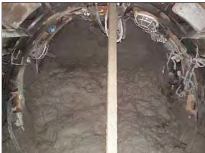
Obr. 3 Příklad do učebnic geotechniky – vykomínování rozbředlých jílu v čelbě razicího štítu
