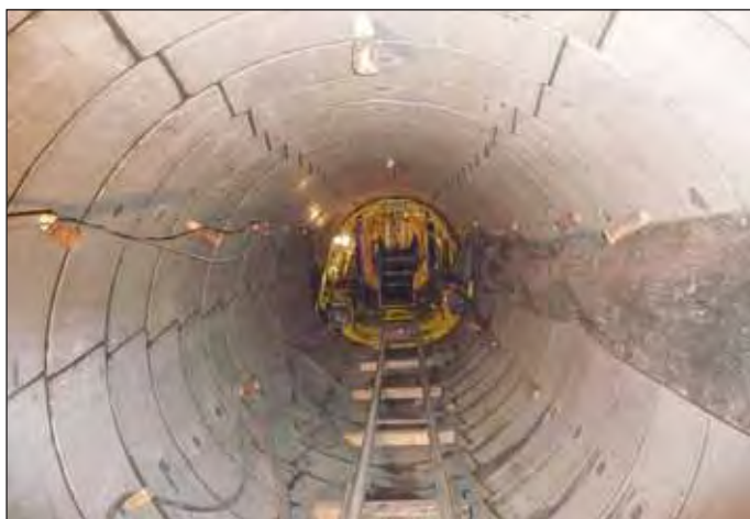
Obr. 5 Tubus tunelu po provedení těsnící injektáže (Bc. Petr Cupal) Fig. 5 Tunnel tube after completion of the sealing grouting (Bc. Petr Cupal)
