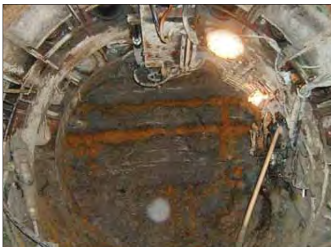
Obr. 9 Stabilní čelba razicího štítu DN 2560 mm bezprostředně po průchodu geologickou anomálií
