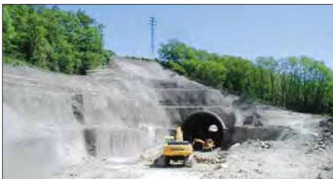
Obr. 1 Asymetrická stavební jáma tunelu Vepřek Fig. 1 Asymmetric construction trench – the Vepřek tunnel
