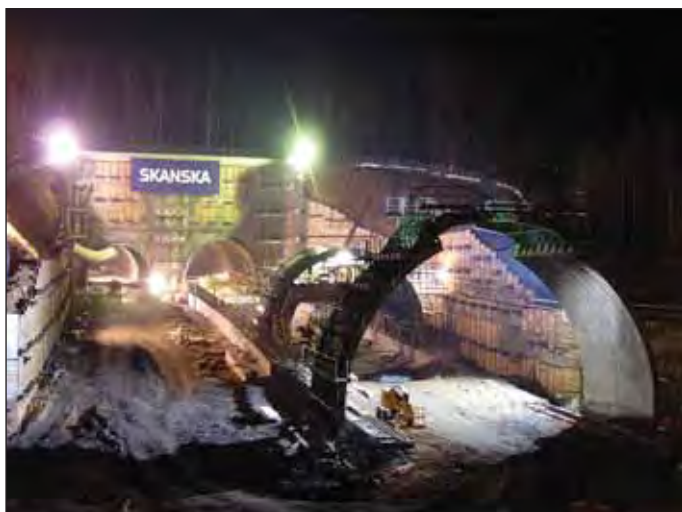
Obr. 3 Stavebná jama hĺbených tunelov Komořany Fig. 3 Construction trench for Komořany cut-and-cover tunnels
