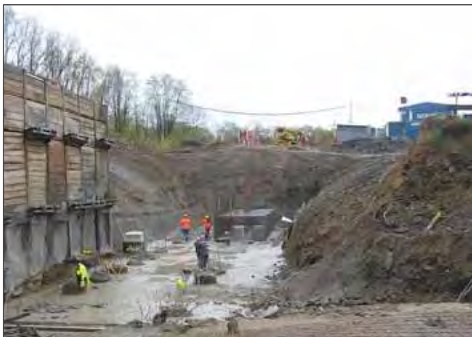
Obr. 14 Foto z výstavby – stavební jáma a výztuž základové desky Fig. 14 Photo from construction site – construction trench and foundation slab reinforcement
