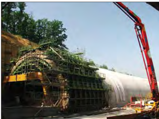
Obr. 6 Betonáž hlbeného tunela Fig. 6 Casting of the cut-and-cover tunnel lining
