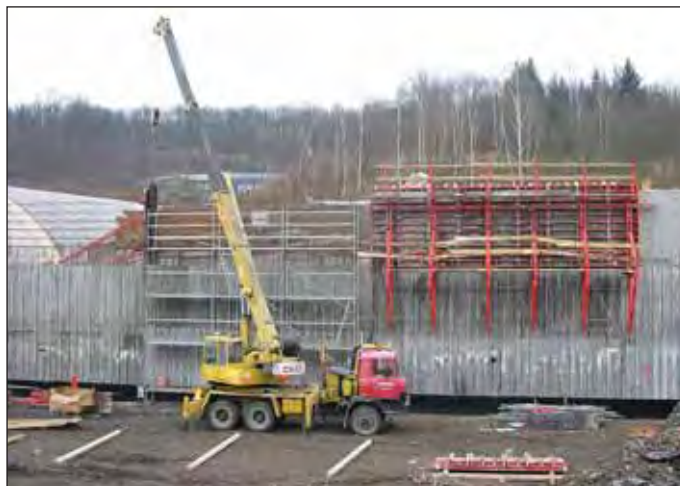
Obr. 15 Foto z výstavby – proudový postup výstavby – etapa 1 Fig. 15 Photo from construction site – flow method of construction – Stage 1
