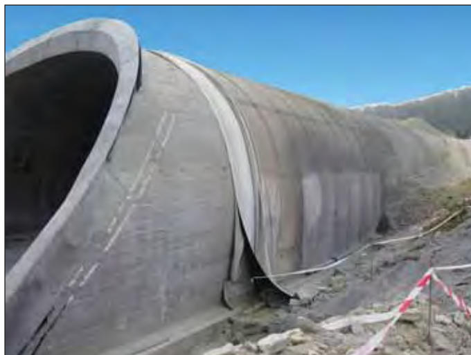
Obr. 10 Ochrana hydroizolace stříkaným betonem
