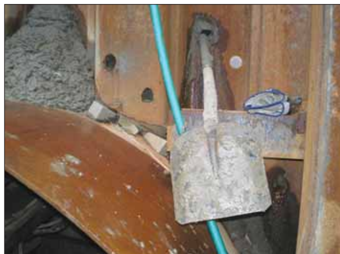
Obr. 4 Ilustrativní obrázek dokládající vlastnosti jílu – do zeminového prostředí za šachtou bylo možné zarazit ručně násadu od lopaty
