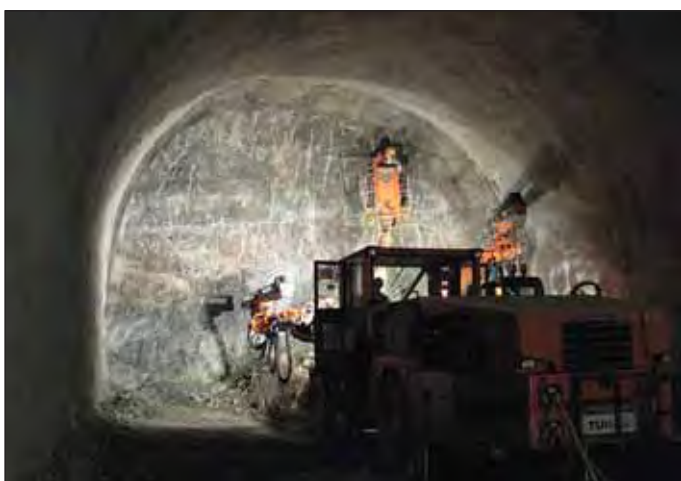
Obr. 3 Razenie pomocou vrtno-trhacích prác – navrtávanie čelby Fig. 3 Drill-and-blast operations – the face drilling
