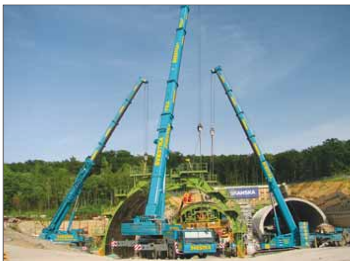
Obr. 5 Montáž vonkajšieho debnenia Fig. 5 Assembly of the external form
