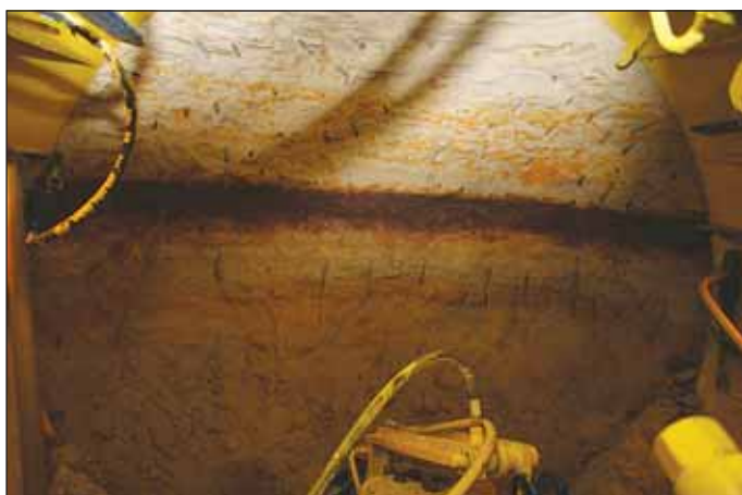
Obr. 3 Čelba tunelu, křemičité pískovce s polohou zpevněnou železitým tmelem (Bc. Petr Cupal) Fig. 3 Tunnel excavation face – quartzose sandstone with the layer solidified by ferrous cement (Bc. Petr Cupal)
