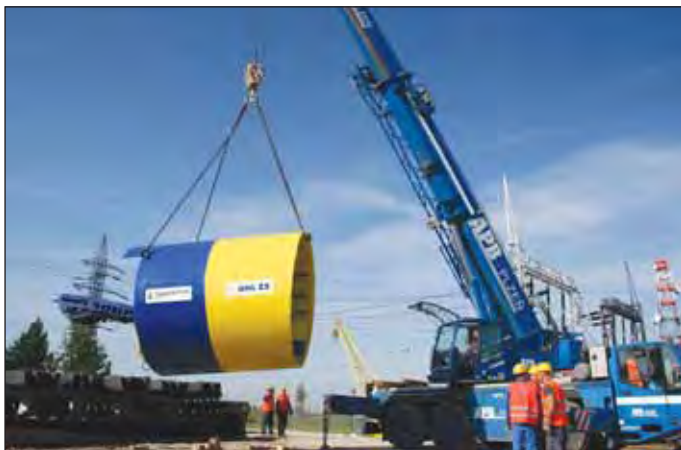
Obr. 4 Spouštění štítu (Bc. Petr Cupal) Fig. 4 Lowering of the shield (Bc. Petr Cupal)
