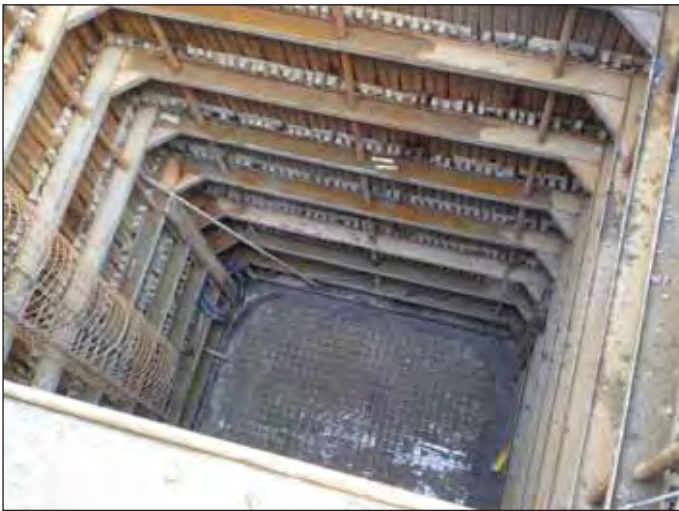
Obr. 1 Pažení a roubení šachty TŠ8 Fig. 1 TŠ8 shaft bracing
