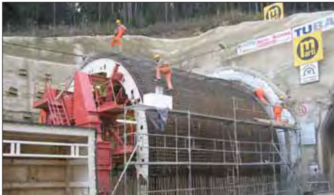
Obr. 6 Sekundárne ostenie – armovanie bloku v hĺbenej časti Fig. 6 Secondary lining – placing concrete reinforcement in the cut-and-cover section
