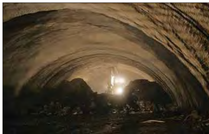
Obr. 4 Proražené kaloty severního tunelu se spojily v hloubce asi 35 m pod křižovatkou ulic Korunní a Jana Zajíce
