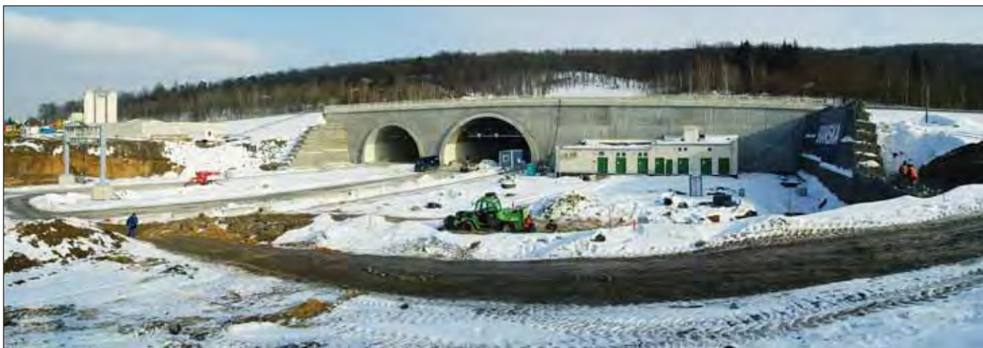
Obr. 1 Celkový pohled na portál Komořany Fig. 1 Overall view of the Komořany portal
