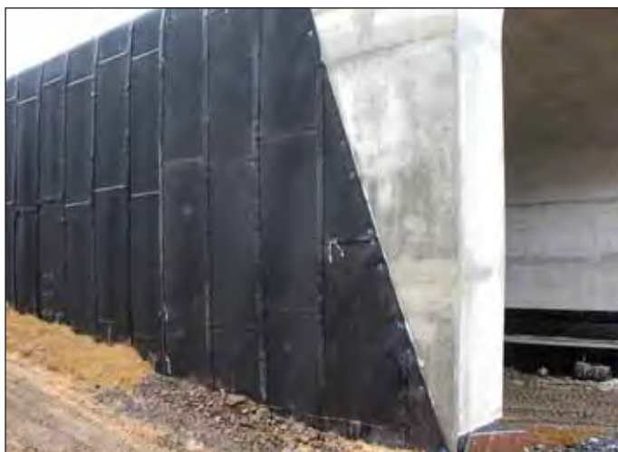
Obr. 11 Ochrana hydroizolace recyklátem pryže ELTEC
