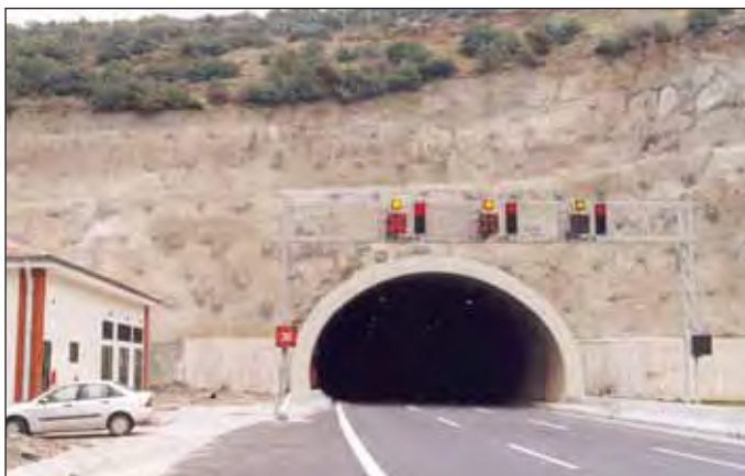
Obr. 5 Portál tunelu na dálnici Mersin–Adana–Gaziantep v Turecku, použité proměnné dopravní značení z produkce ELTODO, rok 2000 Fig. 5 Portal of a tunnel on the Mersin - Adana - Gaziantep motorway in Turkey; variable traffic signs produced by ELTODO, 2000
