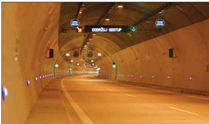
Obr. 8 Tunel Klimkovice v roce 2007 s proměnným dopravním značením z výroby ELTODO a Značek Praha
