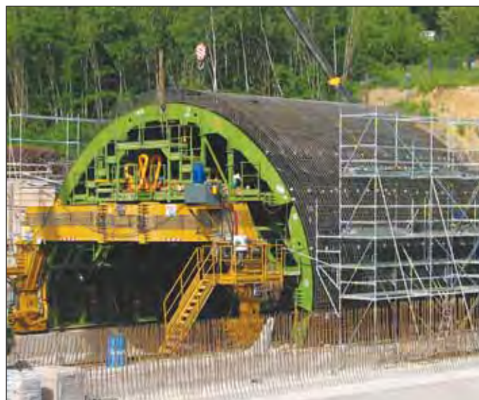
Obr. 9 Montáž ocelevej výstuže hĺbeného tunela
