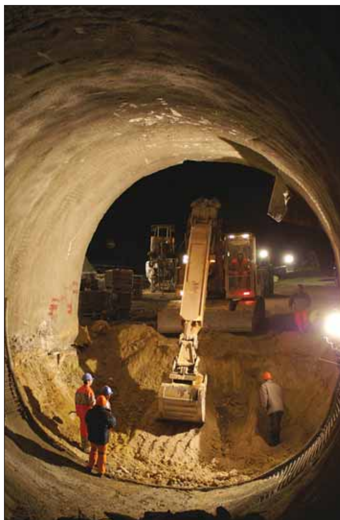
Obr. 5 Začistovanie spodnej klenby primárneho ostenia Fig. 5 Scaling for the primary lining invert
