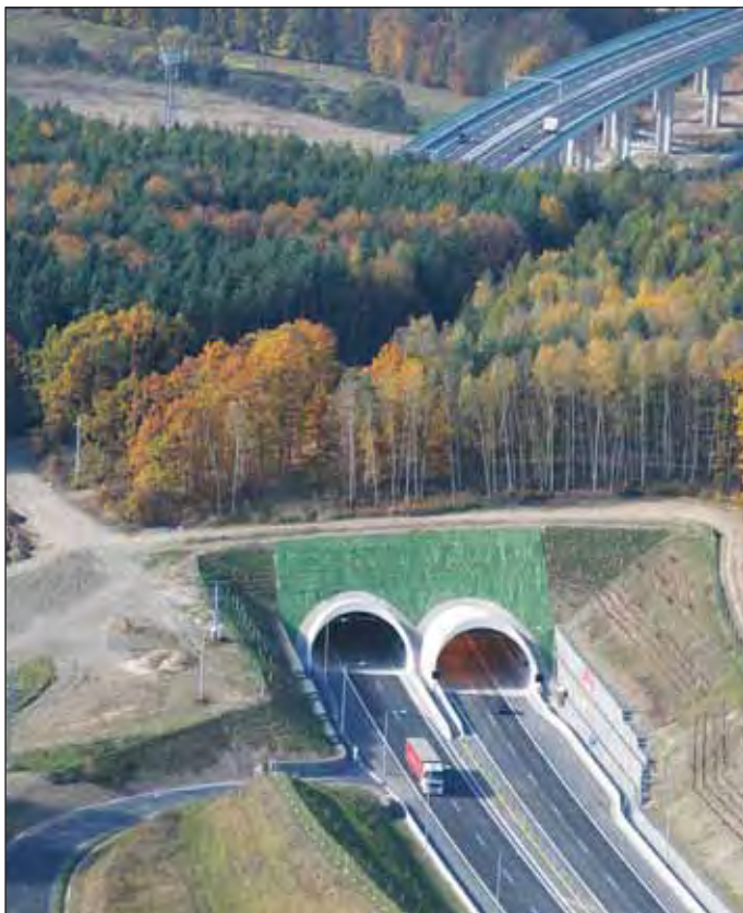
Obr. 2 Vrch Valík s dálničním tunelem Fig. 2 Motorway tunnel under Valík Hill
