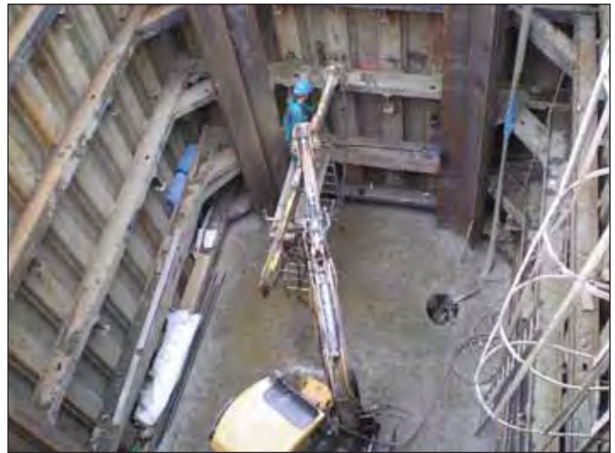
Obr. 2 Nově zapažená šachta TŠ6 – příprava injektážní clony Fig. 2 Newly braced TŠ6 shaft – preparation of grout curtain
