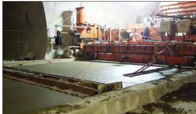
Obr. 7 Betonáž vozovky pomocou Finišeru Fig. 7 Casting concrete pavement by a paver
