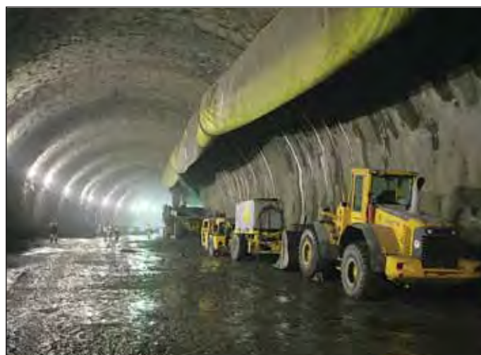
Obr. 6 Dokončený výlom tunelu
