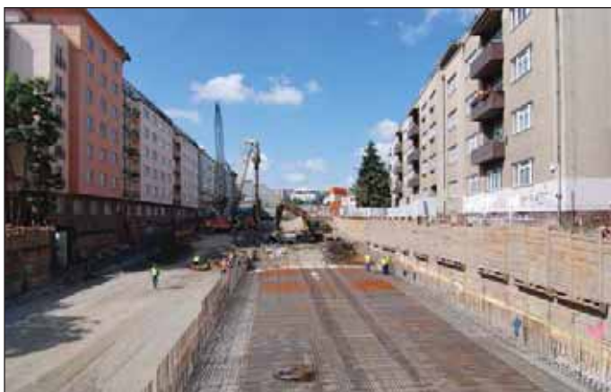
Obr. 4 Armování stropní desky na podzemních stěnách v ulici Patočkova – pohled od východu (Ing. Štěrba)
