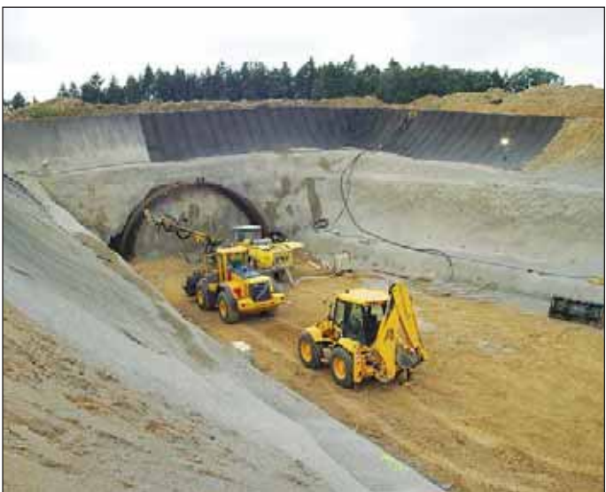
Obr. 9 Tomický I. tunel – stavební jáma vjezdového portálu Fig. 9 Tomice I. tunnel – construction pit for entrance portal
