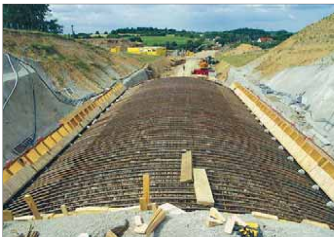
Obr. 4 Olbramovický tunel – výztuž a bednění hloubeného úseku Fig. 4 Olbramovice tunnel – reinforcement and formwork in the cut-and-cover section
