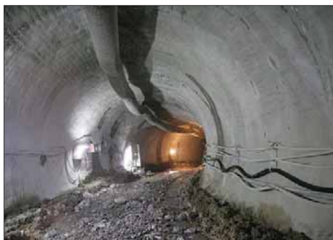
Obr. 6 Ražba přístupového tunelu do stanice Červený vrch Fig. 6 Excavation of the access tunnel to Červený vrch station
