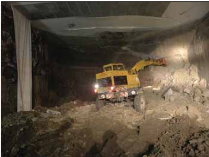
Obr. 7 Odtěžování v JTT pod ochranou stropu a podzemních stěn – dilatace D1 (Mgr. Kolařík)
