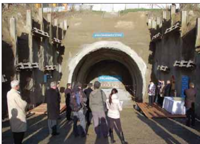
Obr. 5 Portál přístupového tunelu do stanice Červený vrch Fig. 5 Driven portal of the access tunnel to Červený Vrch station
