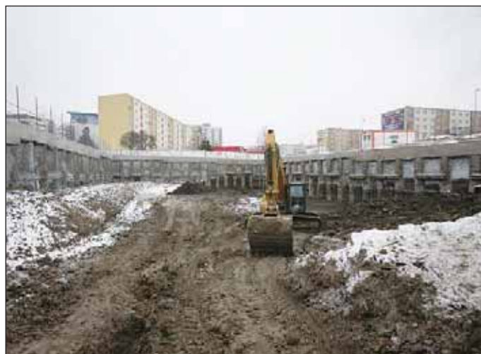
Obr. 4 Hloubení jámy E2 u stanice Veleslavín Fig. 4 Excavation of construction pit E2 at Veleslavín station
