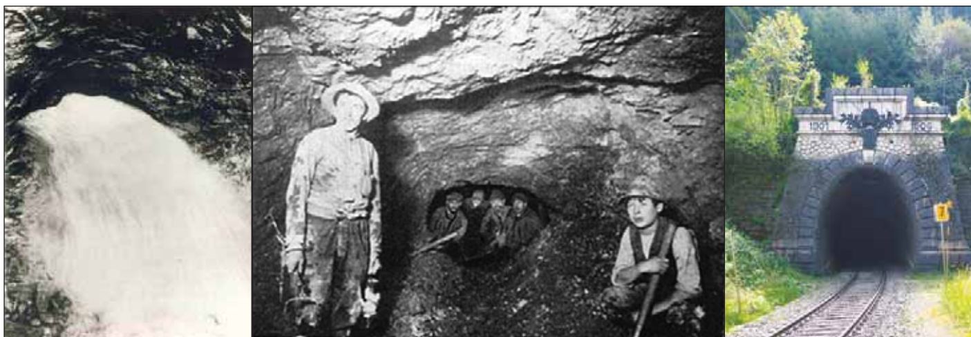
Obr. 1 Výstavba železničního tunelu 1901–1905, náhlý příval vody (vlevo), prorážka tunelu (uprostřed), severní portál (vpravo) Fig. 1 Construction of Rail Tunnel 1901–1905, Violent Water Inrush (Left), Breakthrough (Centre), Northern Portal (Right)
