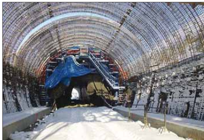
Obr. 2 Votický tunel – samonosná výztuž rozepřená o boky jámy Fig. 2 Votice tunnel – self-supporting reinforcement braced against the trench sides
