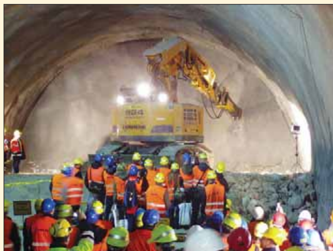
Obr. 1 Slávnostná prerážka železničného tunela Turecký vrch sa uskutočnila 25. novembra 2010
