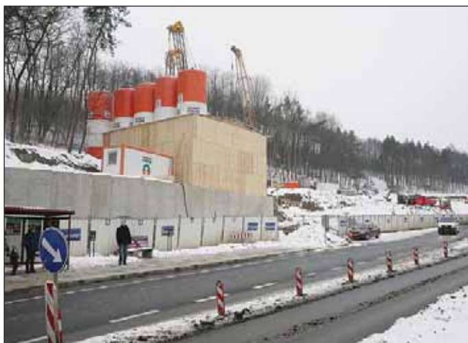
Obr. 3 Zařízení staveniště u stanice Motol Fig. 3 Station Motol construction site
