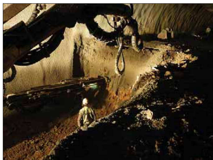
Obr. 1 Vrtání v opěří (Kukutsch) Fig. 1 Drilling into the bench (Kukutsch)
