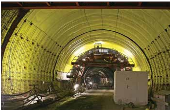
Obr. 14 Izolace horní klenby Fig. 14 Upper vault waterproofing
