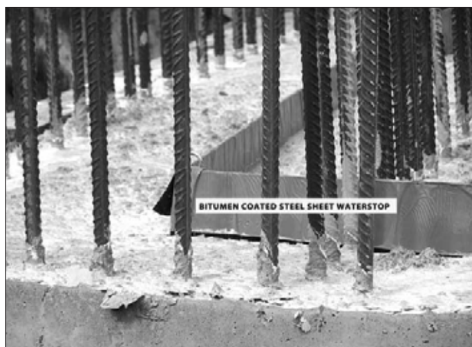
Obr. 7 Těsnicí plech v pracovní spáře
