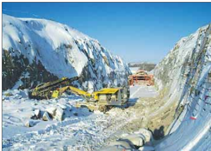
Obr. 1 Votický tunel – stavební jáma hloubky až 19 m Fig. 1 Votice tunnel – construction trench up to 19m deep
