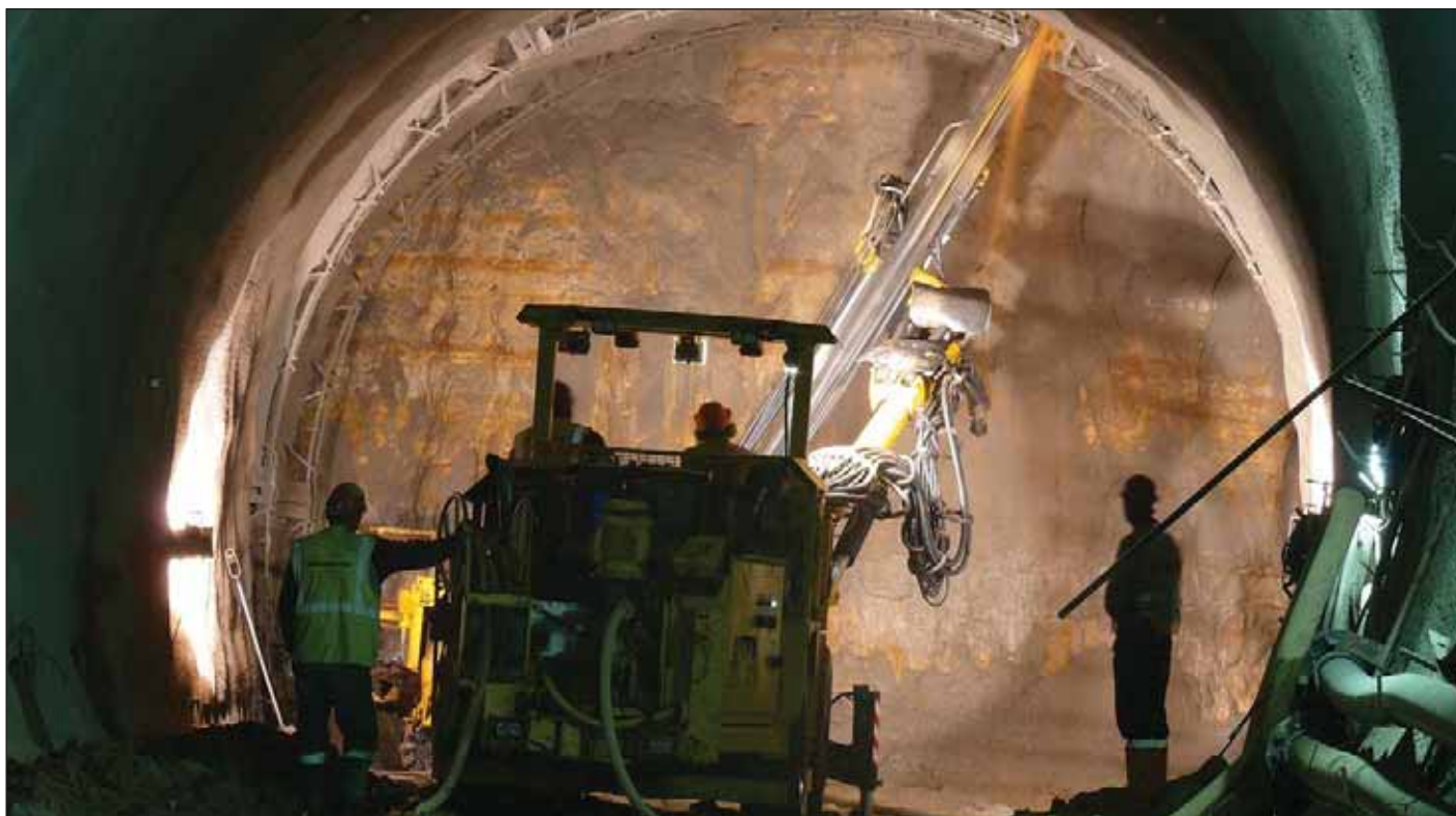
Obr. 7 Ražba přístupového tunelu do stanice Petřiny Fig. 7 Excavation of the access tunnel to Petřiny station
