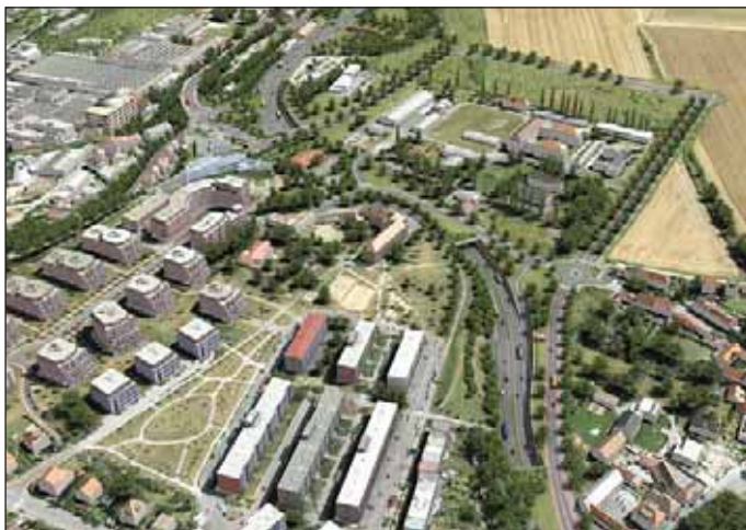
Obr. 9 Obnovený městský parter nad tunelem Jinonice (Artoo, s. r. o.) Fig. 9 Renewed urban floorscape above the Jinonice tunnel (Artoo s. r. o.)
