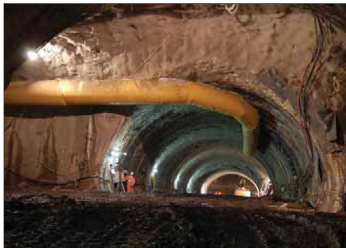
Obr. 2 Ražba dvojkoľejného tunelu směrem ke stanici Motol Fig. 2 Excavation the double-track tunnel toward Motol station
