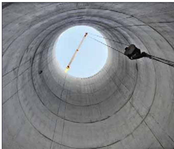
Obr. 8 Zahradnický tunel – definitivní ostění únikové šachty Fig. 8 Zahradnice tunnel – final lining of escape shaft
