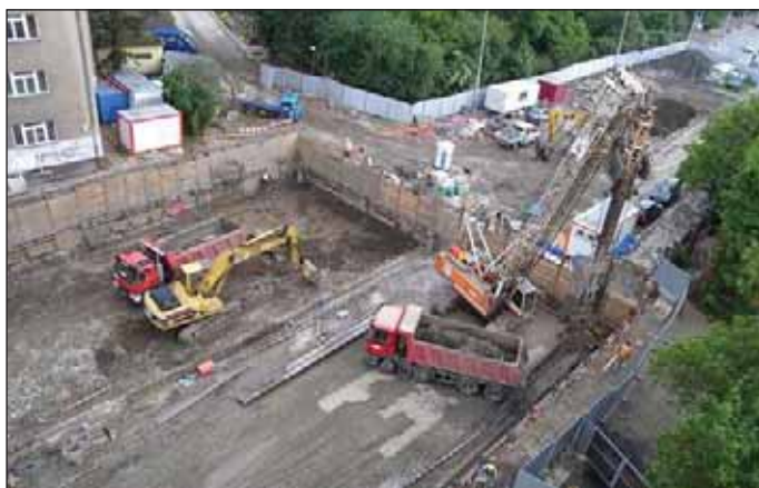
Obr. 3 Hloubení rýh pro podzemní stěny dilatace D4 (pohled ze střechy obj. č. p. 975) (Ing. Mazura)
