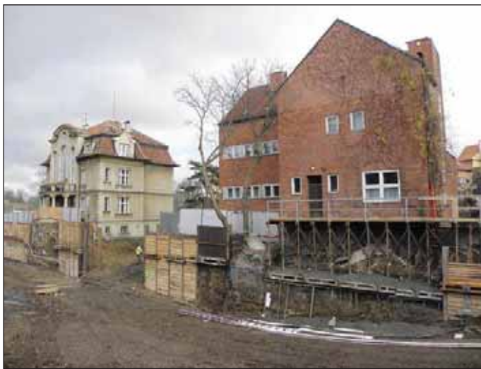
Obr. 5 Pohled na zajištění stavební jámy v místě objektů č. p. 711 a 712 (Mgr. Kolařík)
