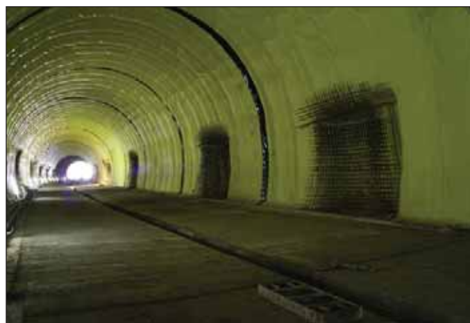
Obr. 6 Olbramovický tunel – výztuž výklenků v jinak nevyztuženém úseku Fig. 6 Olbramovice tunnel – reinforcement for recesses in an otherwise non-reinforced tunnel section
