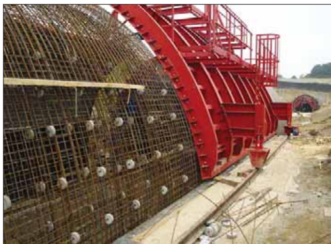
Obr. 3 Votický tunel – speciální bednění horní klenby Fig. 3 Votice tunnel – special formwork for the upper vault
