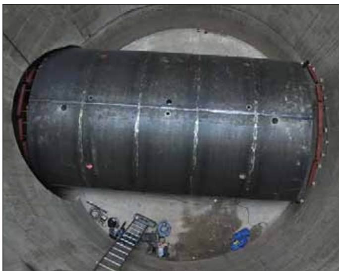
Obr. 7 Zahradnický tunel – bednicí vůz únikové štolky na dně šachty Fig. 7 Zahradnice tunnel – travelling shutter for the escape gallery at the shaft bottom
