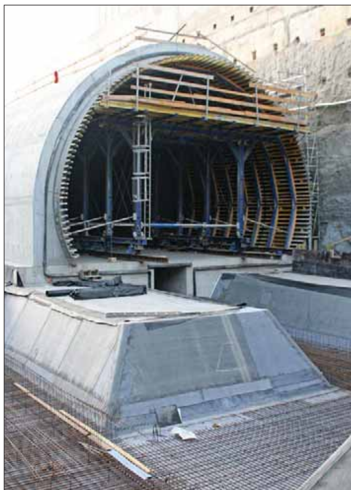
Obr. 3 Před betonáží ukládaná bentonitová izolace Voltex Fig. 3 Voltex bentonite mats installed before casting of concrete
