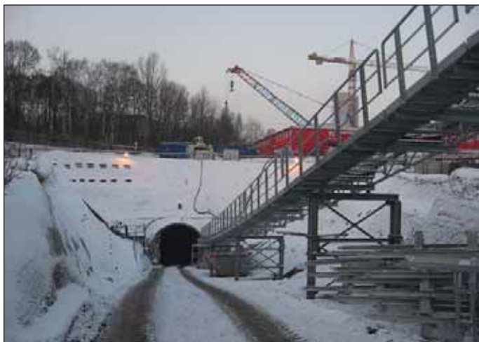
Obr. 1 Přístupový tunel Kateřina na Vypichu Fig. 1 The Kateřina access tunnel in the area of Vypich
