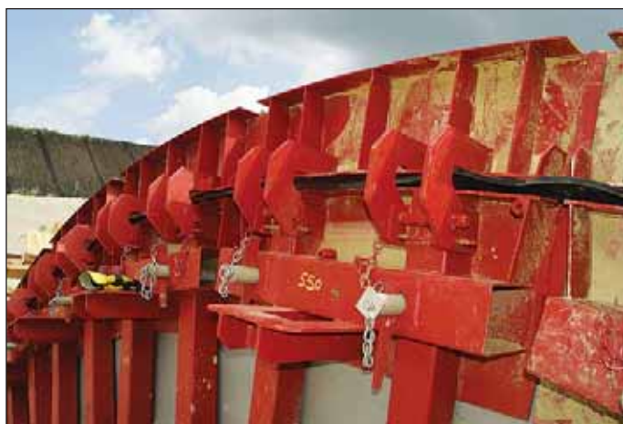
Obr. 5 Olbramovický tunel – úprava čela bednění pro vnitřní těsnicí pás Fig. 5 Olbramovice tunnel – formwork stop-end design for the internal waterstop
