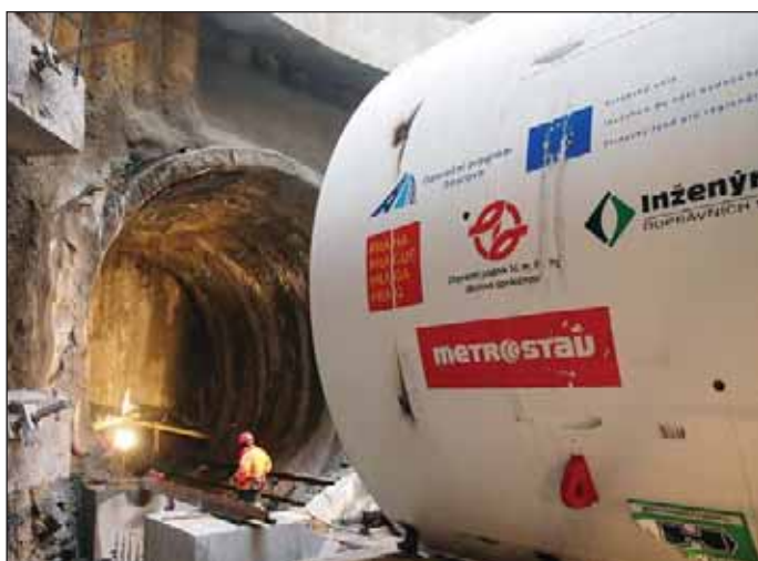
Obr. 10 První štít po spuštění do startovací šachty Fig. 10 The first shield after lowering to the launching shaft
