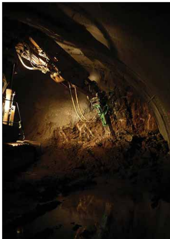
Obr. 7 Razičské práce na kalotě (Kukutsch) Fig. 7 Top heading excavation (Kukutsch)
