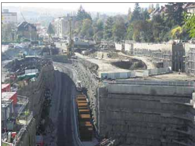
Obr. 6 Pohled na staveniště v Patočkově ulici od východu (Mgr. Kolařík) Fig. 6 A view of the construction site in Patočkova Street from the east (Mgr. Kolařík)
