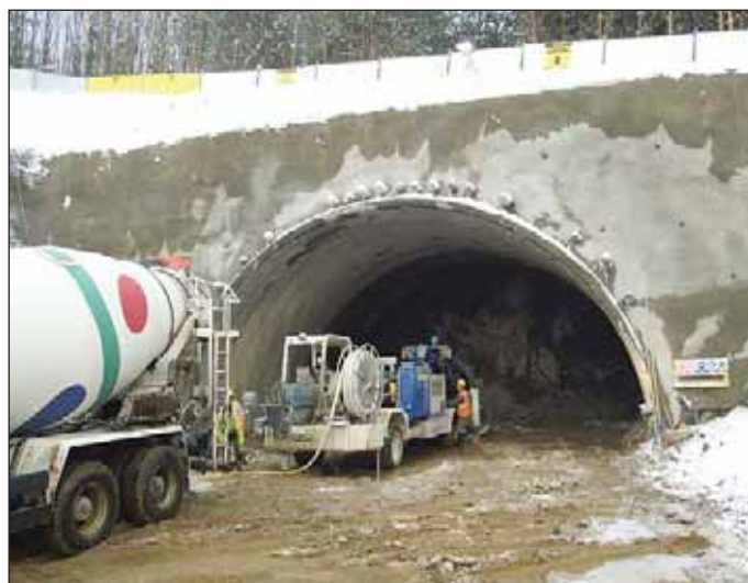
Obr. 12 Tomický II. tunel – první metry ražby Fig. 12 Tomice II. tunnel – initial metres of tunnel excavation
