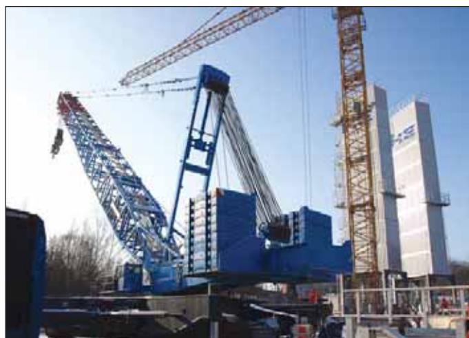
Obr. 11 Montáž technologií pro razičí štít na Vypichu Fig. 11 Installation of services for shields in the area of Vypich
