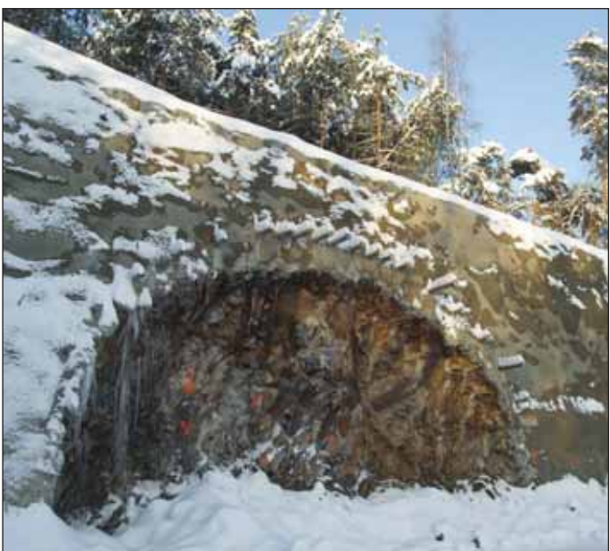
Obr. 11 Tomický II. tunel – výjezdový portál před zahájením ražby Fig. 11 Tomice II. tunnel – entrance portal before the comment of tunnelling
