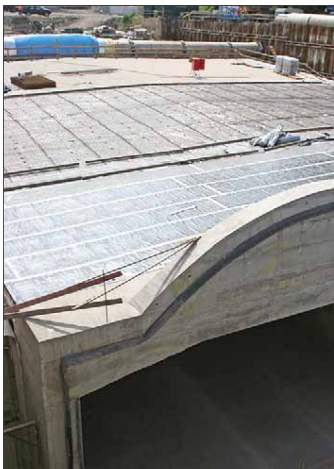
Obr. 4 Po odbednění ukládaná bentonitová izolace Dual Seal Fig. 4 Dual Seal bentonite membrane installed after the formwork stripping
