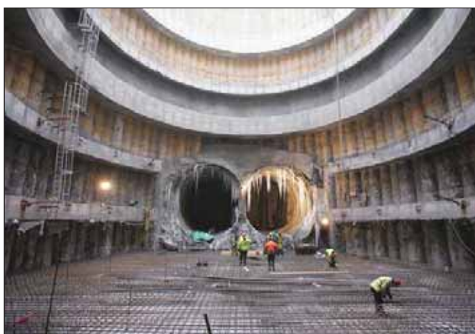
Obr. 8 Dno startovací šachty pro razičí štít Fig. 8 Bottom of the shield launching shaft
