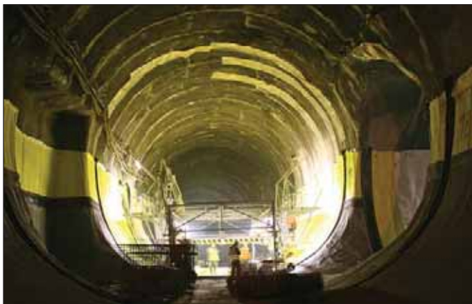
Obr. 13 Izolace spodní klenby s ochrannou fólií
