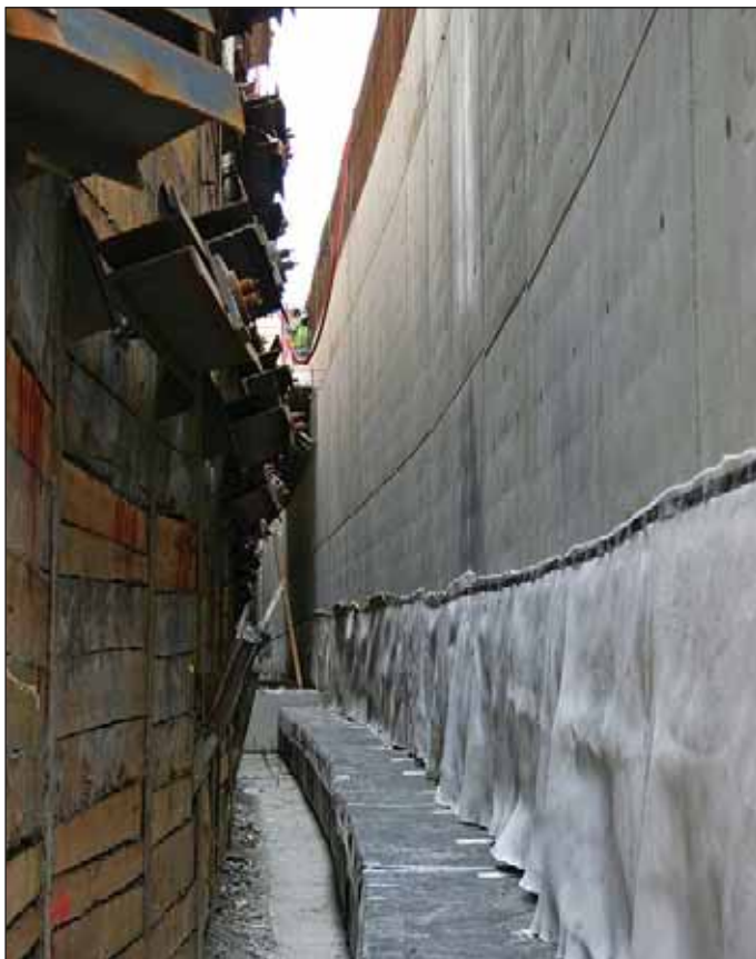
Obr. 8 Dočasná ochrana bentonitové izolace na stěně Fig. 8 Temporary protection of a bentonite waterproofing layer on the wall
