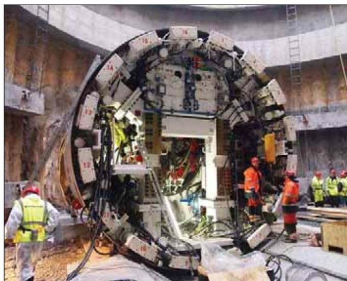
Obr. 9 Montáž štítu ve startovací šachtě Fig. 9 Shield assembly in the launching shaft
