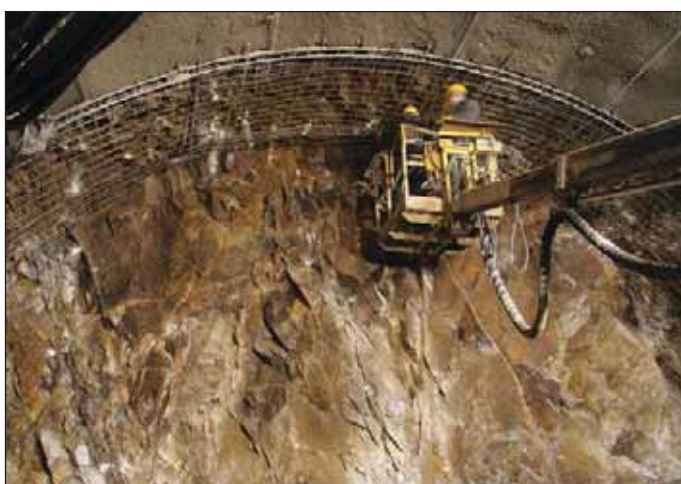
Obr. 10 Tomický I. tunel – geologické poměry na čelbě a montáž sítě Fig. 10 Tomice I. tunnel – geological conditions at the heading; installation of steel mesh
