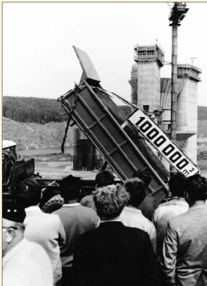
Obr. 4 VD Želivka – uložení miliontého kubíku zeminy při dosypání hráze
