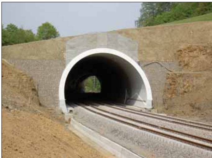
Obr. 6 Pohled na portál tunelu Hněvkovský I Fig. 6 A view of the Hněvkov I tunnel portal
