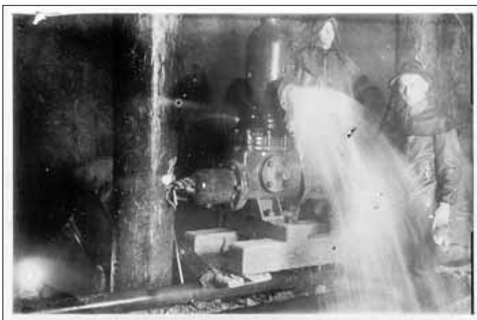
Obr. 5 Obsluha čerpadla Fig. 5 Pump operator
