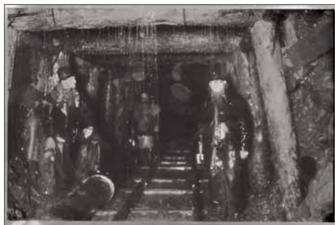
Obr. 3 Velké přítoky vody do štoly/tunelu Fig. 3 Large inflows of water into the gallery/tunnel
