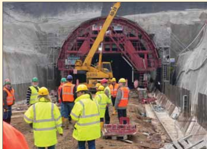
Obr. 6 Účastníci exkurze před portálem vyraženého tunelu Tomice I Fig. 6 Excursion attendees in front of the Tomice I tunnel where the excavation work has been completed
