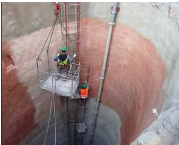
Obr. 9 Nástřik první vrstvy v šachtě Š1 ze závěsného koše; pracovník je zajištěn lezeckým vybavením
