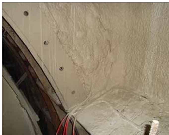
Obr. 2 Tybinkové ostění s injektážními hadicemi Fig. 2 Segmental lining with grouting hoses
