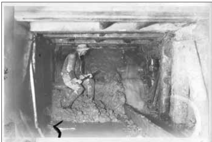
Obr. 7 Soustředěný pramen v čelbě štoly svedený do provizorního dřevěného koryta
