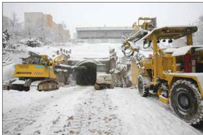
Obr. 5 Portál přístupové štolky s nákupním střediskem v pozadí Fig. 5 The portal of the access adit with the shopping centre in the background
