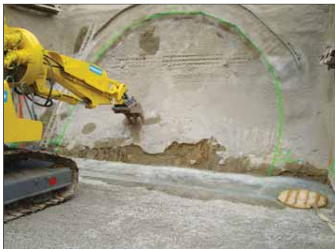
Obr. 1 Zahájení ražeb pod ochranou mikropilotového deštníku Fig. 1 Commencement of excavation under protection of canopy tube pre-support
