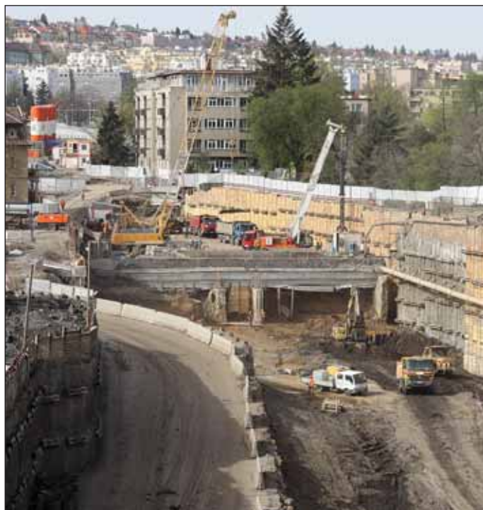
Obr. 1 Výstavba hloubených tunelů v jámě Patočkova Fig. 1 Construction of cut-and-cover tunnels in Patočkova construction trench
