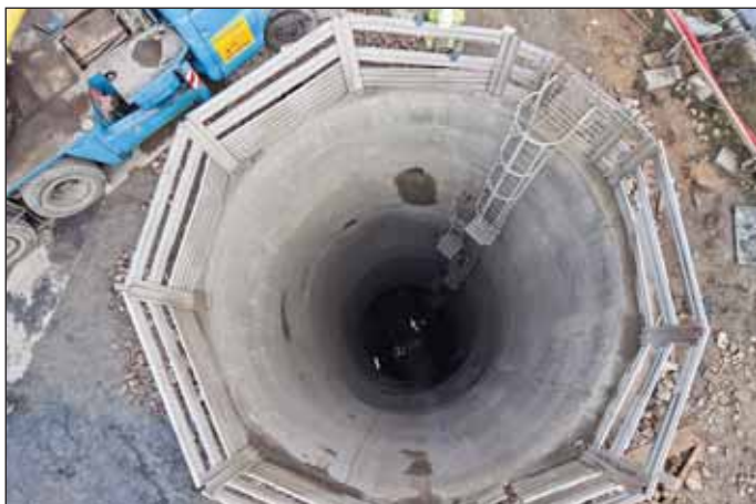
Obr. 4 Pohled na větrací objekt SO 03-29 Fig. 4 A view of the ventilation structure SO 03-29
