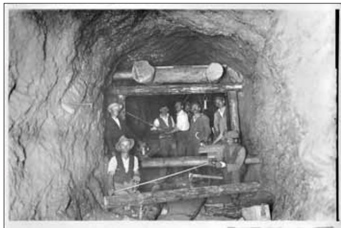
Obr. 11 Ražení štoly v kvalitní hornině Fig. 11 Driving the gallery through good quality rock
