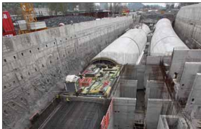
Obr. 14 Výstavba TGC6 a klenbových tunelů v Troji Fig. 14 Construction of services centre TGC6 and vaulted tunnels in Troja
