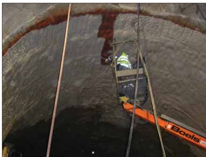
Obr. 6 Aplikace druhé vrstvy z manipulační plošiny bez probarvení na chodbě CH1 Fig. 6 Application of the second layer without colouring from the handling platform in the CH1 gallery
