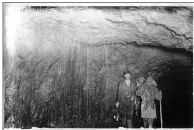
Obr. 2 Velké přítoky vody do štoly/tunelu Fig. 2 Large inflows of water into the gallery/tunnel
