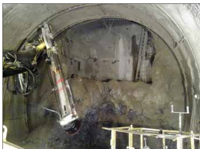
Obr. 7 Dodatečné kotvení ostění pomocí IBO kotev
