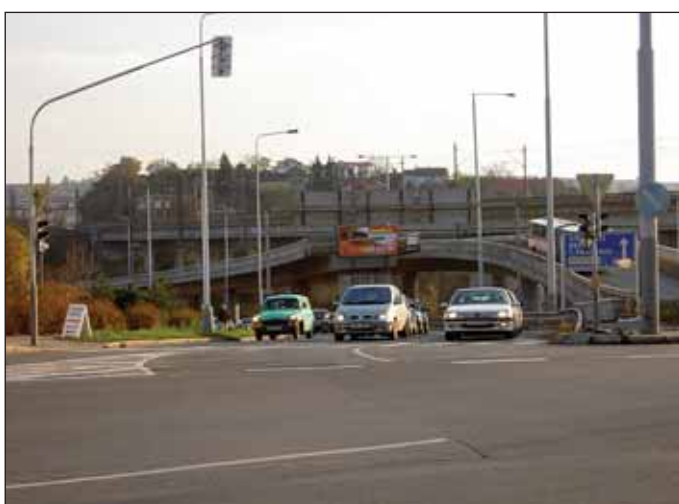
Obr. 3 Křižovatka U Kříže – nedokončené části MO Fig. 3 U Kříže intersection – the CCR parts to be completed
