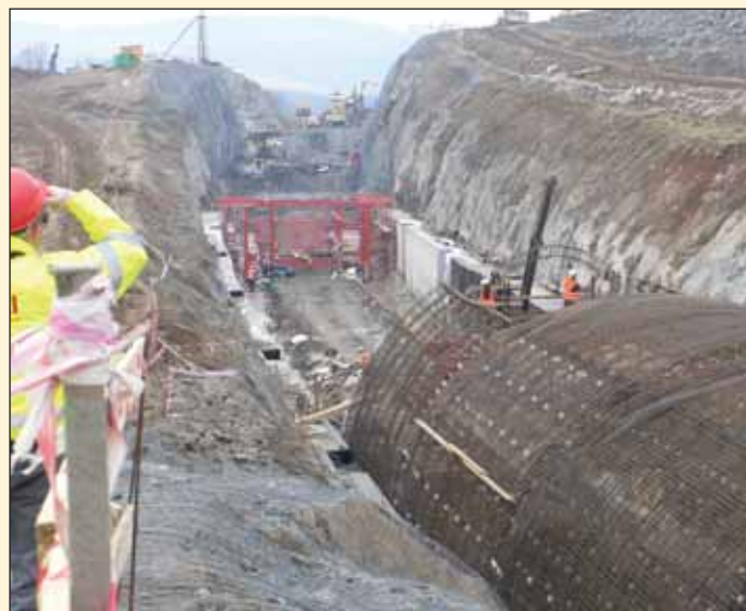
Obr. 4 Proudový postup prací na tunelu Votice Fig. 4 Production line technique applied to the Votice tunnel
