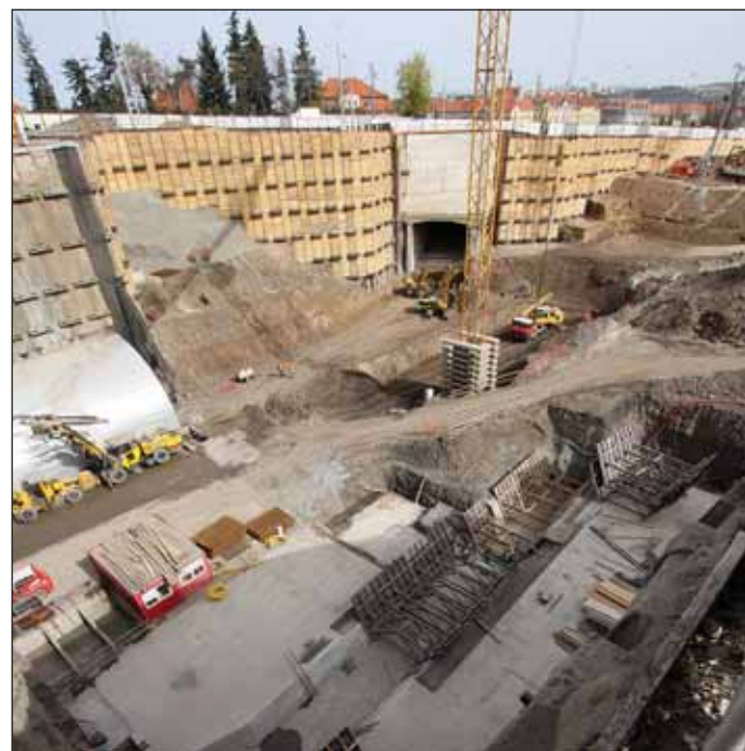
Obr. 6 Stavební jáma Prašný most, podkladní betony dilatačního dílu PG1 Fig. 6 Prašný Most construction pit, blinding concrete in expansion block PG1
