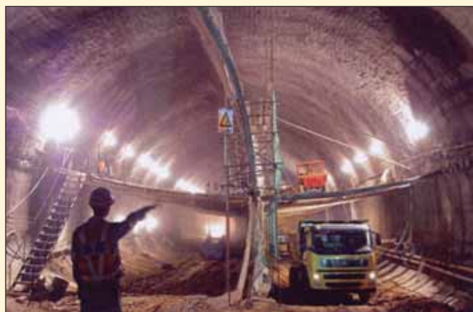
Obr. 2 Ražba tunelu byla prováděna konvenční metodou Fig. 2 Tunnel excavation was carried out using a conventional method
