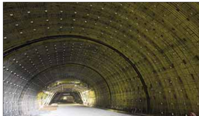
Obr. 2 Výztuž klenby definitivního ostění severního tunelu Brusnice Fig. 2 Reinforcement of the vault of the final lining of the northern tube of the Brusnice tunnel
