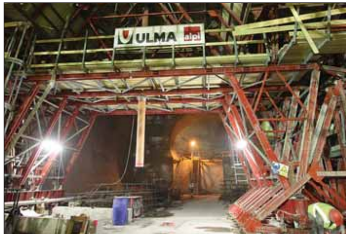
Obr. 12 Bednění klenby definitivního ostění strojovny vzduchotechniky Fig. 12 Formwork for the vault of the final lining of the ventilation plant cavern
