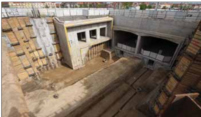
Obr. 7 Stavební jáma dilatačního dílu SJ10 v ulici Milady Horákové Fig. 7 Construction trench for expansion block SJ10 in Milady Horákové Street
