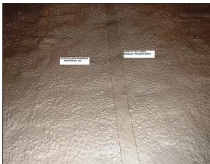
Obr. 4 Provedení ošetření polymercementové hydroizolace v místě budoucí pracovní spáry definitivního ostění
