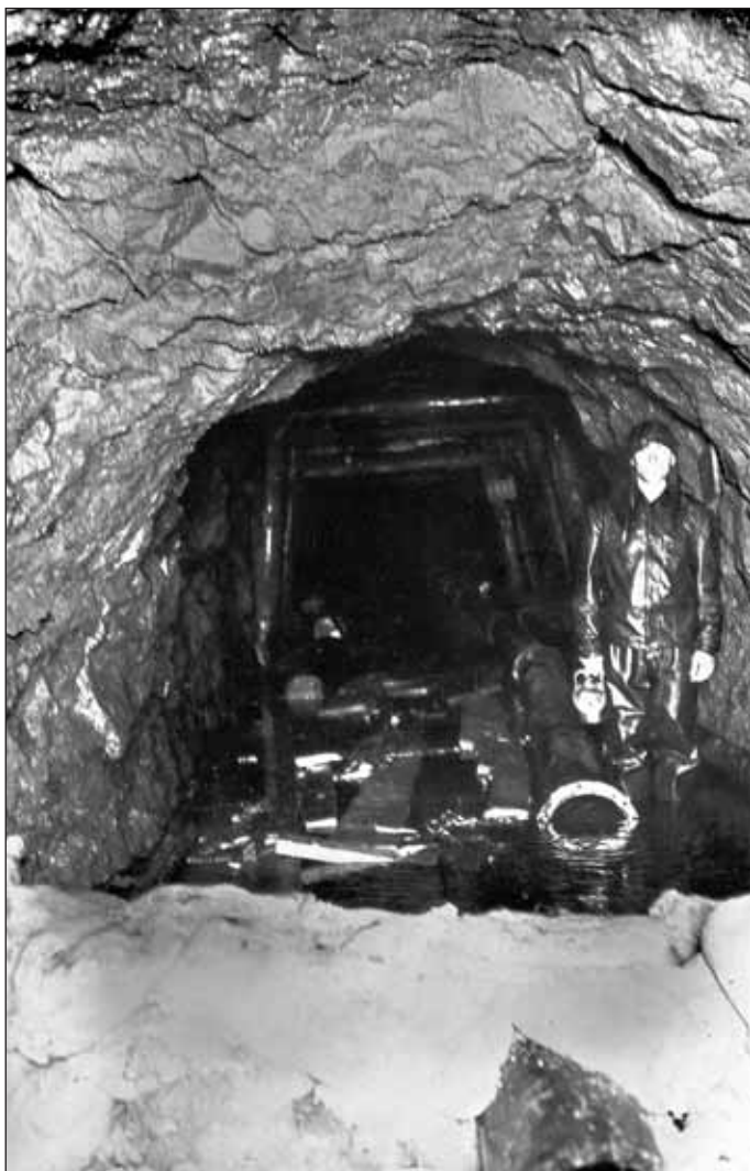
Obr. 4 Velké přítoky vody do štoly/tunelu Fig. 4 Large inflows of water into the gallery/tunnel
