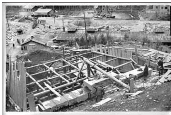
Obr. 14 Zdění portálu, v pozadí zařízení staveniště Fig. 14 Portal masonry. The site facility in the background
