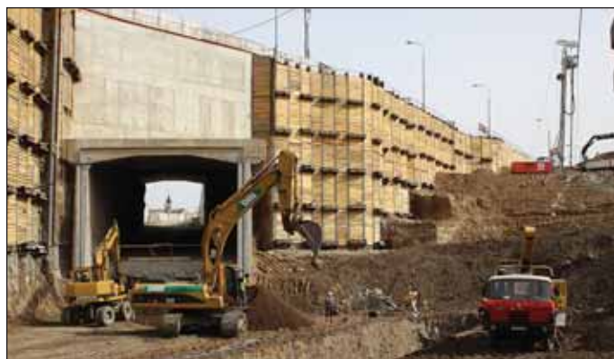
Obr. 5 Rampa Svatovítská ve staveništi Prašný most Fig. 5 Svatovítská ramp at Prašný Most construction site
