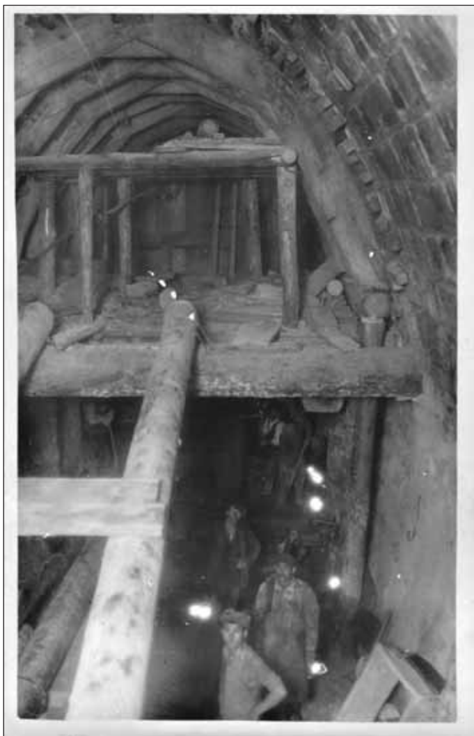
Obr. 12 Zdění tunelového ostění Fig. 12 Tunnel lining masonry
