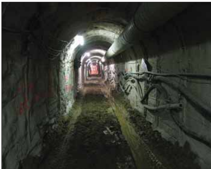
Obr. 3 Ražba štoly – primární ostění štoly Fig. 3 Gallery excavation – primary lining
