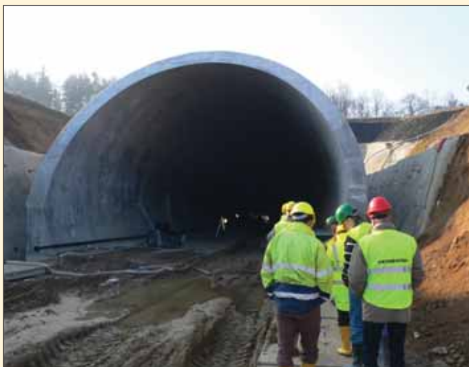
Obr. 1 Portál Olbramovického tunelu Fig. 1 Olbramovice tunnel portal
