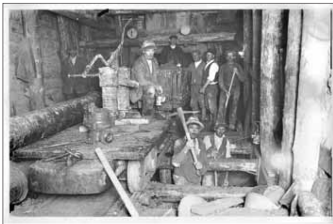
Obr. 8 Zdění – na plošinovém vozíku (rozchodu 760 mm?) ruční čerpadlo
