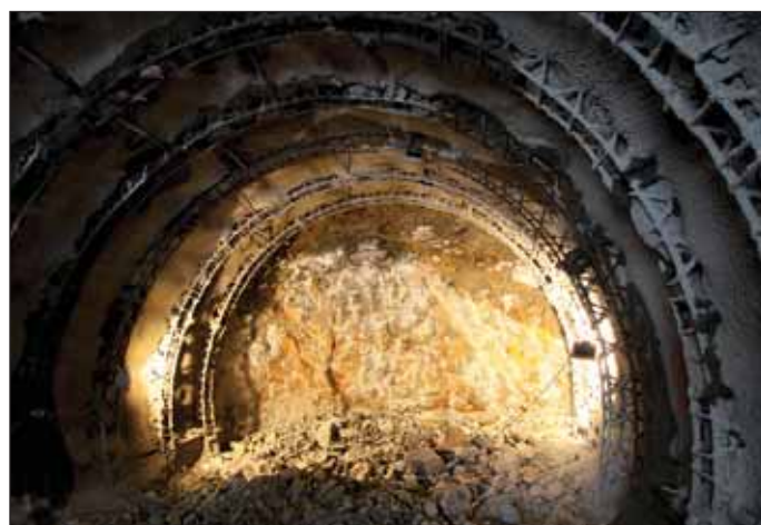
Obr. 3 Pohled na čelbu při ražbě vinného sklepa
