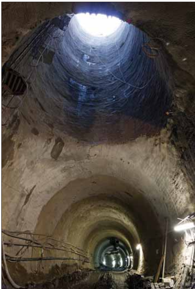
Obr. 6 Místo průniku přístupové štoly a větracího objektu
