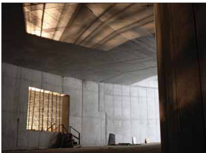
Obr. 9 Otvor pro větrací klapky v dělicí stěně mezi rampami 2/3 U Vorlíků Fig. 9 An opening for dampers in the dividing wall between ramps 2/3 U Vorlíků
