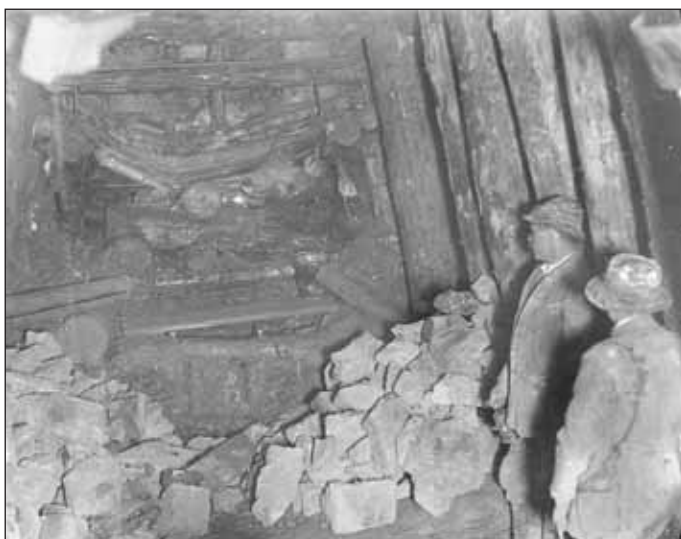
Obr. 9 Prolomený podvoj – projev mimořádně vysokého horninového tlaku (bobtnání?)
