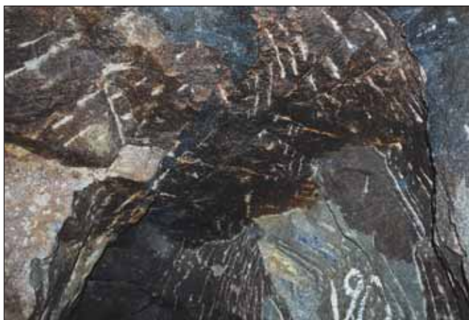
Obr. 6 Ukázka sázení ohněm a práce železkem a mlátkem (komora K3); foto Lednická
