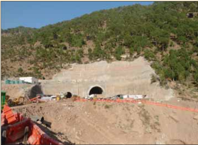
Obr. 3 Jižní a severní portál tunelu (říjen 2011)
