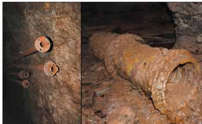
Obr. 6 Pozůstatky vzduchotlakého (vlevo) a ventilačního potrubí (vpravo) v podzemí tvrží Skutina a Stachelberg; průměr ventilačního potrubí je 30 cm Fig. 6 Remnants of the pressure air pipeline (left-side) and ventilation duct (right-hand) in the underground of Skutina and Stachelberg fortresses. The ventilation duct is 30 cm in diameter
