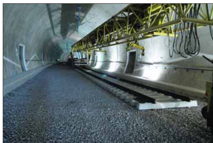
Obr. 4 Pokládka kolejových polí železničního svršku (foto Ing. Mařík IKP Consulting Engineers) Fig. 4 Installation of trackwork (photo courtesy of Ing. Mařík IKP Consulting Engineers)
