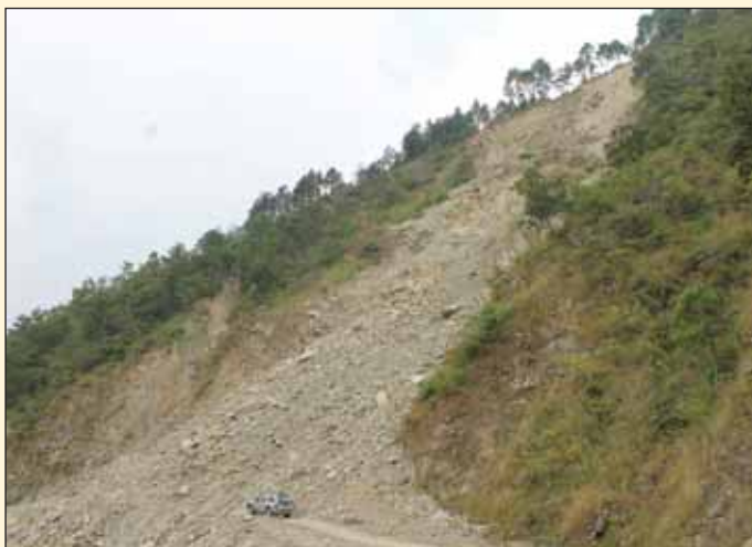
Obr. 6 Aktivní svahový sesuv podél přístupové cesty ke štolě Sindhu Fig. 6 Active slope slide along the access road to the Sindhu gallery
