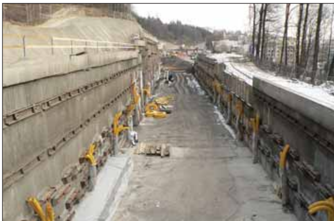
Obr. 1 Z výstavby stanice Motol (foto Ing. Marián Chotár) Fig. 1 From Motol Station construction (photo courtesy of Marián Chotár)
