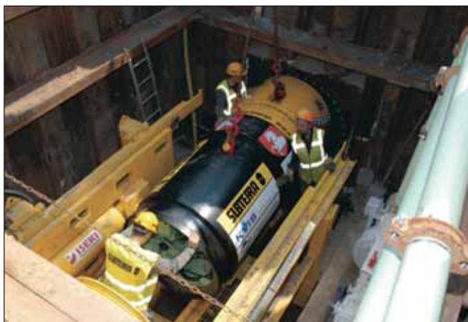
Obr. 3 Usazení stroje na vodící lyžiny
