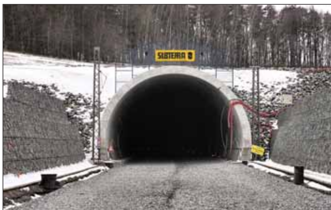
Obr. 1 Zahradnický tunel, (foto Ing. Šponar Subterra, a. s.) Fig. 1 Zahradnice Tunnel (photo courtesy of Ing. Šponar, Subterra, a. s.)
