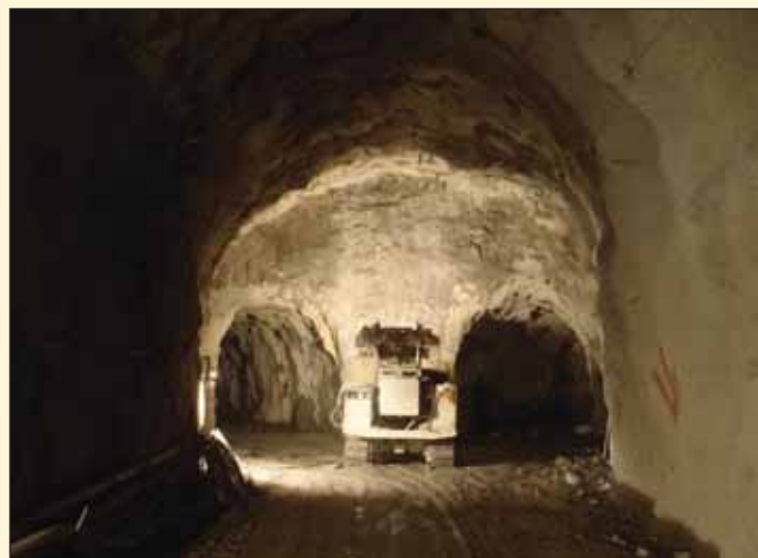
Obr. 3 Přístupová štola Sindhu – křižovatka s vodovodním přivaděčem Fig. 3 Sindhu access gallery – crossing with the water supply tunnel
