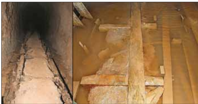
Obr. 5 V podzemí tvrže Stachelberg je stavební drážka i po více než 70 letech stále dobře patrná; přes prache byla položena prkna pro snadnější pohyb dělníků v podzemí; kolejnice byly demontovány při přerušení prací v září 1938 Fig. 5 A building-purpose narrow-gauge track is still well visible in the Stachelberg fortress underground even after over 70 years. Planks were placed over sleepers to allow easier movement of workers in the underground. Rails were dismantled when the works were suspended in September 1938
