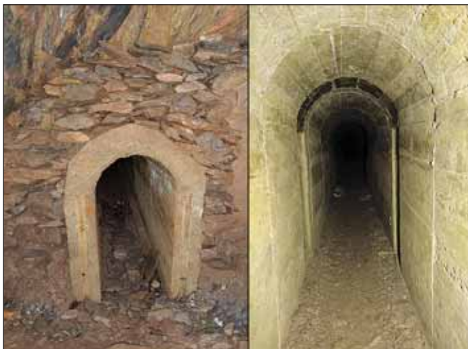
Obr. 3 Odvodňovací štola tvrže Dobrošov v blízkosti nevybudovaného vchodového objektu; na dně štoly je uloženo odvodňovací potrubí, které i dnes spolehlivě odvádí vodu z podzemí tvrže
