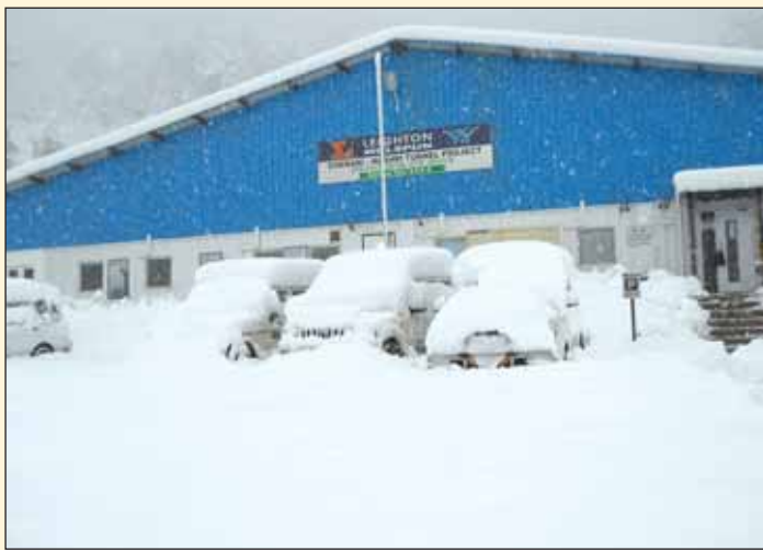
Obr. 4 Kancelářská budova v „Campu“ a jižní portál (leden 2012)
