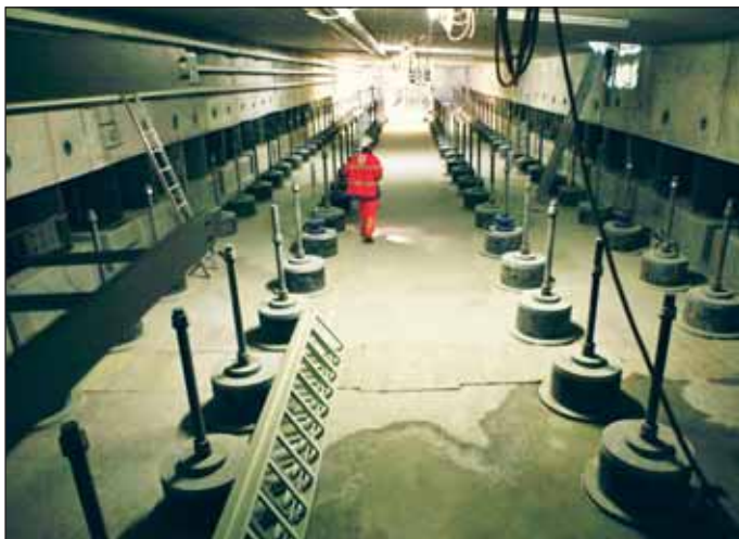
Obr. 10 Pohled na prostor pod vozovkou se základovými prvky a kotvícími prvky v plochém dně tunelu
