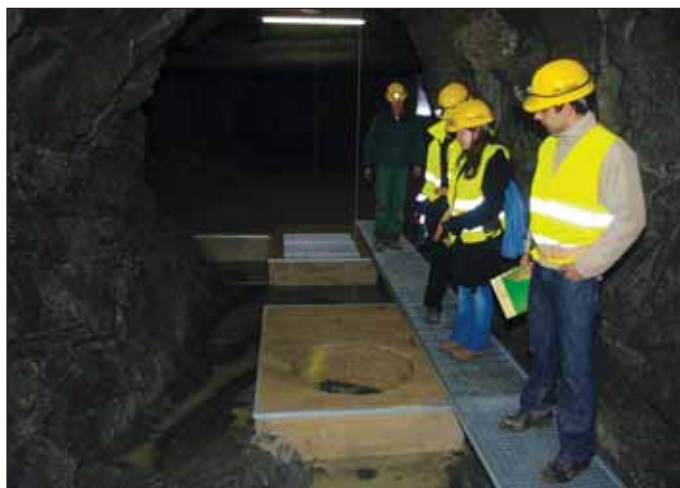
Obr. 6 Rozrážka se studnami pro experimenty Mock-Up (Vojta Hrach)
