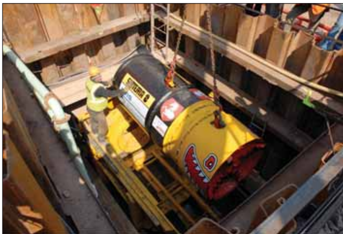
Obr. 2 Spouštění stroje Iseki do šachty Fig. 2 Iseki machine lowering to the shaft
