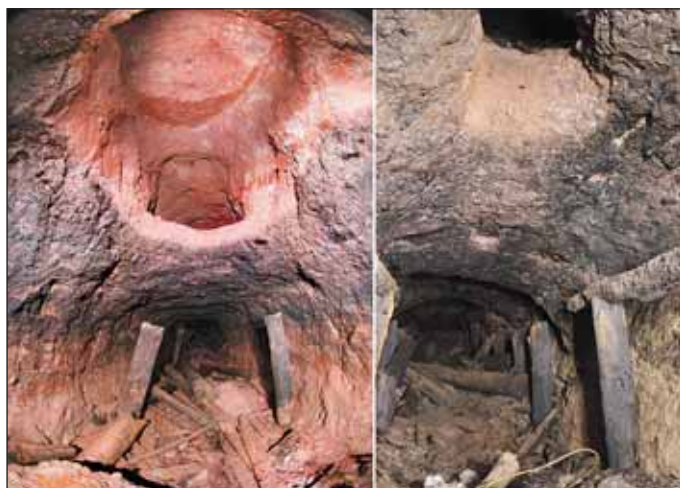
Obr. 12 Použití rakouské tunelovací soustavy je dobře patrné také v podzemí tvrže Stachelberg; nad spodní směrovou štolou je ražena štola horní, ze které probíhalo dobírání kaloty, postupný sestup a propojení do spodní štoly; na pravém snímku je ve stropě mezi spodní a horní štolou patrný „sypák“ pro dopravu rubaniny
