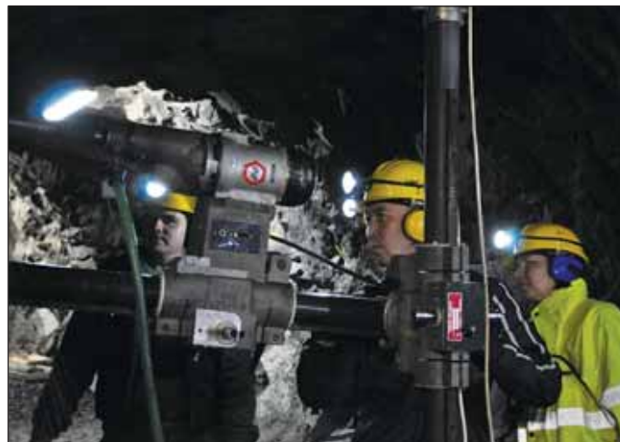
Obr. 9 Vrtání na jádro (Dana Pacovská) Fig. 9 Cored drilling (Dana Pacovská)
