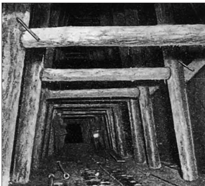
Obr. 16 Historický snímek, zachycující německé vojáky při prohlídce vyražené komory pro kasárna v podzemí tvrze Stachelberg; použita výdřeva odpovídá anglické tunelovací soustavě (1938) [5]
