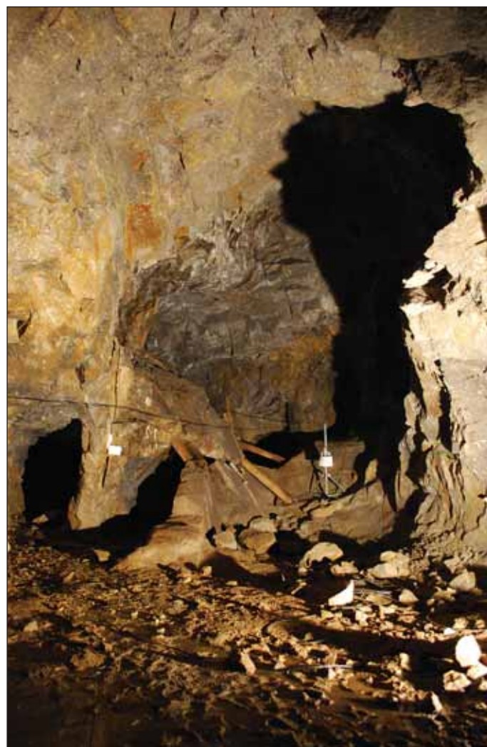
Obr. 5 Komora K2 (uprostřed laserové čidlo pro měření svislé konvergence); foto Lednická Fig. 5 Chamber K2 (a laser sensor measuring vertical convergence is in the centre); Photo courtesy of Lednická
