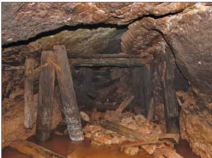
Obr. 8 Pozůstatky výdřevy pomocí klasických lichoběžníkových věřejí na hlavní galerii tvrže Stachelberg
