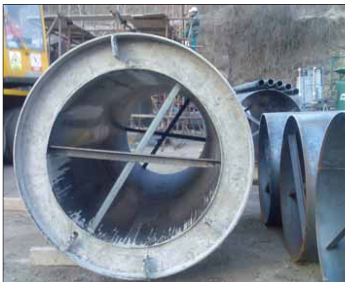
Obr. 4 Čelo vybetonované trouby teplovodu bez trubek pro kabely, v pozadí trouba s kabelovými trubkami připravená k betonáži
