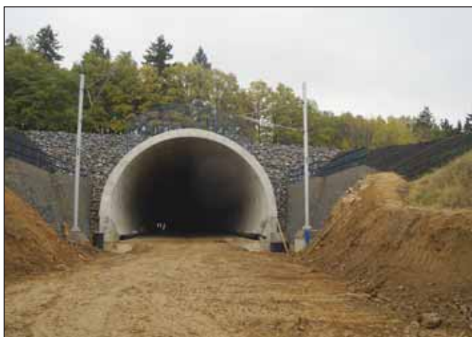
Obr. 3 Portál Tomického tunelu (foto Ing. Mařík IKP Consulting Engineers) Fig. 3 Tomice Tunnel portal (photo courtesy of Ing. Mařík IKP Consulting Engineers)
