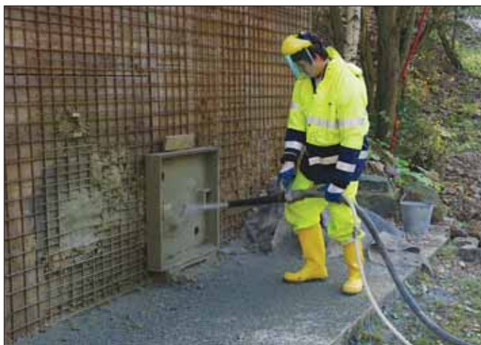
Obr. 5 Cvičná stěna pro stříkaný backfill (Radek Vašíček)
