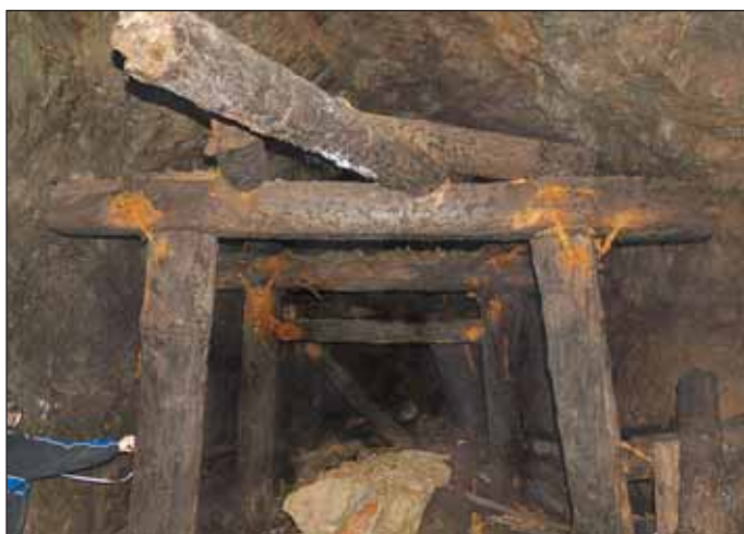
Obr. 13 Torzo zajištění výrubu v podzemí tvrže Stachelberg; spoj sloupů s hlavními prahy je tvořen skobami a plochými klíny; na hlavních prazích leží podélné průvlaky o průměru 30 cm; z prahů se již zřítily vějířovité vzpěry plné vazby
