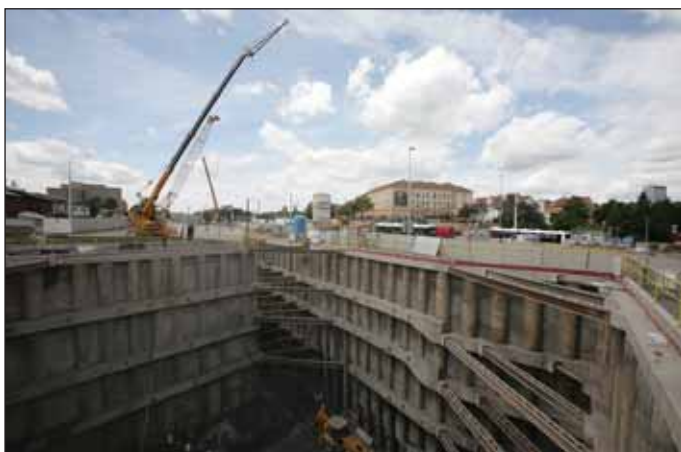
Obr. 6 Pohled do stavební jámy z východní strany
