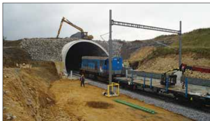
Obr. 2 Montážní vlak před portálem Votického tunelu (foto Ing. Mařík IKP Consulting Engineers) Fig. 2 Track laying train in front of the Votice Tunnel portal (photo courtesy of Ing. Mařík IKP Consulting Engineers)
