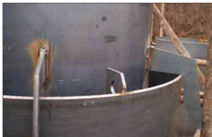
Obr. 5 Horní držák rozteče potrubí
