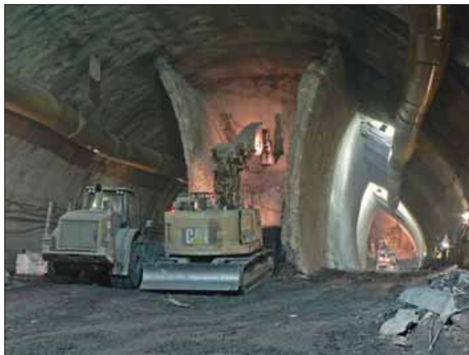
Obr. 3 Ražba stanice Červený vrch (foto Ing. Marián Chotár) Fig. 3 Červený Vrch Station excavation (photo courtesy of Marián Chotár)
