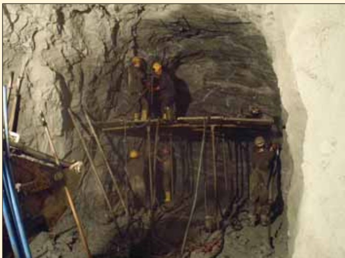
Obr. 4 Příprava na manuální vrtání čelby Fig. 4 Preparation for manual face drilling
