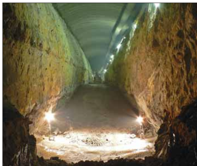
Obr. 4 Střední výrub jednodílné stanice Petřiny (foto Ing. Marián Chotár) Fig. 4 Central excavation sequence for Petřiny one-vault station (photo courtesy of Marián Chotár)
