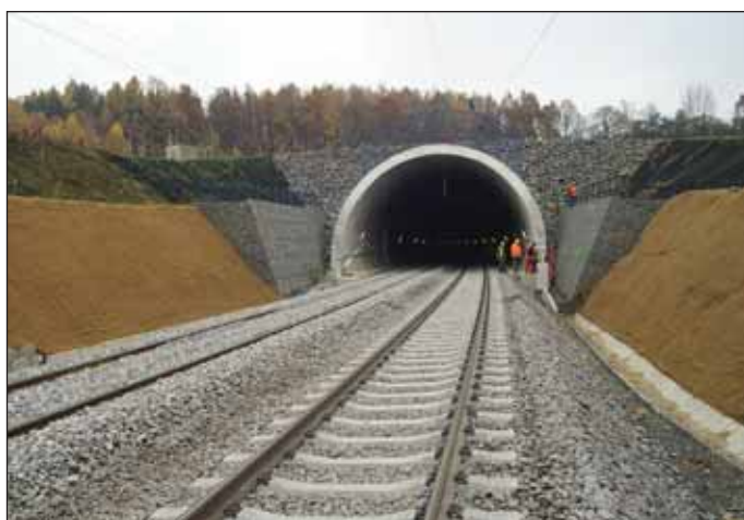
Obr. 5 Výjezdový portál Olbramovického tunelu (foto Ing. Mařík IKP Consulting Engineers) Fig. 5 Olbramovice Tunnel exit portal (photo courtesy of Ing. Mařík IKP Consulting Engineers)
