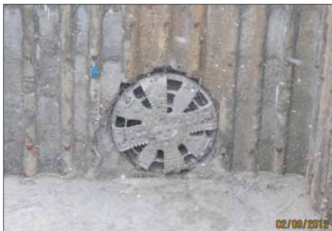
Obr. 5 Štít Tonda a zimní nálada v jámě E2 (foto Ing. Luděk Rais) Fig. 5 Tonda TBM and the winter atmosphere in E2 construction pit (photo courtesy of Luděk Rais)
