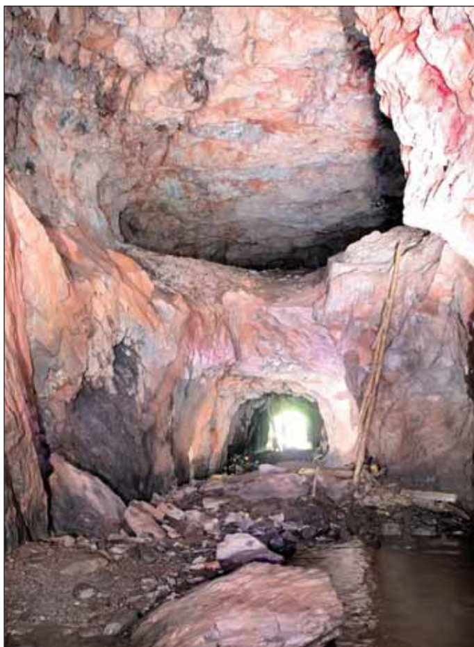
Obr. 11 Použití rakouské tunelovací soustavy modifikované ve vchodových partiích tvrže Skutina
