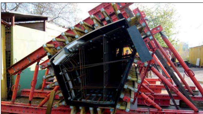
Obr. 5 Betonážní pokus zhotovení části trámu před výstavbou definitivního ostění (duben 2012)
