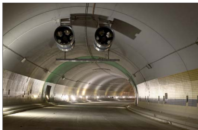
Obr. 4 Třípruhový ražený tunel s dvojicí ventilátorů pod klenbou (foto Jakub Karlíček)
