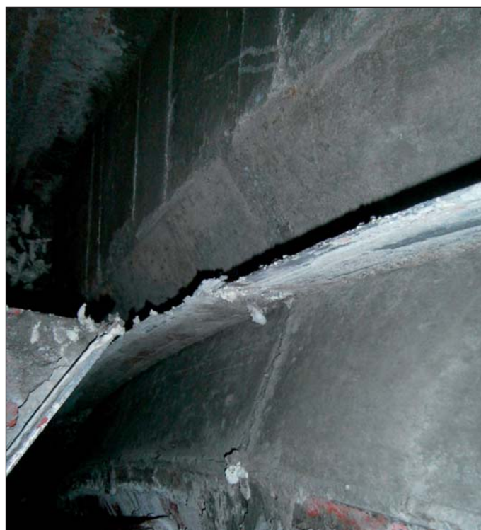
Obr. 3 Detail děleného zazubeného čela klenby po odbednění
