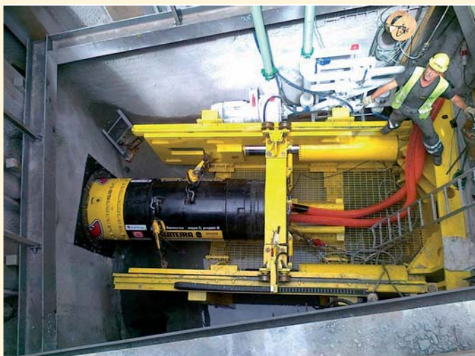
Plzeň - Úslavský sběrač, stroj při zarážení v šachtě (foto Karel Kratochvíl) Plzeň - Úslava river interceptor sewer, the machine launching from the shaft (photo courtesy of Karel Kratochvíl)
