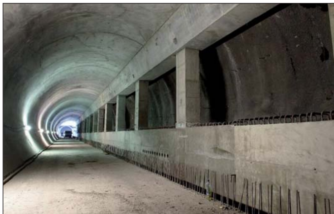
Obr. 5 Dokončené definitivní ostění bočního staničního tunelu (foto Ing. Jiří Junek)
