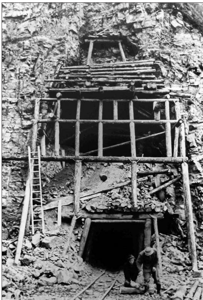
Obr. 1 Portál železničního tunelu vybudovaného v letech 1951–1952 u Štýrského Hradce pomocí rakouské tunelovací metody (foto ÖSTU)
