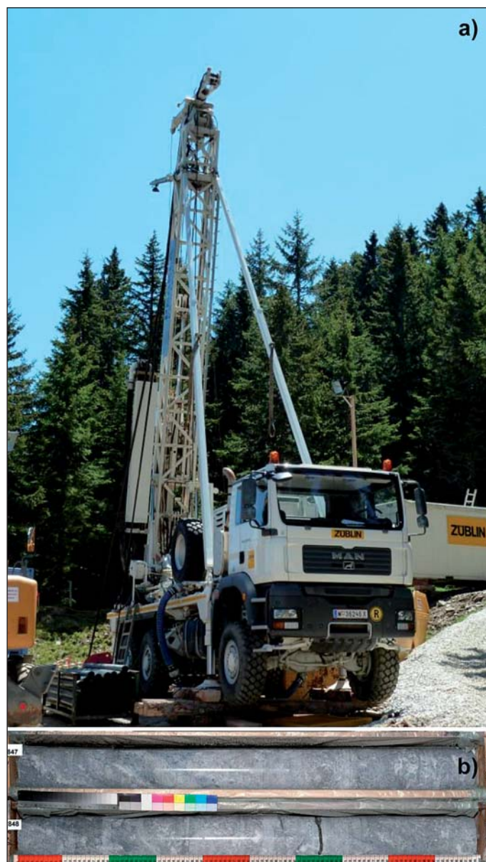
Obr. 4 Jádrové vrtání KB-26/11: a) vrtná souprava; b) jádra z hloubky 847–849 m
