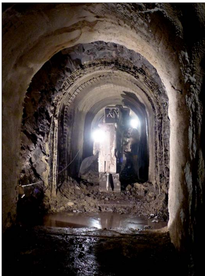
Obr. 4 Fotografie prorážky s razičím strojem SCHAEFF ITC 112 (foto PUDIS a.s.) Fig. 4 Picture of the breakthrough with SCHAEFF ITC 112 tunnelling machine (photo PUDIS a.s.)
