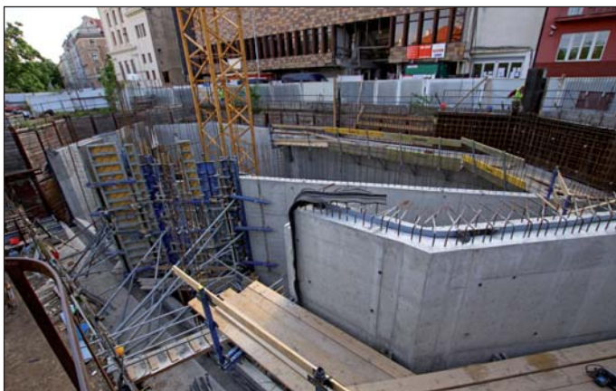
Obr. 5 Výstavba výdechového a nasávacího objektu v ulici Nad Královskou oborou (foto Jakub Karlíček)
