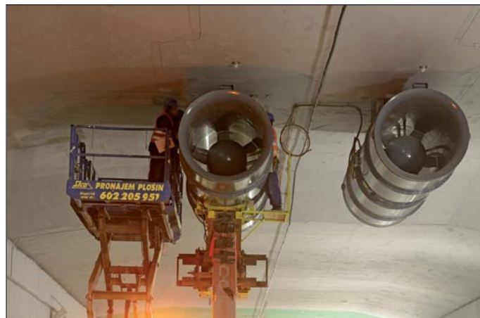
Obr. 2 Montáž ventilátorů v severním hloubeném tunelu (foto Jakub Karlíček)
