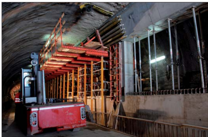
Obr. 7 Vysokozdvíhací vozík s bočním výložníkem a bednění trámu se sloupy Fig. 7 The side forklift and the formwork for the beam and columns
