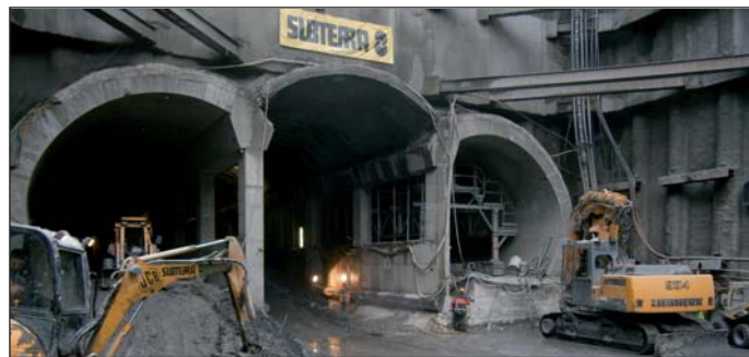
Obr. 11 Portál trojlodní ražené části stanice Nádraží Veleslavín v období ražby středního tunelu (leden 2013)
