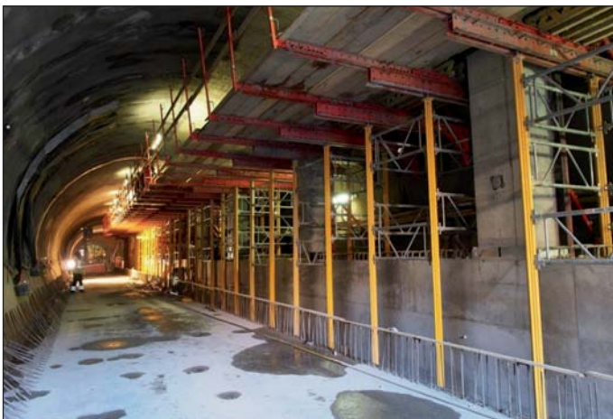
Obr. 3 Bednění trámu definitivního ostění levého staničního tunelu (foto Ing. Jiří Junek)
