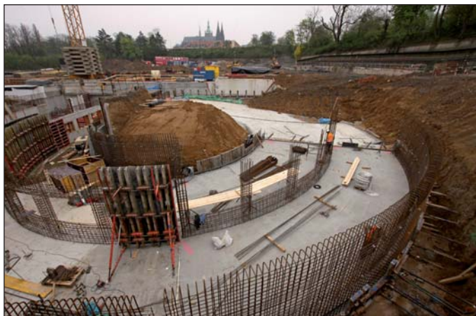
Obr. 1 Výstavba vjezdové rampy podzemních garáží Prašný most (foto Jakub Karlíček)
