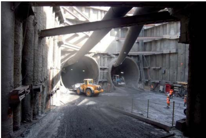
Obr. 1 Ražba bočních staničních tunelů z hloubené jámy Veleslavín (foto archiv Subterra a.s.)
