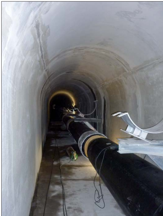
Obr. 5 Fotografie tepelného napáječe v sekundárním ostění při osazování teplovodního potrubí (foto PUDIS a.s.)
