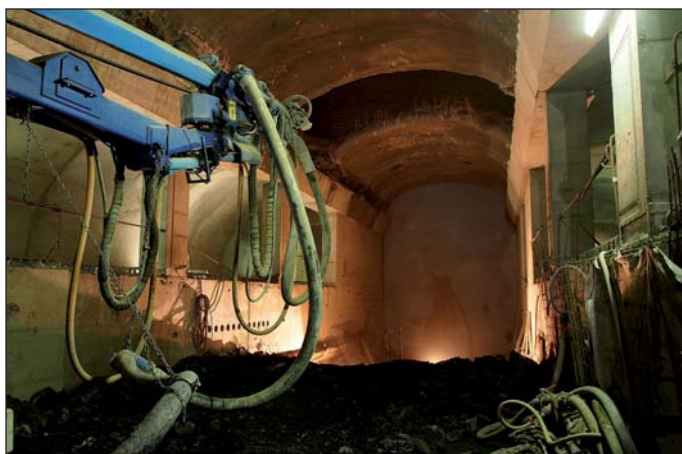
Obr. 9 Pohled do středního tunelu po zahájení ražby dna, nahoře zaústění únikového objektu (únor 2013)
