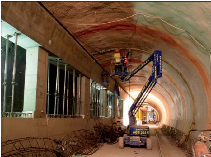
Obr. 4 Provádění stříkané hydroizolační membrány v klenbě pravého tunelu (září 2012)
