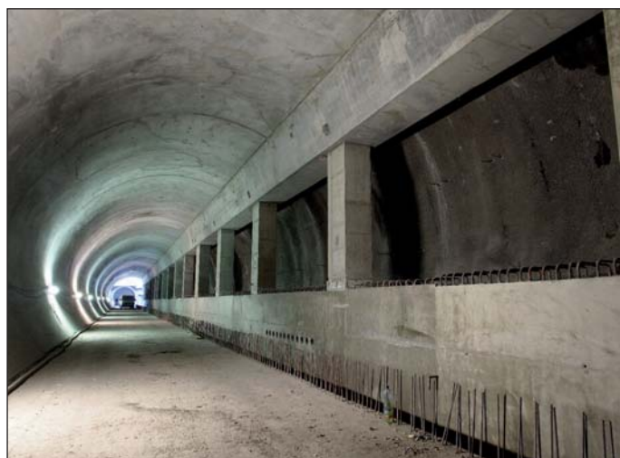
Obr. 6 Definitivní ostění pravého staničního tunelu po dokončení (listopad 2012)
