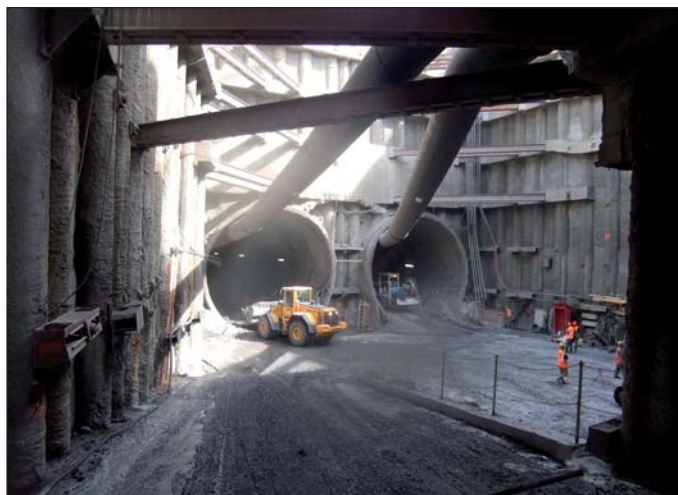
Obr. 1 Portál ražené části stanice v průběhu ražeb levého a pravého tunelu (září 2011)
