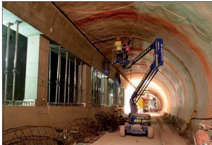
Obr. 4 Stříkaná izolace klenby s barevným odlišením zesílených partií v místě pracovních spár (foto Ing. Jiří Junek)
