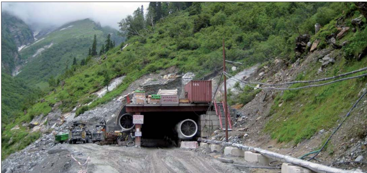
Obr. 8 Jižní portál tunelu Rothang
