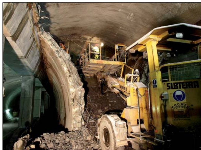
Obr. 8 Mobilní pracovní plošina NORMET při práci na čelbě kaloty středního výrubu (prosinec 2012)
