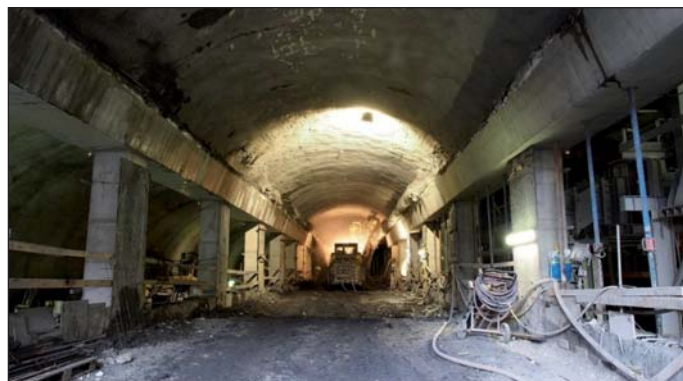
Obr. 6 Ražba kaloty středního tunelu, bourání částí primárního ostění bočních výrubů (foto Ing. Jiří Junek)
