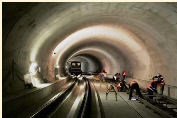
Metro V.A., tunel obrátových kolejí stanice Nemocnice Motol (foto Josef Husák)
