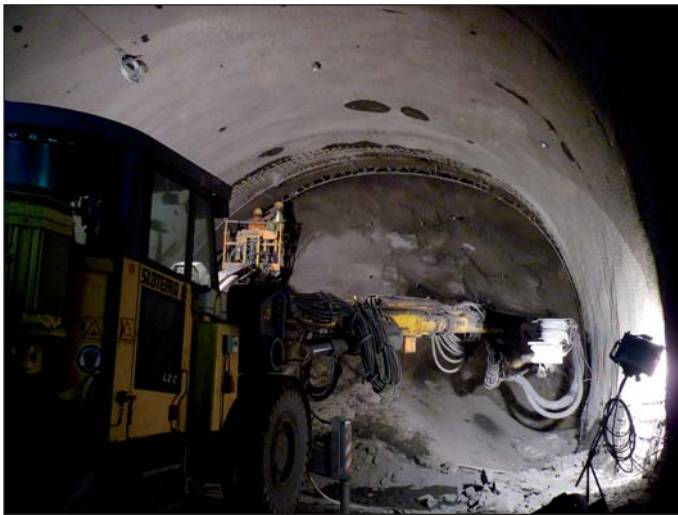
Obr. 2 Injektáž samozávrtných jehel z plošiny vrtacího stroje na čelbě kaloty levého výrubu
