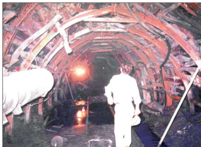
Obr. 2 Typická ocelová výstroj s dřevěnými pažinami na stavbě železničního tunelu South Link na Tchaj-wanu, 1986 (foto W. Schubert)
