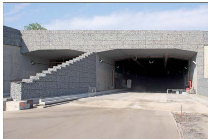
Obr. 6 Portál tunelů hlavní trasy v Troji (foto Jakub Karlíček)
