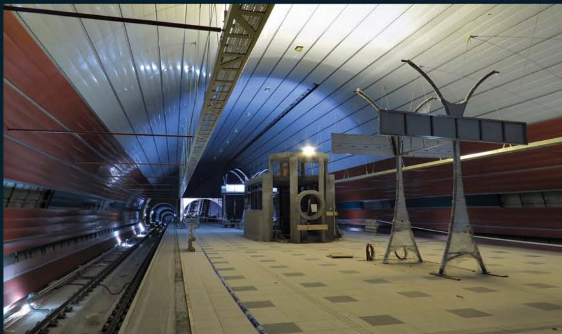
Prodloužení trasy A pražského metra, jednolodní stanice Petřiny před dokončením 07/2014
