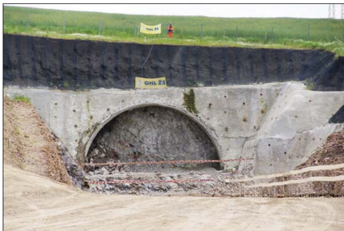
Obr. 1 Čelba tunelu před prorážkou Fig. 1 Tunnel excavation face before the breakthrough
