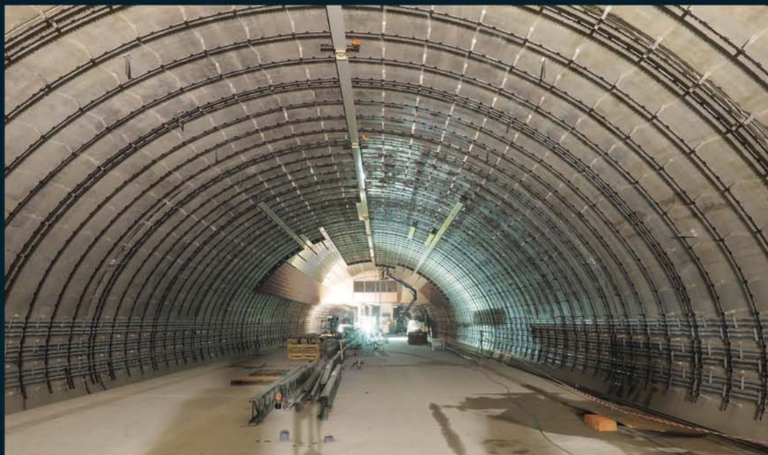
Prodloužení trasy A pražského metra, jednolodní stanice Bořislavka před dokončením 07/2014
