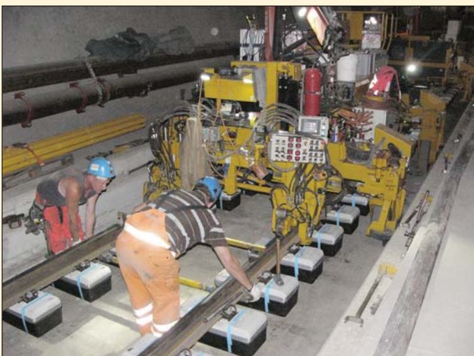
Obr. 2 Montáž pevné jízdní dráhy v Gotthardském bázovém tunelu Fig. 2 Slab track installation in the Gotthard Base Tunnel
