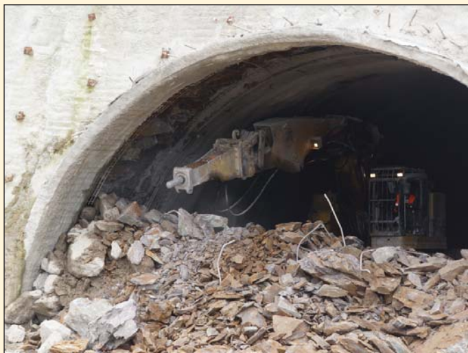
Obr. 1 Prorážka železničního tunelu Sudoměřice Fig. 1 Sudoměřice railway tunnel breakthrough
