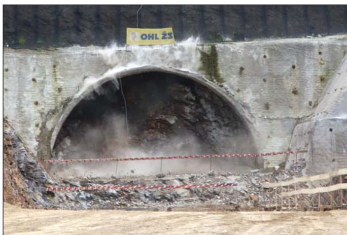
Obr. 3 Odpal posledního záběru Fig. 3 Last excavation round blasting
