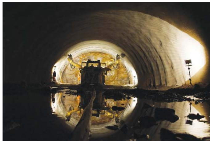
Obr. 2 Ražba posledních metrů tunelu Fig. 2 Excavation of the last metres of the tunnel
