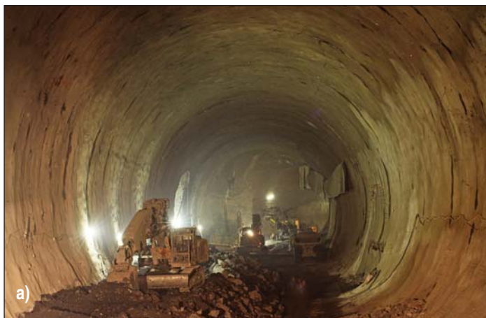
Obr. 7 Porovnání prostoru strojovny po jejím vyražení a v definitivním stavu Fig. 7 Comparison of the ventilation plant cavern space after the excavation and in the definite state
