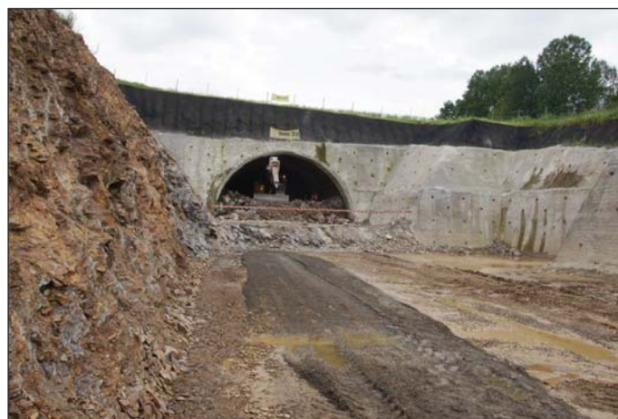
Obr. 4 Celkový pohled na severní portál Fig. 4 Overall view of the northern portal
