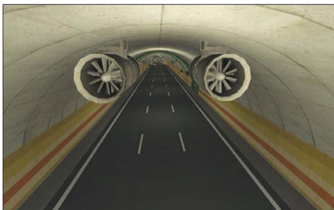
Obr. 4 Ventilátory zavěšené pod stropem tunelu Fig. 4 Fans suspended from the tunnel ceiling
