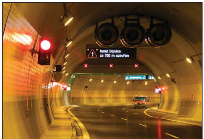
Obr. 6 Dvoupruhový tunel pod Letnou a Stromovkou Fig. 6 The double-lane tunnel under Letná and Stromovka Park
