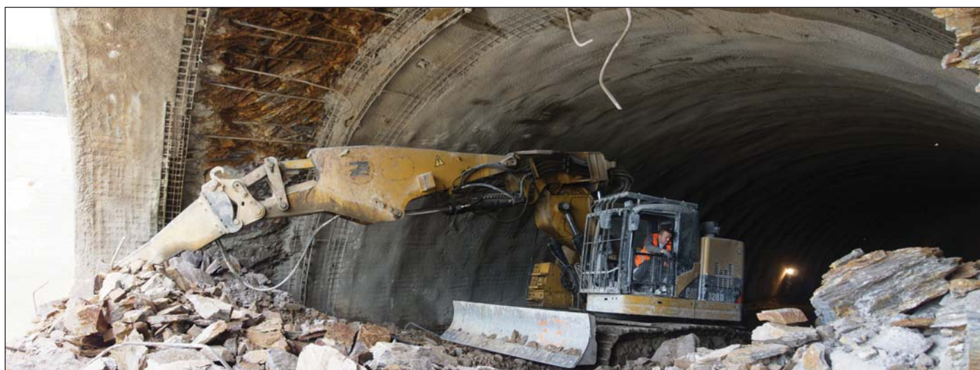
Obr. 5 Dočištění lince výrubu Fig. 5 Excavation surface scaling
