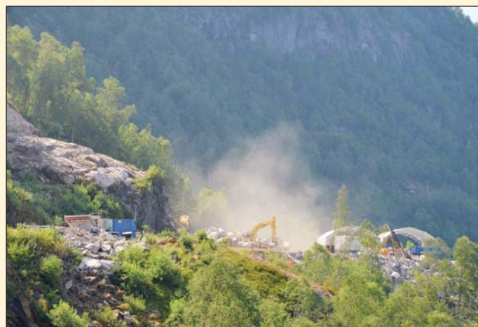
Obr. 1 Příprava severního portálu pro zahájení ražeb
