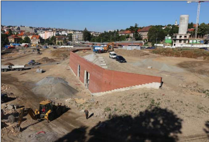
Obr. 1 Hrubé terénní úpravy budoucího parku a nadzemní část TGC1 Fig. 1 Bulk excavation for a future park and the above-ground part of the TGC1 services structure
