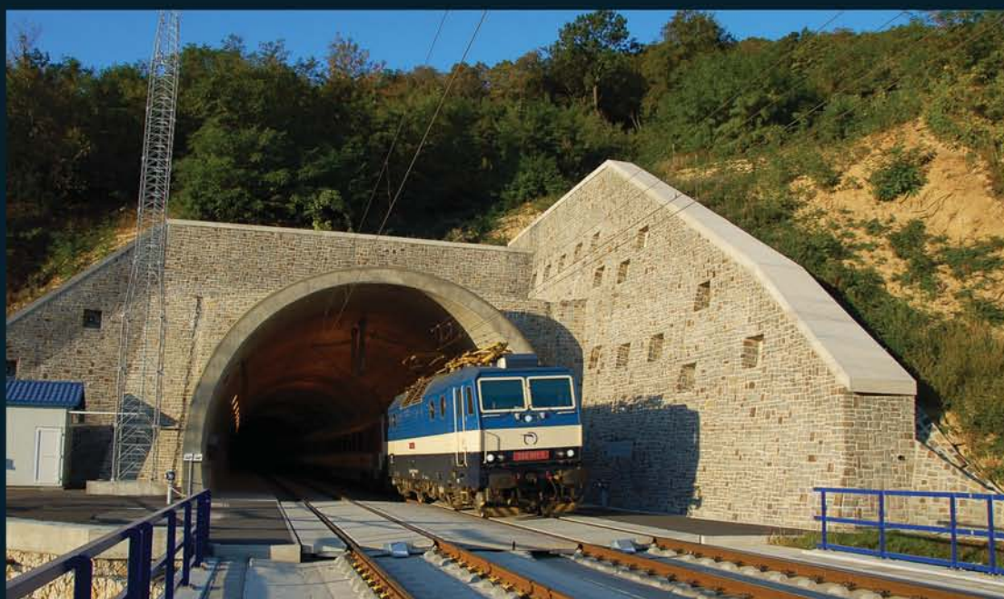
Železniční tunel Turecký Vrch, Slovenská republika
