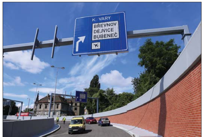
Obr. 4 Portály značení nad výjezdovou rampou křižovatky U Vorlíků Fig. 4 Portals – marking above the exit ramp at U Vorlíků intersection
