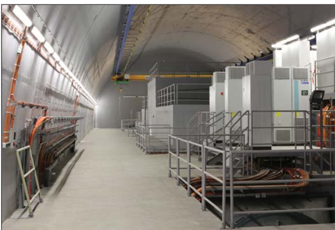
Obr. 5 Horní podlaží ražené strojovny vzduchotechniky TGC 4 pod Letnou Fig. 5 Upper floor of the mined ventilation plant cavern at the TGC 4 service structure under Letná
