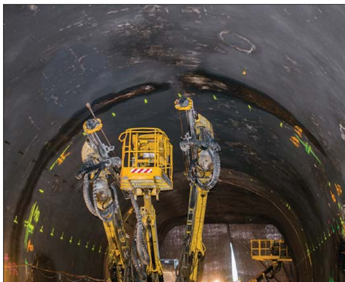
Obr. 6 Vrtná souprava při provádění vrtů pro cementovou injektáž Fig. 6 Drilling set during the execution of drillholes for cement grouting
