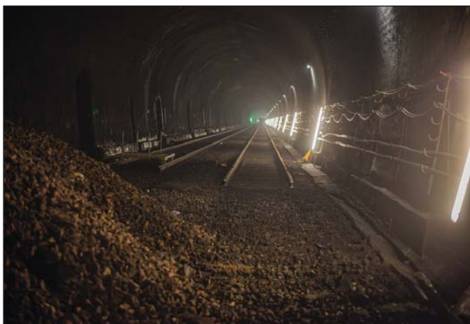
Obr. 5 Pohled do tunelu v době demontáže kolejového svršku Fig. 5 A view down the tunnel at the time of dismantling the trackwork
