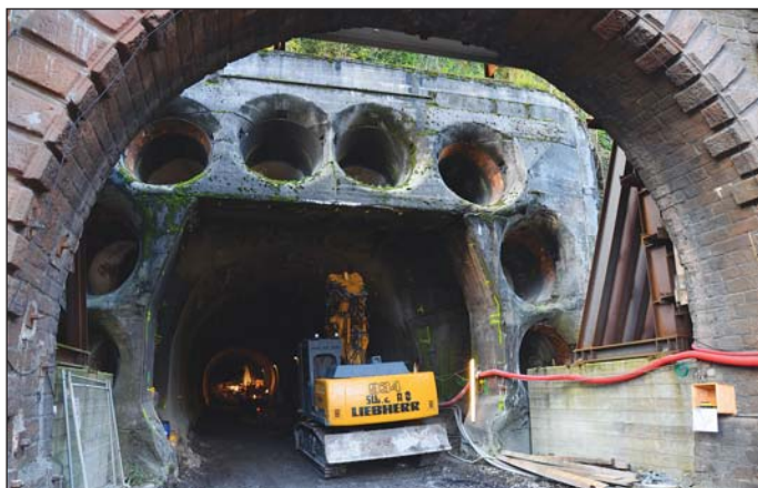
Obr. 5 Rekonstrukce AKWT, pohled na otvory po větracích turbínách Siemens-Bentz
