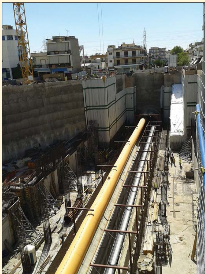
Obr. 3 Výstavba hloubené stanice Agia Varvara Fig. 3 Construction of Agia Varvara station
