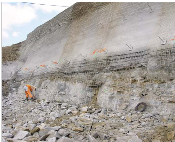
Obr. 1 Polohy hrubo lavičovitých pieskovcov kežmarských vrstiev v oblasti západného portálu
