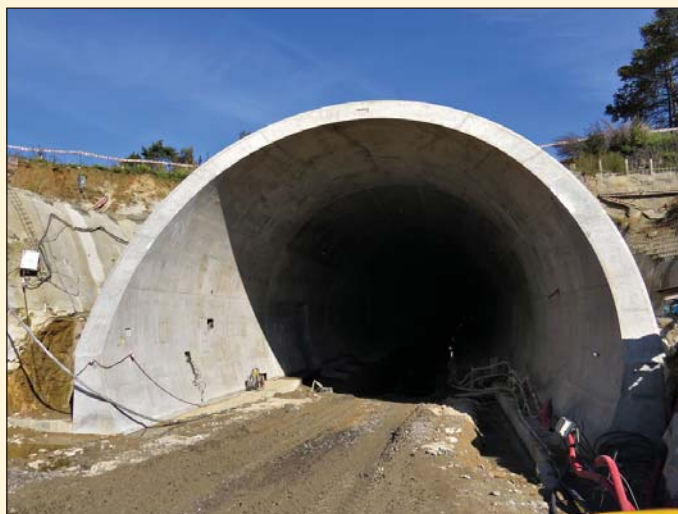
Obr. 2 Jižní portál tunelu Sudoměřice (foto Ing. Marián Chotár) Fig. 2 Southern portal of the Sudoměřice tunnel (photo Ing. Marián Chotár)
