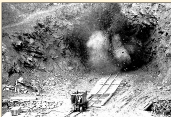
Obr. 1 První odpal na vodovodním přivaděči z Želivky do Prahy (září 1964) Fig. 1 The first blast for the excavation of the aqueduct tunnel from the Želivka to Prague (September 1964)
