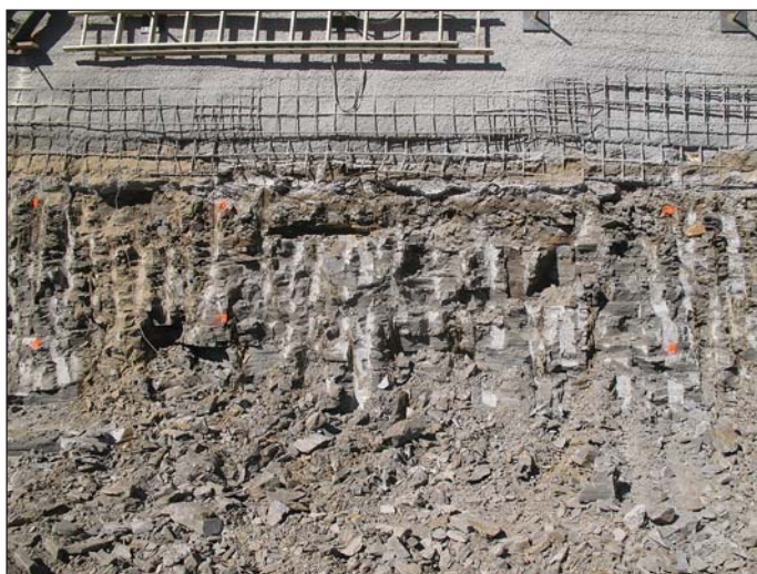
Obr. 2 Tenko doskovité až doskovité ílovce až siltovce, zubereckého súvrstvia v oblasti východného portálu
