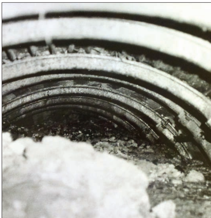
Obr. 5 Detail závalu ve štolě stoky „P“ (1981)
