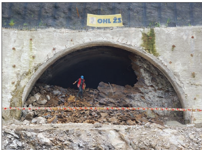
Obr. 6 Proražená kalota na severním portále Fig. 6 Top heading broken through at the northern portal
