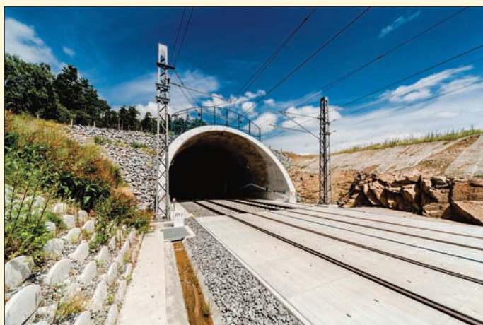
Obr. 5 Modernizace traťového úseku Votice – Benešov u Prahy (2009–2013) Fig. 5 Modernisation of the Votice – Benešov u Prahy track section (2009–2013)
