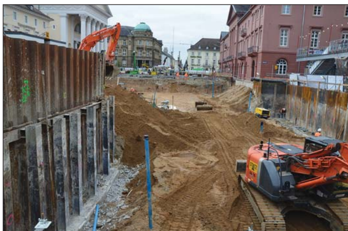
Obr. 1 Stavba podzemní tramvaje v Karlsruhe, výstavba hloubené stanice Marktplatz
