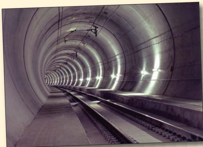
Obr. 12 NEAT Lötschberský bázový tunel. 2007. BLS AG [sbírka autorů] Moderní fotopohlednice potvrzující, že i prostý pohled do prostoru železničního tunelu může působit velmi dynamicky.
