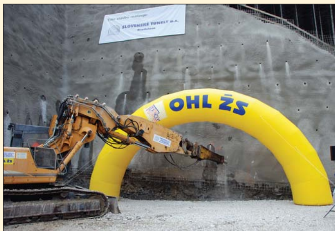
Obr. 2 Tunel Čebrať, zahájenie razenia, východný portál Fig. 2 Čebrať tunnel – commencement of tunnelling, eastern portal
