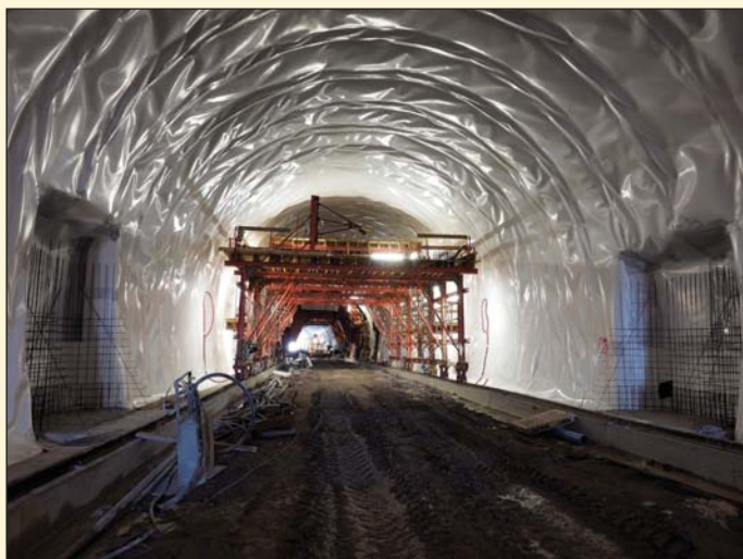
Obr. 1 Izolace v tunelu Sudoměřice (foto Ing. Marián Chotár) Fig. 1 Sudoměřice tunnel waterproofing (photo Ing. Marián Chotár)
