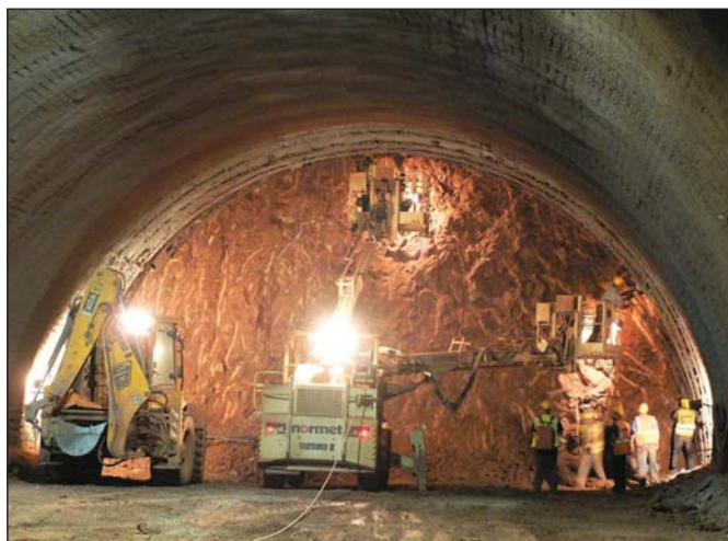
Obr. 7 Ukázka čelby v pravé tunelové troubě (TM 190 478,8)
