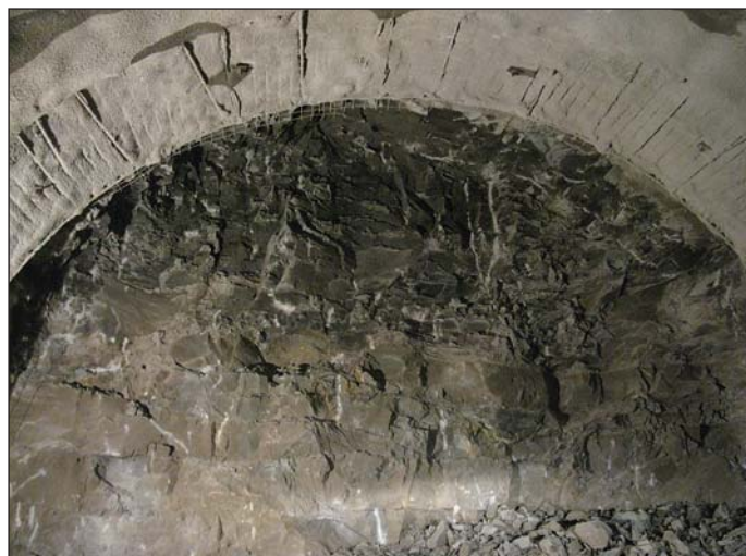
Obr. 3 Prechod masívnych pieskencov (spodná časť) do tenko doskovitých ílovcov v staničení 340,0 m v severnej tunelovej rúre
