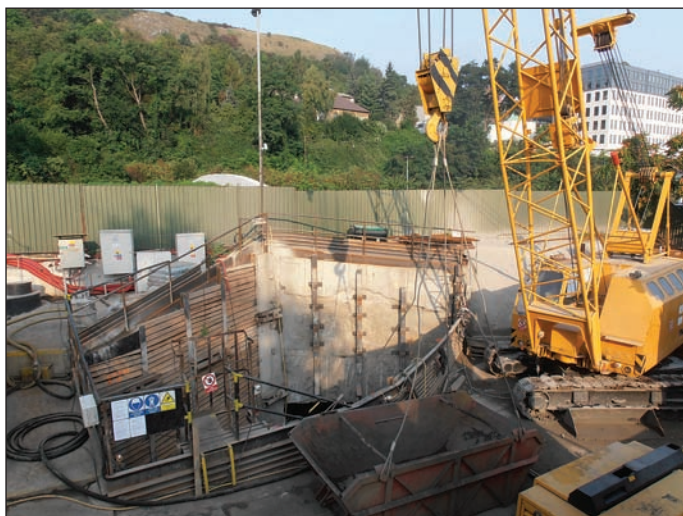
Obr. 9 Fotografie zařízení staveniště průzkumné štoly s těžní šachtou a jeřábem RDK 300-1, v pozadí na horizontu vrch Dívčí hrady s přírodní památkou Čtítad
