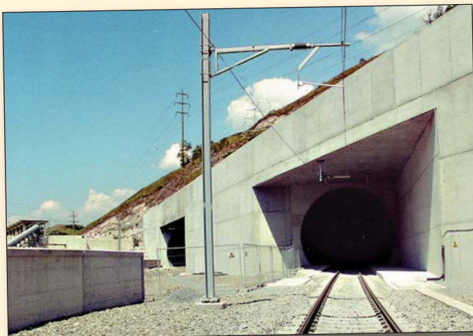
Obr. 11 NEAT Lötschberský bážový tunel. 2007. BLS AG [sbírka autorů] Krásné moderní portály vyúsťující na jižní straně Lötschberského masivu u Raronu na most přes řeku Rhônu. Ze zobrazeného úhlu pohledu se jeví konstrukce až kubisticky.
