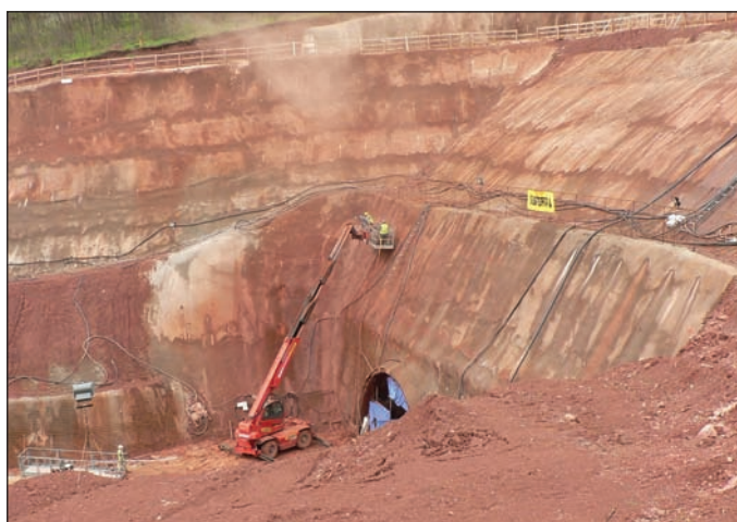
Obr. 6 Ukázka vrtání SN kotev pomocí vysokozdvížných plošin
