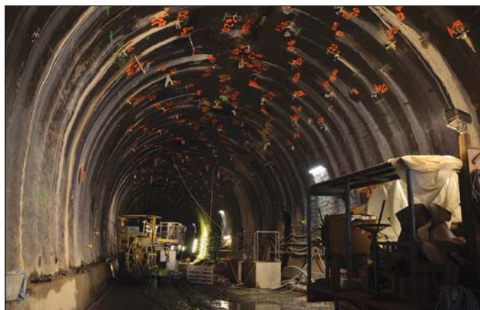
Obr. 6 Rekonstrukce AKWT, pohled na proinjektované přístupí
