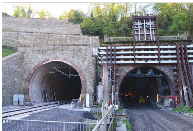
Obr. 4 Rekonstrukce starého tunelu císaře Wilhelma (AKWT) v Cochemu, pohled na nový a starý portál
