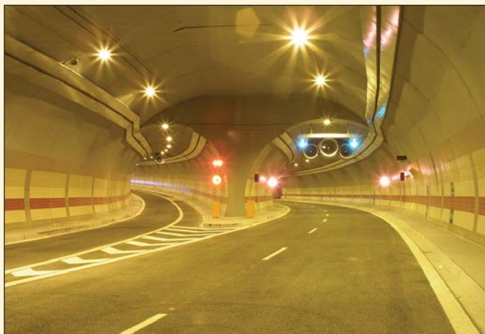
Obr. 4 Výstavba tunelu Mrázovka, Praha (1998–2004) Fig. 4 The Mrázovka tunnel construction (1998–2004)
