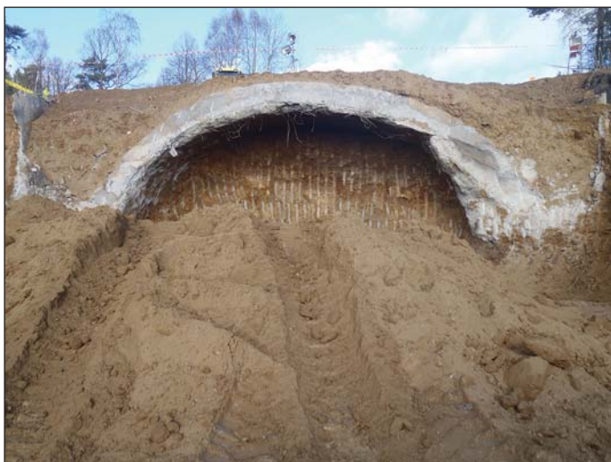
Obr. 2 Zahájení prací na jižním portále ve zcela zvětralých rulách Fig. 2 The commencement of the work on the southern portal in completely weathered schist
