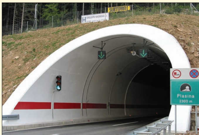
Obr. 6 Výstavba tunelu Plasina, Chorvatsko (2002–2004) Fig. 6 Construction of the Plasina tunnel, Croatia (2002–2004)
