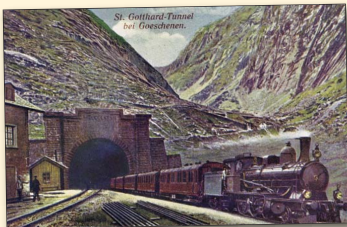
Obr. 3 St. Gotthard – Tunel u Göschenen. ?? Wanderer-Serie No. 7/5. St. Gotthardbahn [sbírka autorů]
