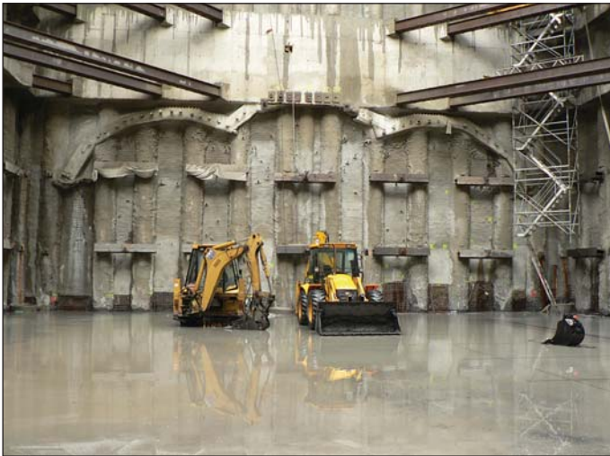
Obr. 4 Stavební jáma s portálem pro zahájení ražby stanice Nádraží Veleslavín
