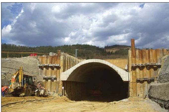
Obr. 2 Západní portál, severní tunel po vyražení kaloty a jádra
