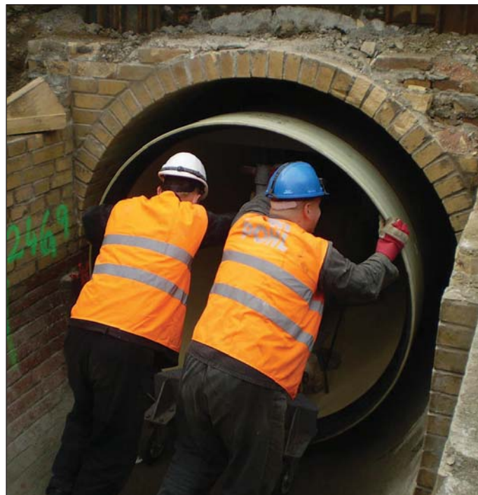
Obr. 12 Zavážení trubek GRP – Troja Fig. 12 Transporting GRP tubes – Troja
