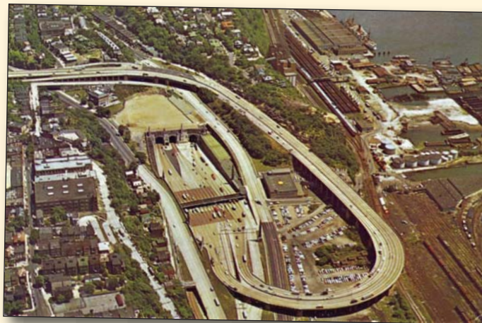
Obr. 9 Vstup do Lincolnova tunelu, vstup v New Jersey do jediného světového třítrobového automobilového tunelu
