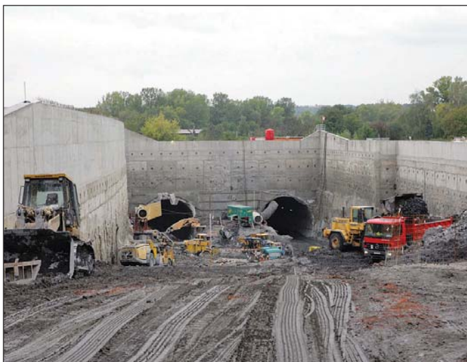
Obr. 2 Stavební jáma Troja – rok 2007
