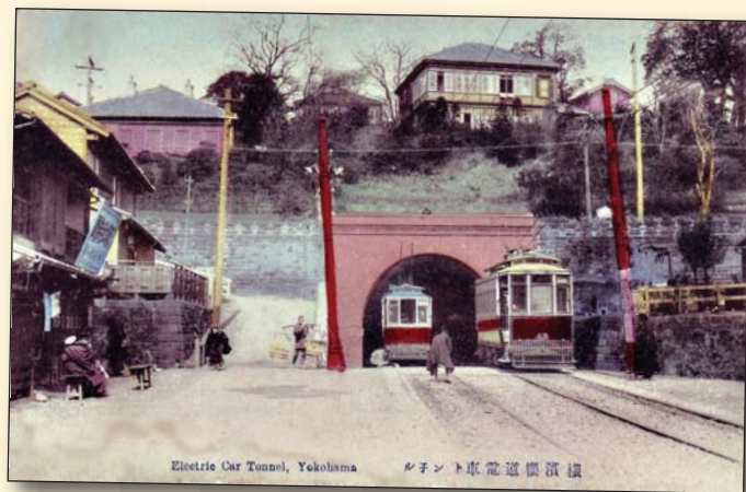
Obr. 3 Tunel elektrické dráhy, Jokohama
