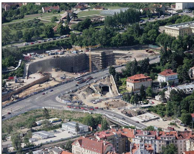
Obr. 6 Jáma Prašný most – rok 2011 Fig. 6 Prašný Most construction pit – 2011
