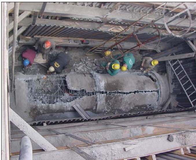
Obr. 3 Odstraňování trubek Vianini v jámě hluboké 10,5 m Fig. 3 Removing Vianini tubes in a 10.5m deep pit
