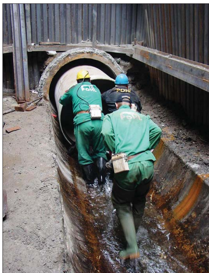
Obr. 8 Zavážení trubek GRP – proplachovací kanál Fig. 8 Transporting GRP tubes into the flushing duct
