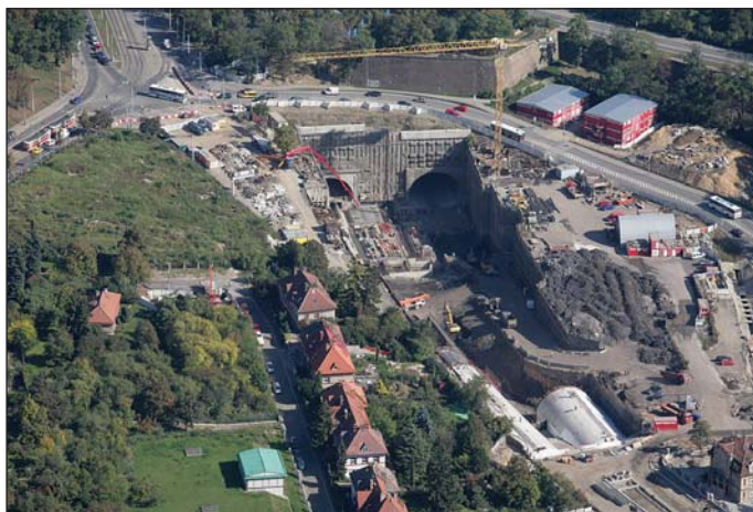
Obr. 8 Jáma Myslbezkova – rok 2011 Fig. 8 Myslbezkova construction pit – 2011
