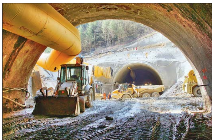
Obr. 5 Střední jáma, jižní tunel, pohled na východ po vyražení kaloty
