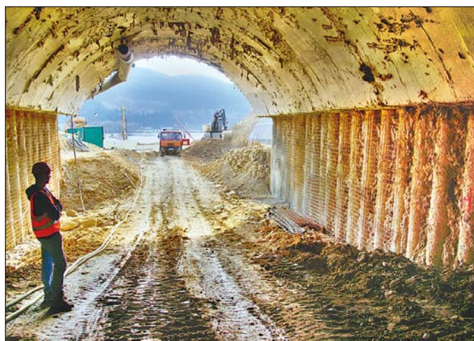
Obr. 3 Západní portál, zajištění klenbou želvy a velkopřůměrovými pilotami
