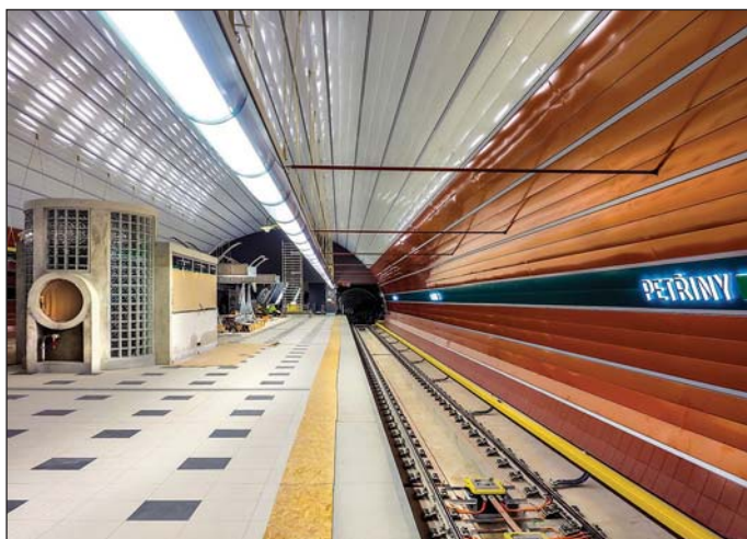
Obr. 5 Nástupiště stanice Petřín Fig. 5 Petřín station platform
