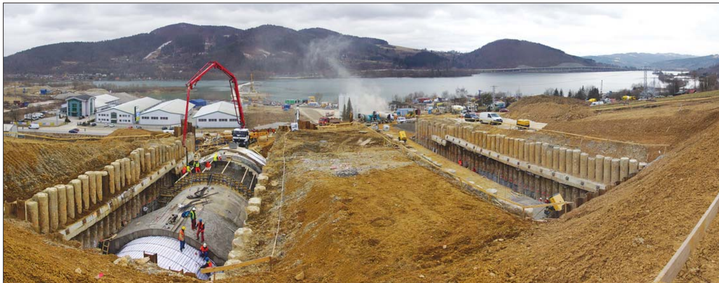
Obr. 1 Západní portál, konstrukce želvy na jižní a severní tunelové troubě
