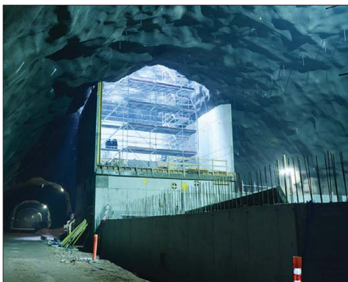
Obr. 3 Betonáž šachty v podzemní kaverně metra Fig. 3 Casting a concrete shaft in the metro underground cavern
