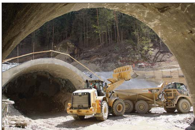
Obr. 4 Střední jáma, severní tunel, pohled na konstrukci želvy (vzdálenost portálů 12,5 m)
