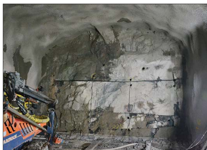
Obr. 4 Prorážka tunelu do stávajícího kolektoru – prořezáno lanem Fig. 4 Tunnel breakthrough into the existing utility tunnel – cut through with a diamond wire saw
