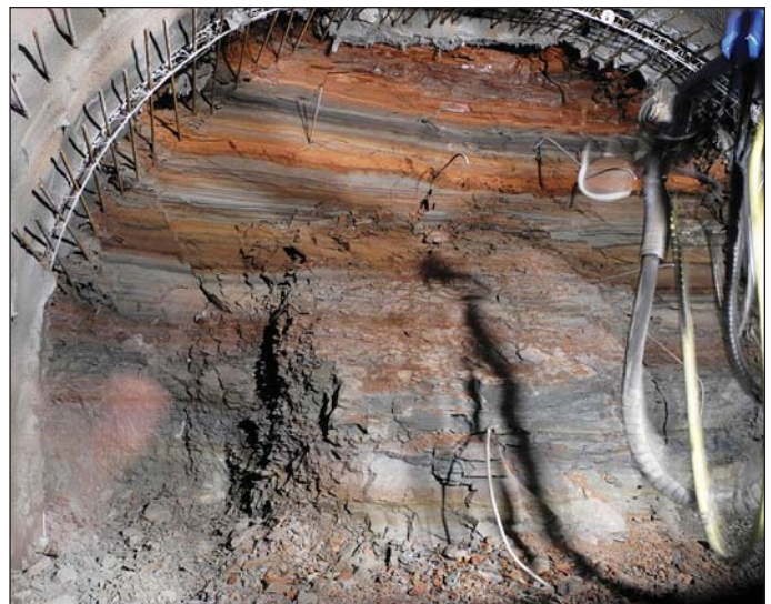
Obr. 5 Příhradové nosníky BTX spolu s jehlami při průchodu vulkanosedimentárních vrstev
