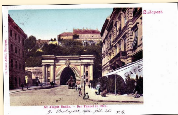
Obr. 1 Budapešť, tunel pod Budou
