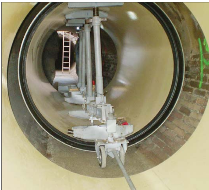
Obr. 11 Trubky GRP před spojením – Troja Fig. 11 GRP tubes before joining – Troja
