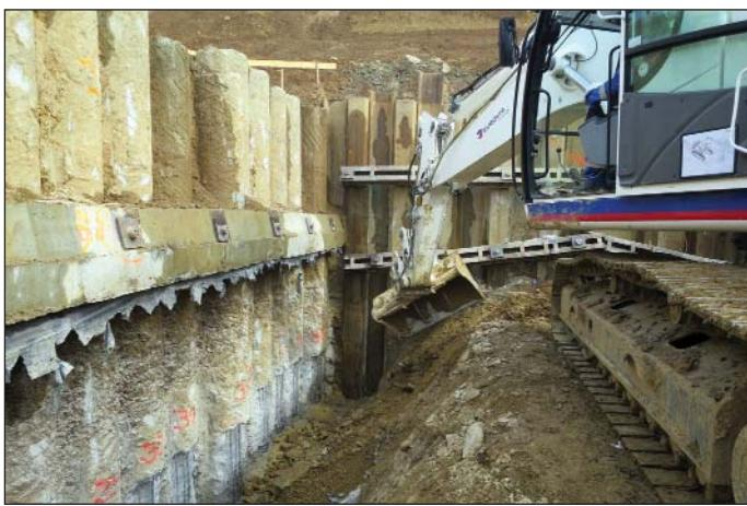
Obr. 7 Tvarování dna jámy pro betonáž želvy
