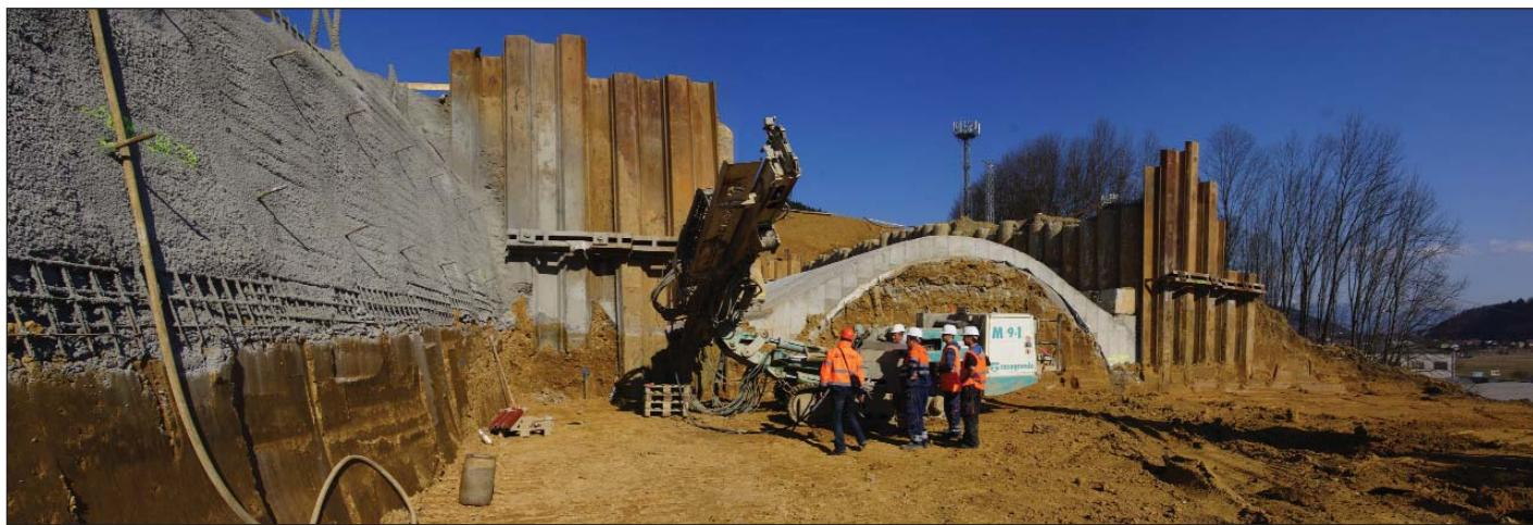
Obr. 5 Zajištění čela jámy štětovnicovou stěnou
