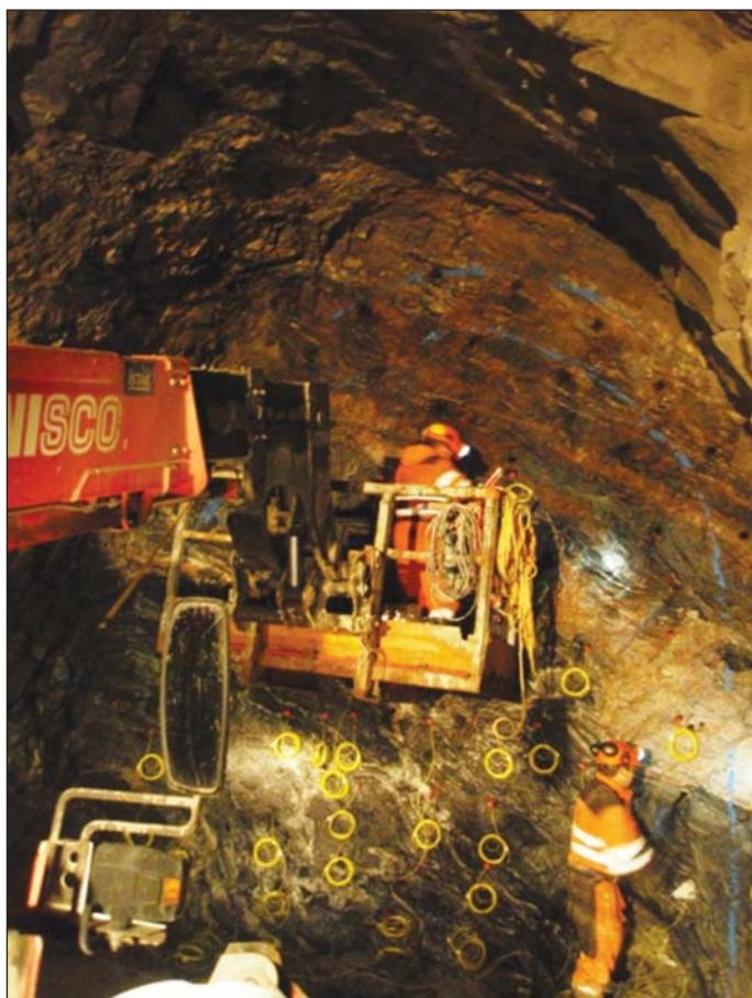
Obr. 10 Nabíjanie vývrtov v čelbe prepojovacieho tunela
