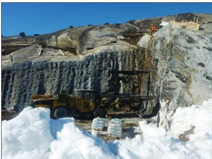
Obr. 9 Zaistovanie portálu hlavnej vpusťe
