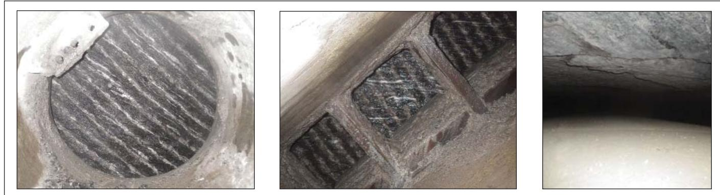
Obr. 6 Fotografická dokumentace čelby skrze otvory v řezné hlavě, tj.“Mannloch“, otvory začišťovacích dlát, a dále mezery mezi segmentovým prstencem a horninou v klenbě
