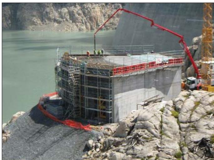
Obr. 7 Výstavba vtokovo-výtokového objektu
