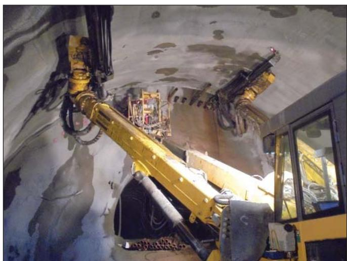
**Obr. 6 Vŕtanie mikropilotového dáždnika v severnej tunelovej rúre (východný portál)**
