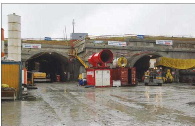
Obr. 2 Portály tunelu Žilina s konstrukcí želvy
