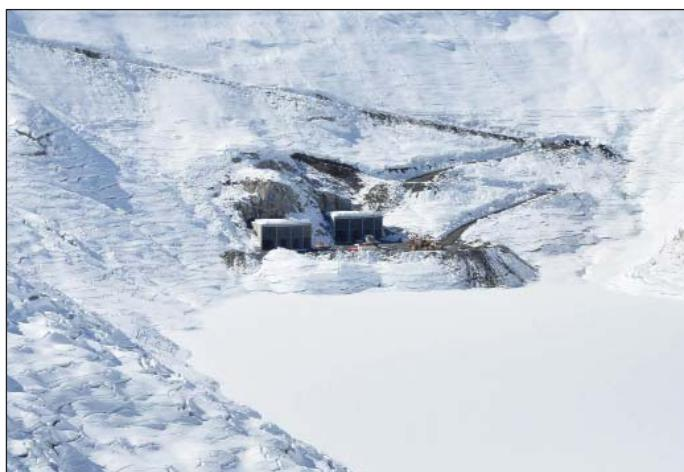
Obr. 8 Jar 2013,oba vtokovo-výtokové objekty naplavene a ulozene na pripravenych betonových prahoch, hladina vody v jazere Emosson je vypustená na minimum
