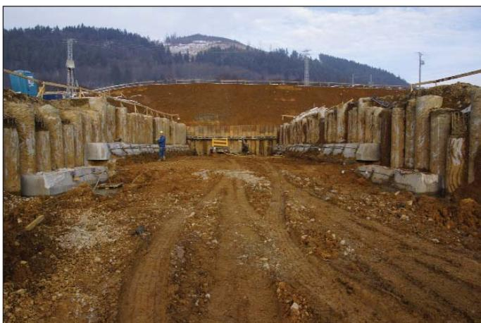
Obr. 6 Odtěžení stavební jámy do úrovně převázek
