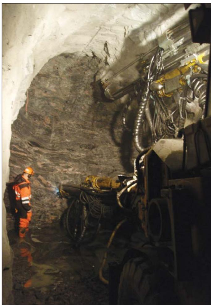
Obr. 6 Vŕtanie vývrtov vo vstupnom servisnom tuneli
