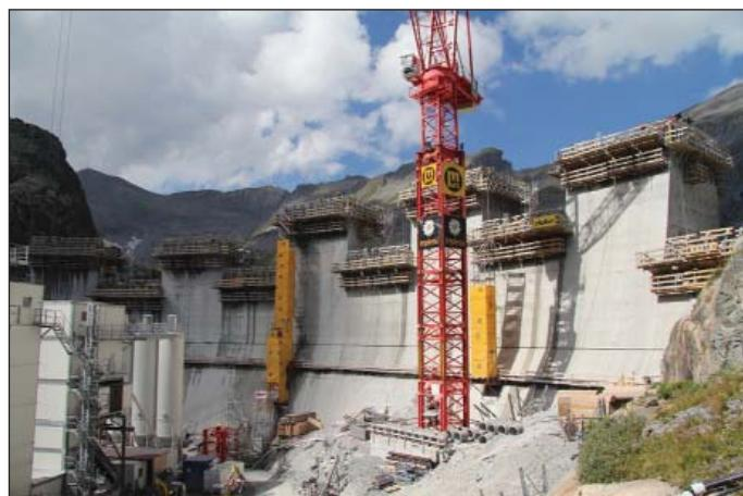
Obr. 13 Zariadenie staveniska pod päto hrádze Vieux-Emosson, ktorej oporný mûr sa navýšuje o 23 m
