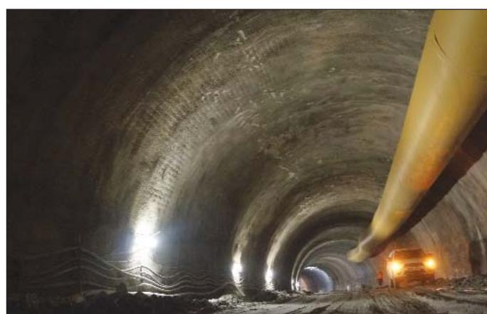
Obr. 3 Primární ostění tunelu Ovčiarisko
