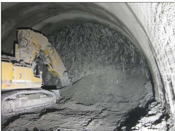
Obr. 4 Mechanické profilovanie tunelbagrom
