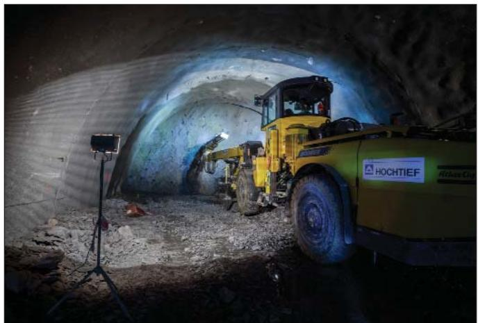
Obr. 5 Vŕiaci voz Atlas – Copco Rocket Boomer E2C
