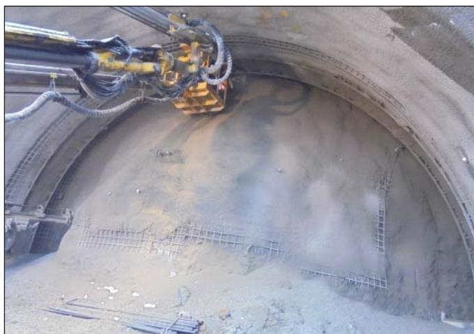
Obr. 8 Zaistovanie čelby IBO kotvami
