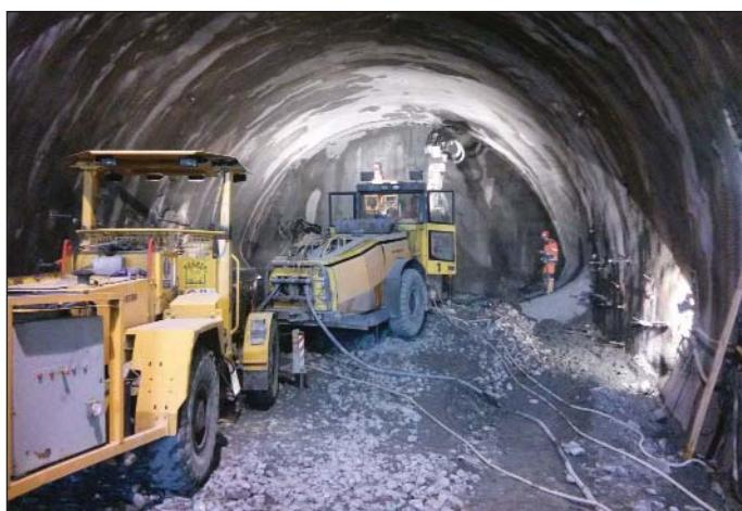
Obr. 4 Realizácia IBO dáždnika
