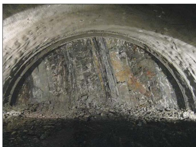
Obr. 4 Čelba kaloty cestného tunela Laliki
