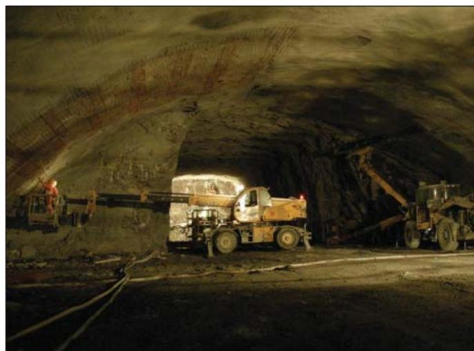
Obr. II Raziace a zaistenovacie práce kaloty strojovej kaverny KMA
