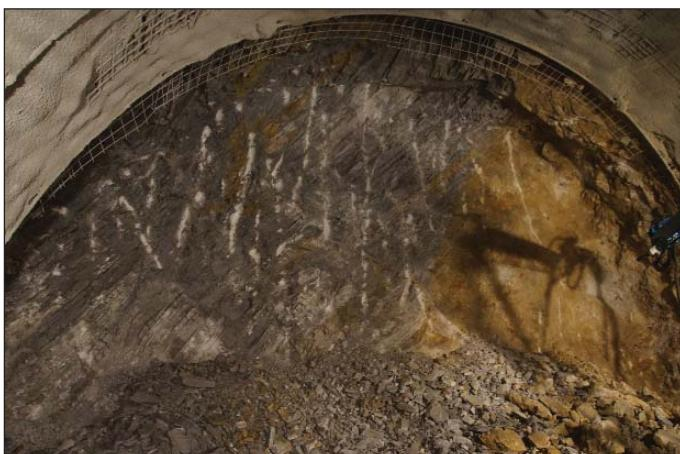
Obr. 19 Skloný diskontinuita na čelbě
