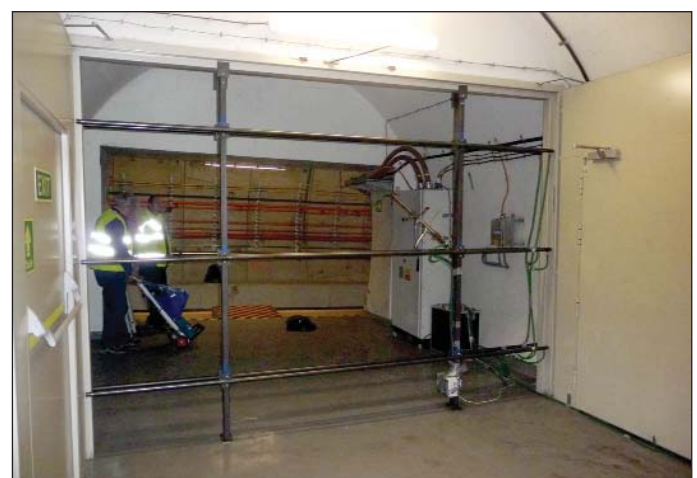
Obr. 2 Rozmístění měřicí mříže pro měření dynamického tlaku, vrtulkového anemometru, termoanemometru pro měření rychlosti proudění vzduchu v průřezu požárního vrat v tunelové propojce 2.4
