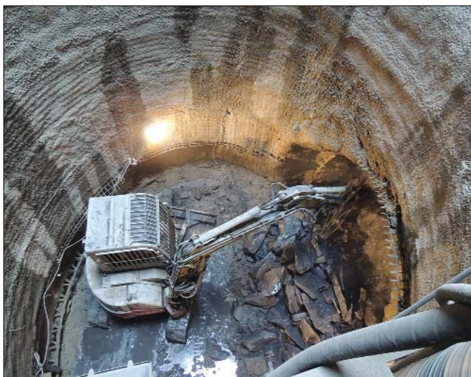
Obr. 4 Zarážka štoly pod ochranou deštníku z jehel
