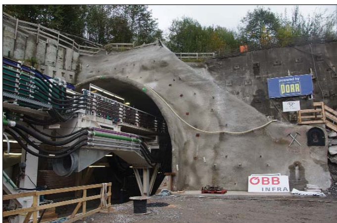
Obr. 2 Portál tunelu raženého TBM Fig. 2 Portal of the TBM-driven tunnel
