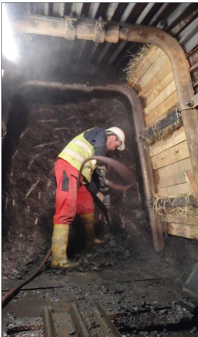
Obr. 7 Ražba ve zdravých jílovitých břidlicích Fig. 7 Tunnel excavation in fresh shale
