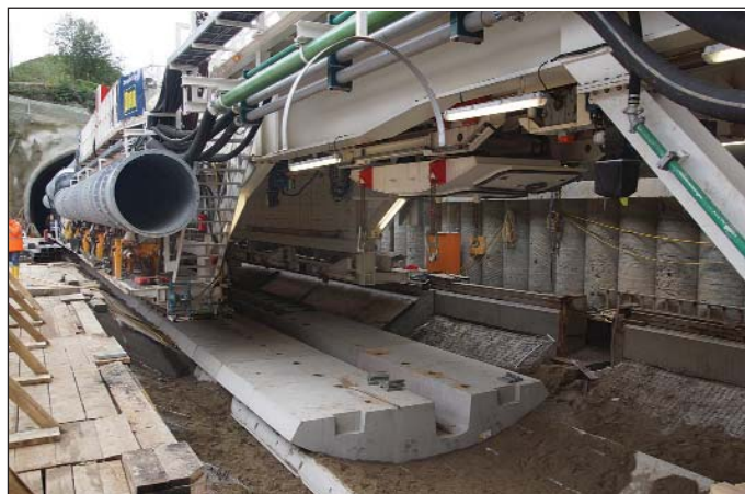
Obr. 3 Prefabrikovaný díl ostění v počvě tunelu Fig. 3 Pre-cast segment of the tunnel invert
