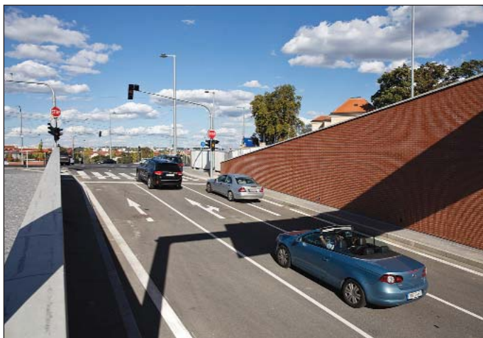
Obr. 5 První minuty provozu v tunelovém komplexu Blanka Fig. 5 Initial minutes of traffic in the Blanka complex of tunnels
