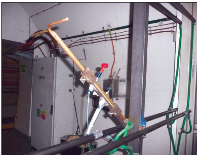
Obr. 3 Rozmístění Prandtlových sond pro měření statického tlaku, vrtulkového anemometru, termoanemometru pro měření rychlosti proudění vzduchu v průřezu požárních vrat v tunelové propojce 2.4
