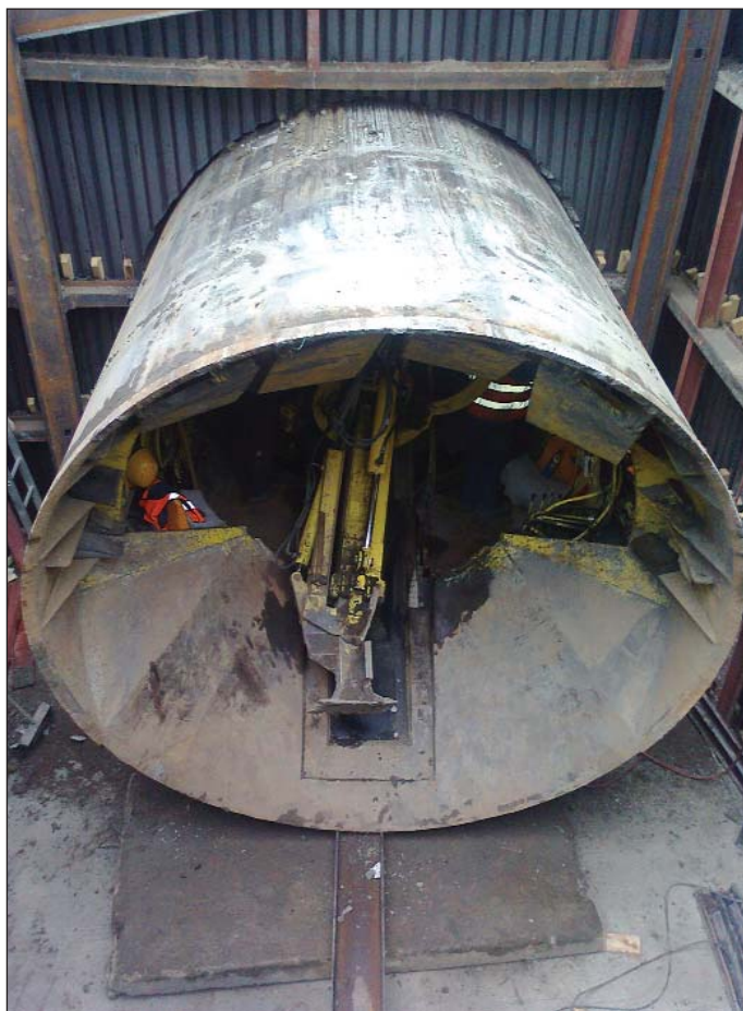
Obr. 6 Vyjetí štítu do koncové šachty ŠA-I-10 Fig. 6 The shield exiting to the end shaft ŠA-I-10
