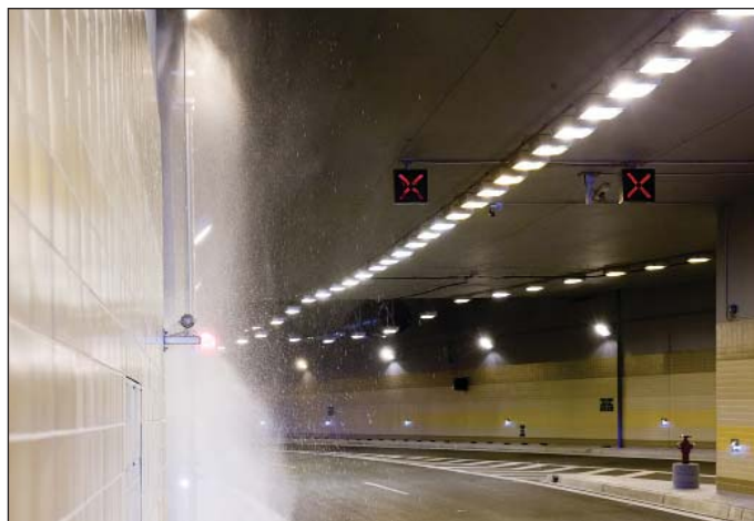
Obr. 2 Komplexní zkoušky v Brusnickém tunelu Fig. 2 Comprehensive tests in the Brusnice tunnel
