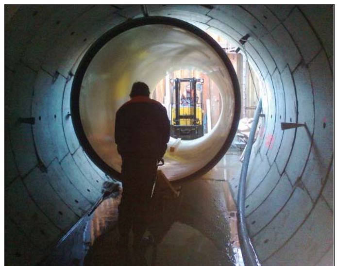
Obr. 7 Zavážení potrubí HOBAS DN 2400 do štoly Fig. 7 Transport of HOBAS tubes DN 2400mm to the gallery
