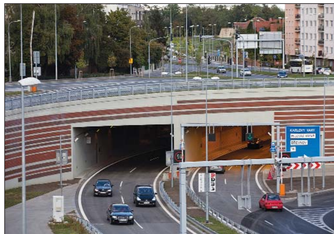
Obr. 6 První minuty provozu v tunelovém komplexu Blanka Fig. 6 Initial minutes of traffic in the Blanka complex of tunnels
