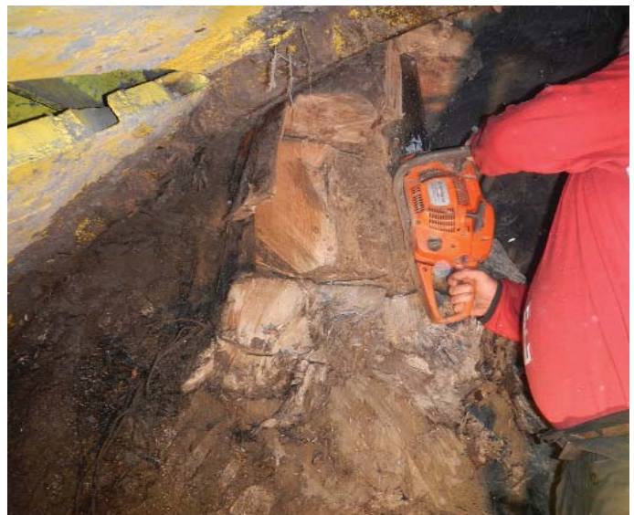
Obr. 5 Odstraňování překážky (kmene stromu) v čelbě štoly Fig. 5 Removing an obstacle (tree trunk) at the excavation face
