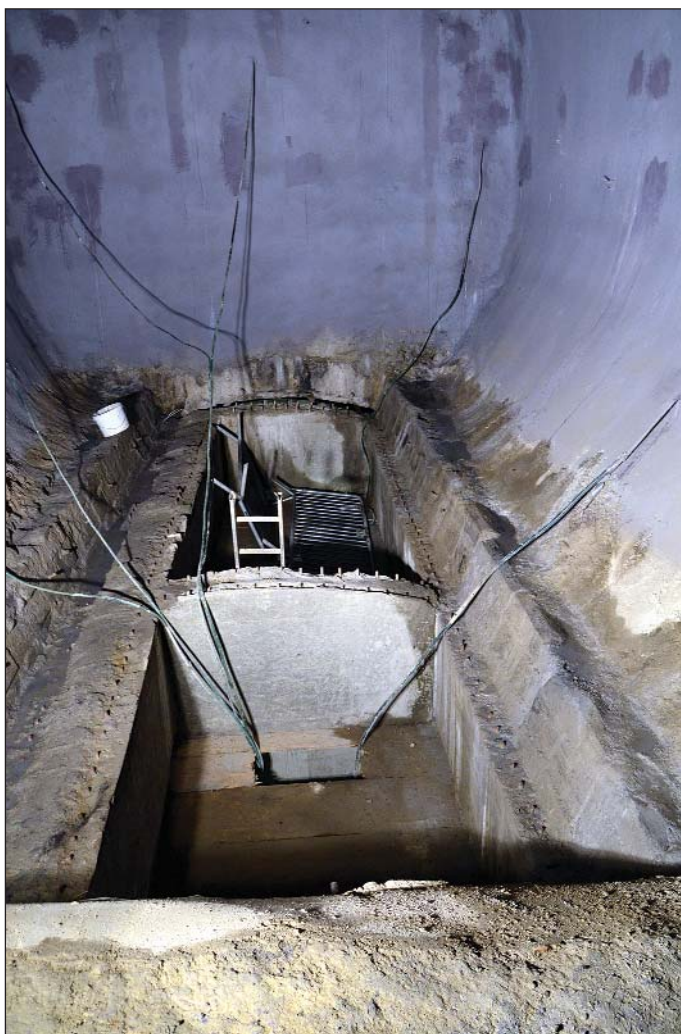
Obr. 7 Šachta Š3 v průběhu provádění stříkané hydroizolace, ze stěn jsou svedeny organizované svody na nástupiště
