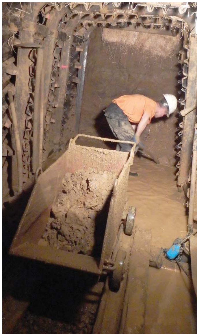
Obr. 8 Ražba v tektonicky porušených břídlích a náplavách Fig. 8 Tunnel excavation in deposits
