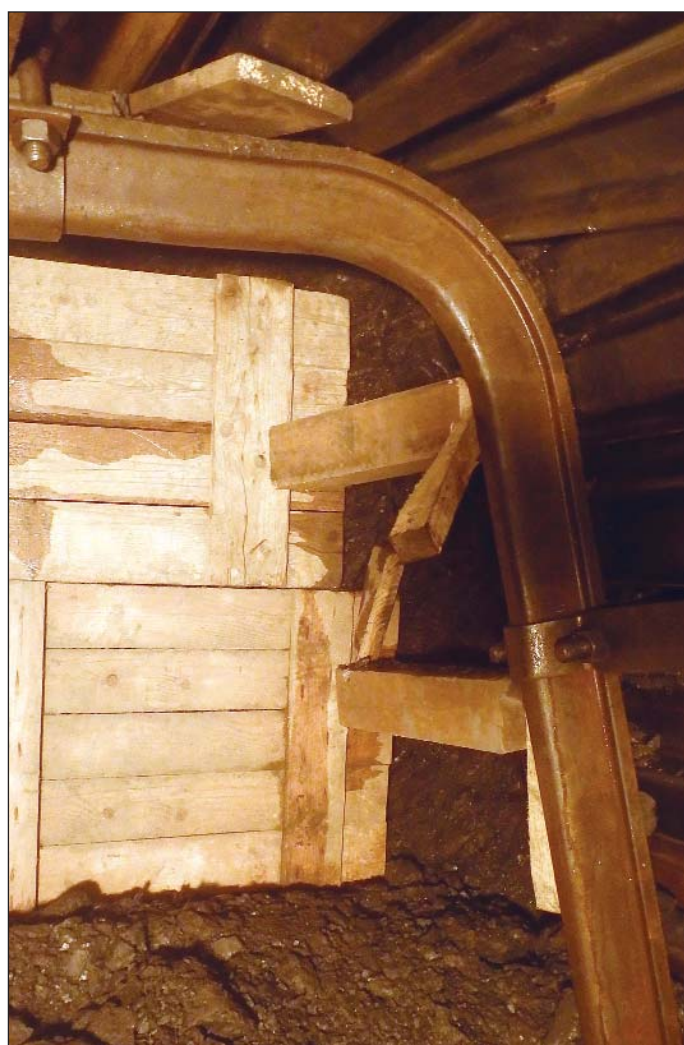
Obr. 10 Čílkování pomocí dřevěných bukových fošentl. 40 mm a hranolů 120x120 mm
