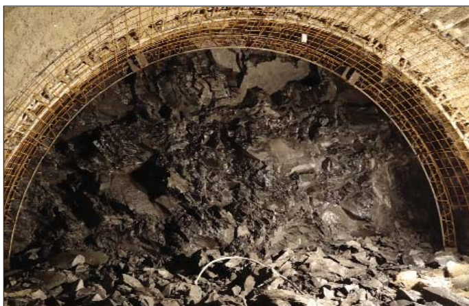
Obr. 5 Čelba kaloty přestupní chodby (šířka výrubu 5,9 m)
