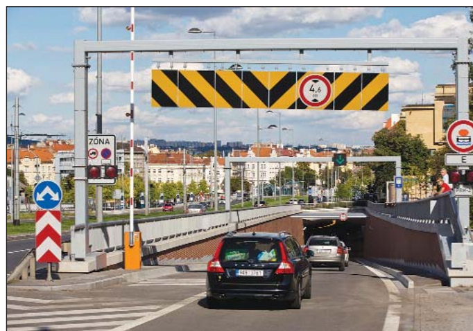
Obr. 4 První minuty provozu v tunelovém komplexu Blanka Fig. 4 Initial minutes of traffic in the Blanka complex of tunnels
