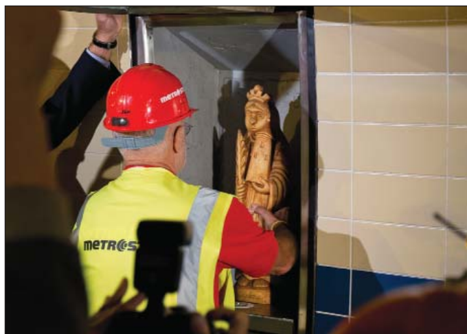
Obr. 4 Ukládání Barborky do výklenku ve stěně tunelu Fig. 4 Installation of St. Barbara statuette in a niche in the tunnel wall
