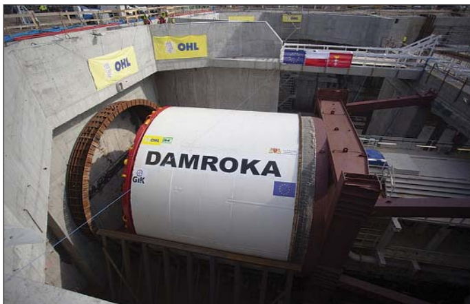
Obr. 1 Razicí štít osazený ve startovací jámě
