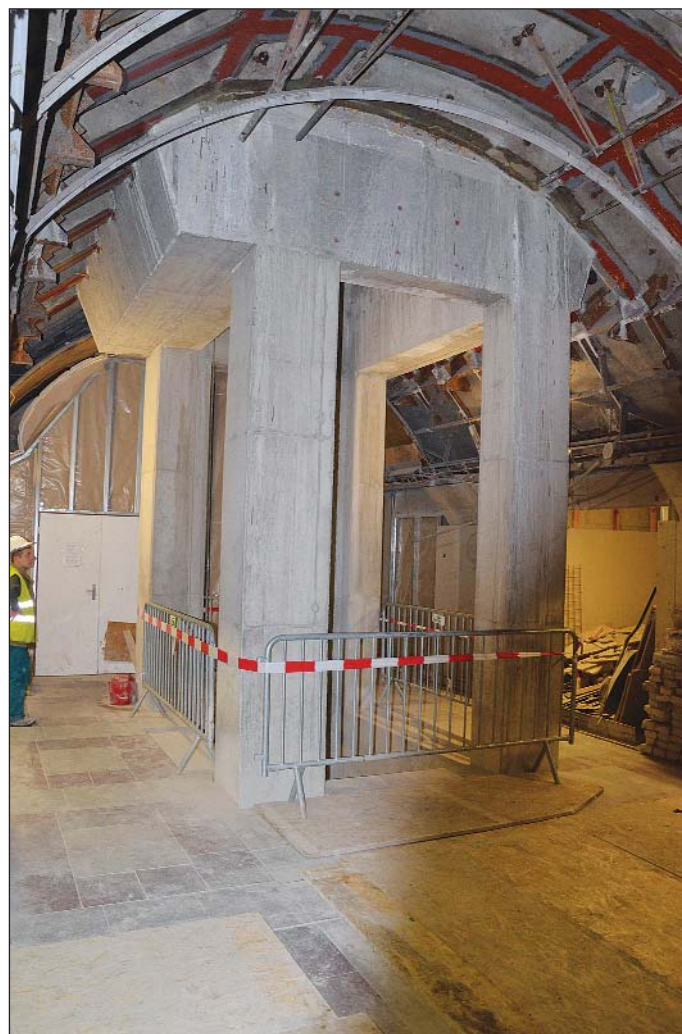
Obr. 8 Definitivní železobetonová konstrukce výtahové šachty na nástupišti stanice metra
