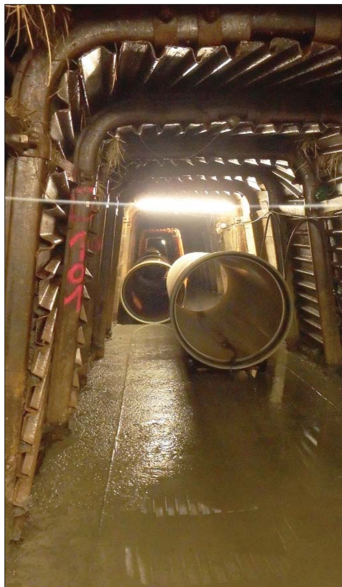
Obr. 11 Zavážení sklolaminátových kanalizačních trub Superlit DN800 Fig. 11 CCFRPM Superlit Sewer Pipe DN800 Installation
