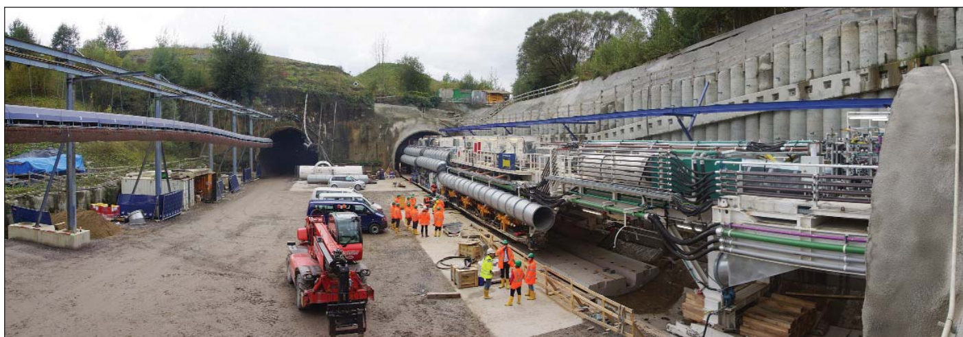
Obr. 6 Stavební jáma a montáž razicího stroje Fig. 6 Construction pit and assembly of the tunnelling machine
