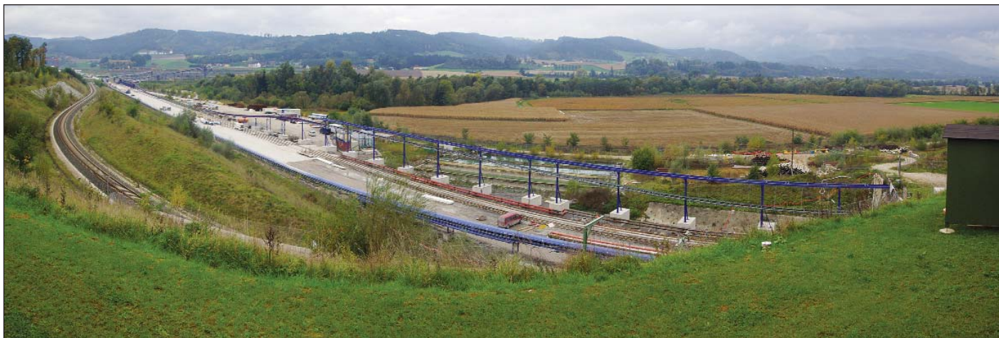
Obr. 1 Zařízení staveniště před portálem Fig. 1 Construction site in front of the portal
