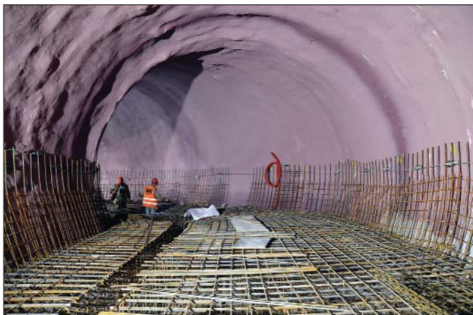
Obr. 9 Přestupní chodba po provedení stříkaných izolací při armování dna Fig. 9 Interchange gallery after completion of sprayed-on waterproofing during the placement of the bottom concrete reinforcement
