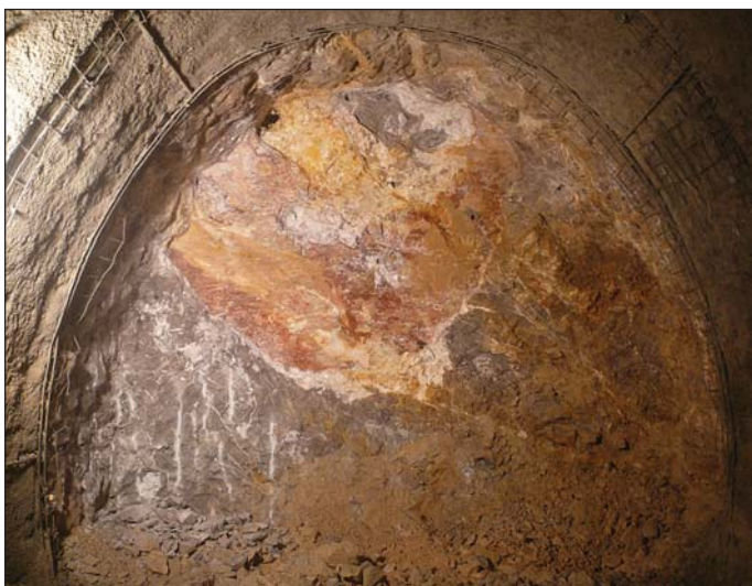
Obr. 5 Fotografie čela výrubu v devonských vápencích lochkovského souvrství, kde je patrné korozi krasové zvětrání horninového masivu až do hloubek 90 m pod terénem
