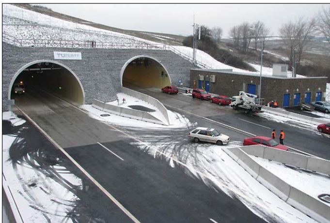
Obr. 1 Dokončovacie práce pred otvorením diaľničného úseku Fig. 1 Finishing work before opening the motorway section to traffic
