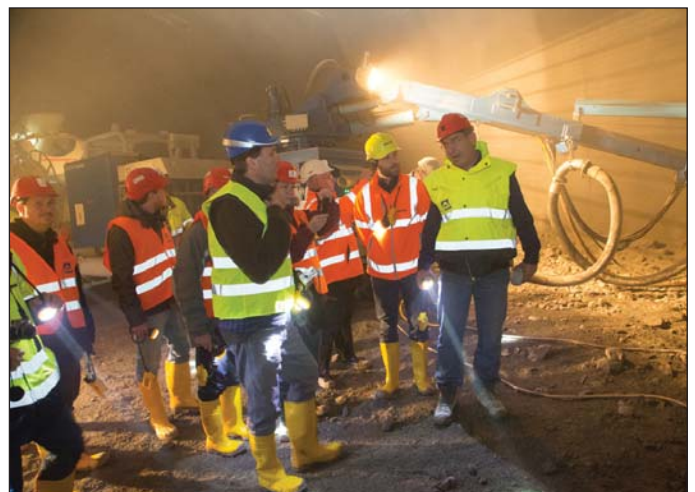
Obr. 6 Exkurzia na tunel Považský Chlmec Fig. 6 Excursion to the Považský Chlmec tunnel
