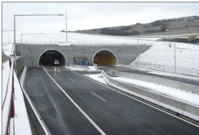
Obr. 2 Tunel Šibenik – pripravený na uvedenie do užívania Fig. 2 Šibenik tunnel – prepared for opening to traffic
