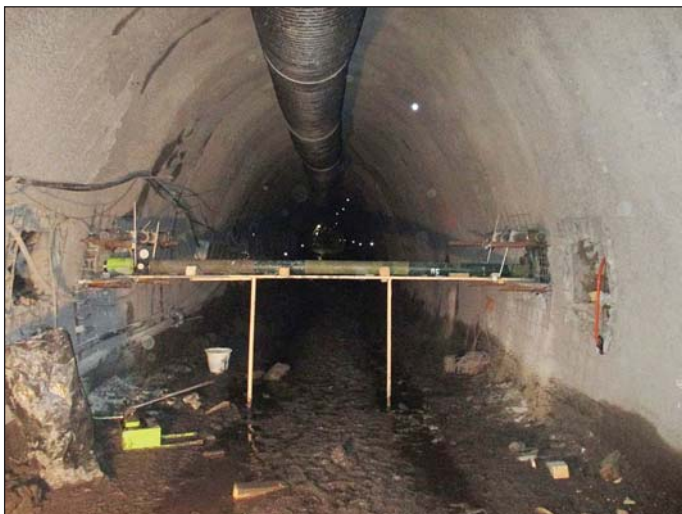
Obr. 9 Sestava rozpěrné zatěžovací zkoušky do stěn průzkumné štoly Fig. 9 The set for the transverse plate load test of the exploratory gallery sidewalls
