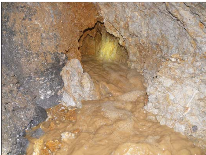
Obr. 6 Přítok podzemní vody z krasové pukliny v lochkovském souvrství, který způsobil částečné zatopení dna průzkumné štoly
