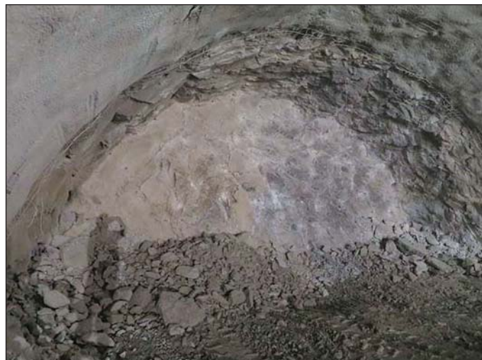
Obr. 10 Ražba v prostředí masivních vápno-písčitých slepenců vysoké pevnosti – výstrojovací třída VT 4.1 bez použití výztužného rámu s délkou záběru 3 m Fig. 10 Tunnelling through the environment formed by massive high-strength calcareous-sandy conglomerates – excavation support class VT4.1 without using support frames, with the excavation round length of 3m
