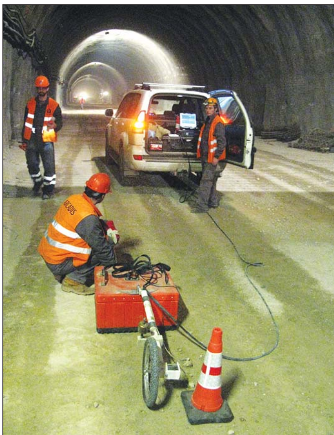
Obr. 7 Georadarové merania vykonávané v dne tunelovej rúry Fig. 7 Georadiolocation survey carried out at the tunnel tube bottom
