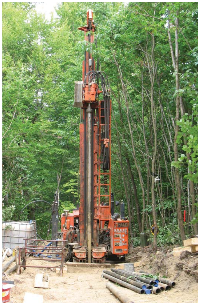
Obr. 2 Vrtanie zvislého jadrového inžinierskogeologického vrtu T-1 Fig. 2 Carrying out the vertical engineering geological cored borehole T-1
