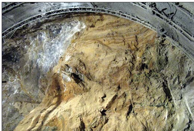
Obr. 6 Piesková a brekciová výplň kaveriny (1486,1 m, SK-188); v hornej časti je zreteľná laminovaná výplň po erózii, v strednej časti vyčnieva kamenný blok Fig. 6 Sandy and breccia fill of a cavern (1486.1m, SK-188); laminated filling after erosion is obvious at the top; a carbonate block protrudes in the middle part
