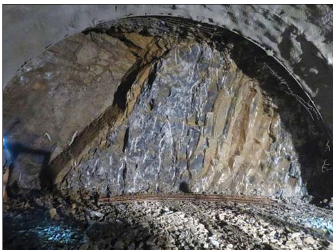
Obr. 8 Ražba v prostředí středně až slabě zvětralých pískovců a slínovců – vystrojovací třída VT 5.1 s délkou záběru 1,7 m
