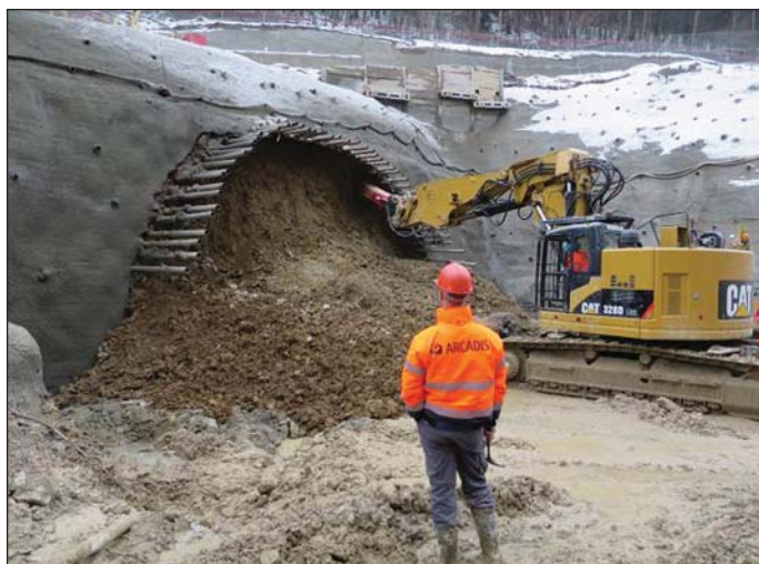
Obr. 6 Zahájení ražby jižní tunelové trouby ze střední části západním směrem pod ochranou mikropilotového deštníku
