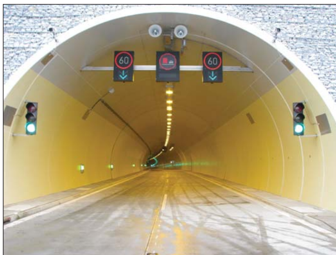
Obr. 4 Východný portál Fig. 4 Eastern portal
