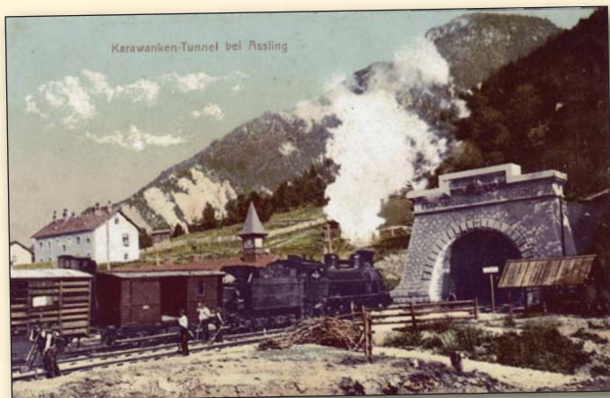
Obr. 5 Karawanken-Tunnel u Assling (dnes Jesenice). Okolo 1910. Fr. Pavlin, Assling. [sbírka autorů]
