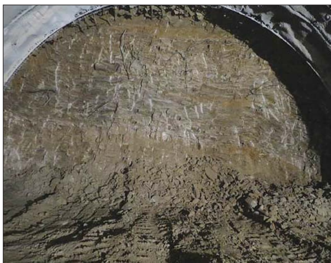
Obr. 7 Ražba v prostředí silně až zcela zvětralých slínovců a pískovců – vstrojovací třída VT 6.3 s délkou záběru 1 m
