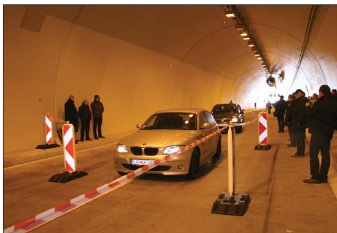
Obr. 6 Prejazd prvých vozidiel tunelom po uvedení do užívania Fig. 6 Passage of first vehicles through the tunnel after its opening to traffic
