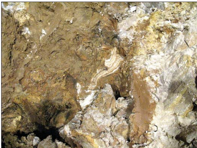
Obr. 2 Vrstva sintrov na okraji krasovej kaveriny v staničení 321,8 tm Fig. 2 Sinter layer on the edge of the karst cavern at tunnel chainage m 321.8
