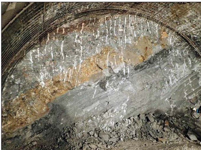
Obr. 9 Ražba v prostředí slabě zvětralých slinitých slepenců a jemnozrnných pískovců až prachovců – výstrojovací třída VT 4.2 s délkou záběru 2,2 m Fig. 9 Tunnelling through the environment formed by weakly weathered marly conglomerates and fine-grained sandstone to siltstone – excavation support class VT4.2 with the excavation round length of 2.2m
