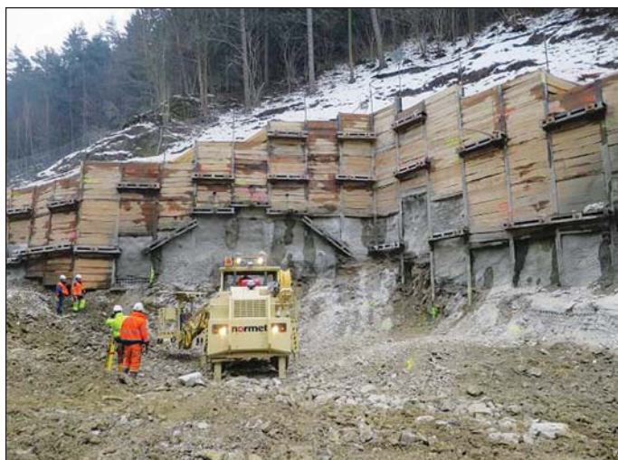
Obr. 5 Stěna východního portálu jižní tunelové trouby zajištěná záporovým pažením a betonovým zástříkem
