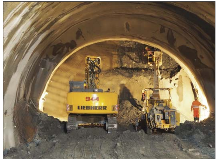
Obr. 3 Otváranie výrubu po častiach s okamžitým stabilizačným nástrekom otvorenej plochy, staničenie km 0,215 Fig. 3 Sequential opening of excavation with immediate application of shotcrete to the exposed surface, chainage km 0.215
