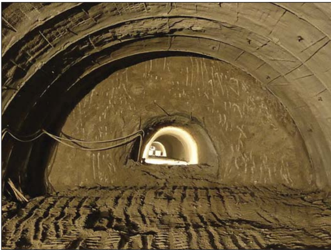
Obr. 2 Charakteristická čelba súľovských zlepcov, kde sa realizovali najdlhšie zábery v kalote
