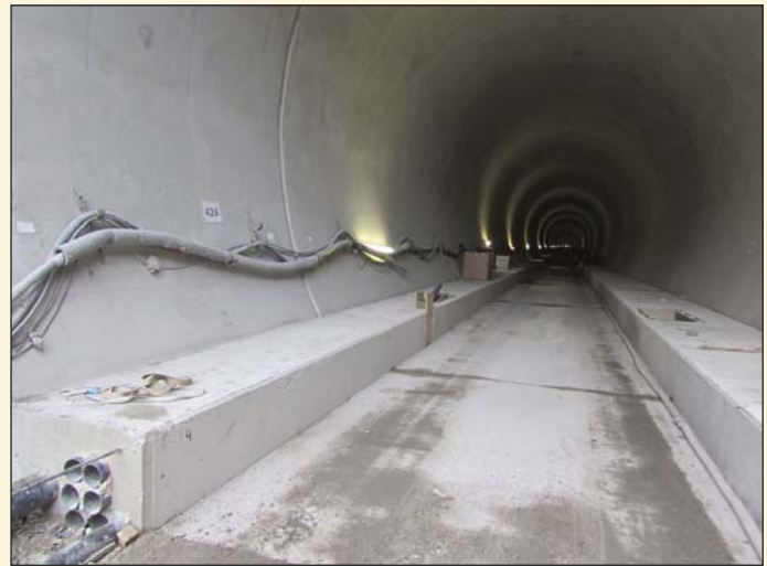
Obr. 4 Definitivní obezdívka v tunelu AKWT – pohled z portálu v Cochemu Fig. 4 Final lining in the AKWT tunnel – a view from the portal in Cochem
