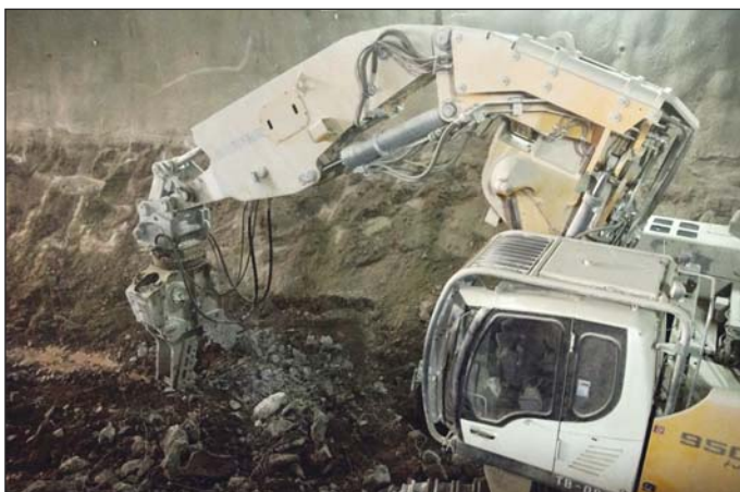
Obr. 4 Nůžky na bourání ostění bočních štol Fig. 4 Shears for the demolition of linings of sidewall drifts
