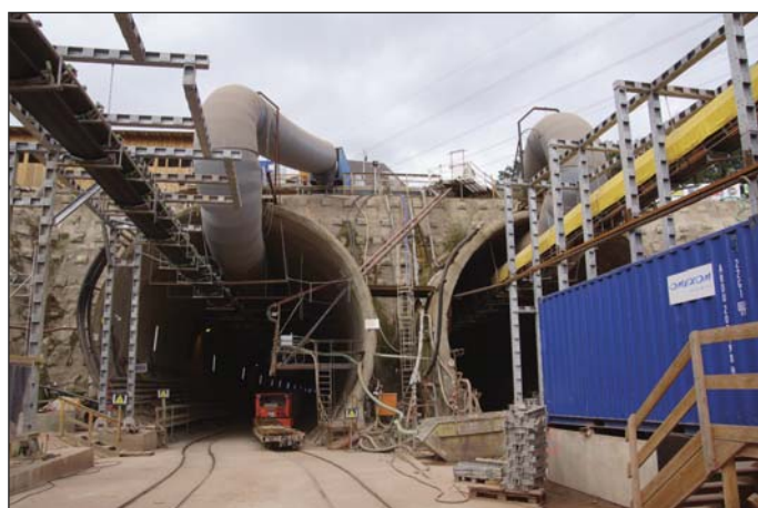
Obr. 3 Pohled na ražený portál s minimálním horninovým pilířem Fig. 3 A view of the mined portal with a minimum rock pillar
