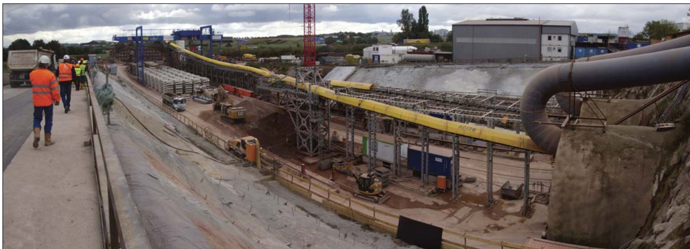
Obr. 1 Celkový pohled na předportálový úsek tunelu Fig. 1 General view of the pre-portal tunnel section
