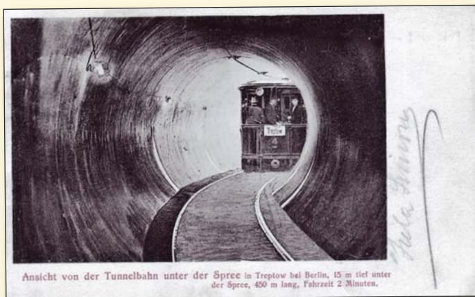
Obr. 7 Pohled na tunelovou dráhu pod Sprévou v Treptowě u Berlína, v hloubce 15 m pod Sprévou, délka 450 m, jízdní doba 2 minuty.?? 1906 [sbírka autorů]
