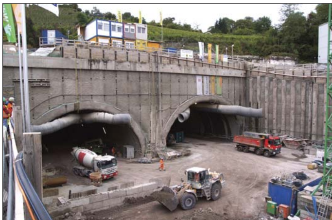
Obr. 1 Stavební jáma před nádražím Fig. 1 Construction pit in front of the railway station
