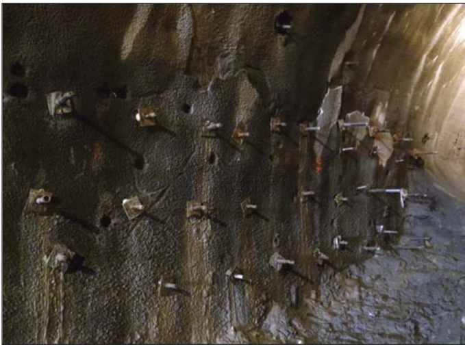
Obr. 2 Dodatočné dokotvenie pozdĺžnej trhliny, staničenie km 0,209 Fig. 2 Additional anchoring of the longitudinal crack, chainage km 0.209
