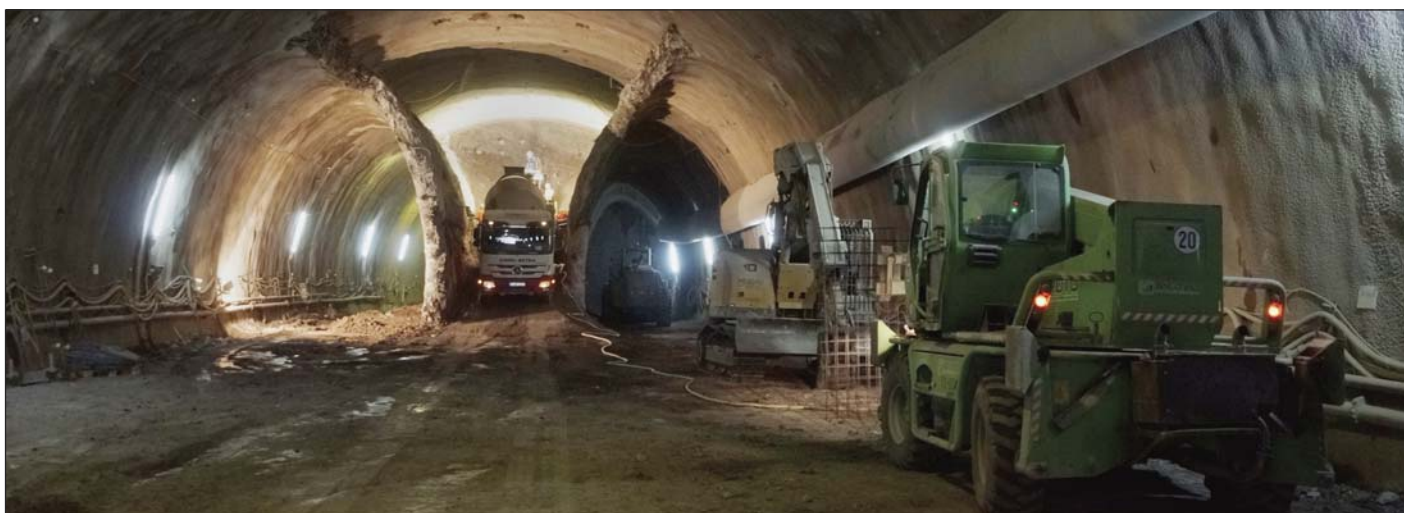
Obr. 5 Ražba v zeminách s vertikálním členěním – počva bez vody a výmolů Fig. 5 Tunnelling through soils using the so-called vertical excavation sequence – tunnel bottom without water and potholes
