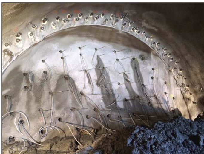
Obr. 8 VT 8 – zabezpečenie čelby mikropilotovým dáždnikom a sklolaminátovými kotvami
