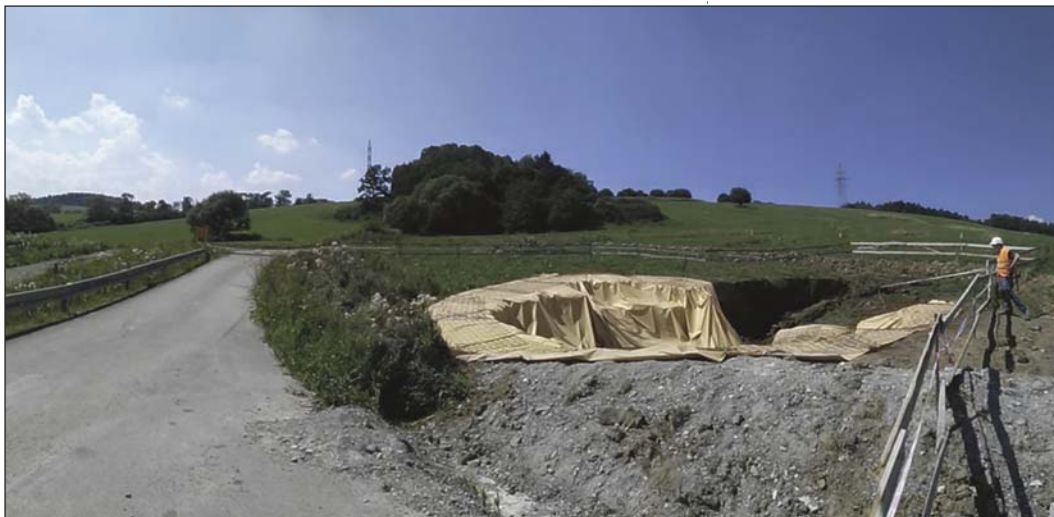
Obr. 6 Povrchová depresia vzniknutá prepadosť terénu Fig. 6 Surface depression developed by sinking of terrain
