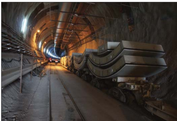
Obr. 4 Kolejová doprava, konvenčně ražený úsek tunelu Fig. 4 Track haulage, a conventionally driven tunnel section
