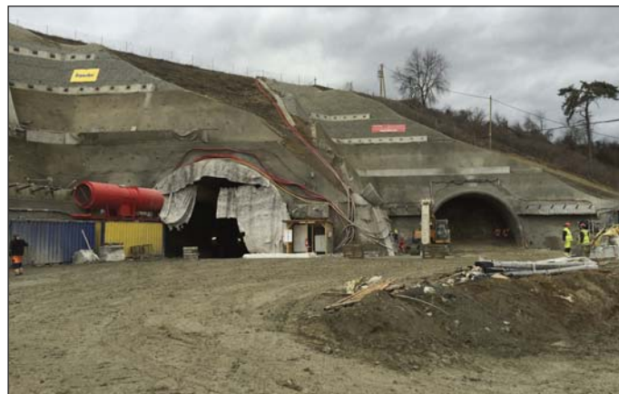
Obr. 11 Východný portál tunela Žilina Fig. 11 Eastern portal of the Žilina tunnel
