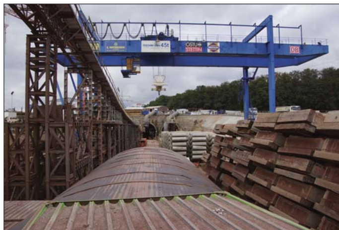
Obr. 5 Zásobník pásového dopravníku a zázemí pro ražbu TBM Fig. 5 Conveyor belt storage unit and TBM excavation background
