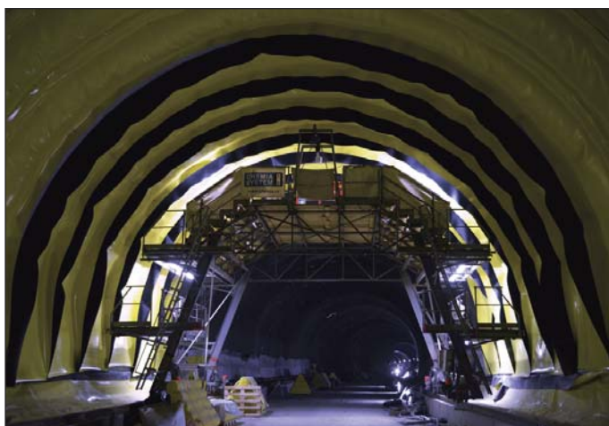
Obr. 2 Hydroizolácie tunela Poľňa Fig. 2 Poľňa tunnel waterproofing
