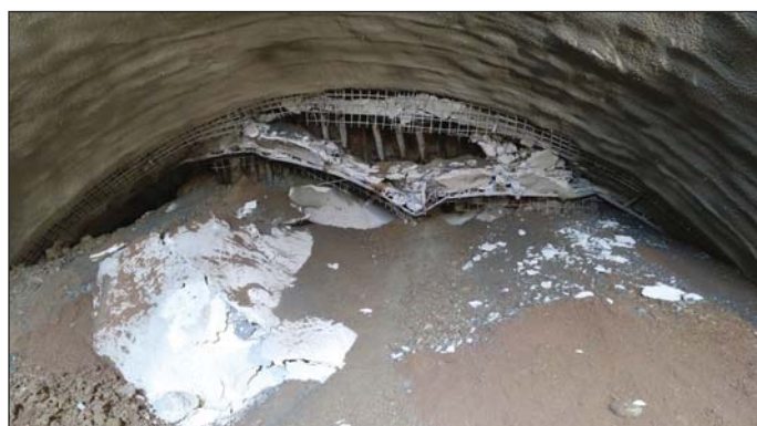
Obr. 5 Vytlačenie horninového materiálu do tunelovej rúry s deformáciou rúr mikropilótového dáždnika a priehradových nosníkov Fig. 5 Ground material extrusion into the tunnel tube; deformation of canopy tubes and lattice girders
