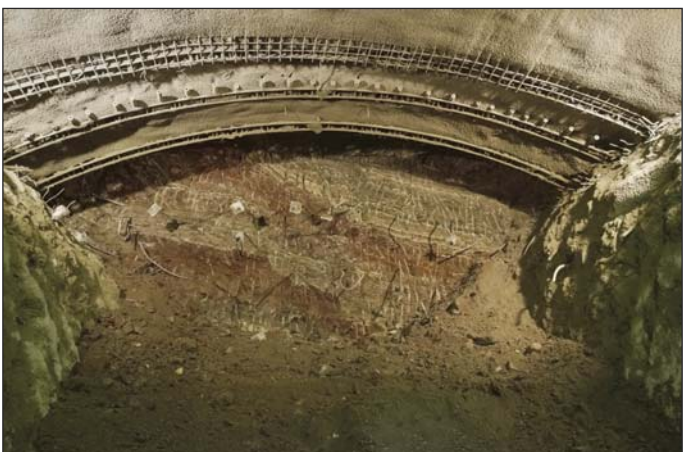
Obr. 3 Zajištění stability čelby a přístropí Fig. 3 Securing the stability of excavation face and top heading
