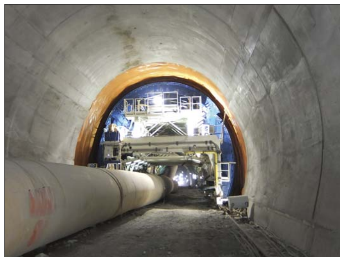
Obr. 12 Betonáž sekundárneho ostenia
