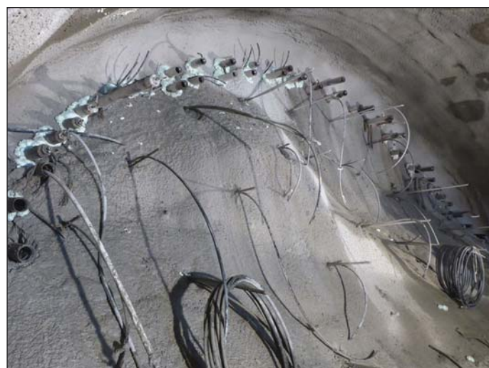
Obr. 7 Pohľad na zaistenú čelbu, sklolaminátové svorníky čelby, dvojradový mikropilotový dáždník
