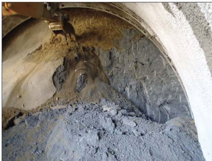
Obr. 4 Vysypávanie materiálu z čelby kaloty, staničenie km 0,240 Fig. 4 Pouring of material off from the top heading excavation face, chainage km 0.240
