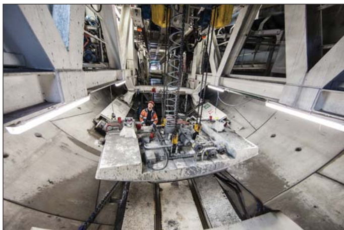
Obr. 2 Skládání segmentů na segmentový podavač Fig. 2 Unloading the segments on the segment erector
