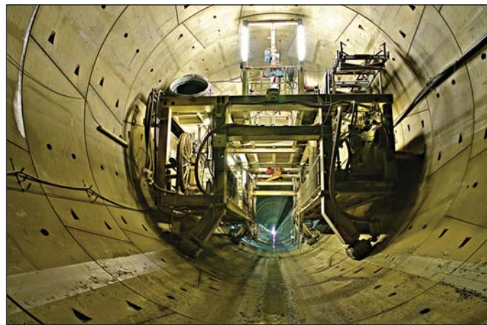
Obr. 7 Průtah gantrů skrz vyraženou konstrukci tunelu
