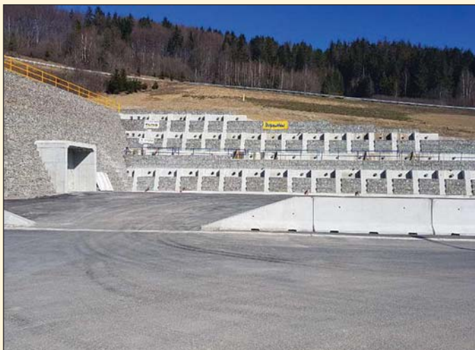
Obr. 1 Tunel Polná – východný portál Fig. 1 Polná tunnel – eastern portal
