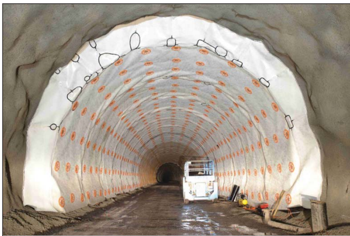
Obr. 7 Izolace plného profilu polyetylenovou membránou Fig. 7 Full-profile insulation using PE membrane
