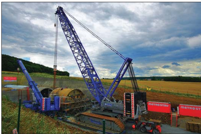
Obr. 6 Demontáž stroje Herrenknecht S-799
