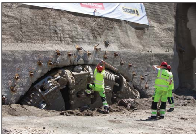
Obr. 4 Tzv. „malá prorážka“ jižní tunelové trouby Fig. 4 The so-called “minor breakthrough” of the southern tunnel tube
