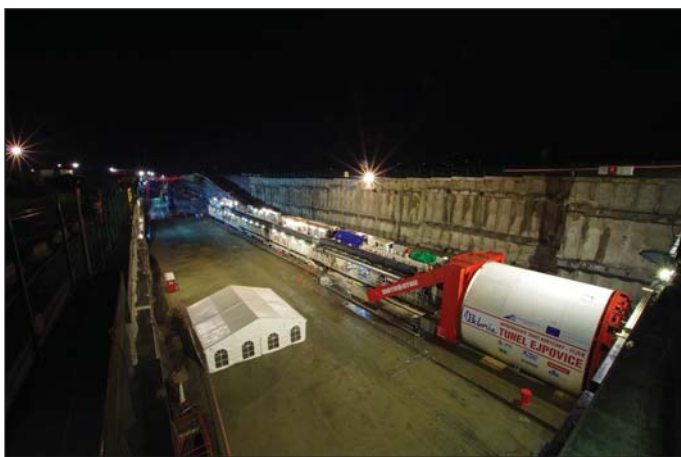
Obr. 1 Tunelovací stroj S-799 před zahájením ražeb JTT
