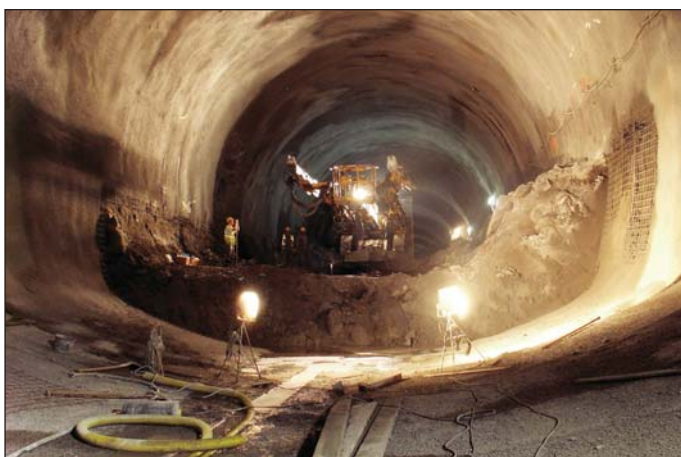
Obr. 5 Seismická měření v tunelu Jablunkov Fig. 5 Seismic measurements in the Jablunkov tunnel
