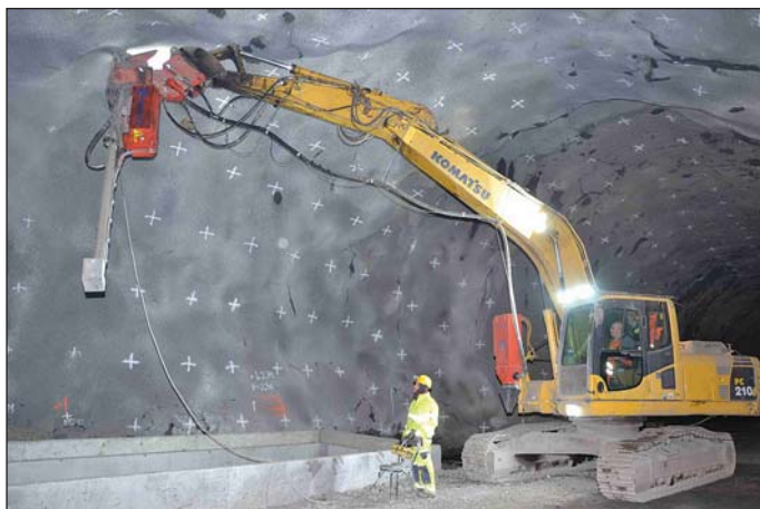
Obr. 1 Vrtání kotev nástavbovou vrtáčkou AB1000
