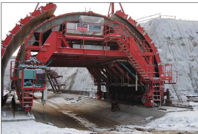
Obr. 8 Tunel Radejčín – bednicí forma pro betonáž horní klenby
