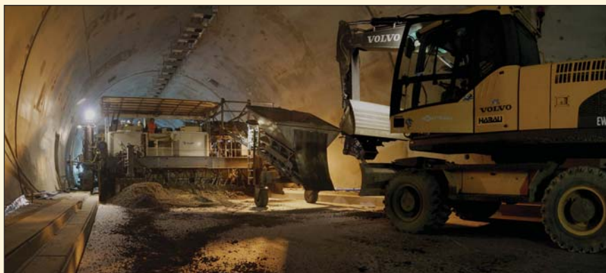
Obr. 4 Tunel Považský Chlmec – betonáž vozovky
