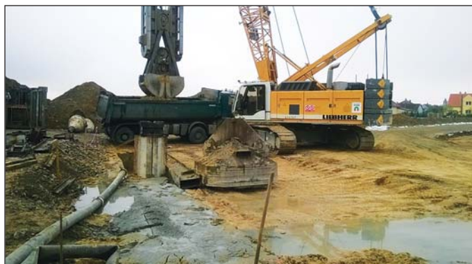
Obr. 3 Hloubení podzemních stěn tzv. garáží Fig. 3 Excavation of trenches for diaphragm walls of the so-called garages
