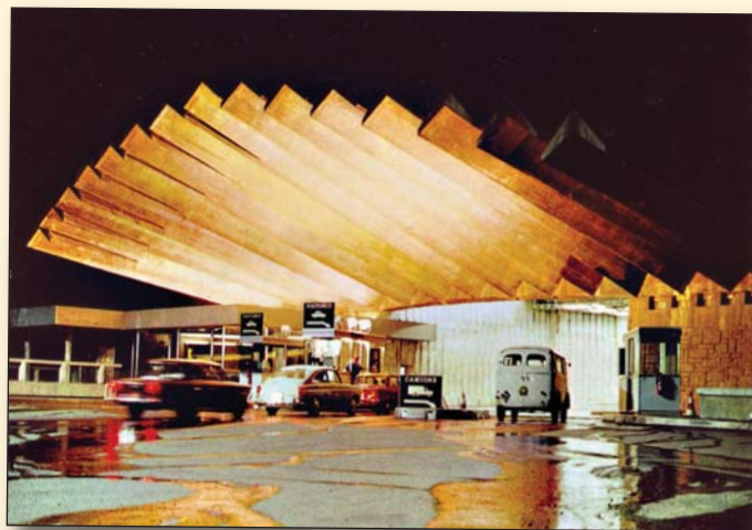
Obr. 2 Chamonix – Mont Blanc (1 050 m). Tunel Mont Blanc (1 381 m) spojující Chamonix (Francie) s Entrèves – Courmayeur (Itálie). Vstup do tunelu Mont Blanc na francouzské straně. Délka: 11 600 m, nejdelší na světě. Šířka: 2 jízdní pruhy 3,50 m. Výška nad vozovkou: 6 m. Provoz řízený radarem. 1965–70? Éditions Lutetia, 4, rue des Charpentiers, 67 Strasbourg. [sbírka autorů]
