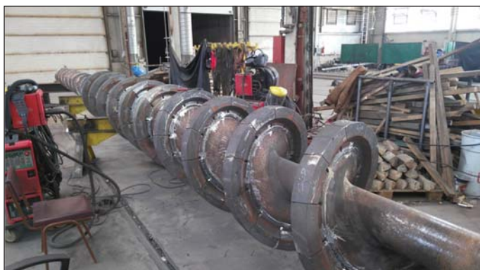
Obr. 9 Repase šnekového dopravníku Fig. 9 Screw conveyor rehabilitation
