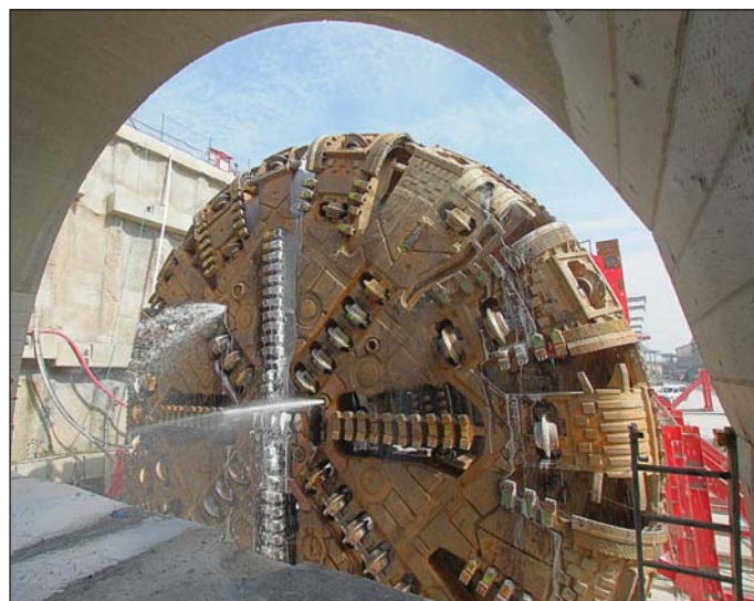
Obr. 10 Provozní zkoušky stroje před zahájením ražeb STT Fig. 10 Operational testing of the TBM before the commencement of driving the NTT
