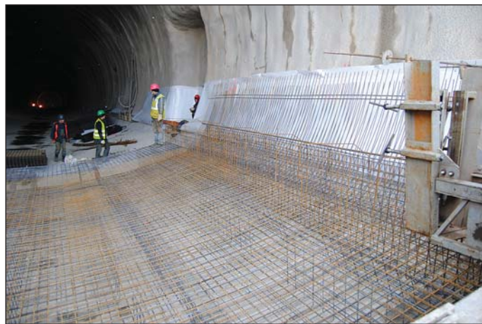
Obr. 7 Tunel Radejčín – montáž výztuže spodní klenby
