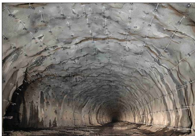
Obr. 2 Kotvy připravené pro osazení izolace
