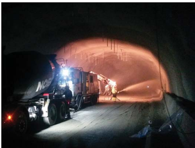
Obr. 11 Stříkání protipožární vrstvy na desky PE pěny
