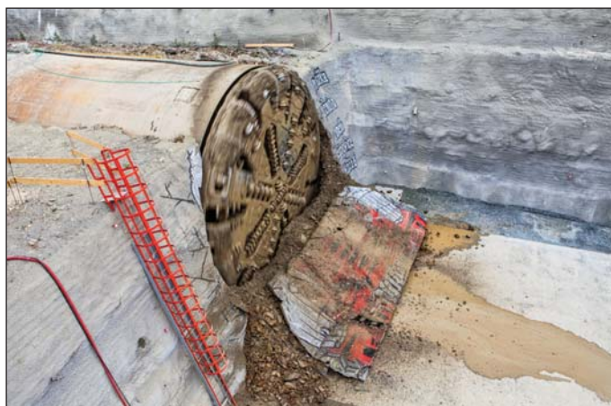
Obr. 5 Prorážka jižní tunelové trouby Fig. 5 Breakthrough of the southern tunnel tube
