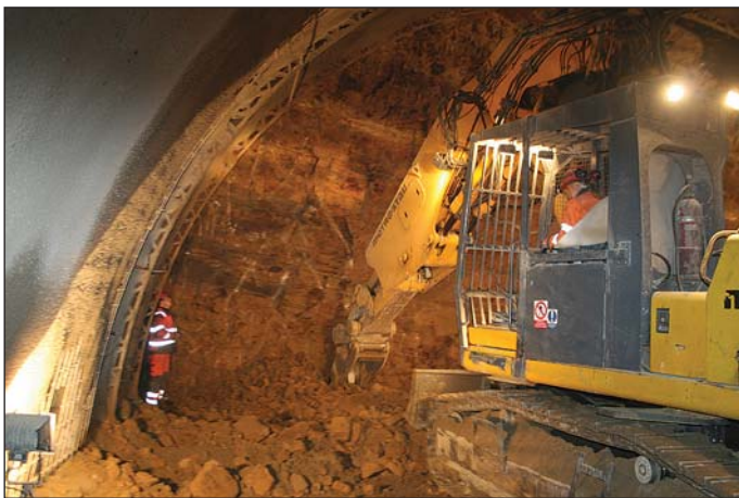
Obr. 6 Rozpojování horniny na čelbě
