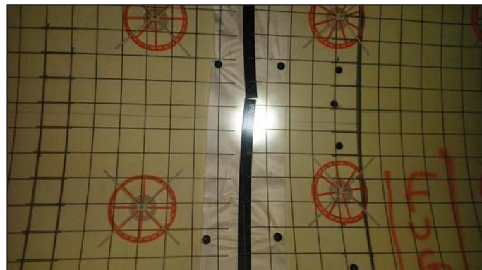
Obr. 4 Detail dilatační spáry
