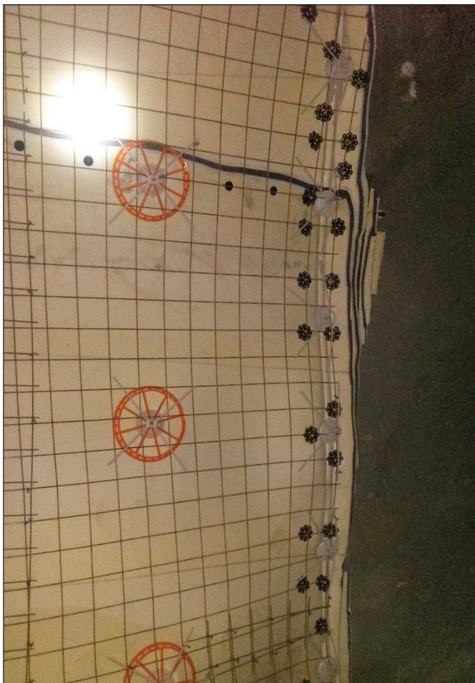
Obr. 3 Detail zakončení PE desek k výrubu
