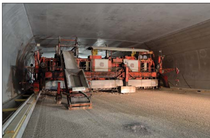
Obr. 3 Finišer v tunelu Götschka (Rakousko) Fig. 3 Roadway paver in the Götschka tunnel (Austria)
