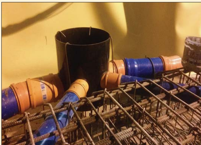
Obr. 3 Tunel Žilina – osadenie dna šachty s napojením drenážnych rúr Fig. 3 Žilina tunnel – installation of a manhole bottom with connections for drainage tubes
