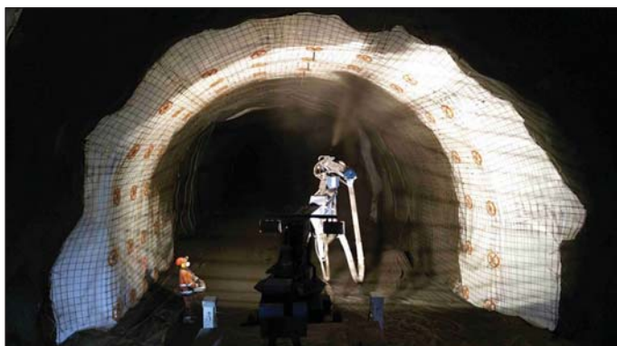
Obr. 10 Stříkání protipožární vrstvy na polyetylenovou membránu Fig. 10 Spraying the fire protection concrete layer on the polyethylene membrane
