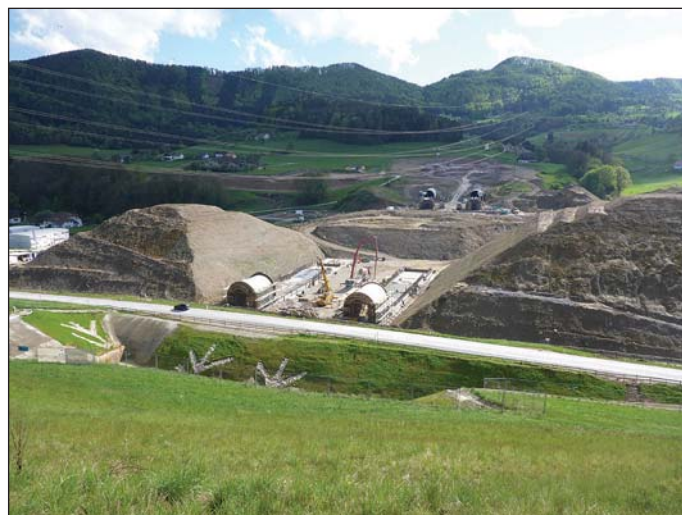
Obr. 13 Údolí Granitztal, portál tunelů DG jih, příprava betonáže bloků přesýpaného tunelu, tunely LB Fig. 13 Granitztal valley, portal of the DG South tunnels, preparation of casting the concrete blocks of the false tunnel, the LB tunnels
