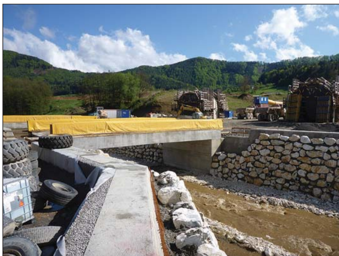
Obr. 14 Objekt SA1, „most pro tunely“, 04/2017 Fig. 14 SA1 structure, „bridge for tunnels“, 04/2017
