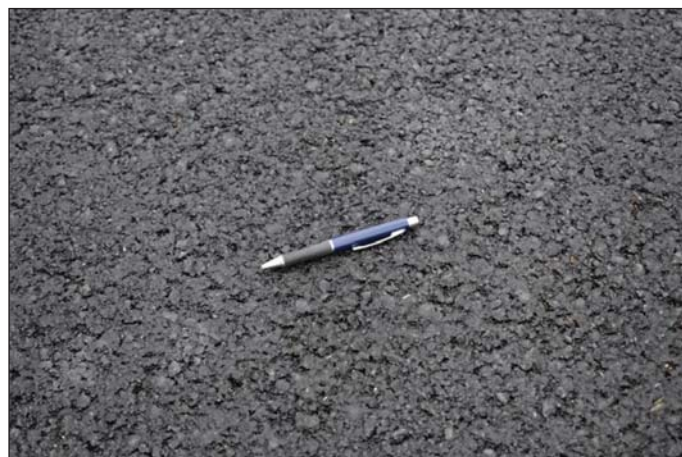
Obr. 2 Kontrola pokládky ložní vrstvy 23. 10. 2016 Fig. 2 Checking the laying of the base course 23 rd October 2016
