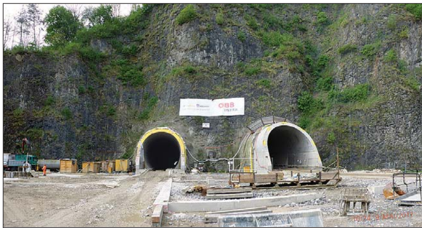
Obr. 7 Pohled na severní portálovou stěnu tunelů Deutsch Grutschen, 05/2017
