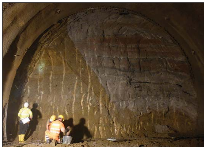
Obr. 6 Tektonická porucha oddělující slepence (pravá strana) a písčité prachovce v granitztalských vrstvách
