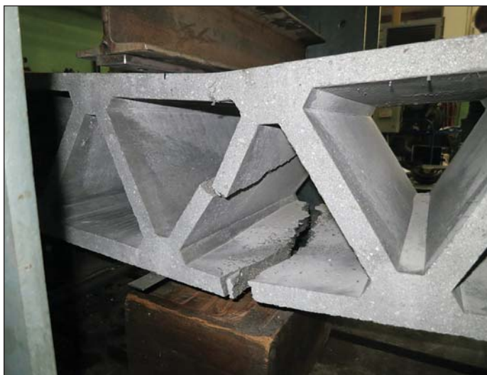
Obr. 5 Zkoušení fragmentu dutinové desky z vysokopevnostního betonu (UHPC) Fig. 5 Testing of a fragment of the slab made of ultra-high performance concrete (UHPC)
