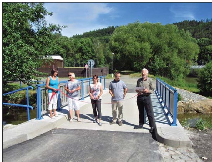
Obr. 2 Slavnostní otevření mostu s přímo poježděnou mostovkou z vláknobetonu v obci Sázava (červen 2017) Fig. 2 Ceremonial inauguration of the bridge with the directly run on bridge deck made from fibre reinforced concrete in the town of Sázava (June 2017)
