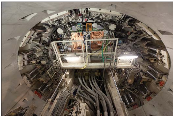
Obr. 10 Pohled ve směru ražby, po obvodě jsou umístěny hydraulické válce opřené o hotovou část ostění
