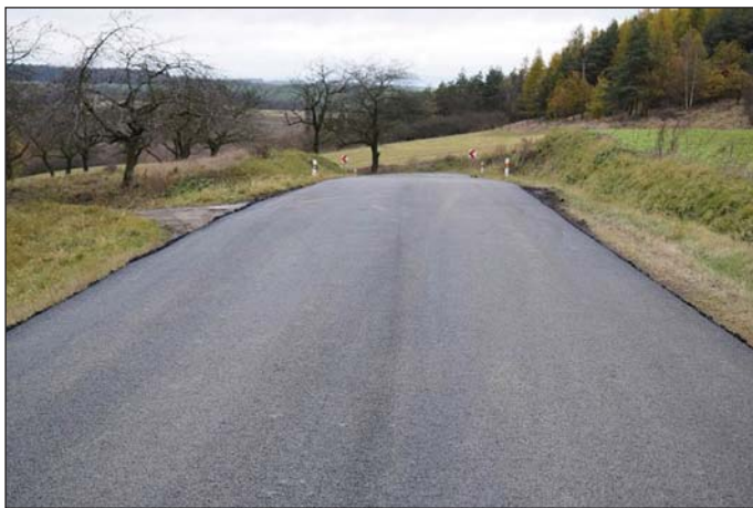
Obr. 1 Zkušební úsek Terešov – Biskoupky – Vejvanov Fig. 1 Testing section Terešov – Biskoupky – Vejvanov
