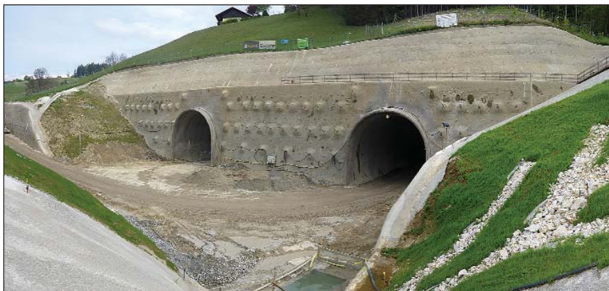
Obr. 8 Pohled na jižní portálovou stěnu tunelů DG Fig. 8 A view of the southern portal wall of the DG tunnels
