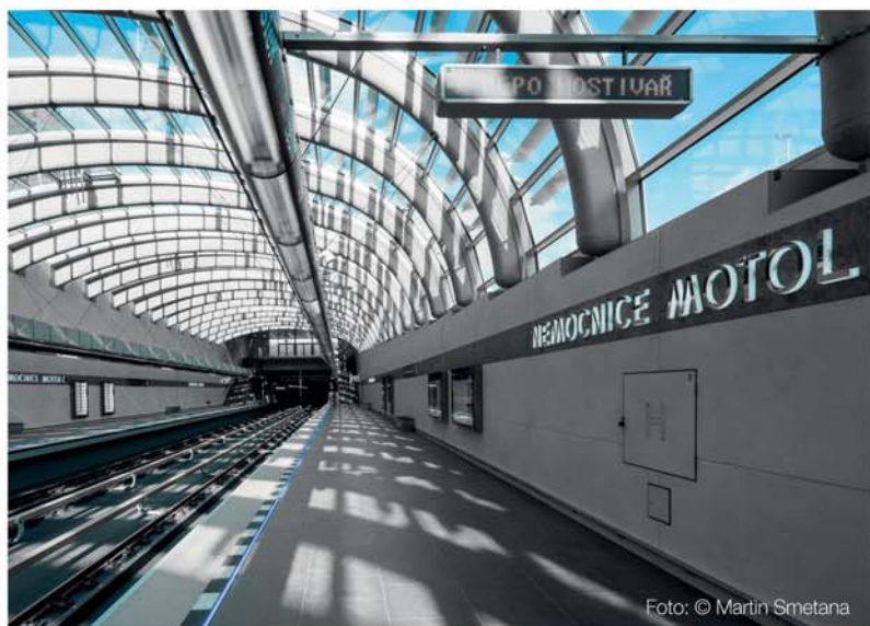
Prodloužení metra V.A (Dejvická–Motol), Praha stanice Nemocnice Motol
