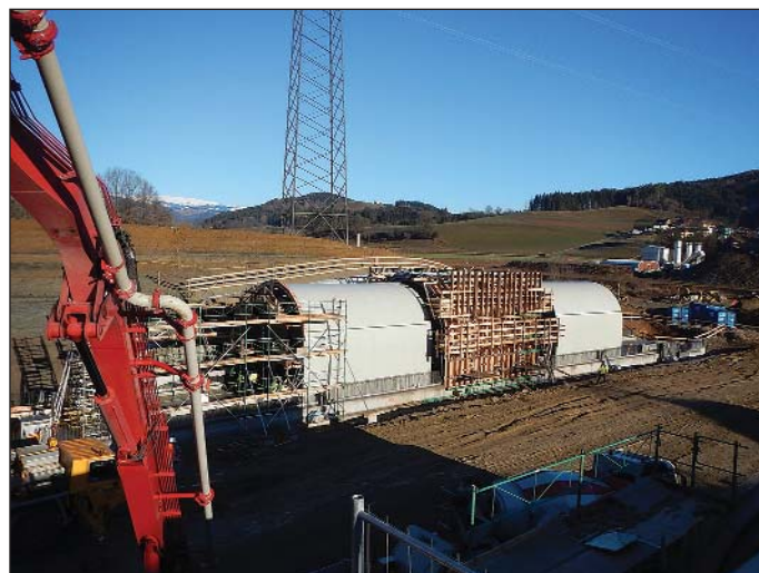
Obr. 15 Betonáž bloků přesypného tunelu
