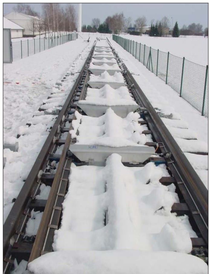
Obr. 4 Inteligentní ohřev výměňové části výhybky pro vysokorychlostní trať Fig. 4 Intelligent heating of the switching part of a turnout for high-speed tracks
