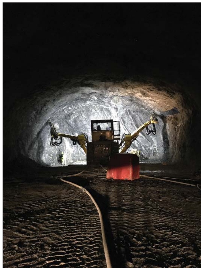
Obr. 2 Tunely hlavní trasy HT202 při nabíjení čelby trhavinou za pomoci vrtacího vozu
