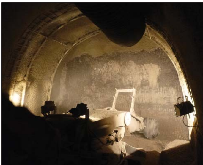
Obr. 10 Ražba pomocí razicího stroje s frézou na výložníku Alpine AM50
