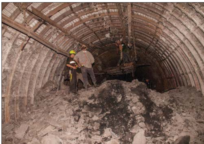
Obr. 9 Místo prorážky protisměrných ražeb
