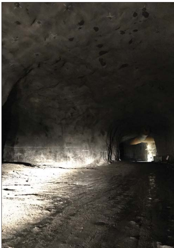
Obr. 8 Tunelová rampa RT211 zachycující pohled na elektrovýklenek ELDU 26H (vlevo) a vyústění přístupového tunelu AT1, ze kterého vedou luty pro větrání v tomto tunelu
