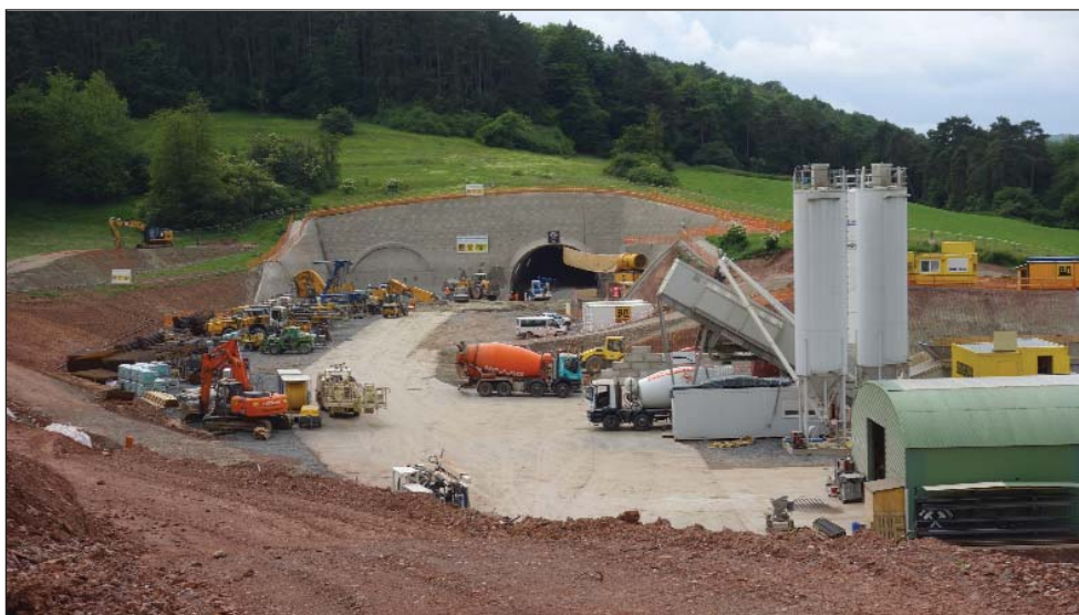
Obr. 2 Zařízení staveniště na severním portále
