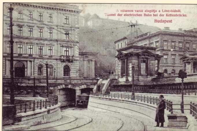
Obr. 4 Budapešť. Tunel elektrické dráhy u Řetězového mostu. 1668–1907 Divald Károly, Budapest. 1907. [sbírka autorů]
