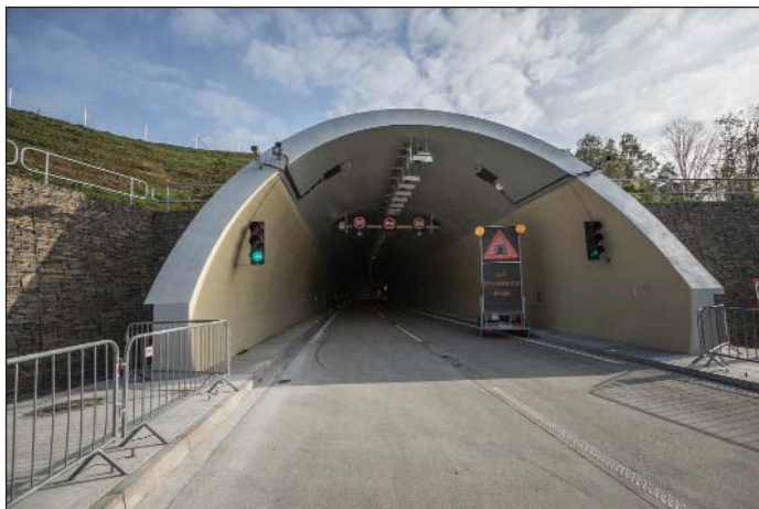
Obr. 1 Južná tunelová rúra, západný portál Fig. 1 The southern tunnel tube, the western portal
