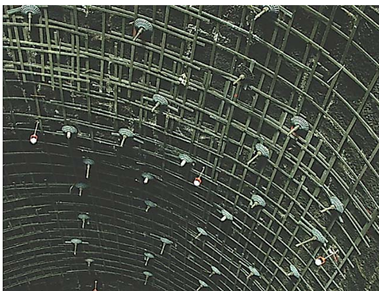
Obr. 1 Provizorní podskružení (vlevo) a po odstranění osazení trvalou kompozitní sítí a svorníky (vpravo)
