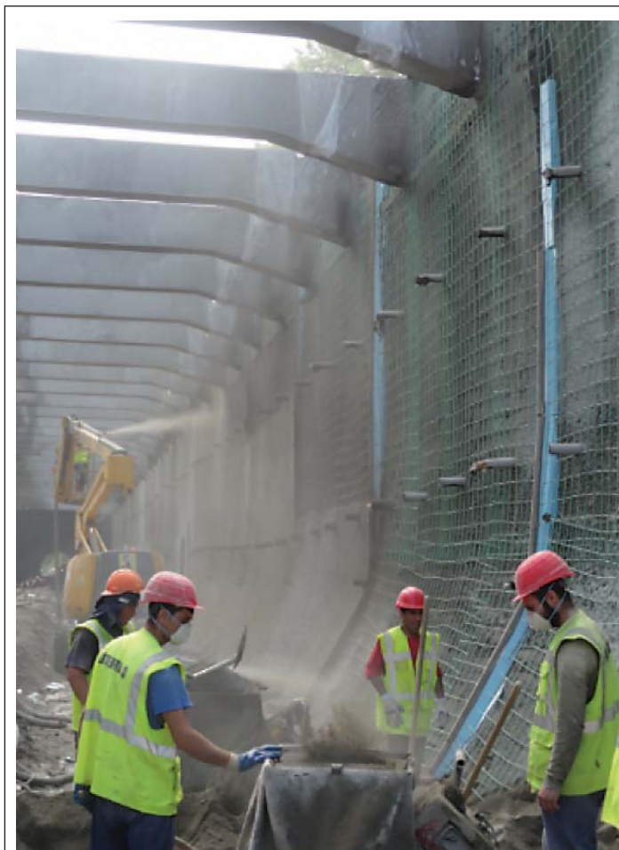
Obr. 2 Sanace Střelenského tunelu s využitím kompozitních sítí Powermesh Fig. 2 Rehabilitation of the Střelenský tunnel using composite Powermesh
