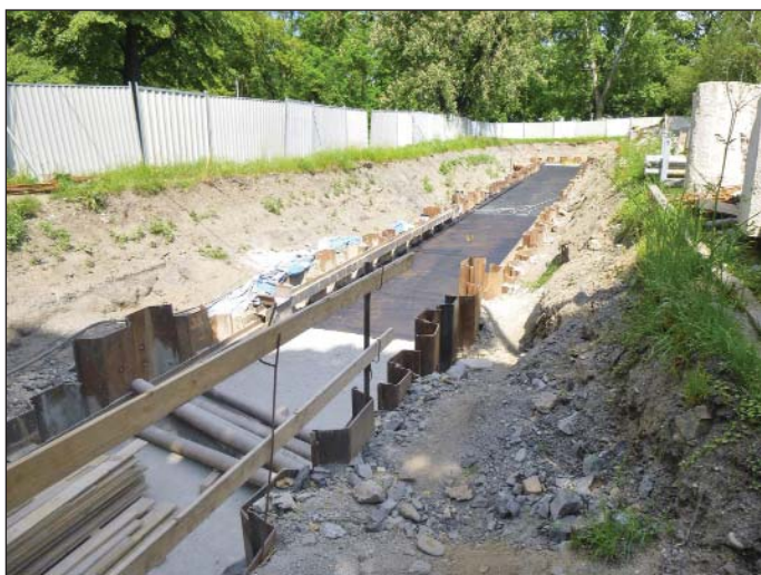
Obr. 11 Pohled do předvýkopu, položené izolace na třetím dilatačním úseku stropu hloubené odbočné větve
