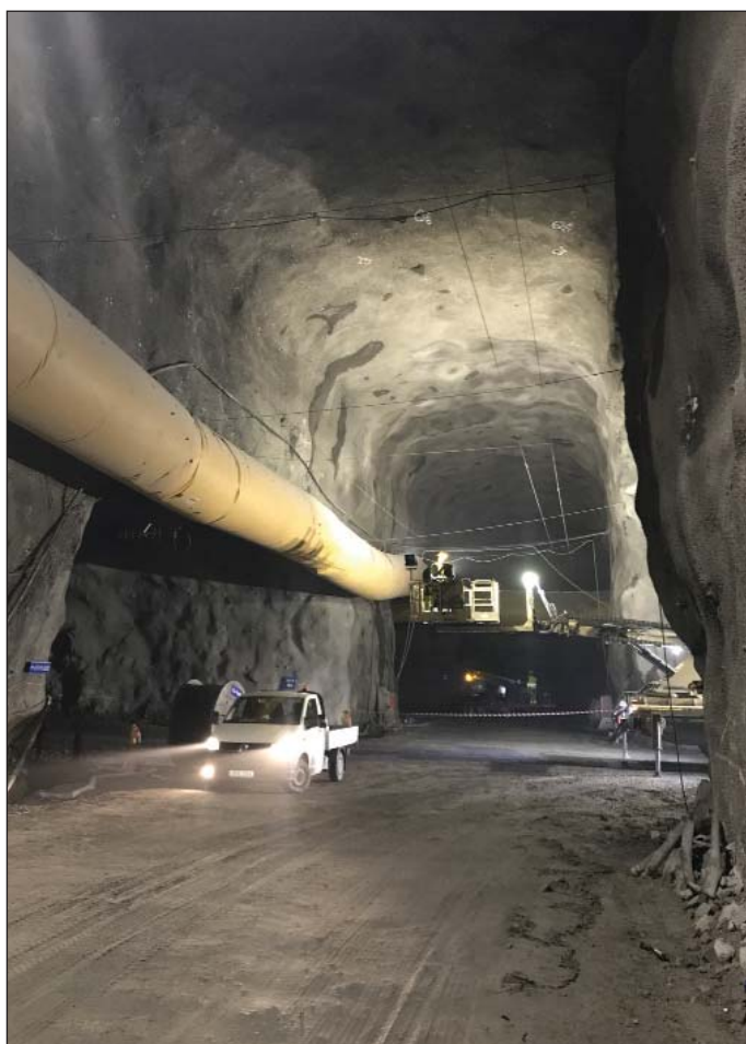
Obr. 9 Kaverna na konci přístupového tunelu AT292, místo odkud jsou raženy tunely hlavní trasy z lokality Sättra
