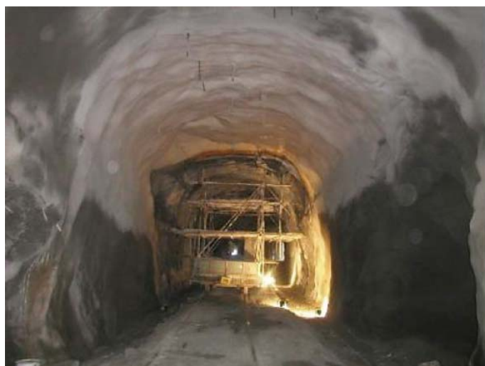
Obr. 3 Aplikace stříkané hydroizolační membrány v Pavlovickém tunelu Fig. 3 Spray-applied waterproofing membrane in the Pavlovice tunnel
