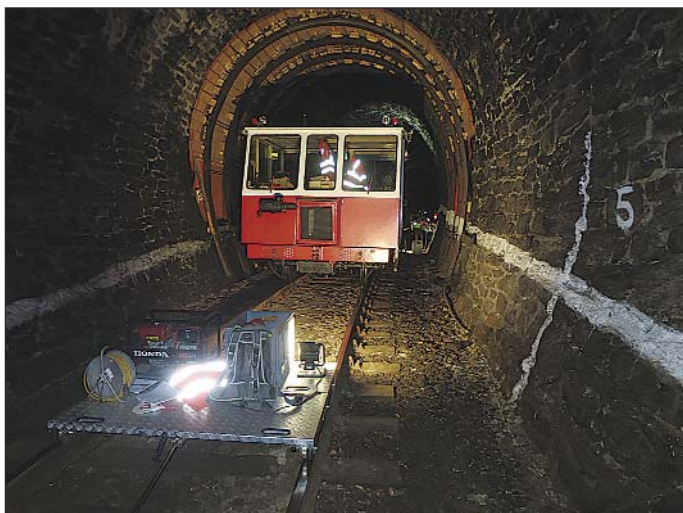
Obr. 4 Dočasné zajištění klenby pásu č. 4 a pracovní vlak pro průzkumné práce
