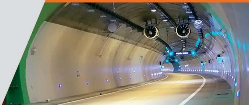
Tunel Klímkovice, stavba roku Moravskoslezského kraje 2008
