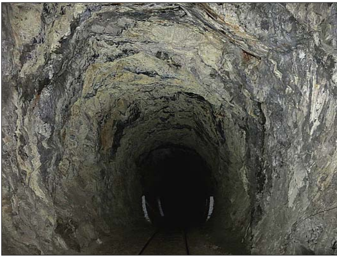
Obr. 3 Část tunelu bez ostění Fig. 3 Unlined part of the tunnel
