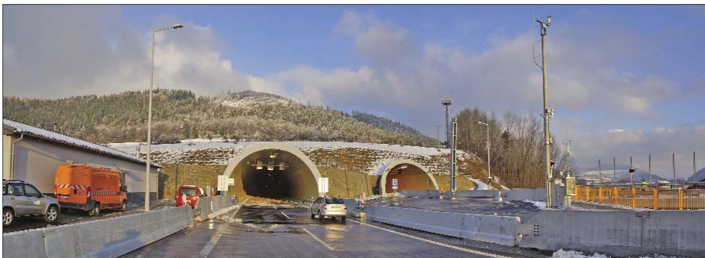
Obr. 18 Pohled na dokončený západní portál
