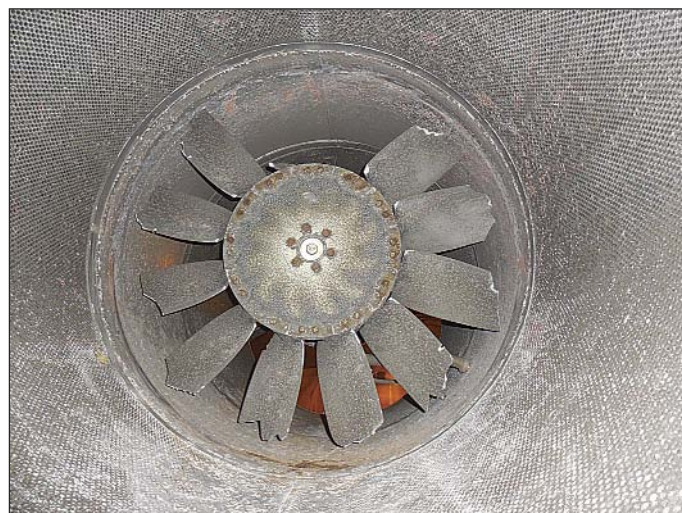
Obr. 6 Lopatky proudového ventilátoru (eloxovaný hliník) Fig. 6 Axial fan vanes (anodised aluminium)
