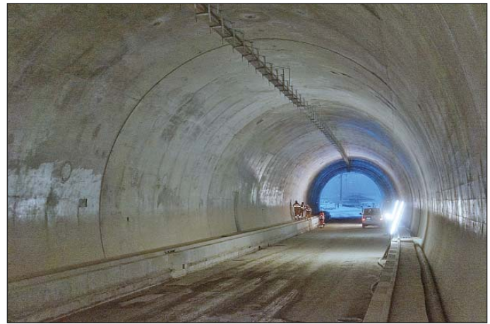
Obr. 6 Spádový beton pod konstrukčními vrstvami vozovky Fig. 6 Sloped concrete under roadway structural layers
