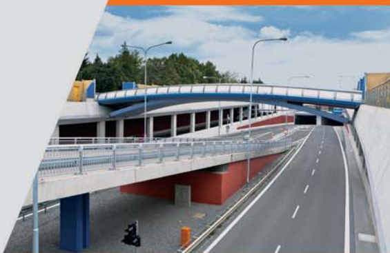
Královopolský tunel, stavba roku 2013
