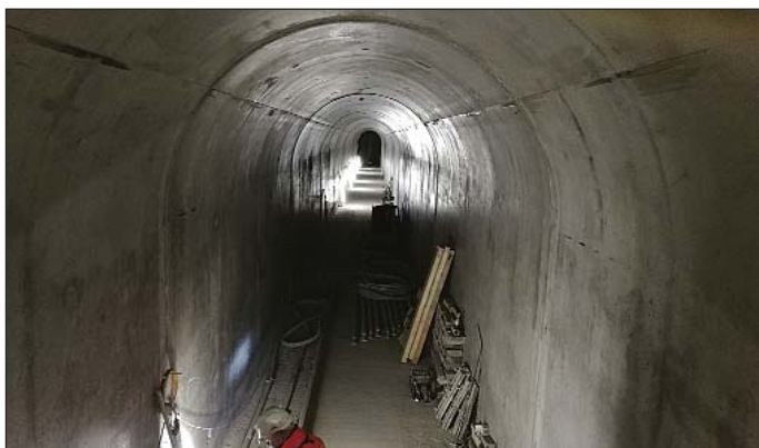
Obr. 8 Hotové betonové definitivní ostění hlavní trasy Fig. 8 Completed final concrete lining on the main route
