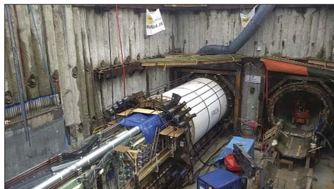
Obr. 11 „Letmá zarážka“ tunelovacího stroje TBM (bez opěrných bloků)
