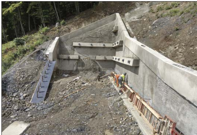
Obr. 1 Výstavba portálu pre únikovú štôľňu tunela Diel Fig. 1 Construction of the portal for the escape gallery of the Diel tunnel
