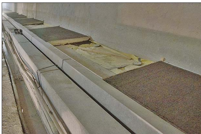
Obr. 10 Betonáž chodníku nad kabelovody Fig. 10 Concreting the walkway above cableways
