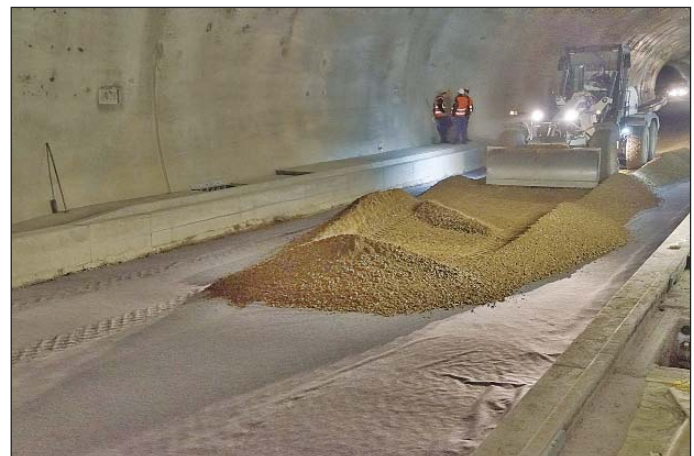
Obr. 8 Pokládka šterkodrti na separační geotextilii Fig. 8 Placement of crushed gravel on separation geotextile
