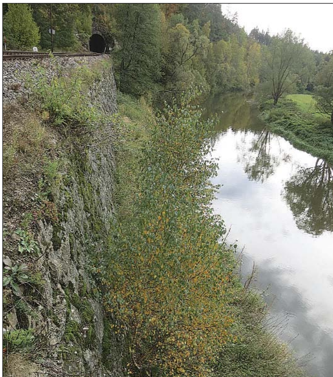
Obr. 7 Opěrná (nábrežní) zď před tunelem Fig. 7 Retaining (embankment) wall in front of the tunnel
