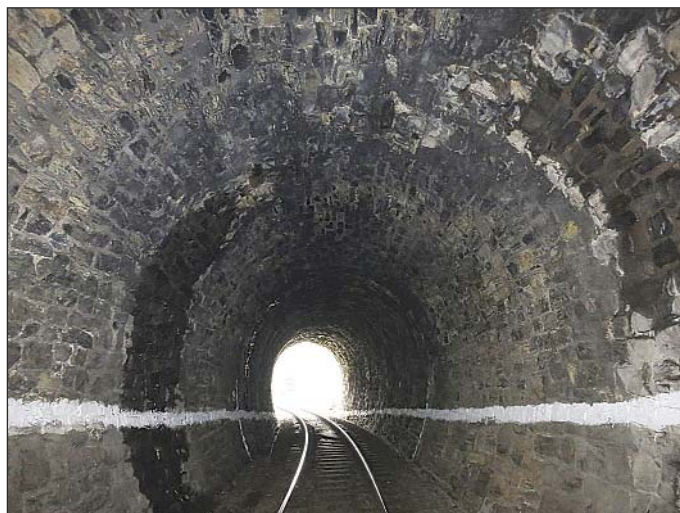
Obr. 2 Část tunelu s kamenným ostěním Fig. 2 Masonry lined part of the tunnel
