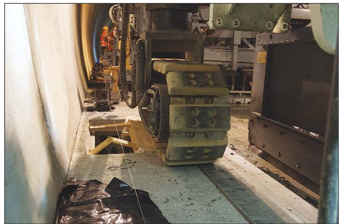
Obr. 16 Ochrana chodníku pod pásem finišeru pryžovým pásem Fig. 16 Protection of walkway under paver track by a rubber belt
