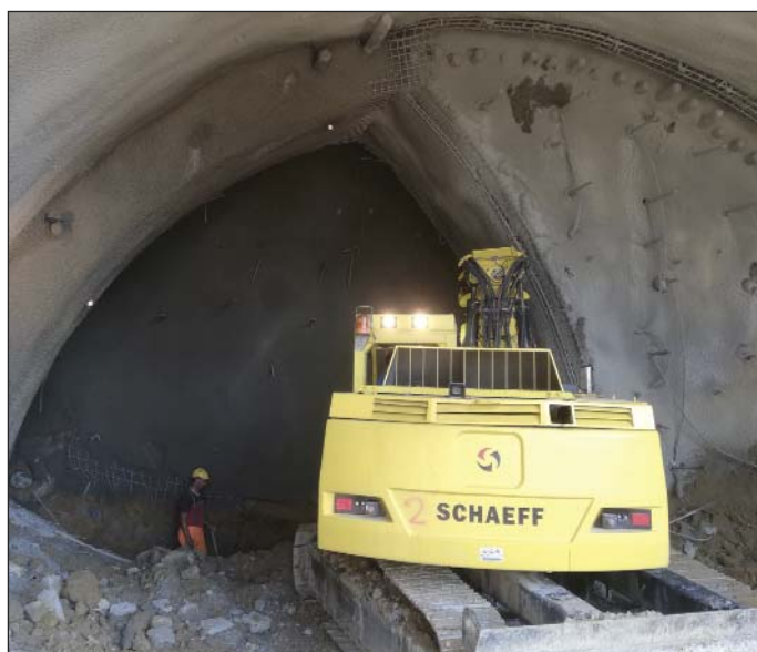
Obr. 6 Razenie tunela Milochove z východného portálu v delenej kalote Fig. 6 Driving the Milochove tunnel from the eastern portal in the divided-up top heading
