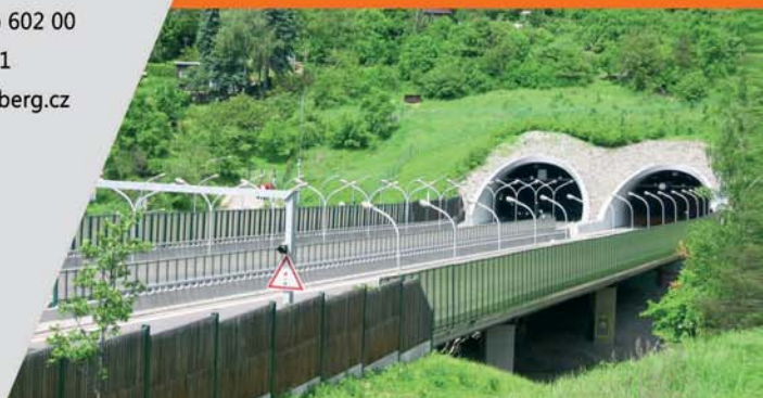
Pisárecký tunel, stavba roku 1998
