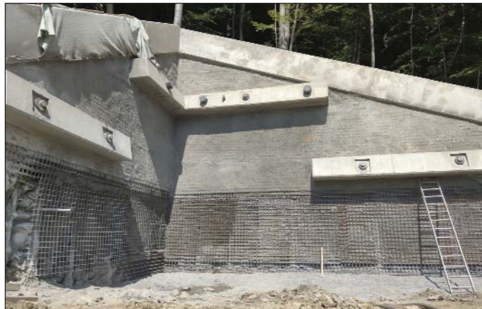
Obr. 2 Postupné otváranie a zabezpečovanie portálu tunela Diel na východnej strane Fig. 2 Gradual opening and stabilising the Diel tunnel portal on the eastern side
