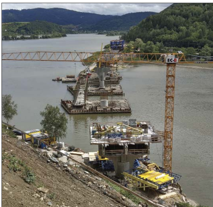
Obr. 3 Pohľad z východného portálu tunela Diel na výstavbu železničnej estakády ponad Nosickú priehradu Fig. 3 A view from the eastern portal of the Diel tunnel for the construction of the viaduct above the Nosice water reservoir
