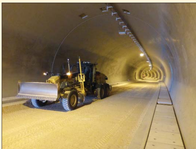
Obr. 1 Tunel Ovčiarisko – podklad pod vozovku STR Fig. 1 Ovčiarisko tunnel – NTT roadway subgrade
