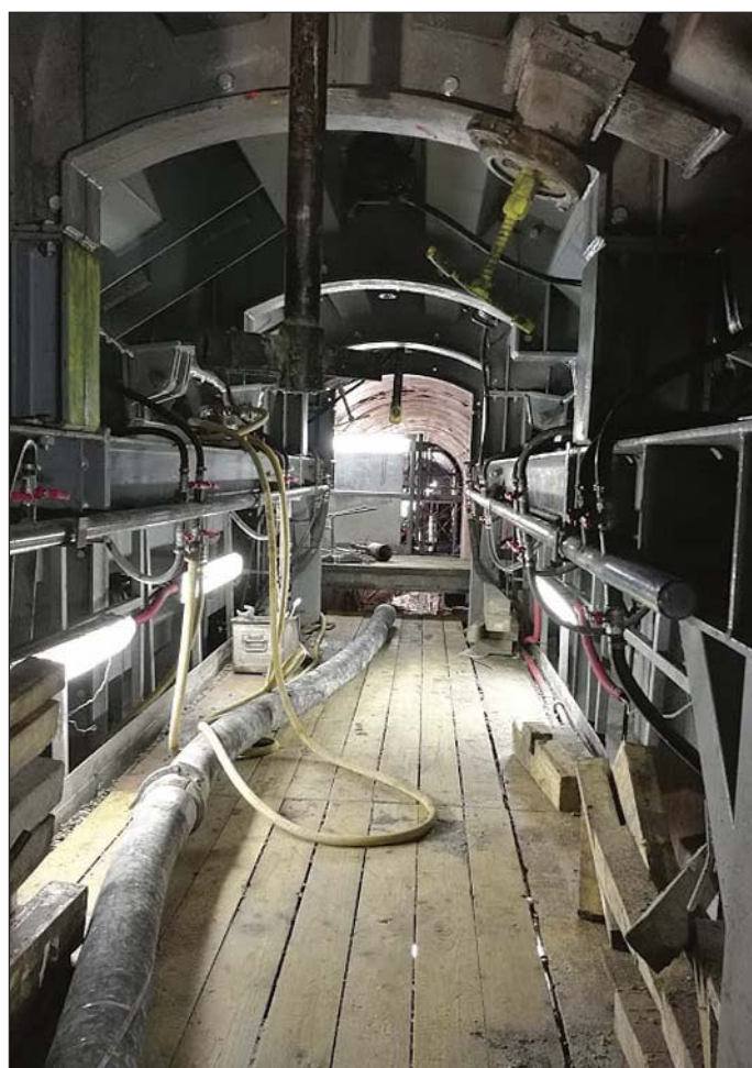
Obr. 6 Pohled dovnitř betonážní formy Fig. 6 A view down the concrete casting formwork
