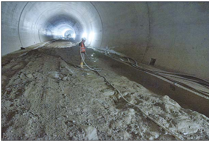
Obr. 5 Čištění počvy tunelu stlačeným vzduchem Fig. 5 Cleaning the tunnel sub-grade by compressed air
