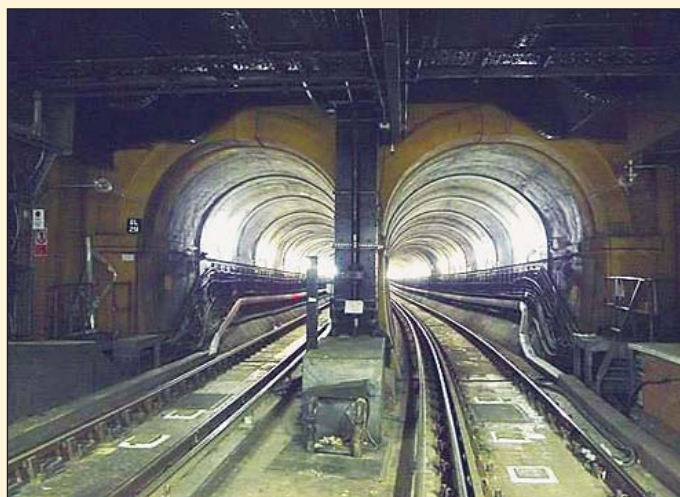
Obr. 8 Po rekonstrukci je tunel od roku 2010 součástí příměstského železničního systému London Overground
