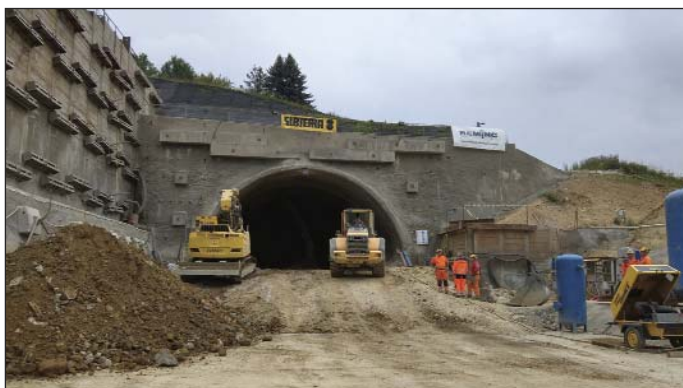
Obr. 5 Východný portál tunela Milochove Fig. 5 Eastern portal of the Milochove tunnel
