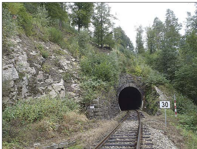
Obr. 6 Pohled na vjezdový portál a svah nad portálovým křídlem
