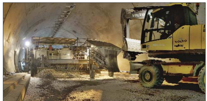
Obr. 17 Doprava směsi k finišeru a stísněné prostorové poměry v tunelu Fig. 17 Transport of mixture to the paver and the restricted spatial conditions in the tunnel
