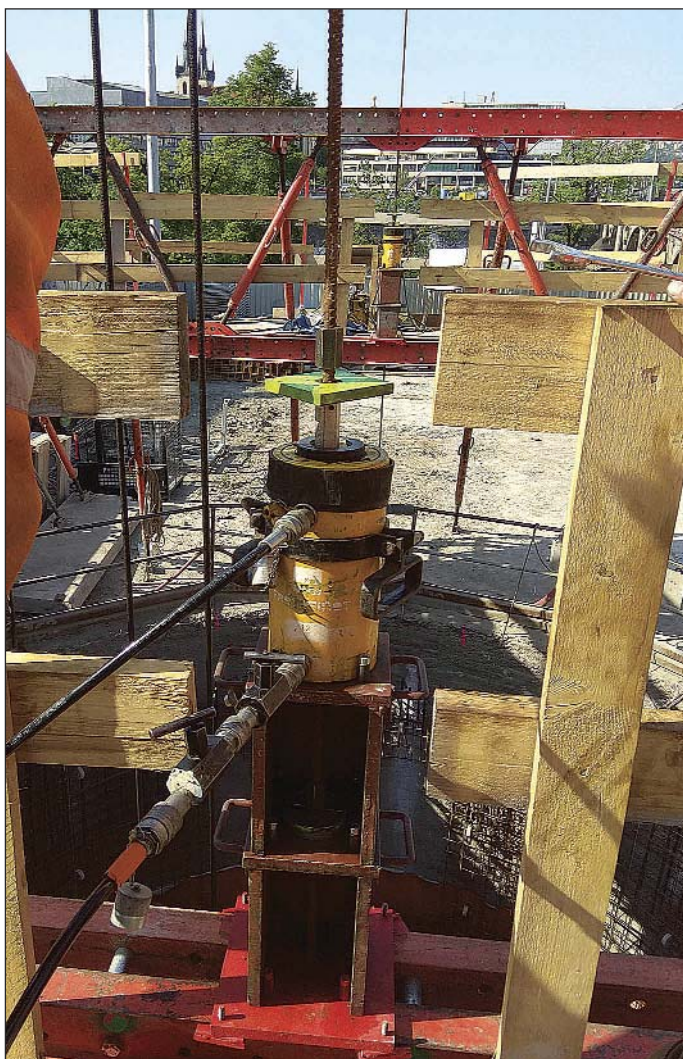
Obr. 13 Hydraulický válec ENERPAC pro manipulaci s plošinou Fig. 13 ENERPAC hydraulic cylinder for handling the platform
