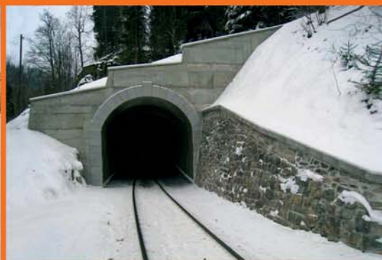
Rekonstrukce Domašovského tunelu, rok 2013
