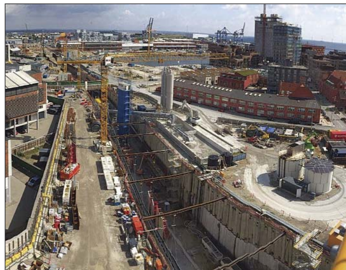
Obr. 9 Stavební jáma stanice a hloubených tunelů Fig. 9 Construction pit for the station and cut-and-cover tunnels
