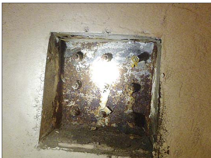
Obr. 3 Injektážní krabice pojistného systému izolace (pozink. ocel) Fig. 3 Grouting box of the waterproofing securing system (galvanised steel)
