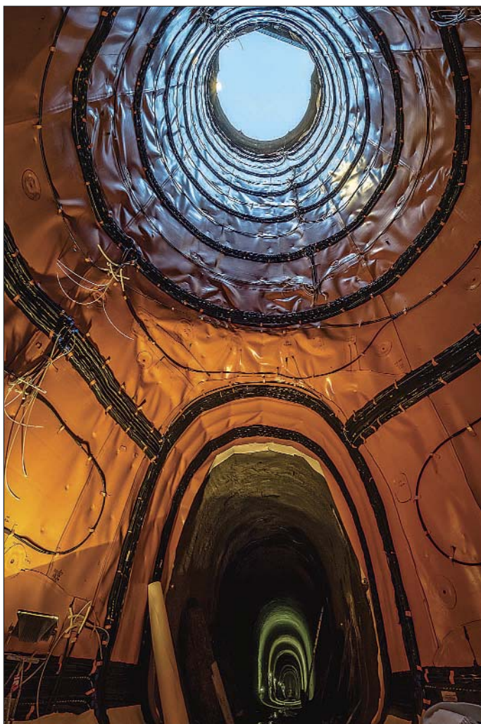
Obr. 3 Průnik šachty J104 a kolektorové trasy s nainstalovaným kompletním hydroizolačním systémem
